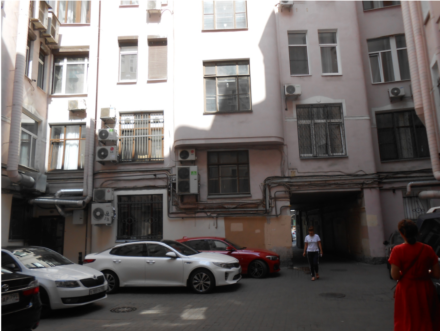
11. “Дом Г.Г.Гесселя”. СПб, Центральный район, Невский пр., 95, лит. А. 1-го двора. Фрагмент северного дворового фасада. Фото: 01.07.21.
