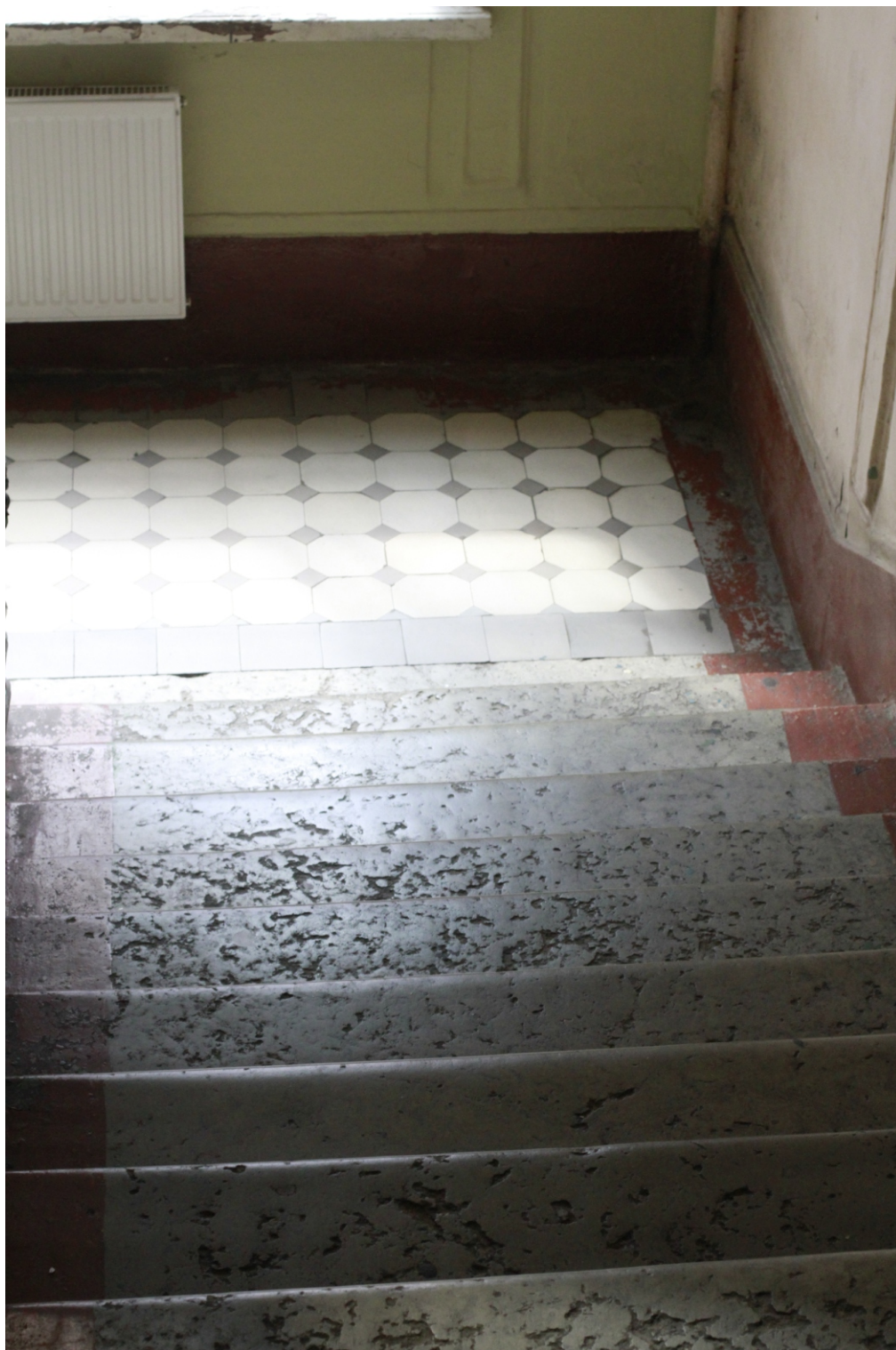
6. “Дом Г.Г.Гесселя”. СПб, Центральный район, Невский пр., 95, лит. А. Фрагмент парадной лестницы лицевого корпуса. Фото: 01.07.21.
