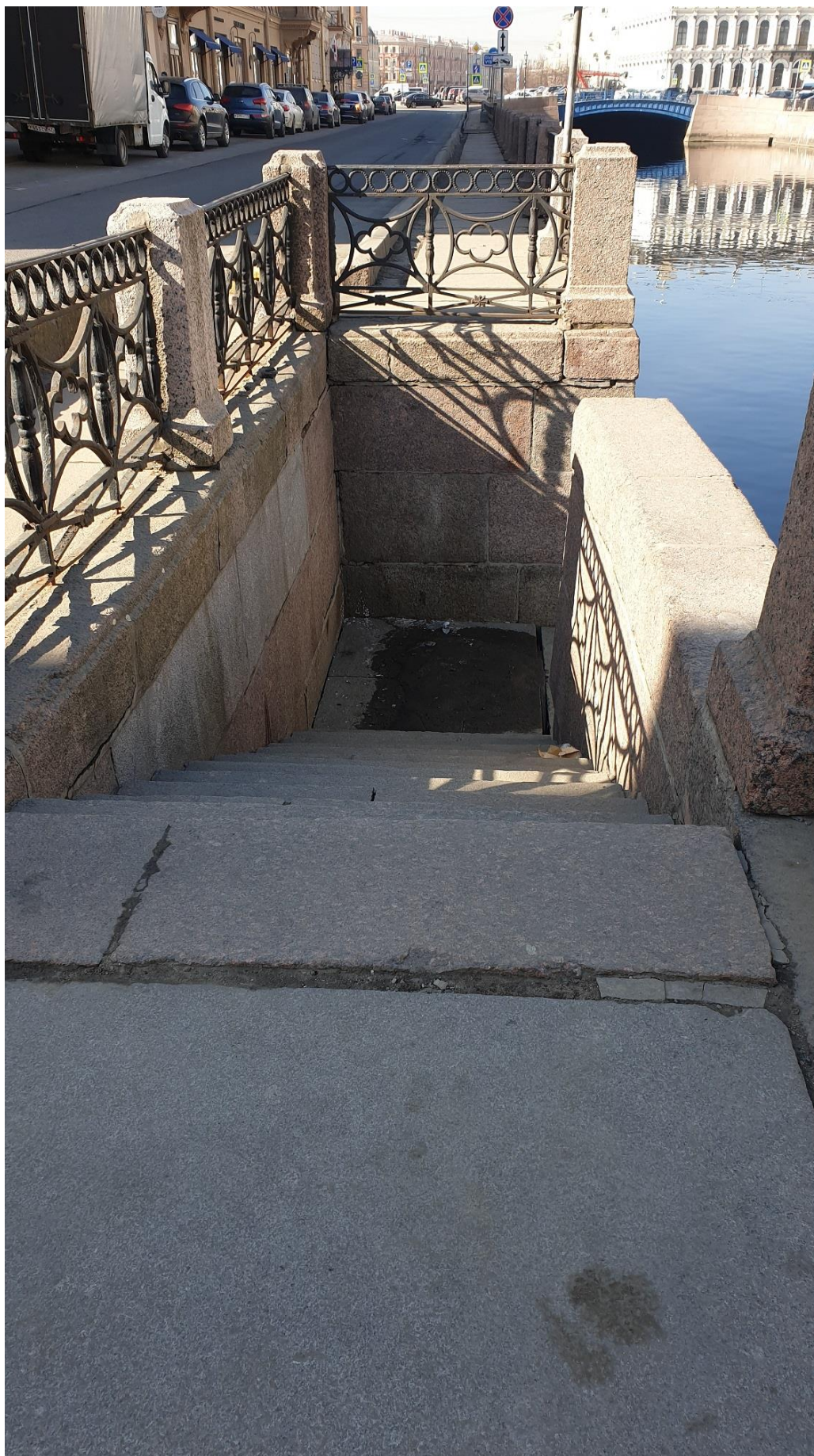
Фото 3. Вид на лестницу и нижнюю площадку спуска № 13 объекта культурного наследия федерального значения «Набережные со спусками» с востока.
