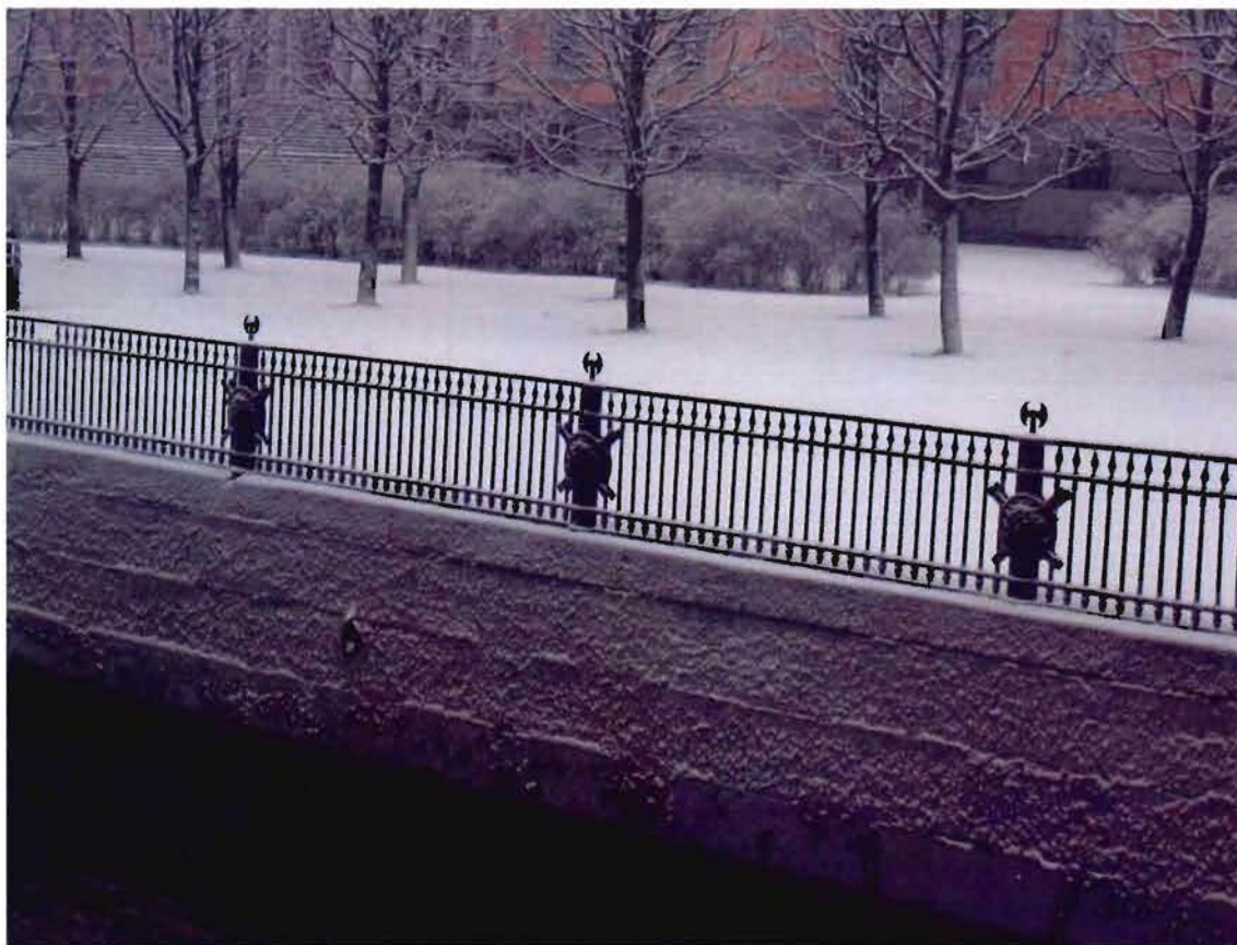
3. Ограждение набережной со стороны Михайловского (Инженерного) замка
