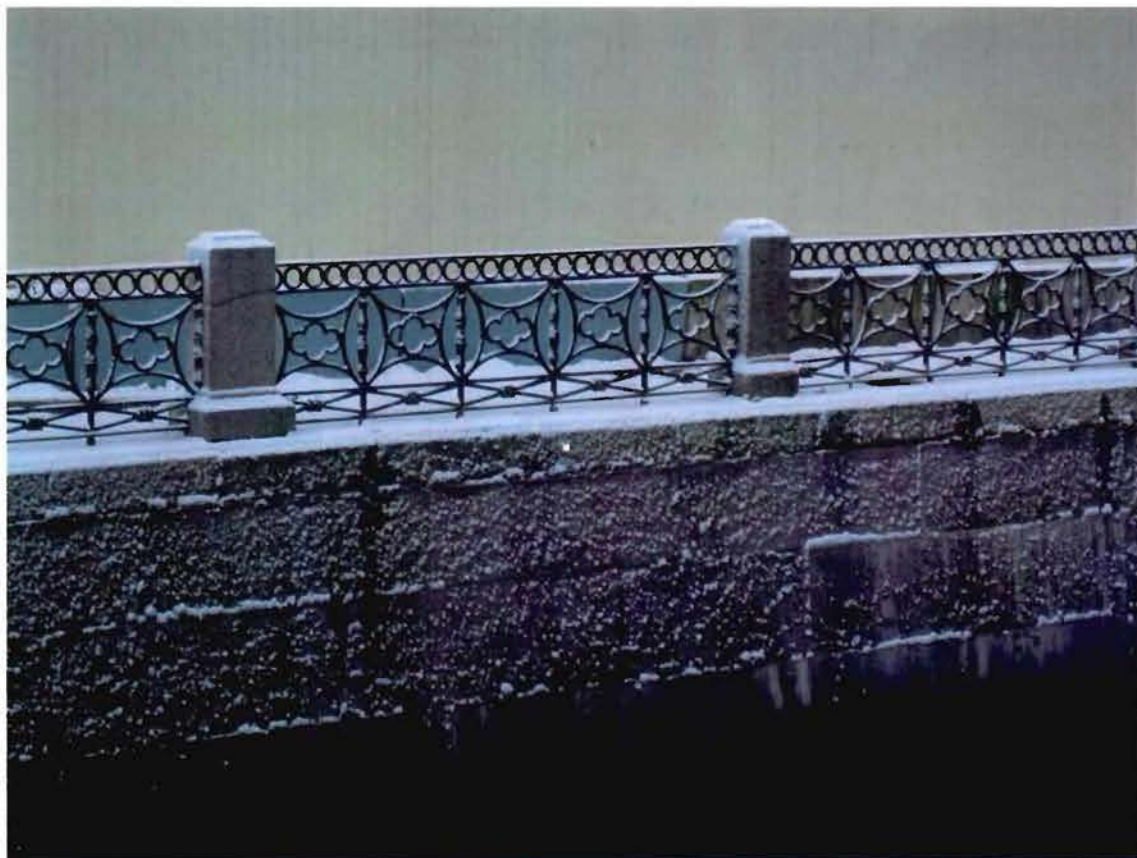
6. Ограждение набережной. Левобережная стенка
