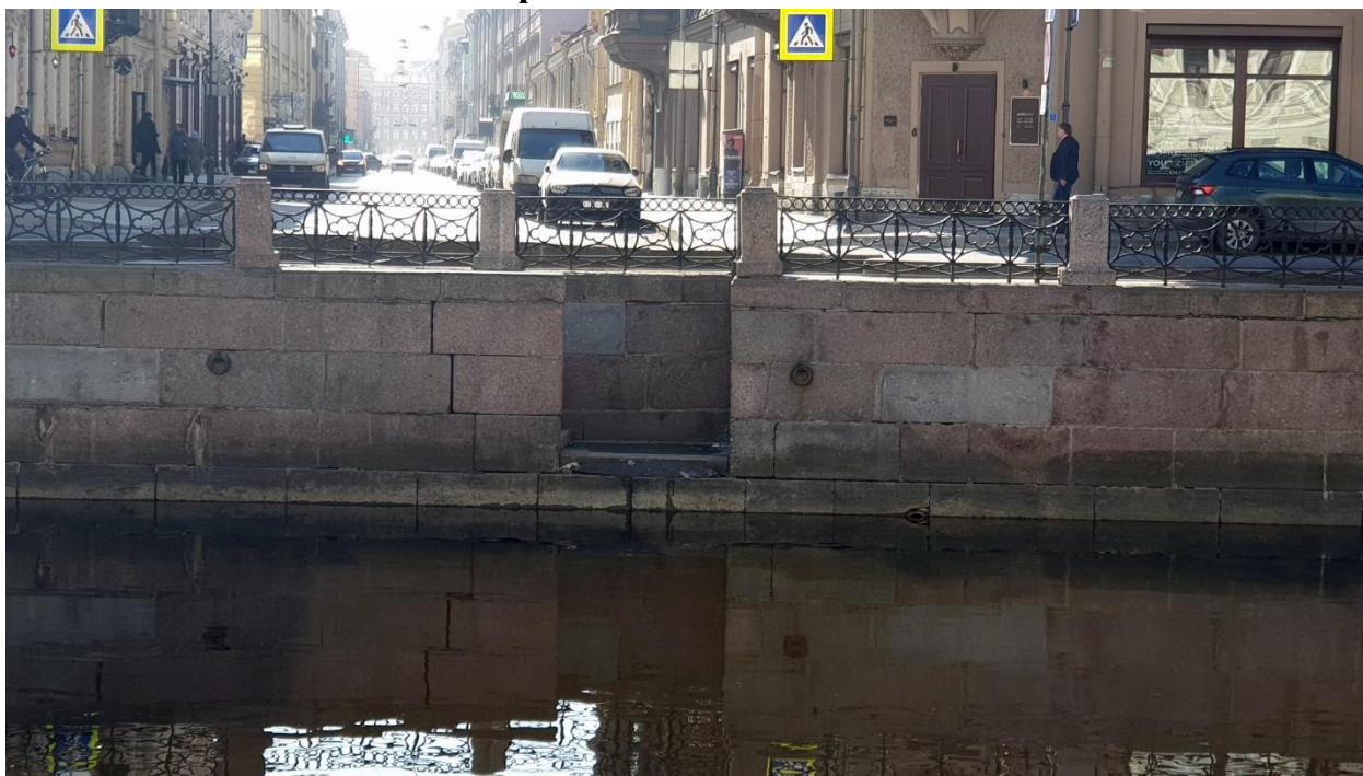
Фото 1. Общий вид на спуск № 13 объекта культурного наследия федерального значения «Набережные со спусками» с левого берега реки Мойки.
