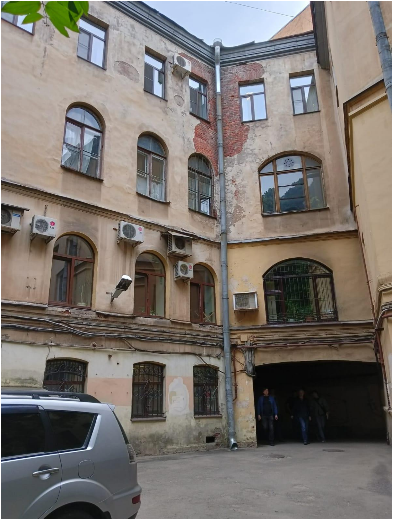
Фото 3. Объект культурного наследия «Особняк А.Р. Ламздорф», расположенный по адресу: Санкт-Петербург, улица Моховая, дом 20, литера А. Дворовый (восточный) фасад лицевого корпуса. Фрагмент.
