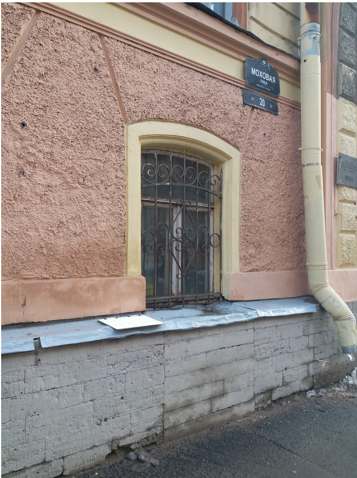
28. Фото начала 2019 г. Фрагмент лицевого фасада по ул. Моховой. Оконный проем по шестой световой оси. Видна поздняя закладка нижней части проема.
