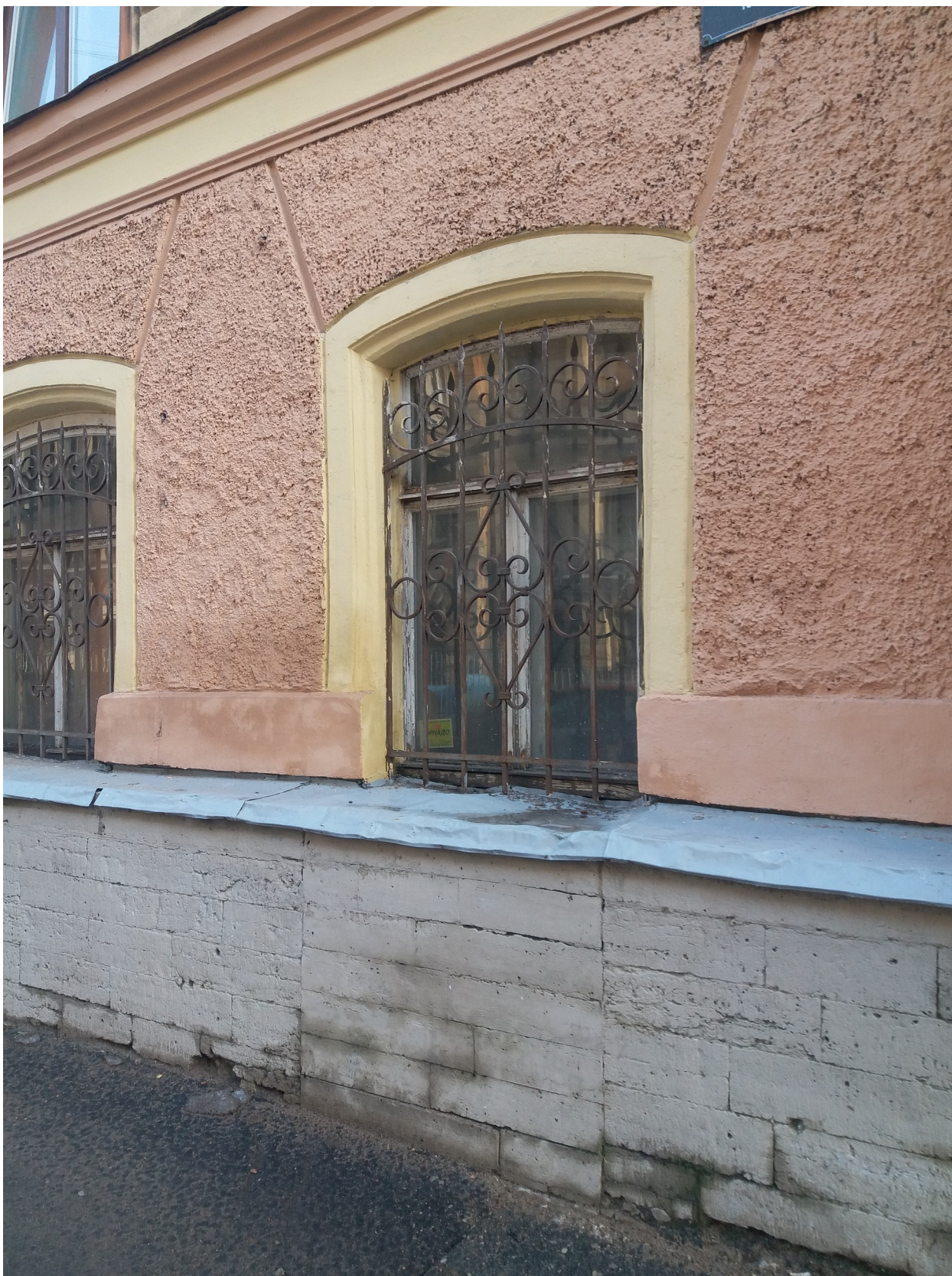
27. Фото начала 2019 г. Фрагмент лицевого фасада по ул. Моховой. Оконный проем по шестой световой оси. Видна поздняя закладка нижней части проема.
