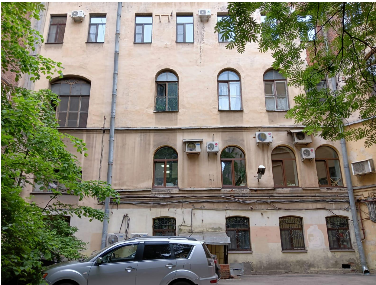
Фото 2. Объект культурного наследия «Особняк А.Р. Ламздорф», расположенный по адресу: Санкт-Петербург, улица Моховая, дом 20, литера А. Дворовый (восточный) фасад лицевого корпуса.
