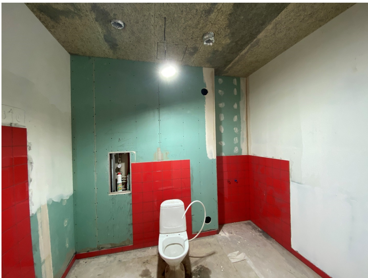
Фото 19. Помещение № 2. Совмещенный санузел.
