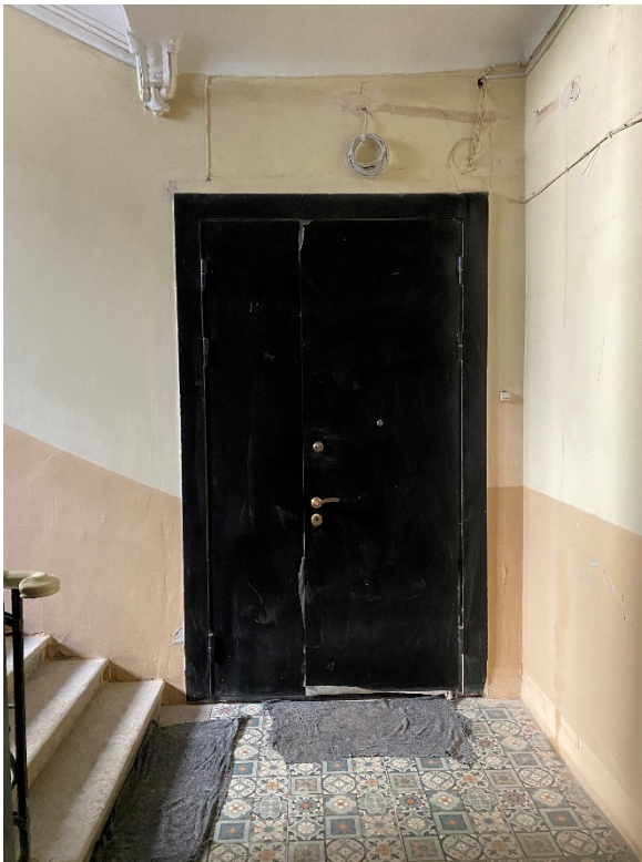
Фото 6. Вход в квартиру с общедомой лестничной клетки.
