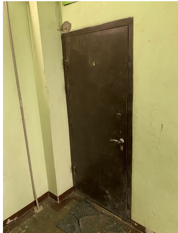
Фото 7. Вход в квартиру с общедомой лестничной клетки.
