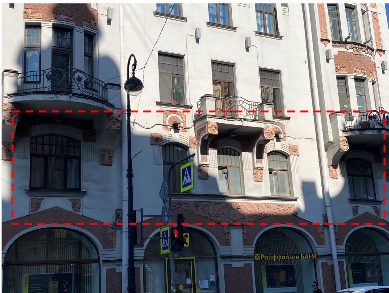
Фото 4. Фрагмент лицевого фасада по Каменноостровскому проспекту. Оконные проемы квартиры № 14.
