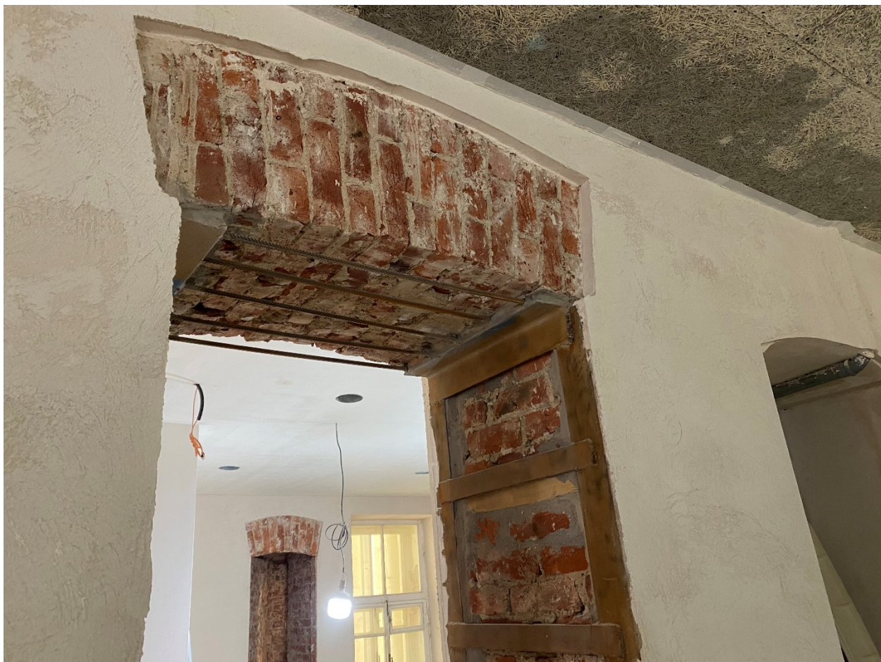
Фото 23. Помещение № 9. Жилая комната. Усиление проема.
