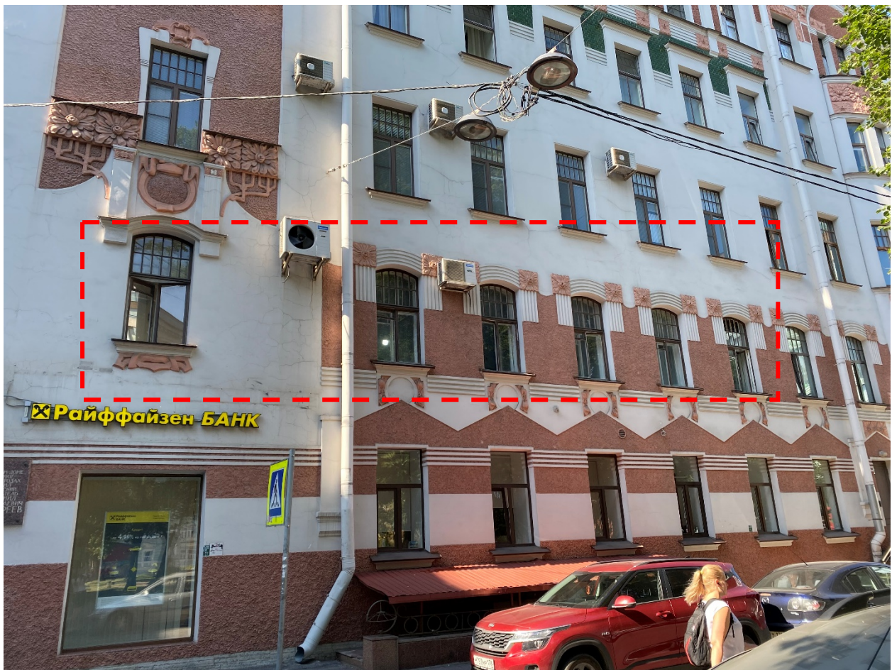
Фото 5. Фрагмент лицевого фасада по улице Дивенской. Оконные проемы квартиры № 14.
