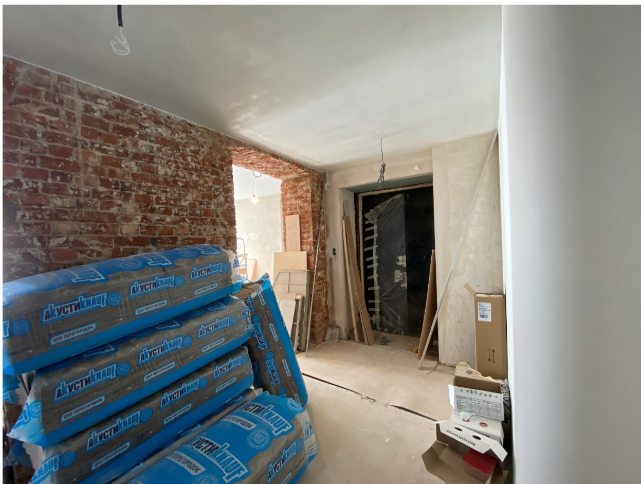
Фото 8. Помещение № 1. Коридор (нумерация и экспликация помещений указа в соответствии с техническим паспортом по состоянию на 15 августа 2012 года).
