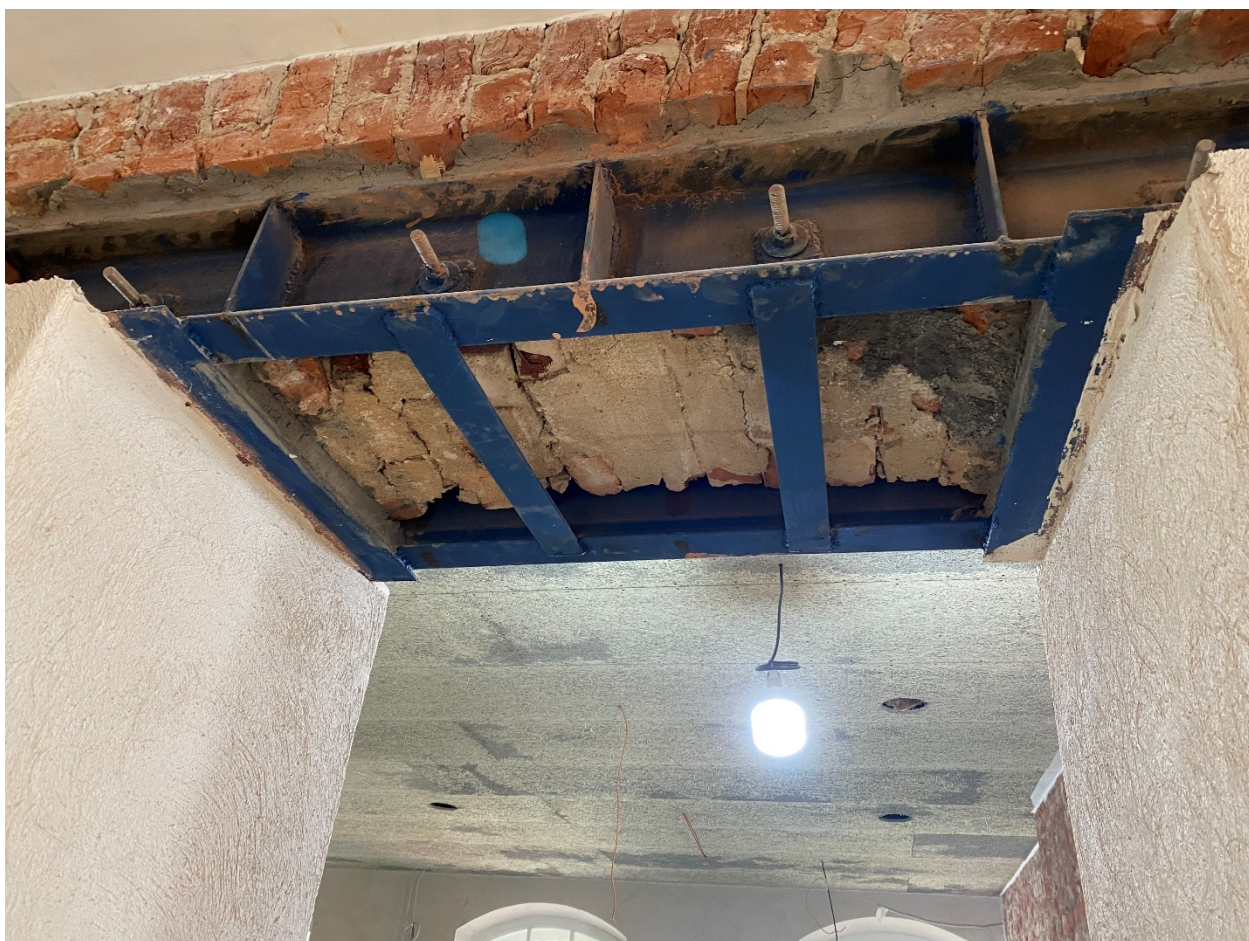
Фото 24. Помещение № 1. Коридор. Усиление проема.
