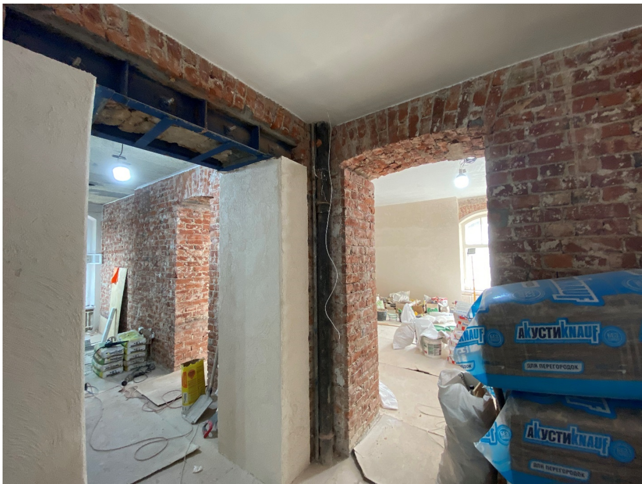
Фото 10. Помещение № 1. Коридор. Общий вид дверных проемов.
