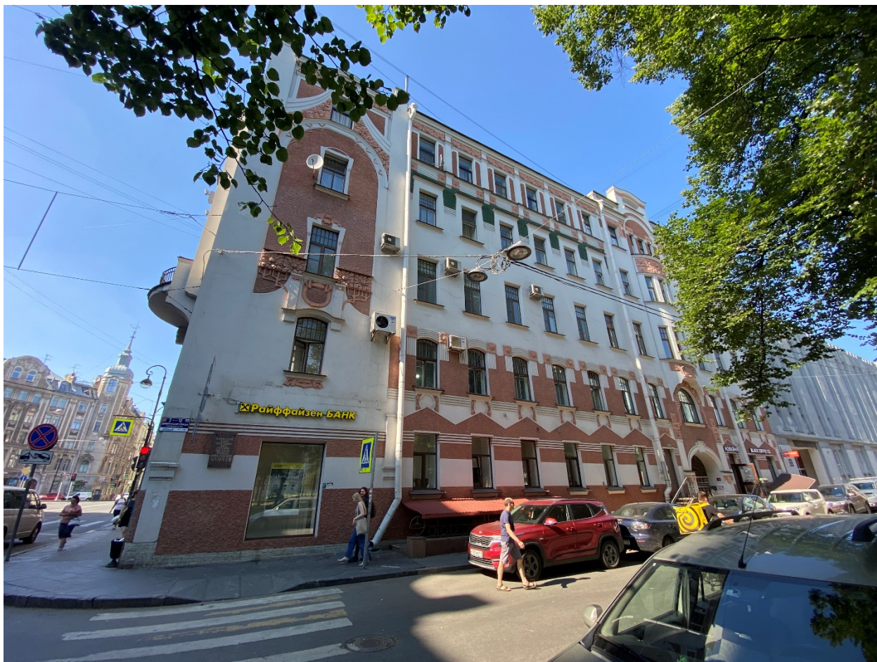
Фото 2. Лицевой фасад по улице Дивенской.
