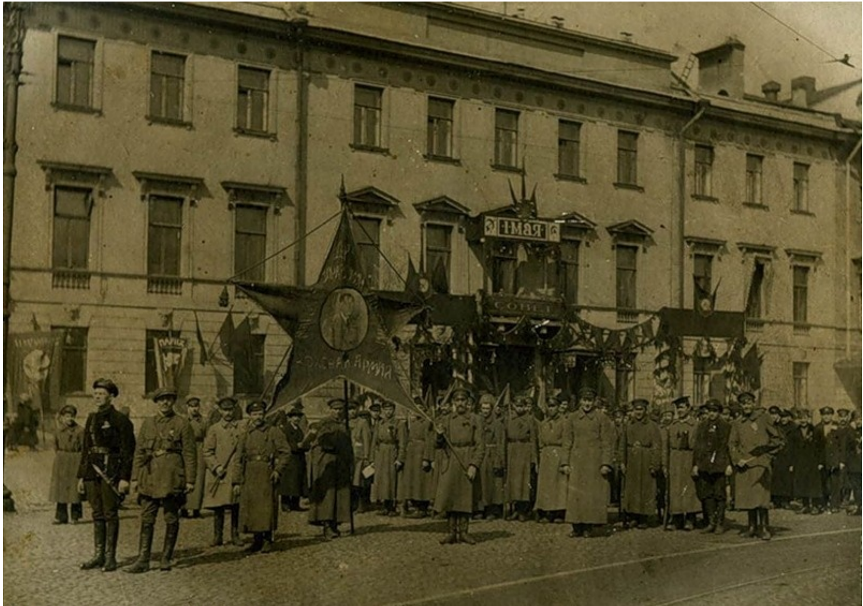
14. Лицевой фасад «Дома П.В.Голенищева-Кутузова». 1918
