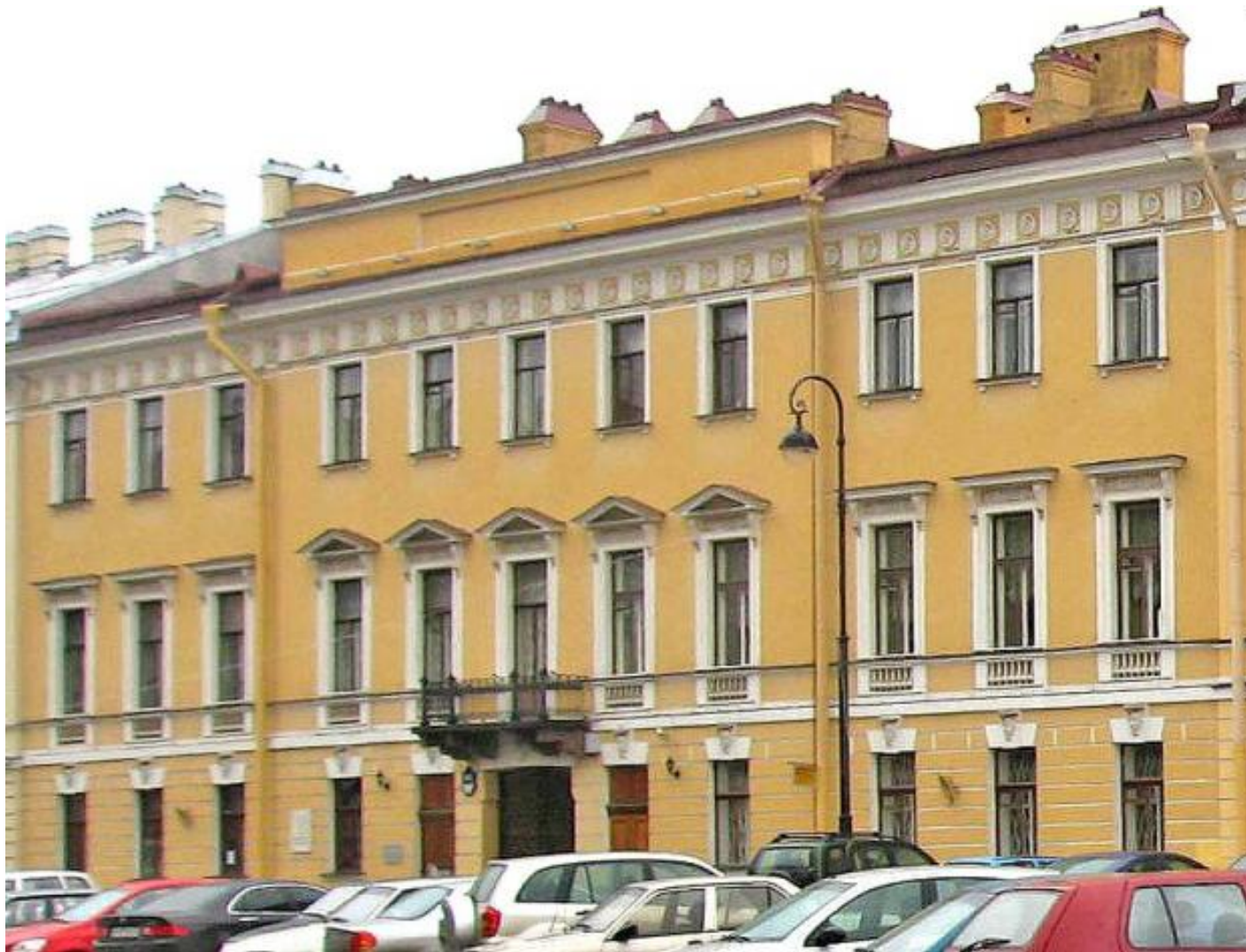
23. Лицевой фасад «Дома П.В. Голенищева-Кутузова». 2006
