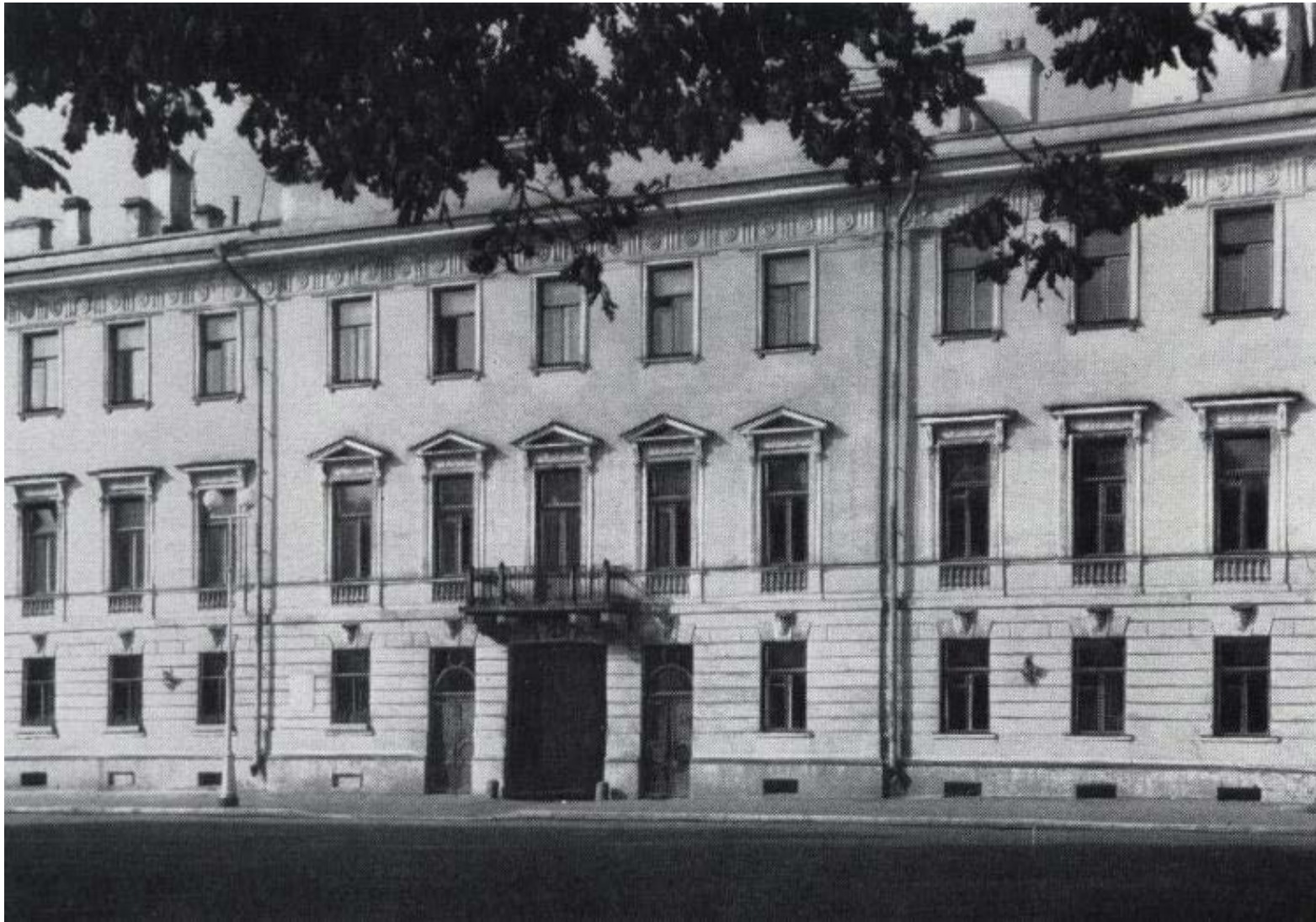
21. Лицевой фасад «Дома П.В.Голенищева-Кутузова». 1966
