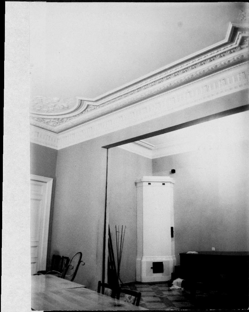
С-петербург, Центральный район, площадь Искусств 3, Дом П.В. Голенищева-Кутузова. 17.«Зеленый зал»(пом.15а), 3-ий этаж. Печь, карниз. Плафон. Ф.с.н. Шмидта С.А. 2002 г.
