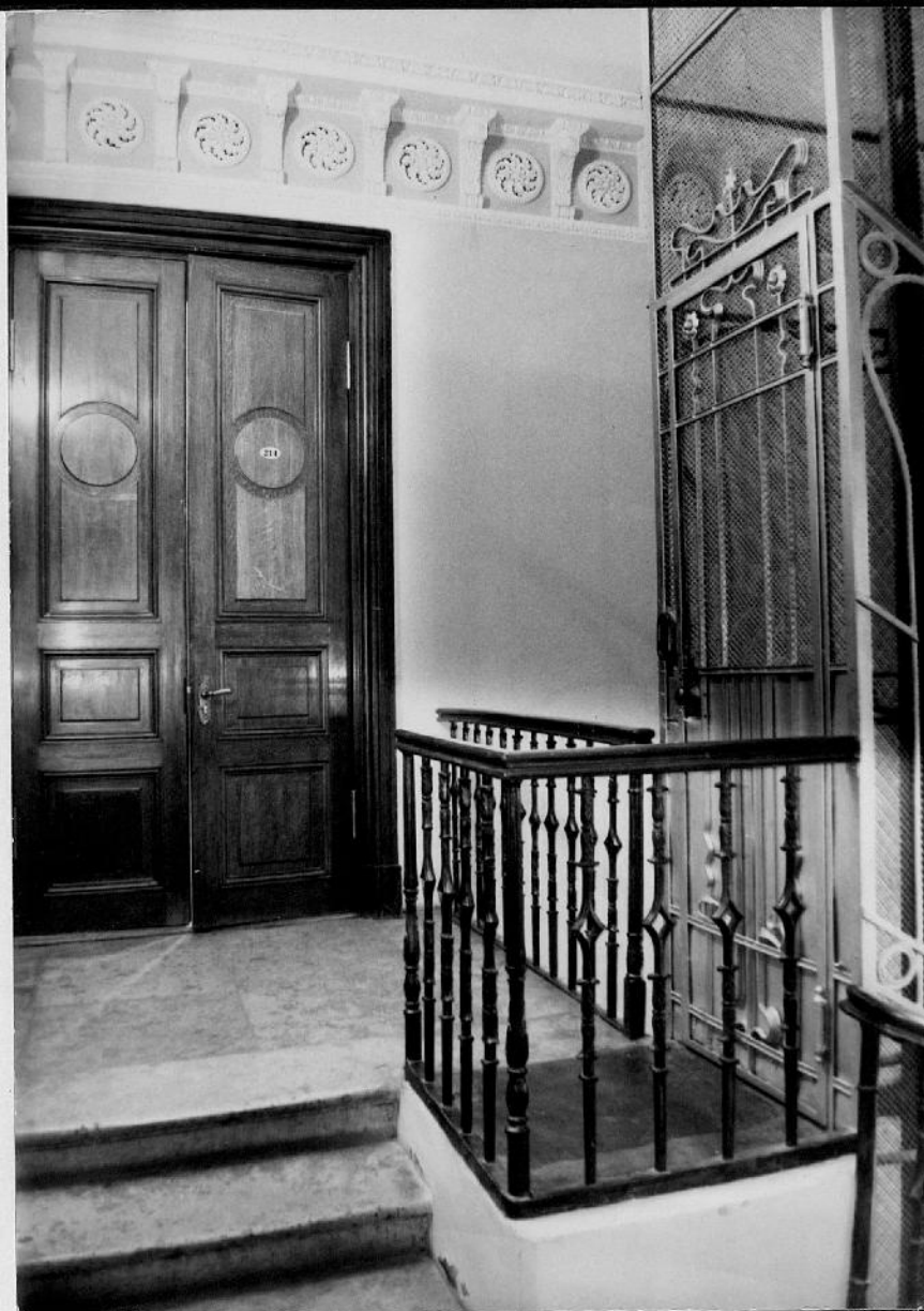
С-петербург, Центральный район, площадь Искусств 3, Дом П.В. Голенищева-Кутузова 20. Помещение лестницы (пом. 16). 3-й этаж. Лифт в стиле модерн. Ф.с.н. Шмидта С.А. 2002 г.
