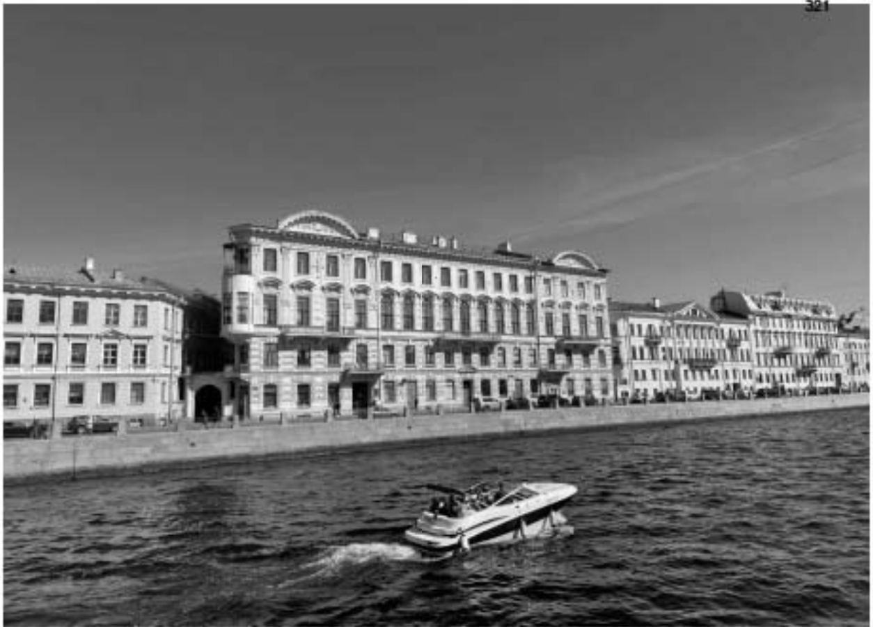
Фото 36. Объект культурного наследия федерального значения «Дом, где жили: в 1880-е-1890-е гг. - поэт Полонский Я.П., в 1888-1892 гг. - композитор Чайковский П.И.», расположенный по адресу: г. Санкт-Петербург, набережная реки Фонтанки, дом 24, лит.А Дата съемки:26.05.2023
