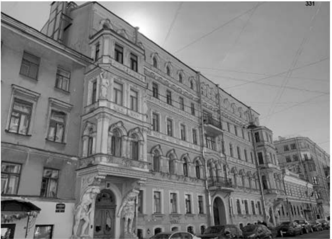
Фото 46. Выявленный объект культурного наследия «Дом С.Ф. Англареса», расположенный по адресу: г. Санкт-Петербург, Сапёрный переулок, дом 13, литера А Дата съемки: 26.05.2023
