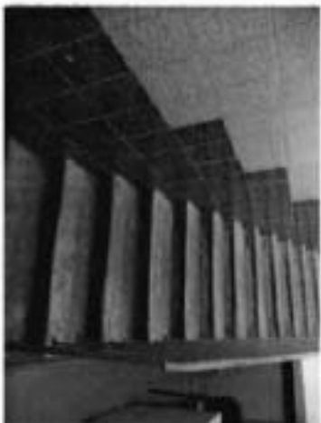
17. Лестница со двора с 1 до 3 этажа
