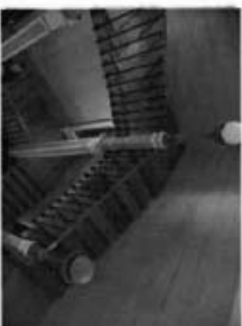
27. Поперечная лестница с 1 на 3 этаж
