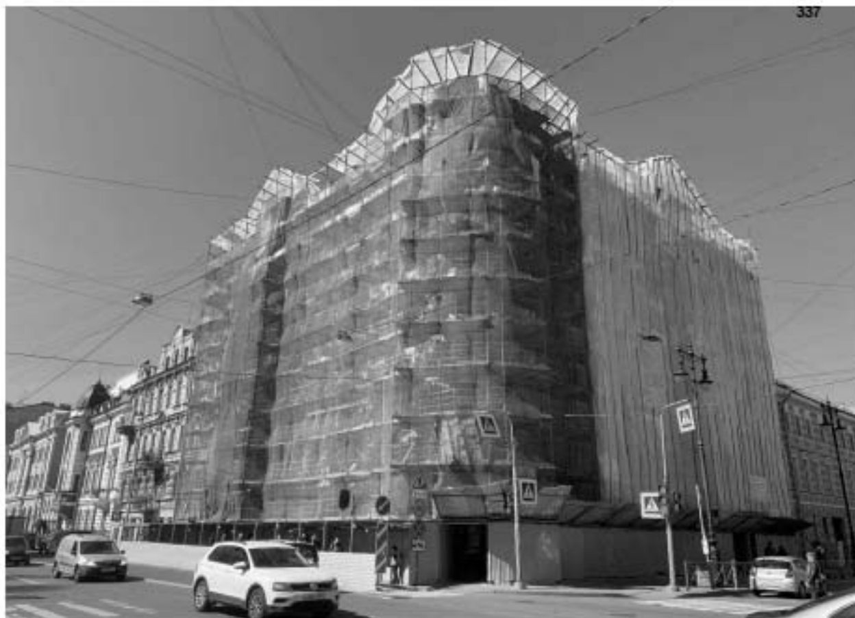
Фото 52. Объект культурного наследия регионального значения «Дом А.Е. Бурцева», расположенный по адресу: г. Санкт-Петербург, улица Маяковского, дом 30, литера А Дата съемки: 26.05.2023
