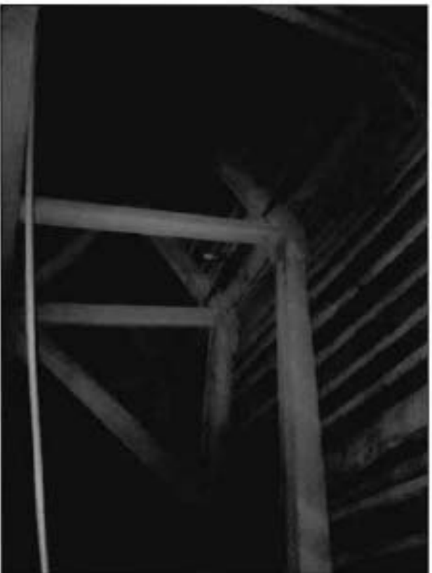
10. Фрагмент Стропильная система
