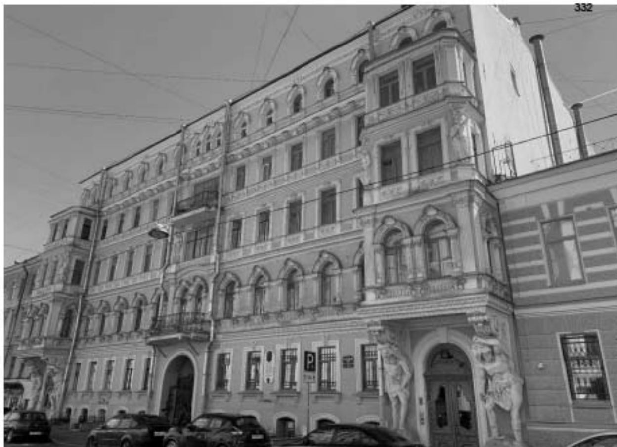
Фото 48. Выявленный объект культурного наследия «Дом С.Ф. Англареса», расположенный по адресу: г. Санкт-Петербург, Сапёрный переулок, дом 13, литера А Дата съемки: 26.05.2023
