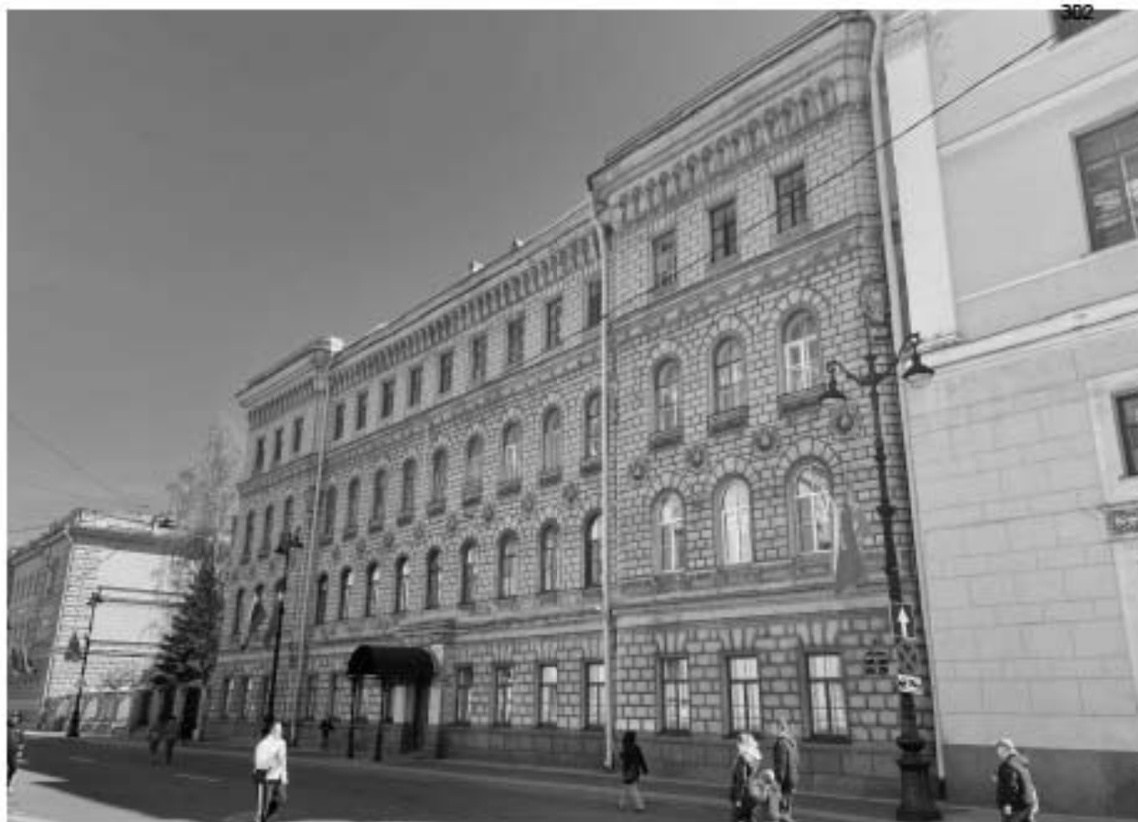
Фото 15. Объект культурного наследия регионального значения «Жилой дом штаба Гвардейского корпуса», расположенный по адресу: г. Санкт-Петербург, Миллионная улица, дом 38, литера А Дата съемки: 26.05.2023
