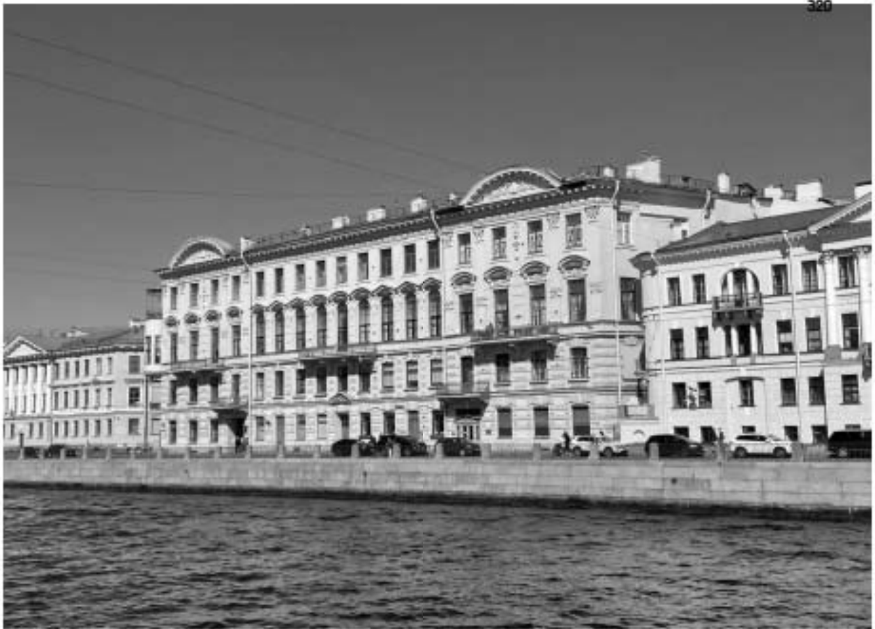
Фото 34. Объект культурного наследия федерального значения «Дом, где жили: в 1880-е-1890-е гг. - поэт Полонский Я.П., в 1888-1892 гг. - композитор Чайковский П.И.», расположенный по адресу: г. Санкт-Петербург, набережная реки Фонтанки, дом 24, лит.А Дата съемки: 26.05.2023
