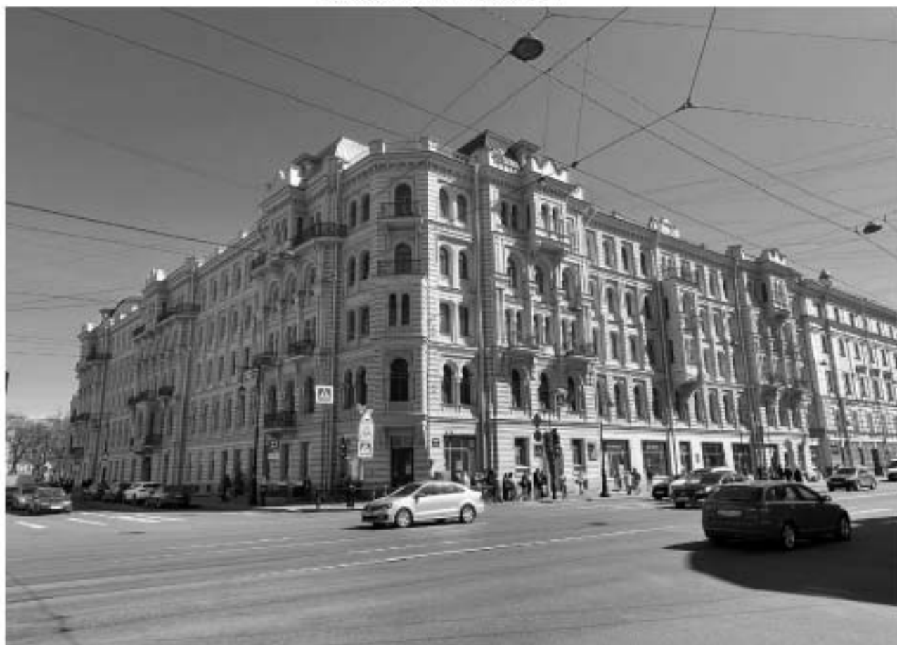
Фото 8. Объект культурного наследия регионального значения «Доходный дом князя А.Д.Мурузи», расположенный по адресу: г.Санкт-Петербург, Литейный проспект, дом 24, литера А Дата съемки:26.05.2023
