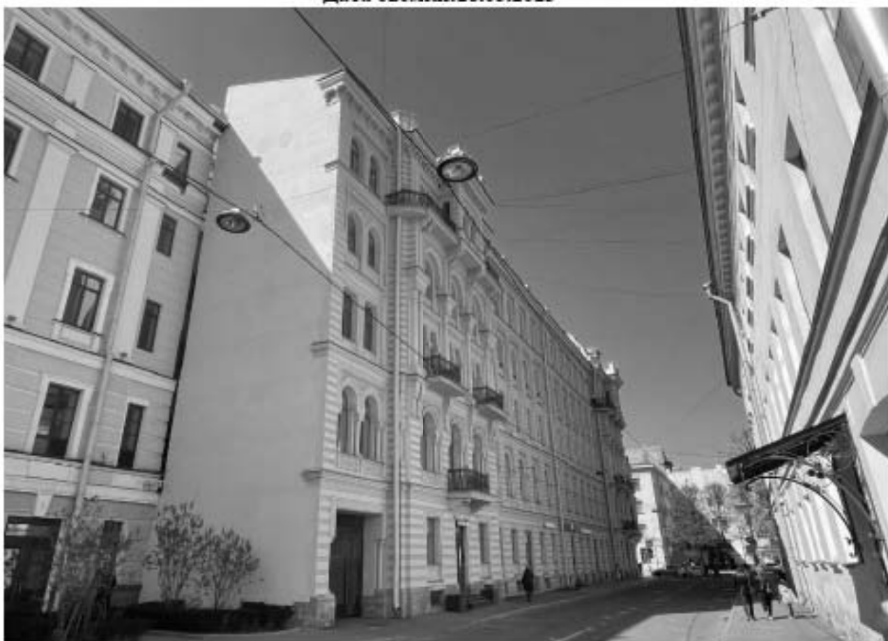
Фото 10. Объект культурного наследия регионального значения «Доходный дом князя А.Д.Мурузи», расположенный по адресу: г.Санкт-Петербург, Литейный проспект, дом 24, литера А Дата съемки:26.05.2023
