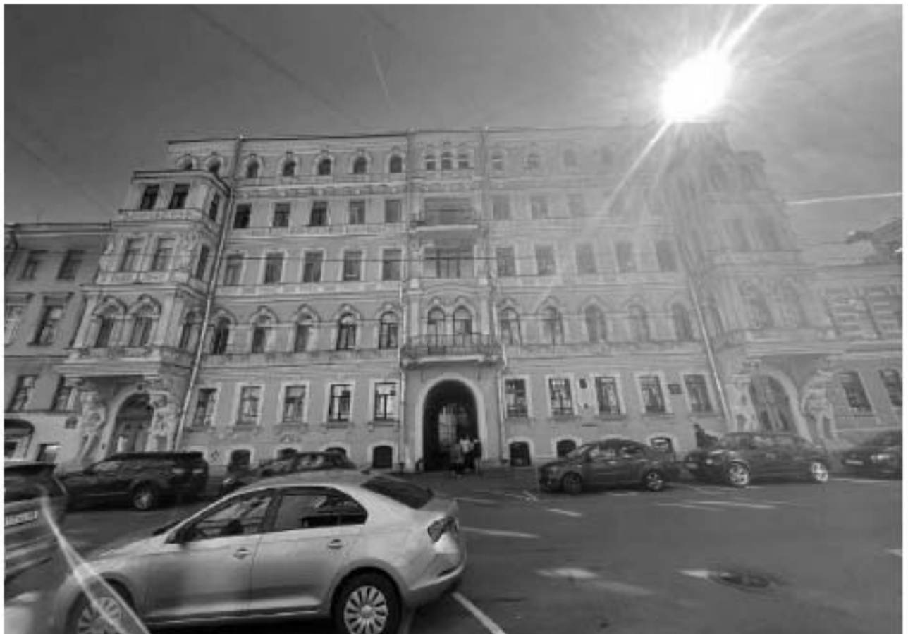
Фото 47. Выявленный объект культурного наследия «Дом С.Ф. Англареса», расположенный по адресу: г. Санкт-Петербург, Сапёрный переулок, дом 13, литера А Дата съемки: 26.05.2023
