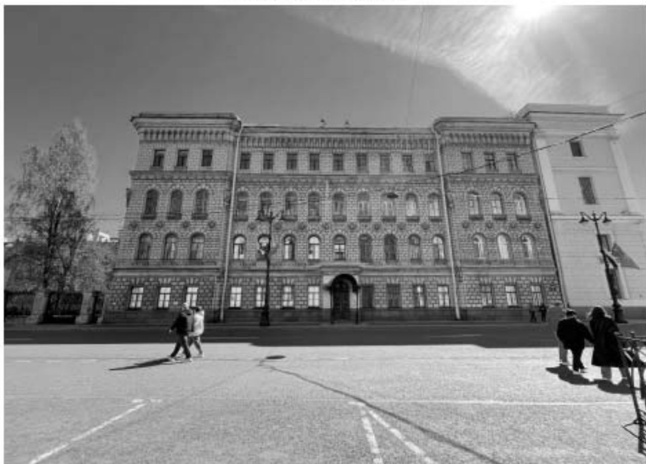
Фото 16. Объект культурного наследия регионального значения «Жилой дом штаба Гвардейского корпуса», расположенный по адресу: г. Санкт-Петербург, Миллионная улица, дом 38, литера А Дата съемки: 26.05.2023
