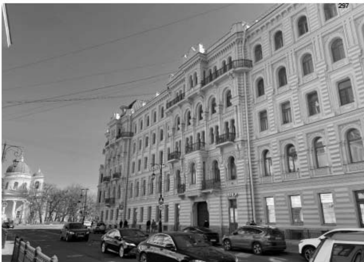
Фото 9. Объект культурного наследия регионального значения «Доходный дом князя А.Д.Мурузи», расположенный по адресу: г.Санкт-Петербург, Литейный проспект, дом 24, литера А Дата съемки:26.05.2023
