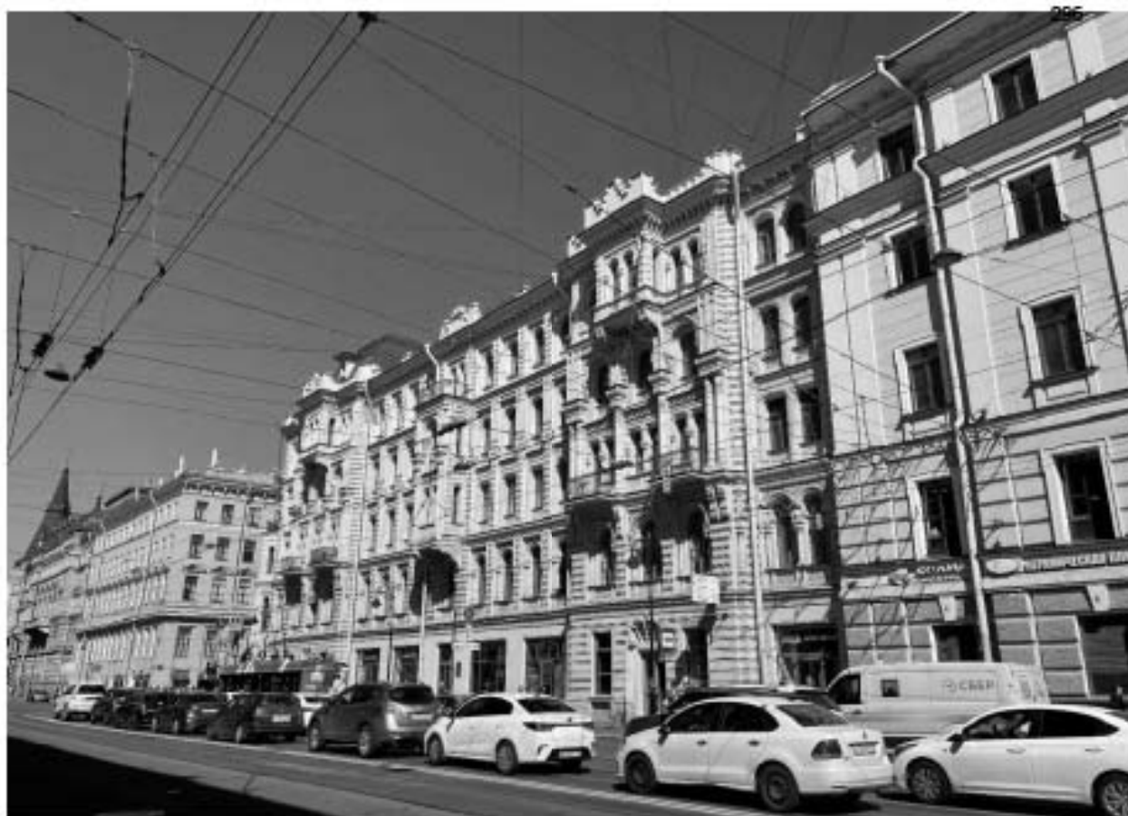
Фото 7. Объект культурного наследия регионального значения «Доходный дом князя А.Д.Мурузи», расположенный по адресу: г.Санкт-Петербург, Литейный проспект, дом 24, литера А Дата съемки:26.05.2023
