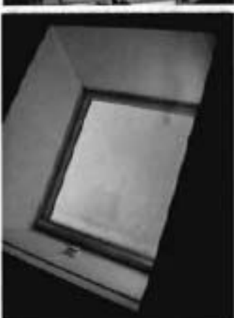
16. Состояние окна в спальне
