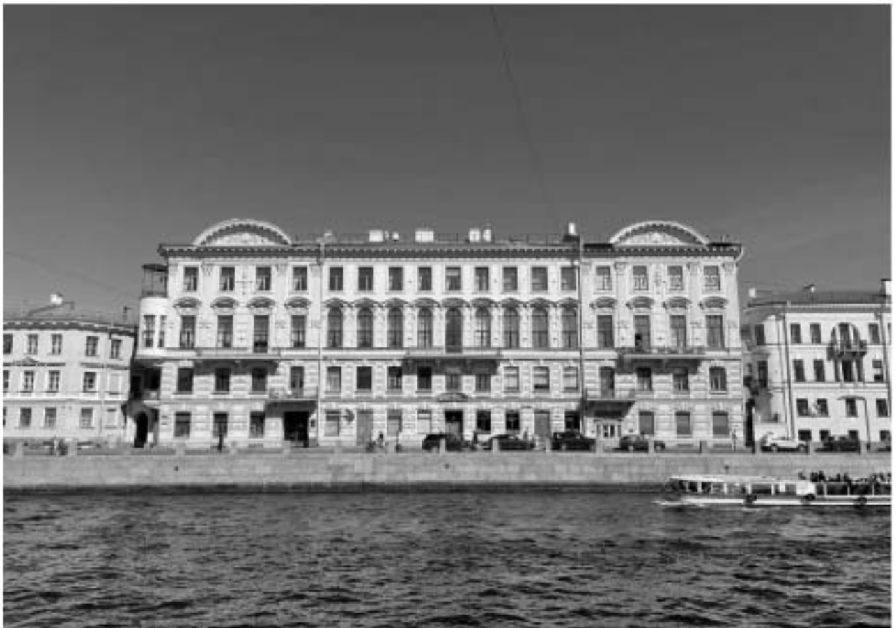
Фото 35. Объект культурного наследия федерального значения «Дом, где жили: в 1880-е-1890-е гг. - поэт Полонский Я.П., в 1888-1892 гг. - композитор Чайковский П.И.», расположенный по адресу: г. Санкт-Петербург, набережная реки Фонтанки, дом 24, лит.А Дата съемки: 26.05.2023
