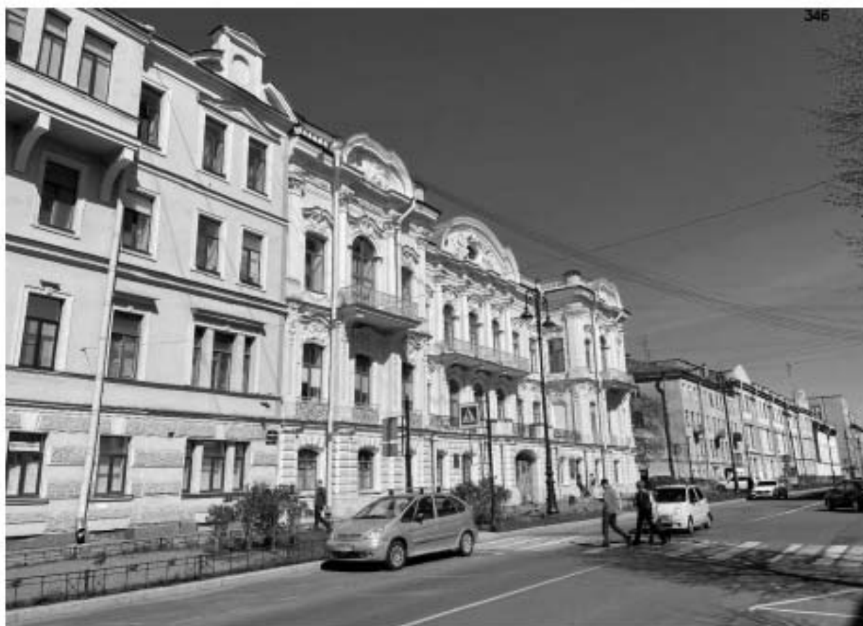
Фото 62. Объект культурного наследия регионального значения «Бывш. дом Бутурлиной», расположенный по адресу: г.Санкт-Петербург, улица Чайковского, дом 10, литера А Дата съемки:26.05.2023
