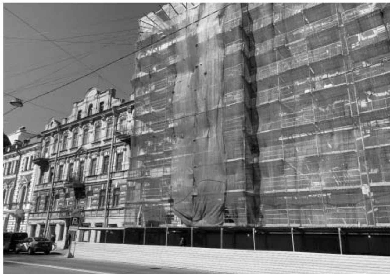
Фото 53. Объект культурного наследия регионального значения «Дом А.Е. Бурцева», расположенный по адресу: г. Санкт-Петербург, улица Маяковского, дом 30, литера А Дата съемки: 26.05.2023
