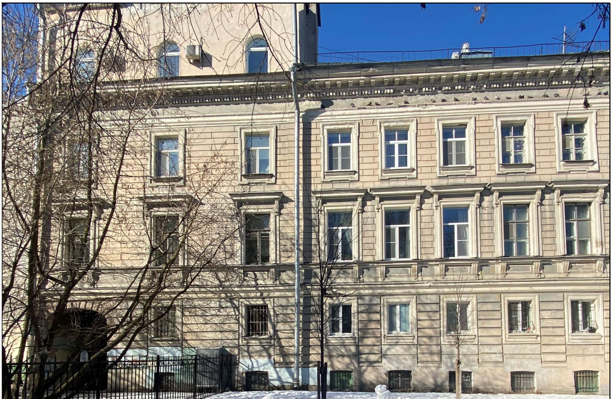
4. Выявленный объект культурного наследия «Жилой дом при заводе Ф.К. Сан-Галли». Фрагмент юго-восточного фасада. 10.03.2023 г.
