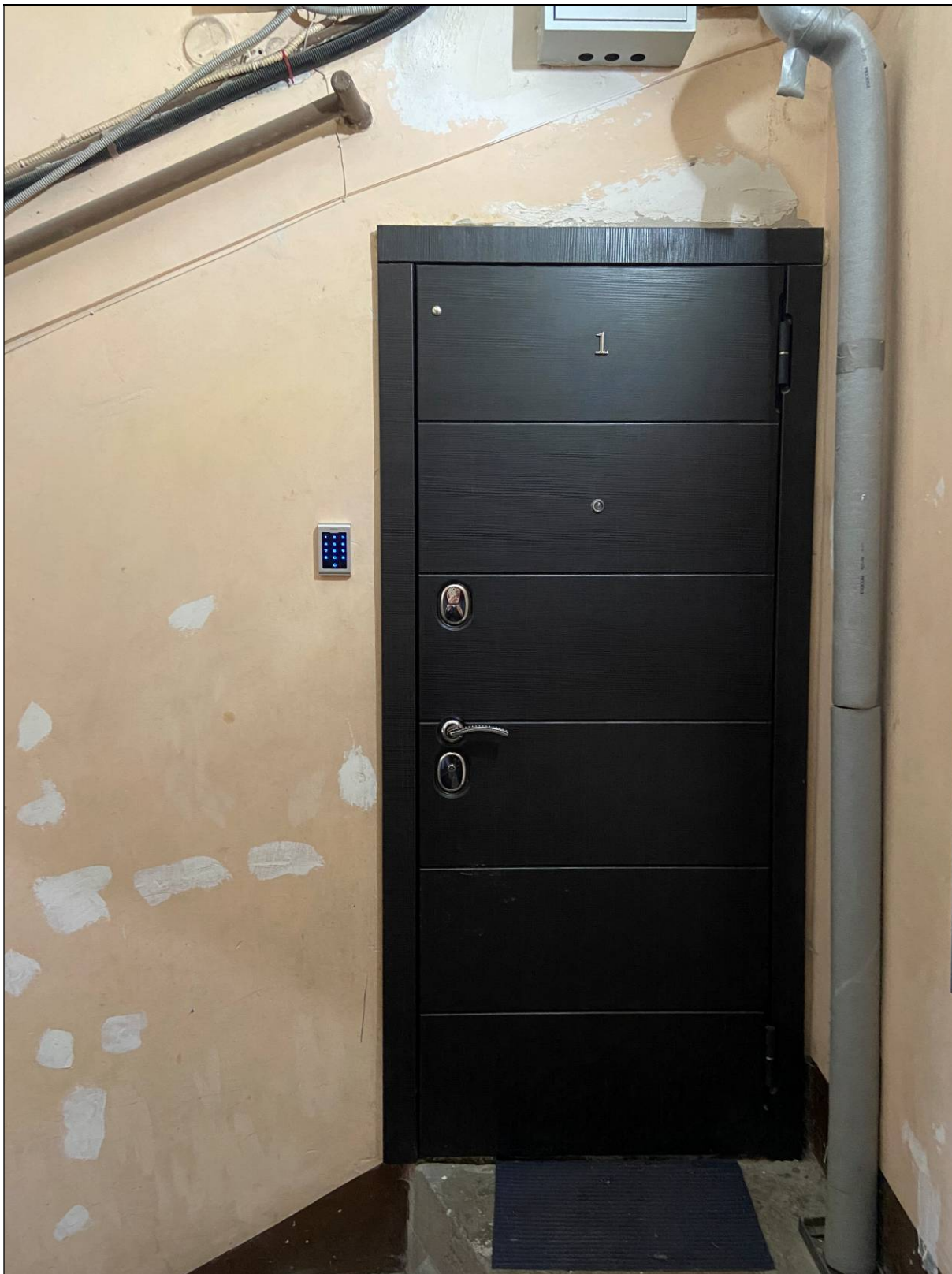
12. Выявленный объект культурного наследия «Жилой дом при заводе Ф.К. Сан-Галли». Лестница Л-4. Вход в квартиру № 1. 10.03.2023 г.
