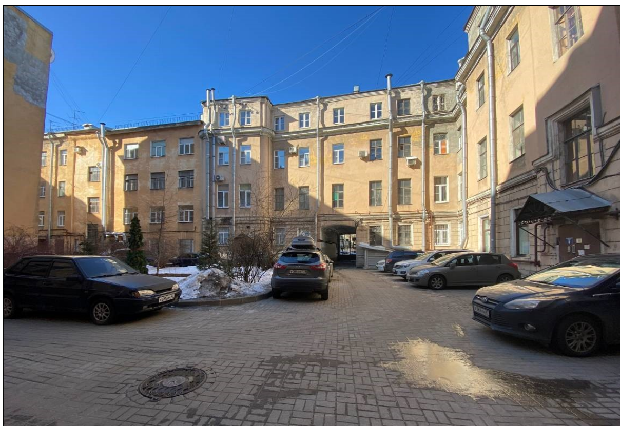
7. Выявленный объект культурного наследия «Жилой дом при заводе Ф.К. Сан-Галли». Дворовые фасады. Вид с востока. 10.03.2023 г.
