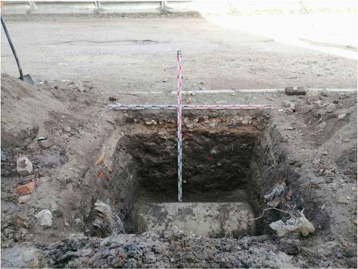
Рис. 24. Санкт-Петербург, внутригородское муниципальное образование Санкт-Петербурга муниципального округа Финляндский округ, Литовская улица, земельный участок 1, кадастровый номер 78:10:0005114:1801. Шурф 1. Фиксация по уровню грунтовых вод, вид на восток.
