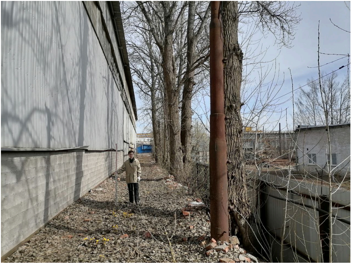
Рис. 15. Санкт-Петербург, внутригородское муниципальное образование Санкт-Петербурга муниципального округа Финляндский округ, Литовская улица, земельный участок 1, кадастровый номер 78:10:0005114:1801. Точка фотофиксации 8, вид на северо-запад.
