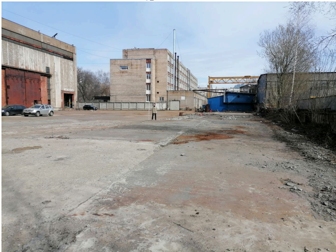
Рис. 13. Санкт-Петербург, внутригородское муниципальное образование Санкт-Петербурга муниципального округа Финляндский округ, Литовская улица, земельный участок 1, кадастровый номер 78:10:0005114:1801. Точка фотофиксации 6, вид на запад.
