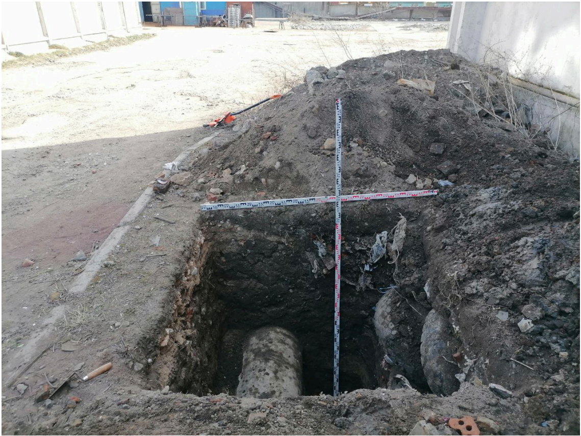
Рис. 26. Санкт-Петербург, внутригородское муниципальное образование Санкт-Петербурга муниципального округа Финляндский округ, Литовская улица, земельный участок 1, кадастровый номер 78:10:0005114:1801. Шурф 1. Фиксация по уровню грунтовых вод, вид на юг.
