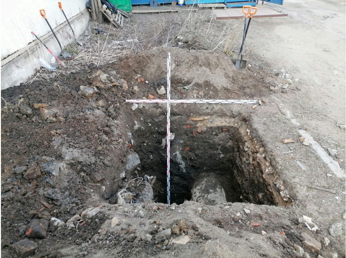
Рис. 22. Санкт-Петербург, внутригородское муниципальное образование Санкт-Петербурга муниципального округа Финляндский округ, Литовская улица, земельный участок 1, кадастровый номер 78:10:0005114:1801. Шурф 1. Фиксация по уровню грунтовых вод, вид на север.
