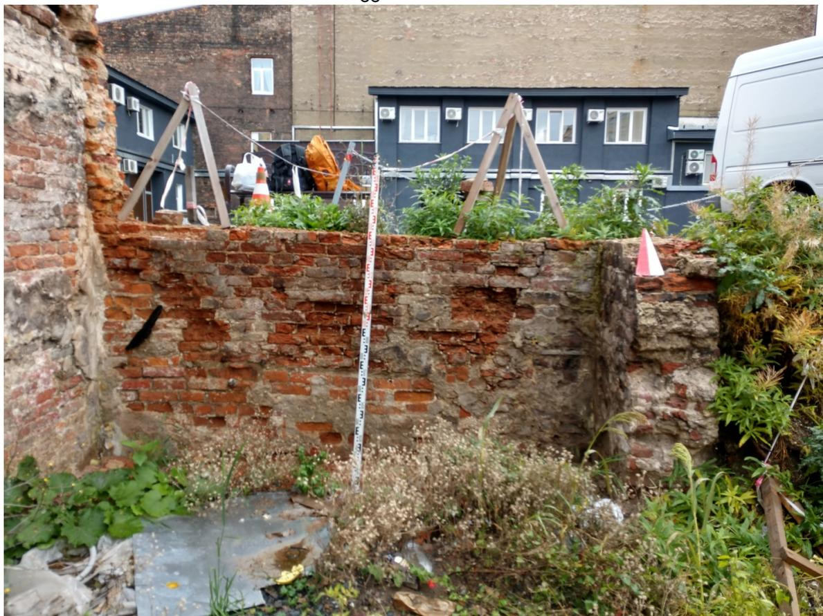
Рис. 15. Моховая, д. 39 - 2019. Фотофиксация. Северный край участка, западная часть, остатки кирпичной стены демонтированного здания.
