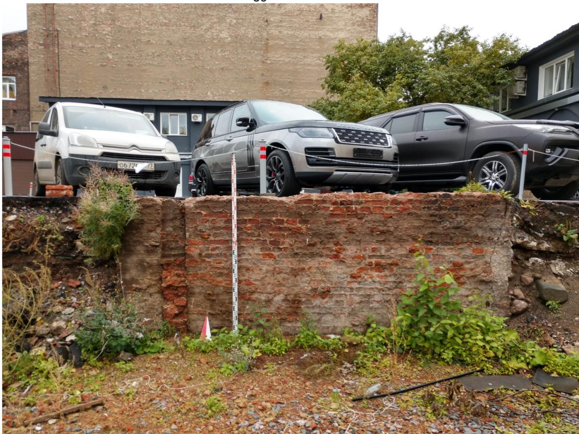
Рис. 17. Моховая, д. 39 - 2019. Фотофиксация. Северный край участка, центральная часть, остатки кирпичной стены демонтированного здания.
