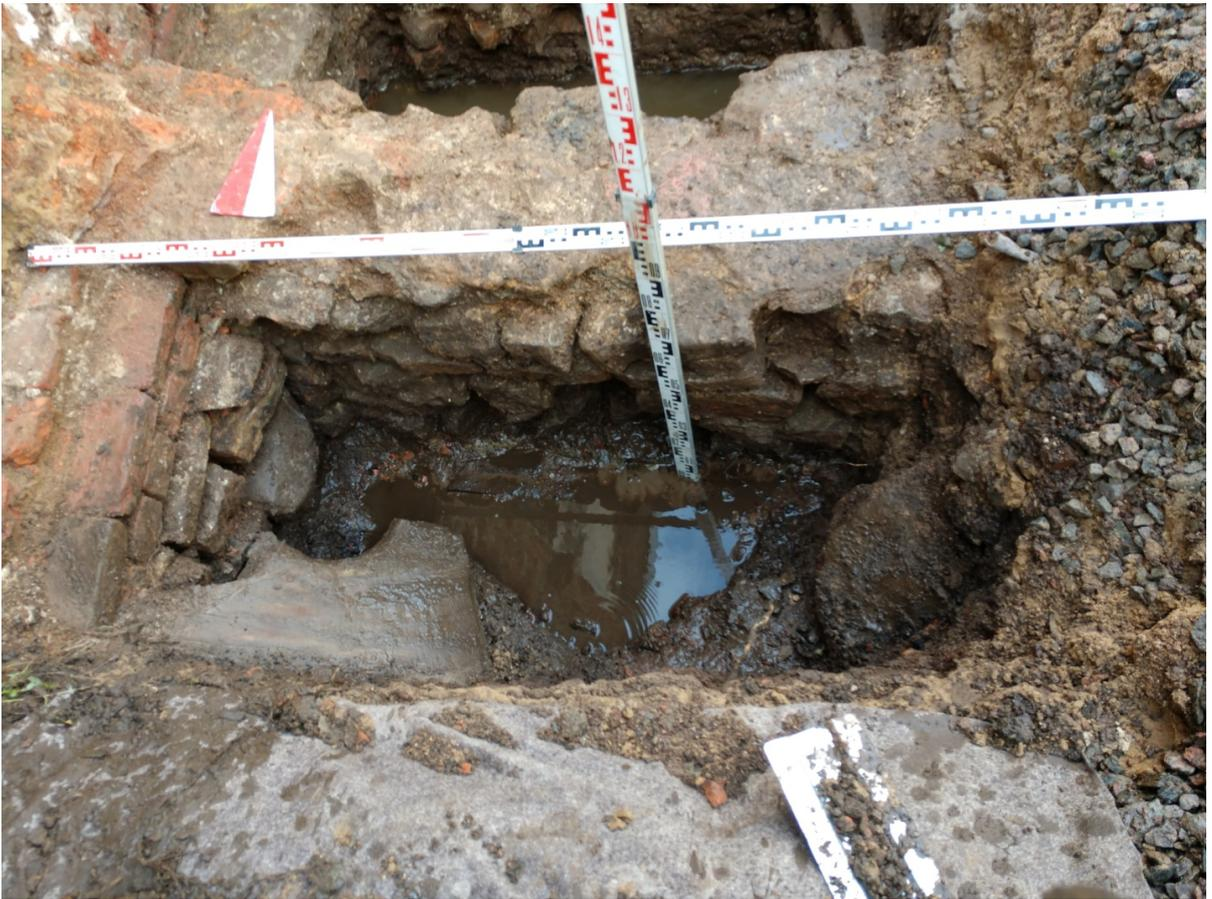
Рис. 26. Моховая, д. 39 - 2019. Фиксация по уровню прекращения работ, южная часть шурфа после откачки воды. Деревянные лежни в основании фундамента. Вид на север.
