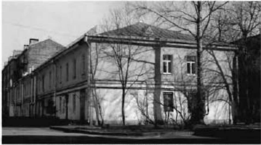
Фото №3. Вид на торцевой (восточный) и дворовой (западный) фасады со стороны сада.
