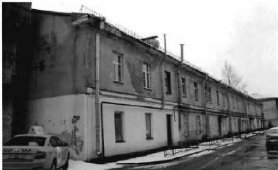
Фото №4. Вид на торцевой (северный) и дворовой (западный) фасады со стороны двора.
