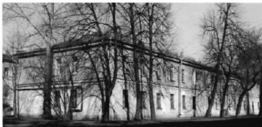
Фото №1. Вид на лицевой (восточный) и торцевой (южный) фасады со стороны Коммунистической ул.
