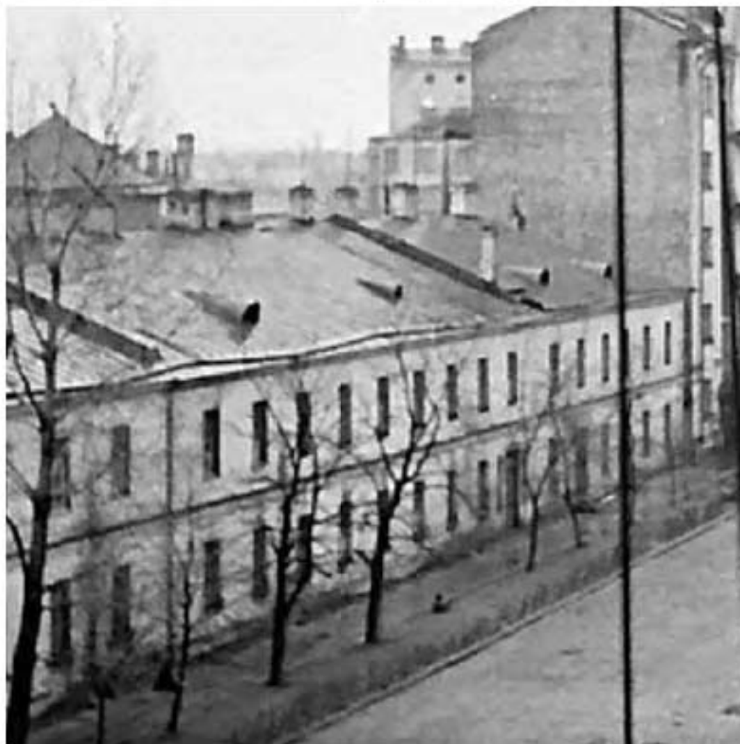
Илл. 18. «Коммунистическая ул. на север», д. 3 и 5. Фотография середины 1960-х гг. (внизу – увеличенный фрагмент, часть здания с пом. 4-Н в 1-м этаже)
