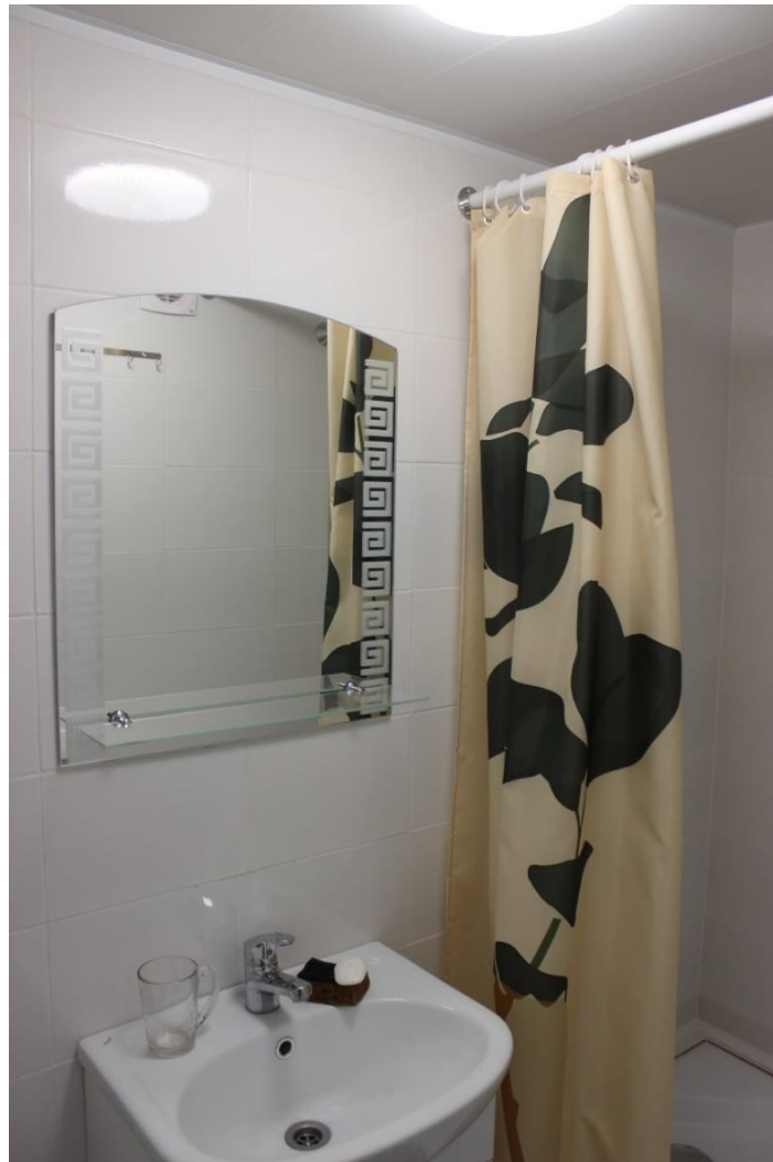
11. Здание по адресу: Санкт-Петербург, улица Чехова, д.3, Лит. А. Санузел в квартире №6
