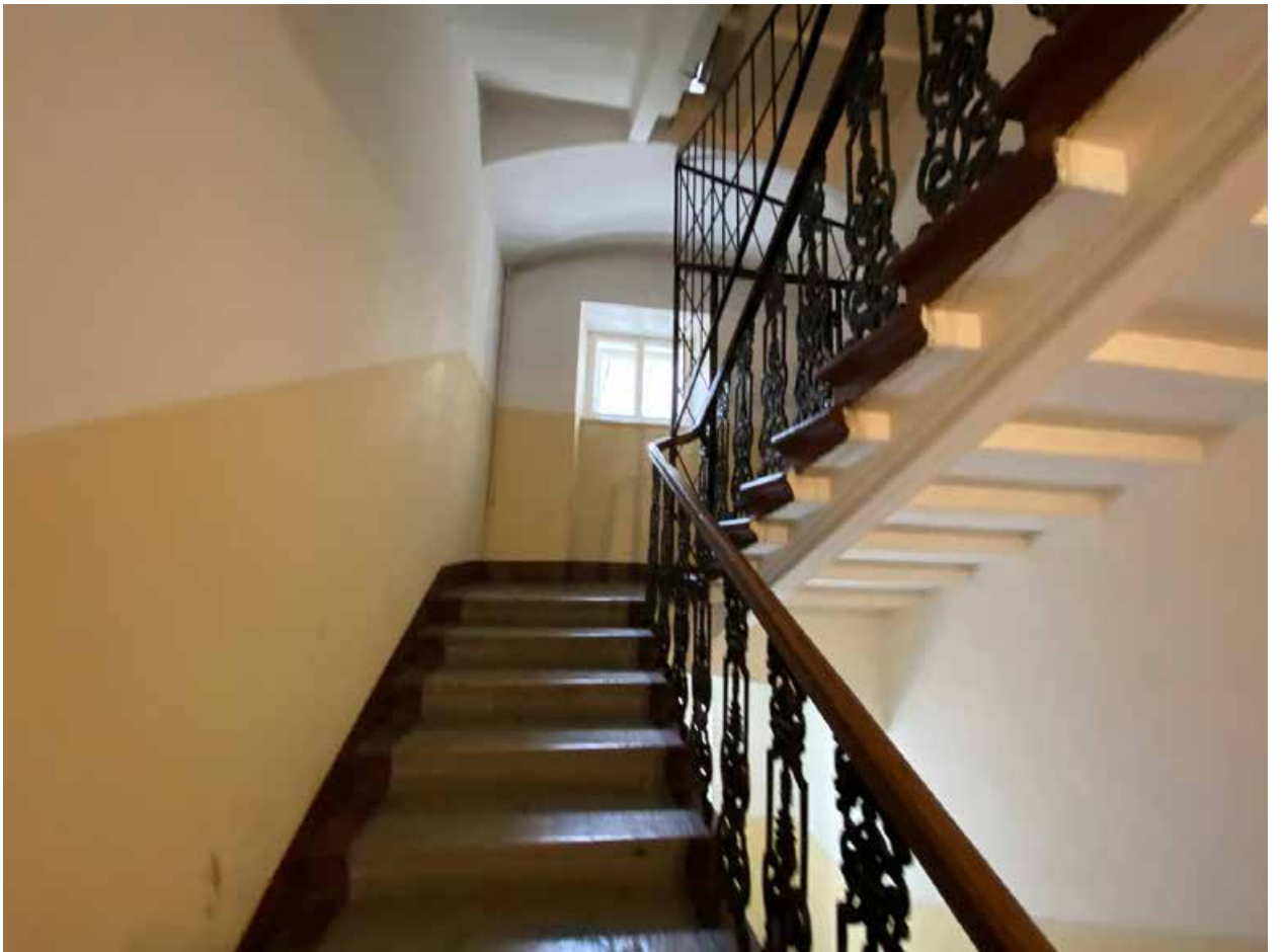
Фото № 78. Лестница ЗЛК между третьим этажом и чердаком.
