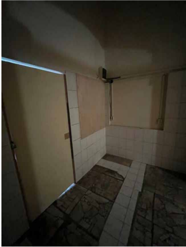
Фото № 99. Цокольный этаж, помещение 1-Н(113).
