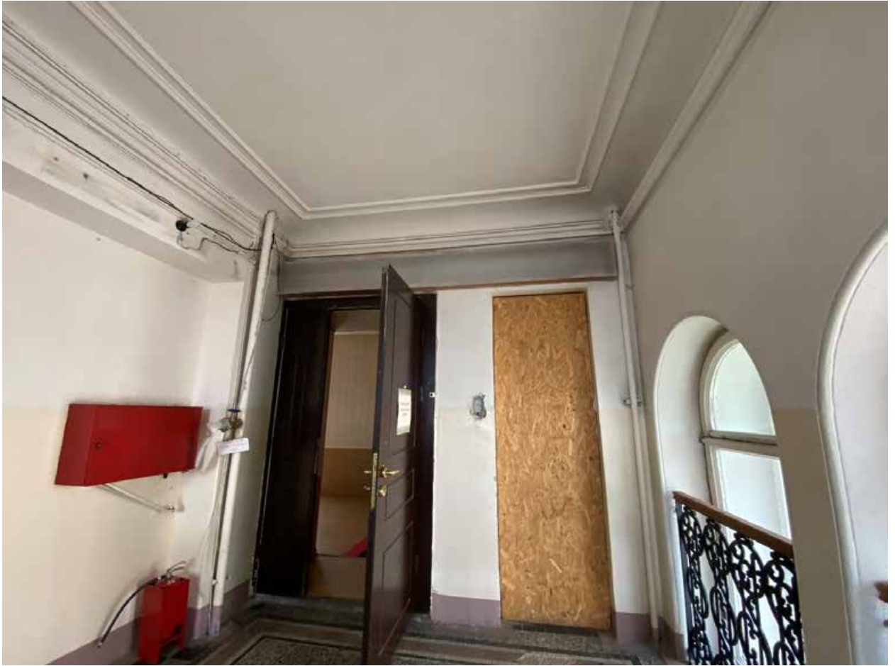
Фото № 37. Лестница 1ЛК в уровне четвертого этажа.
