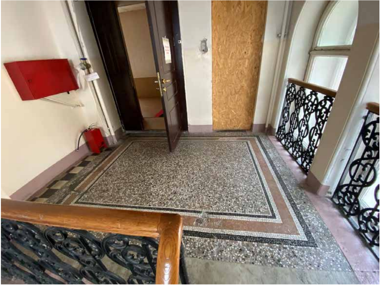
Фото № 36. Лестница 1ЛК в уровне четвертого этажа.
