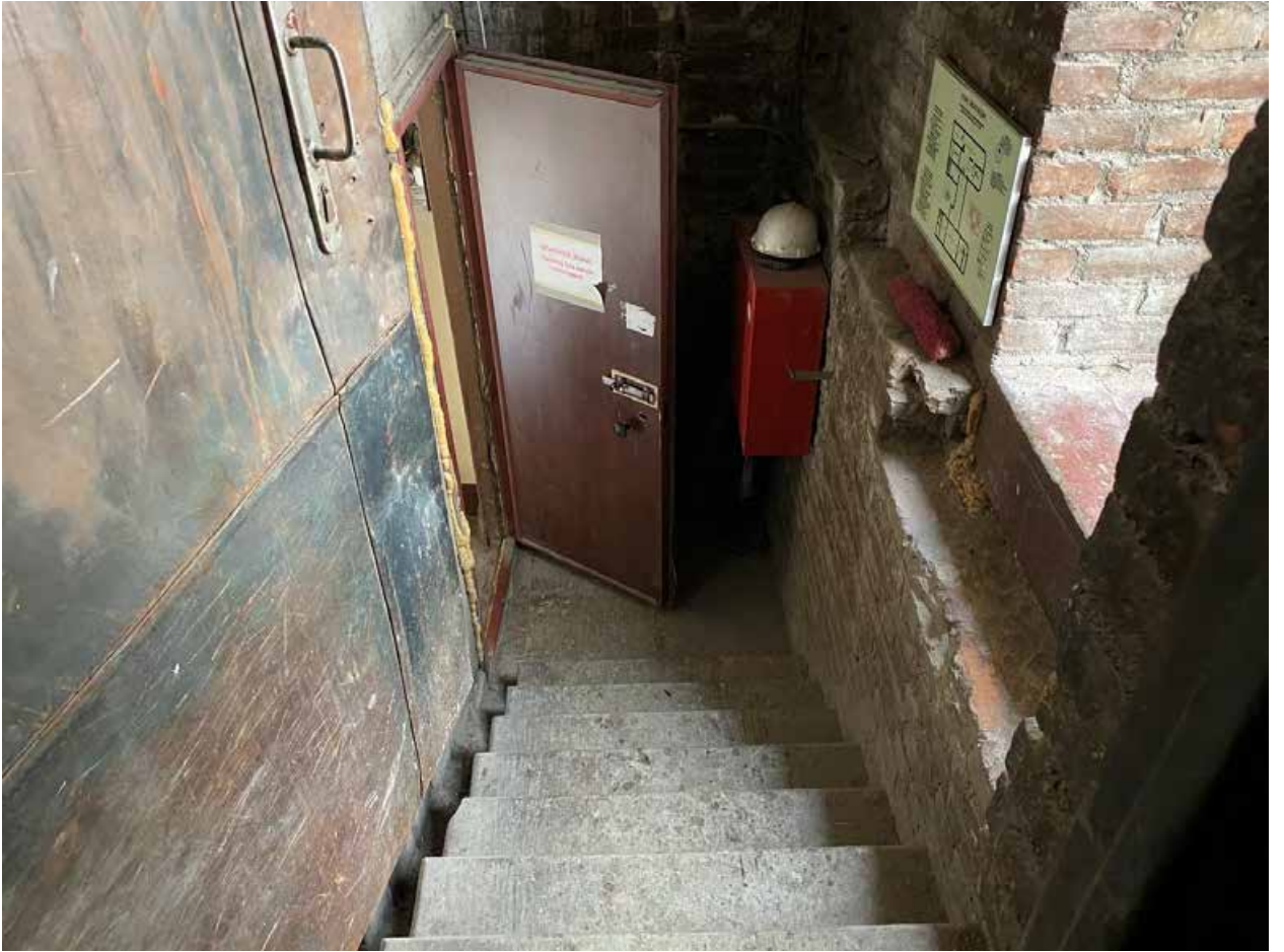
Фото № 386. Технический этаж. Чердак.
