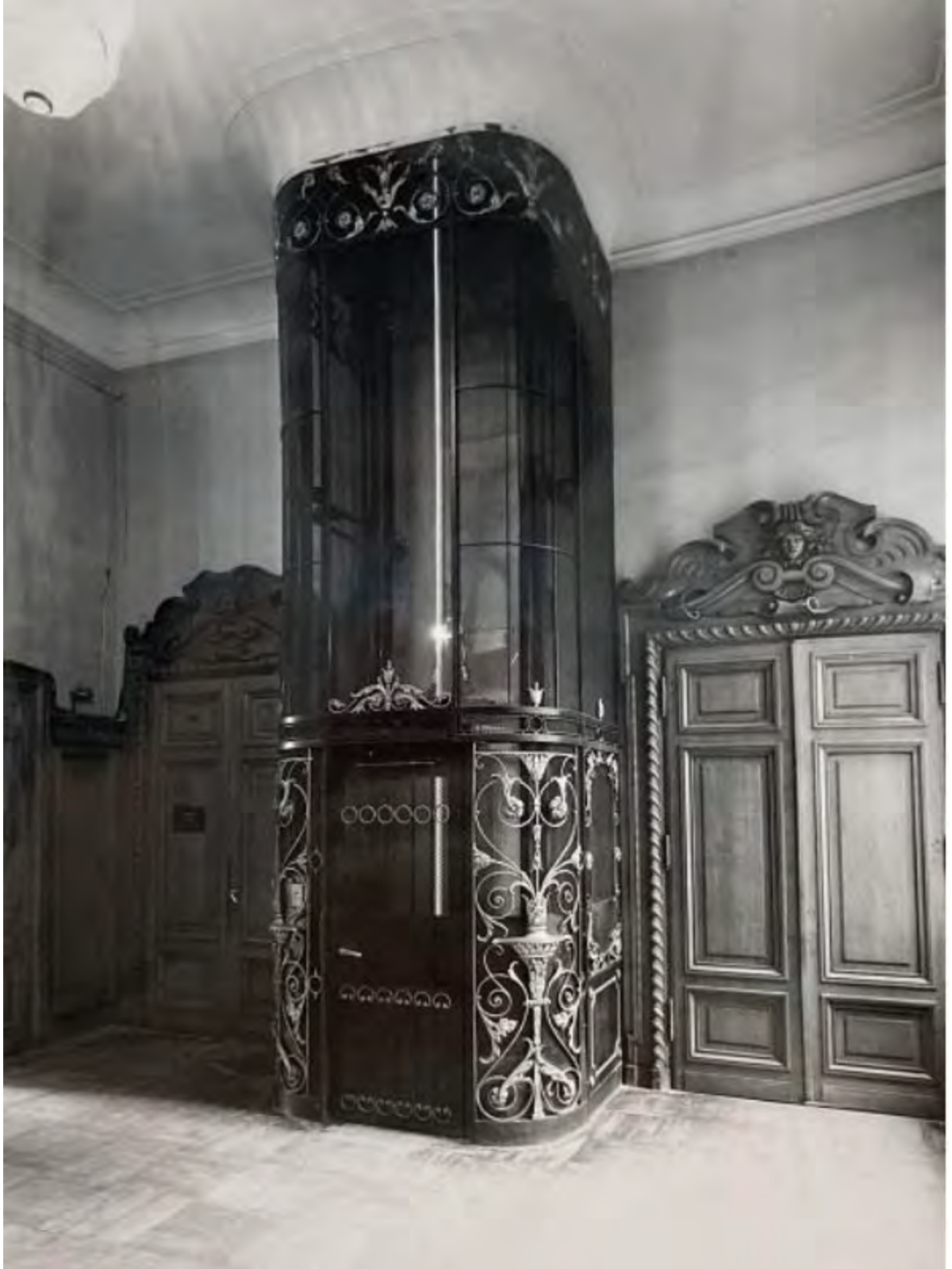
Илл. 58. В. А. Григорьев. Шахта лифта (2 этаж). Фотография. 1992 г. Архив КГИОП. П. 547. № Н-4046.
