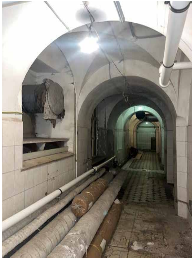
Фото № 104. Цокольный этаж, помещение 1-Н(106).
