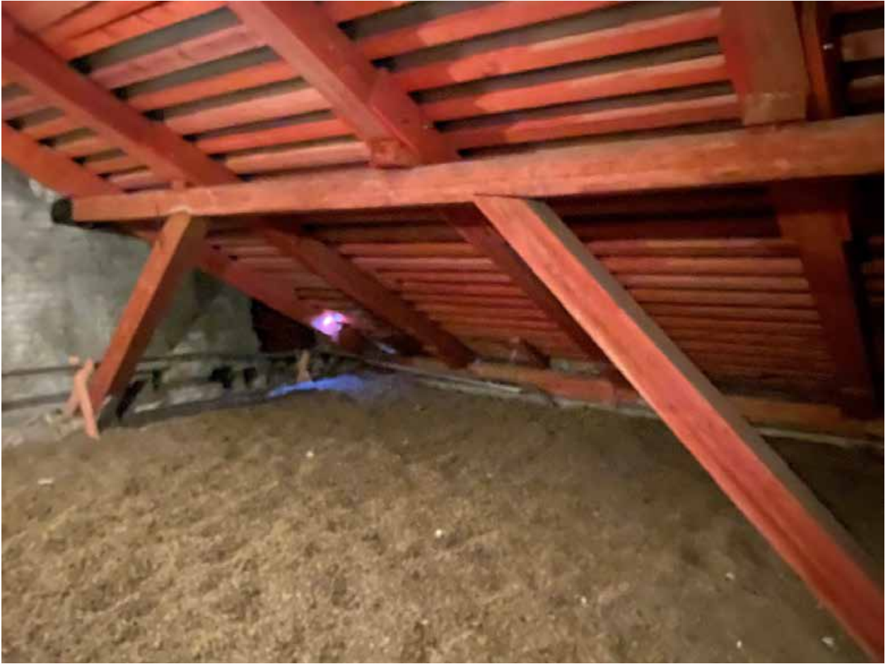
Фото № 375. Технический этаж. Чердак.
