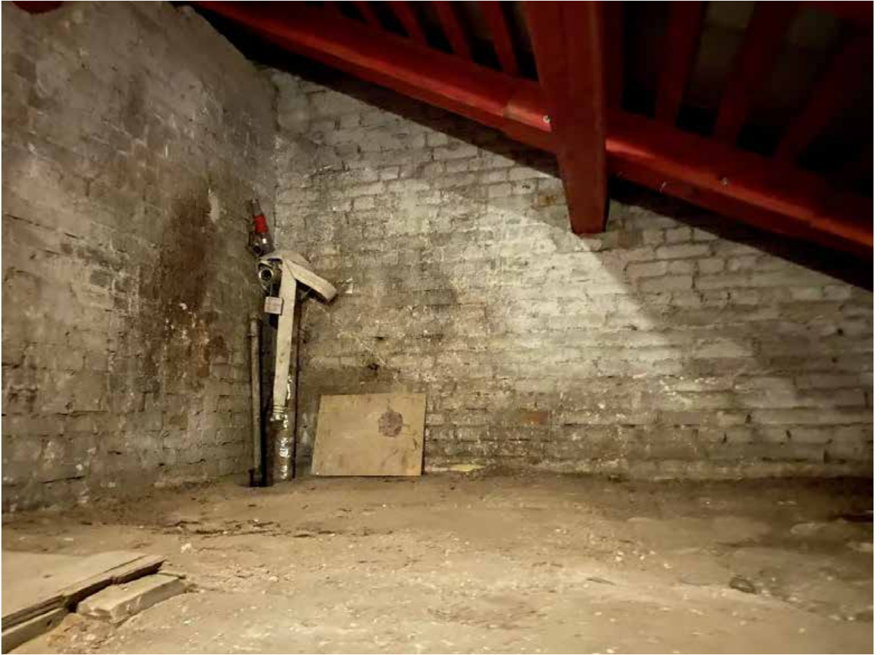
Фото № 368. Технический этаж. Чердак.
