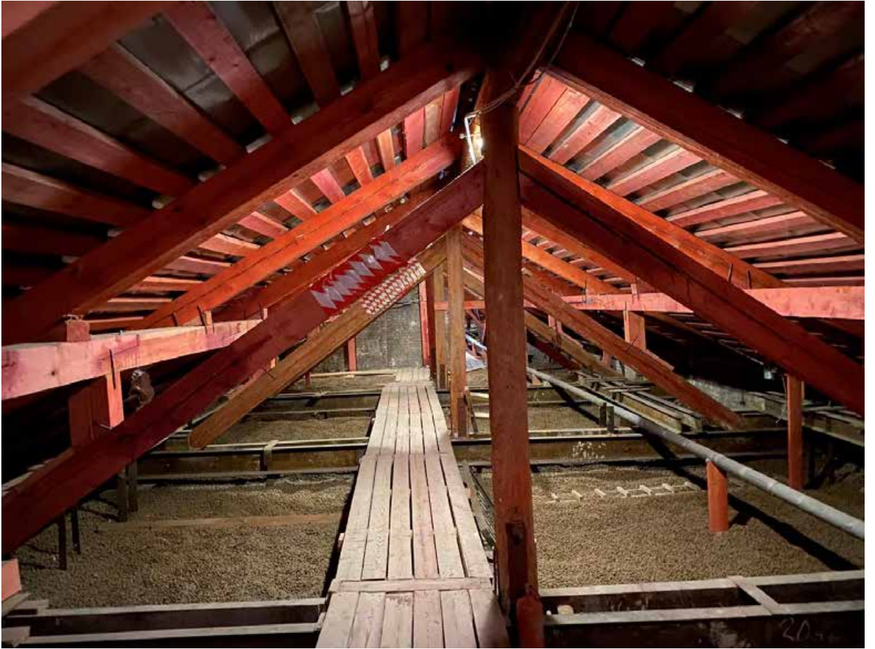
Фото № 381. Технический этаж. Чердак.
