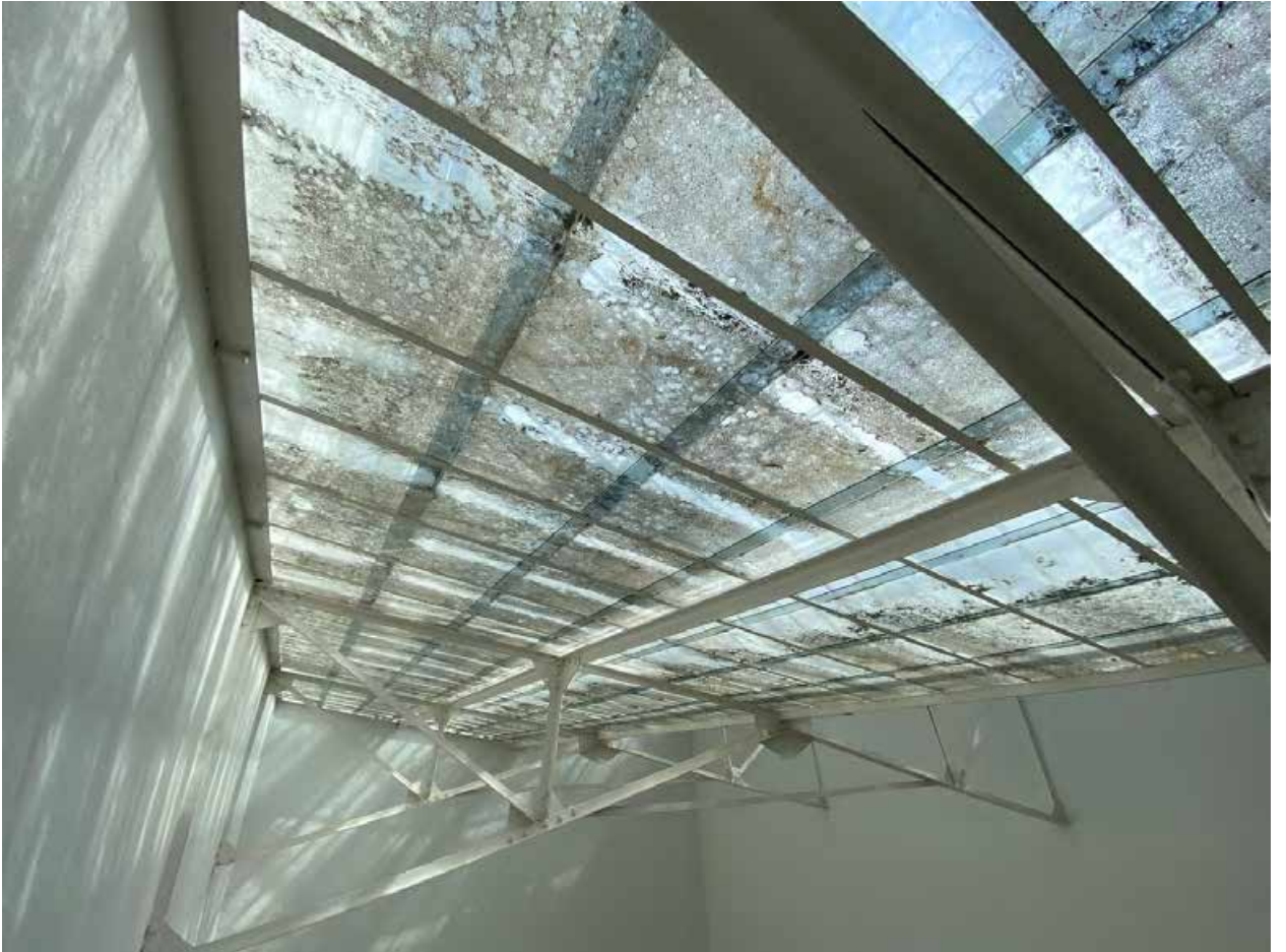
Фото № 394. Технический этаж. Чердак. Конструкции светового фонаря.
