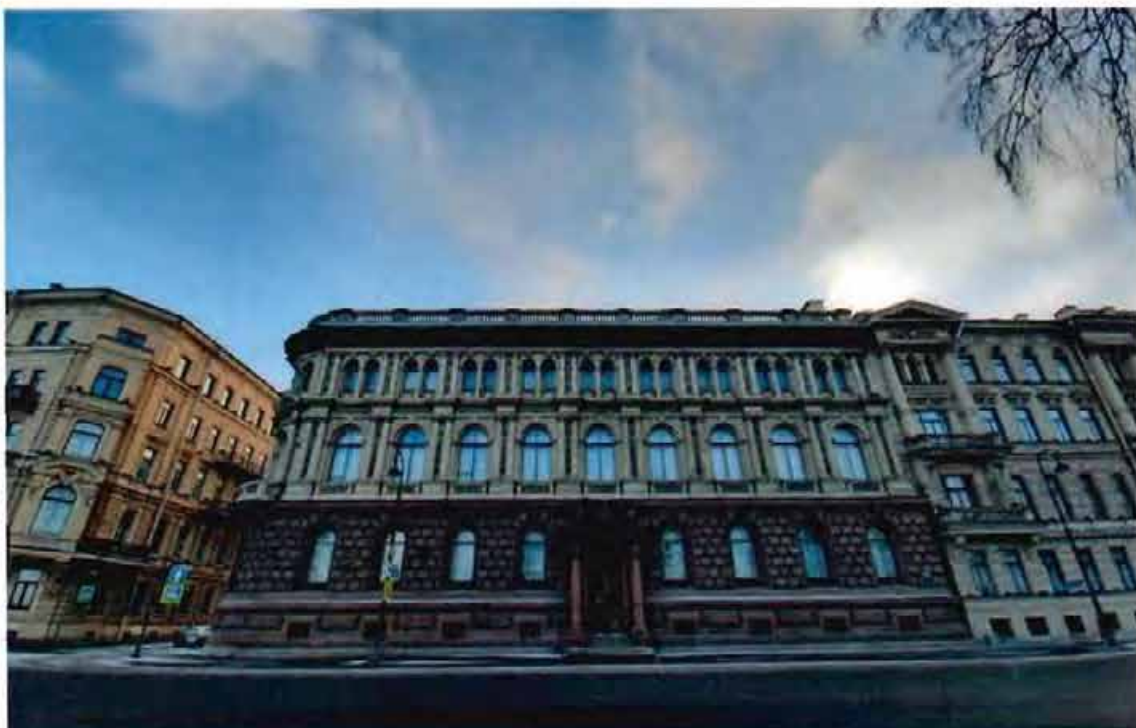
1. Вид на фасад объекта культурного наследия по Адмиралтейской набережной
