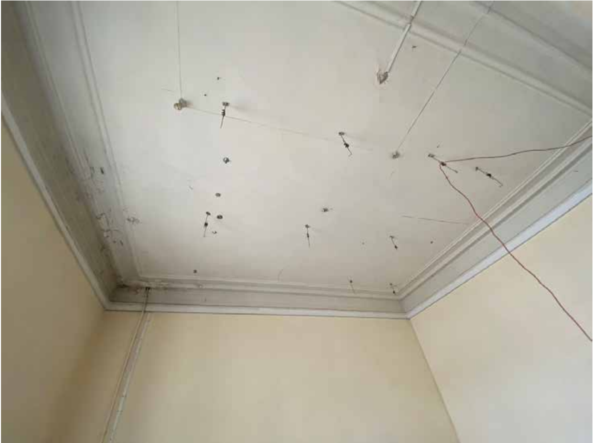
Фото № 325. 4 этаж, помещение 15-Н(9).
