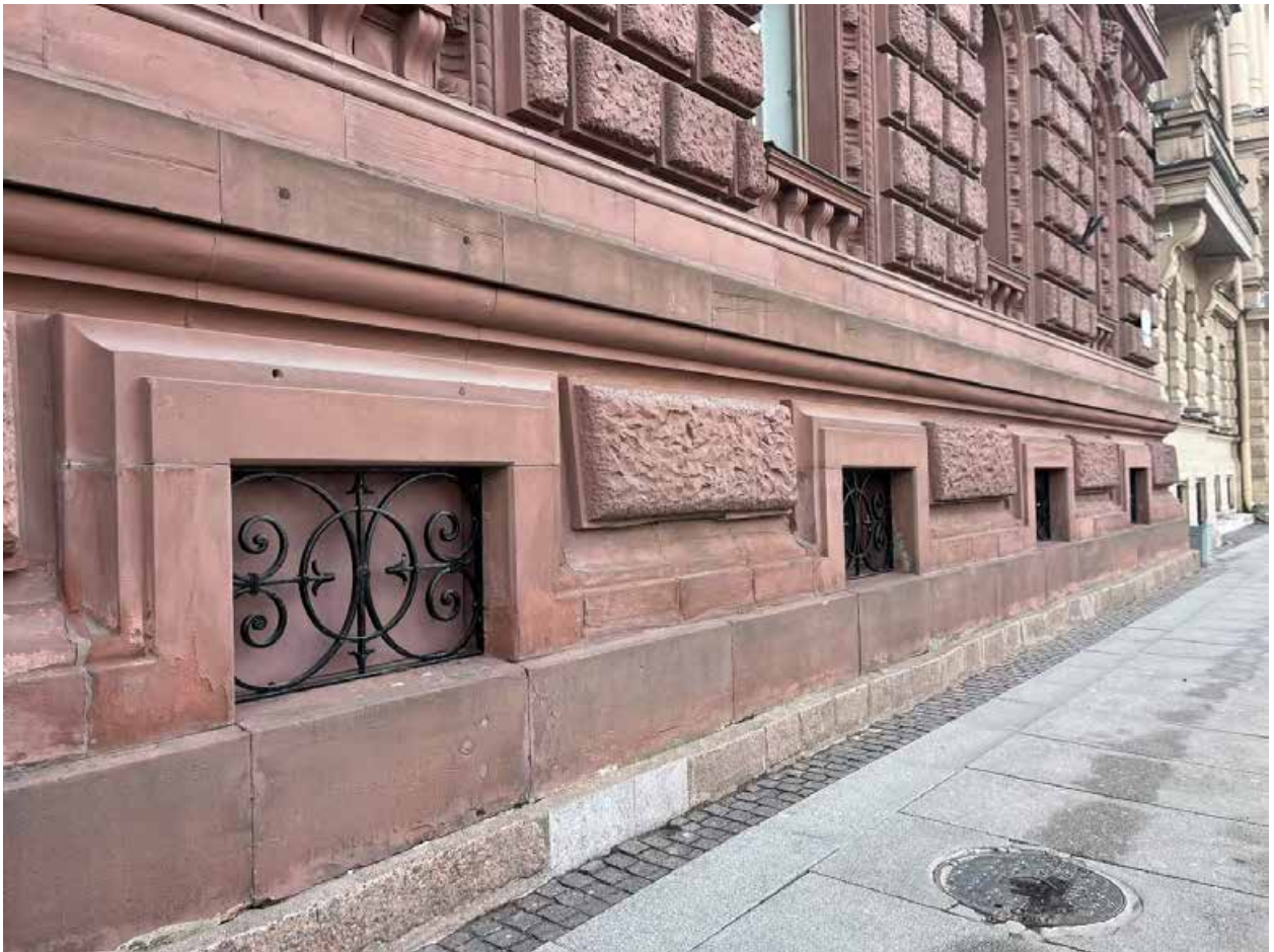
Фото №3. Юго-западный лицевой фасад, цокольная часть.
