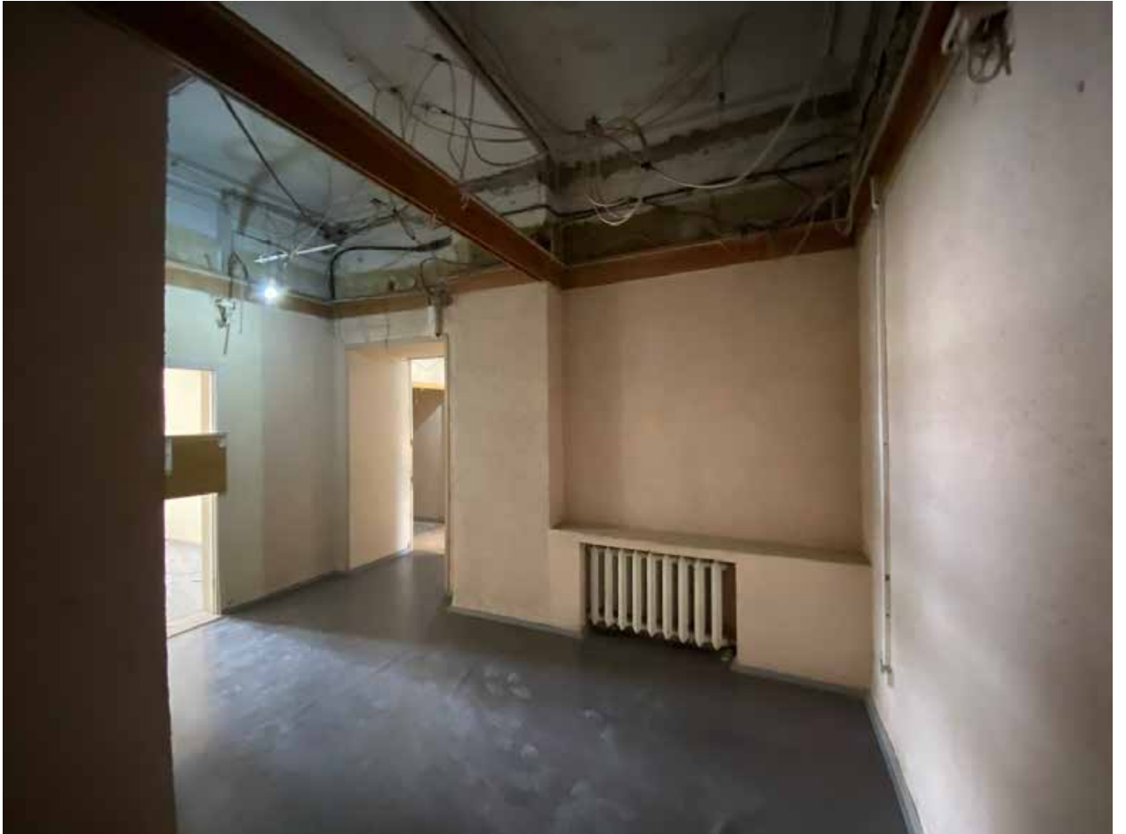
Фото № 314. 4 этаж, помещение 15-Н(17).
