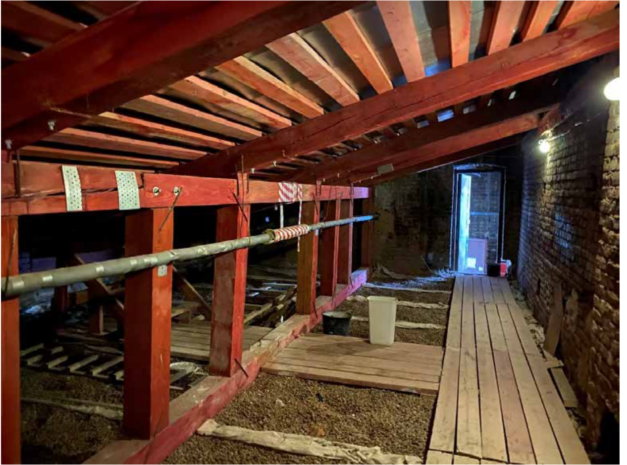
Фото № 384. Технический этаж. Чердак.
