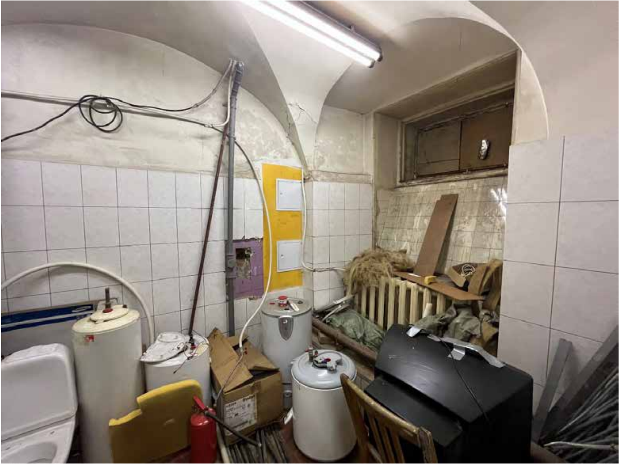
Фото № 95. Цокольный этаж, помещение 1-Н(104).
