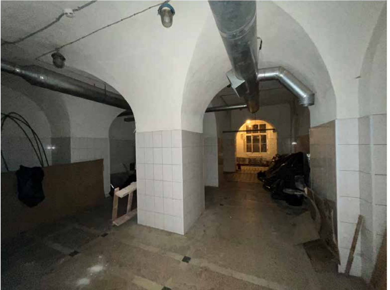
Фото № 92. Цокольный этаж, помещение 1-Н(101).
