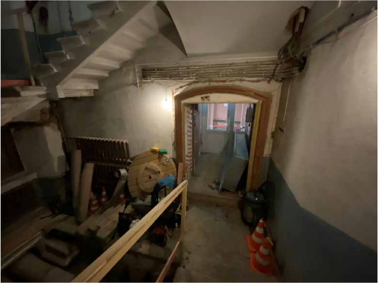
Фото № 55. Лестница 2ЛК в уровне цокольного этажа.
