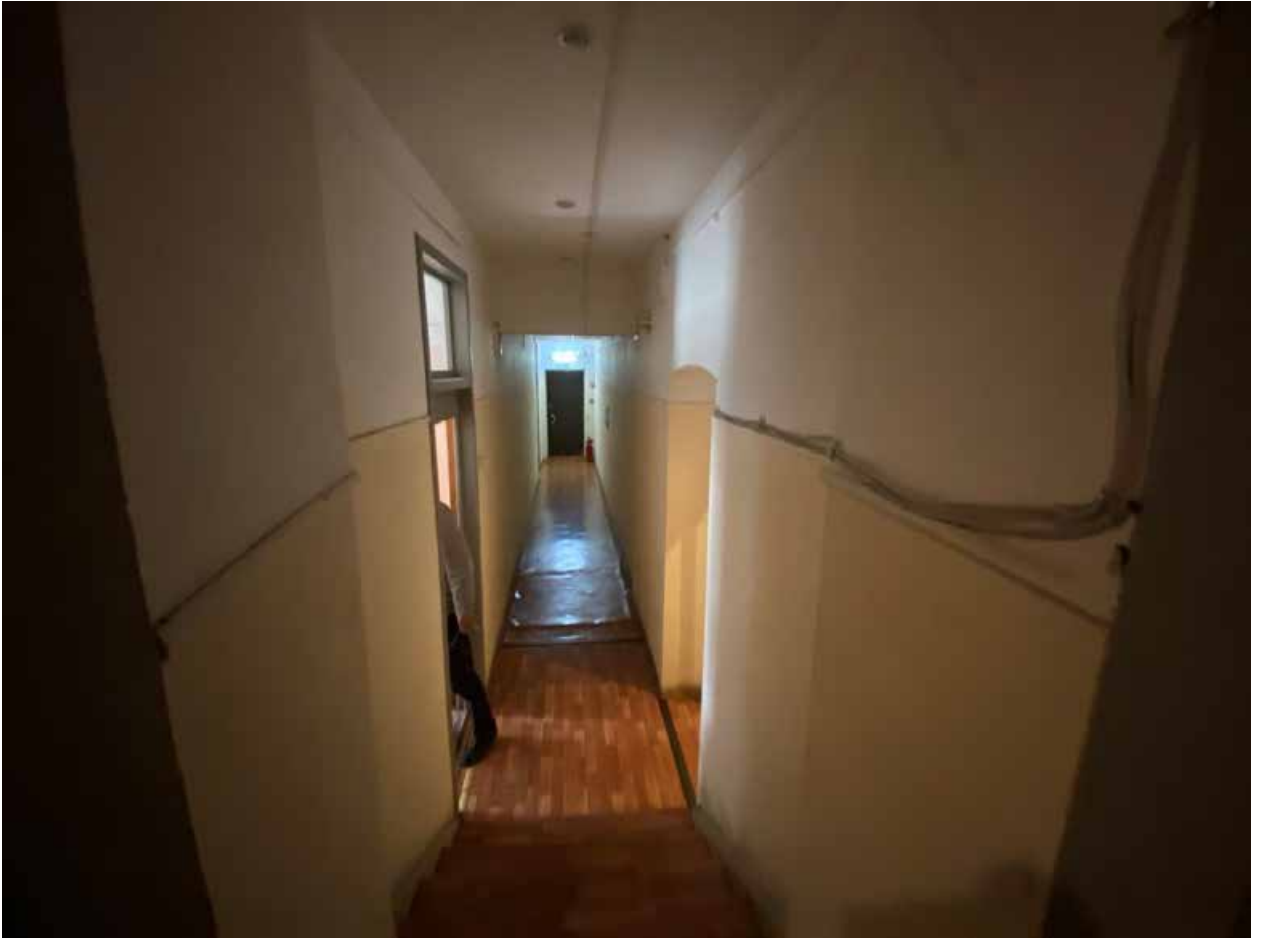
Фото № 347. 4 этаж, помещение 14-Н(14).
