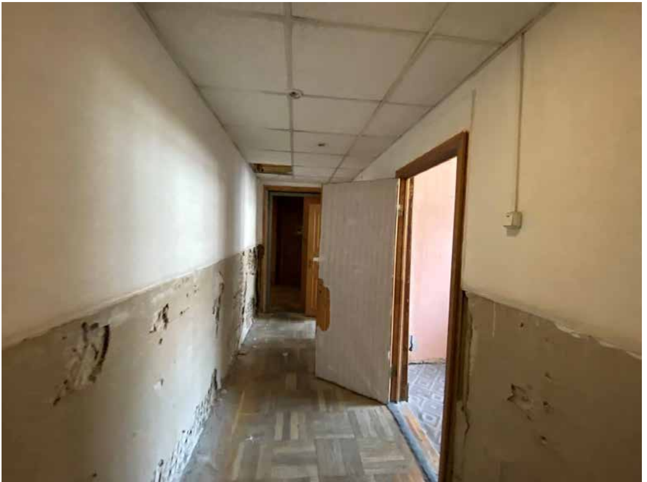
Фото № 342. 4 этаж, помещение 15-Н(7).
