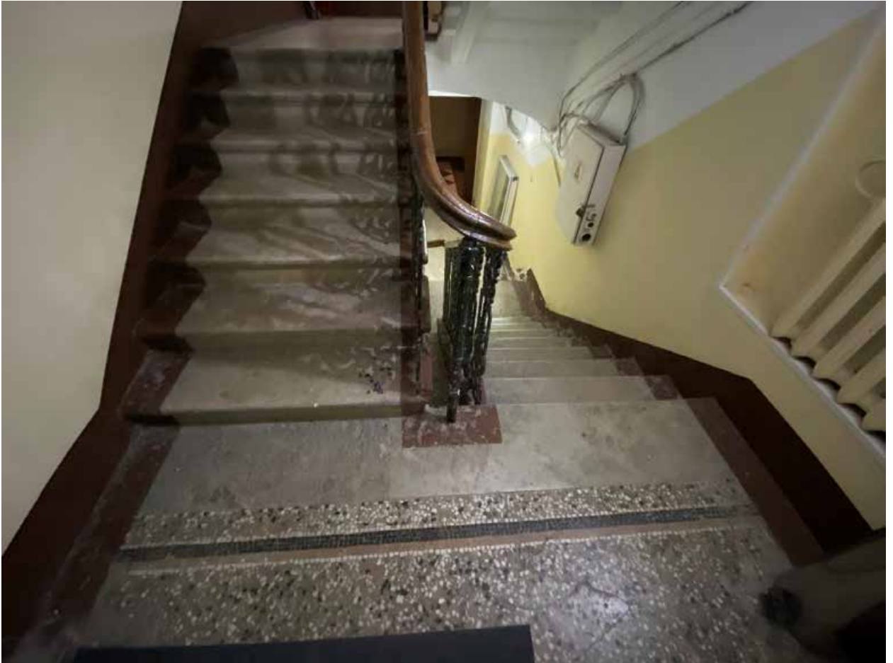
Фото № 68. Лестница ЗЛК между цокольным и первым этажами.
