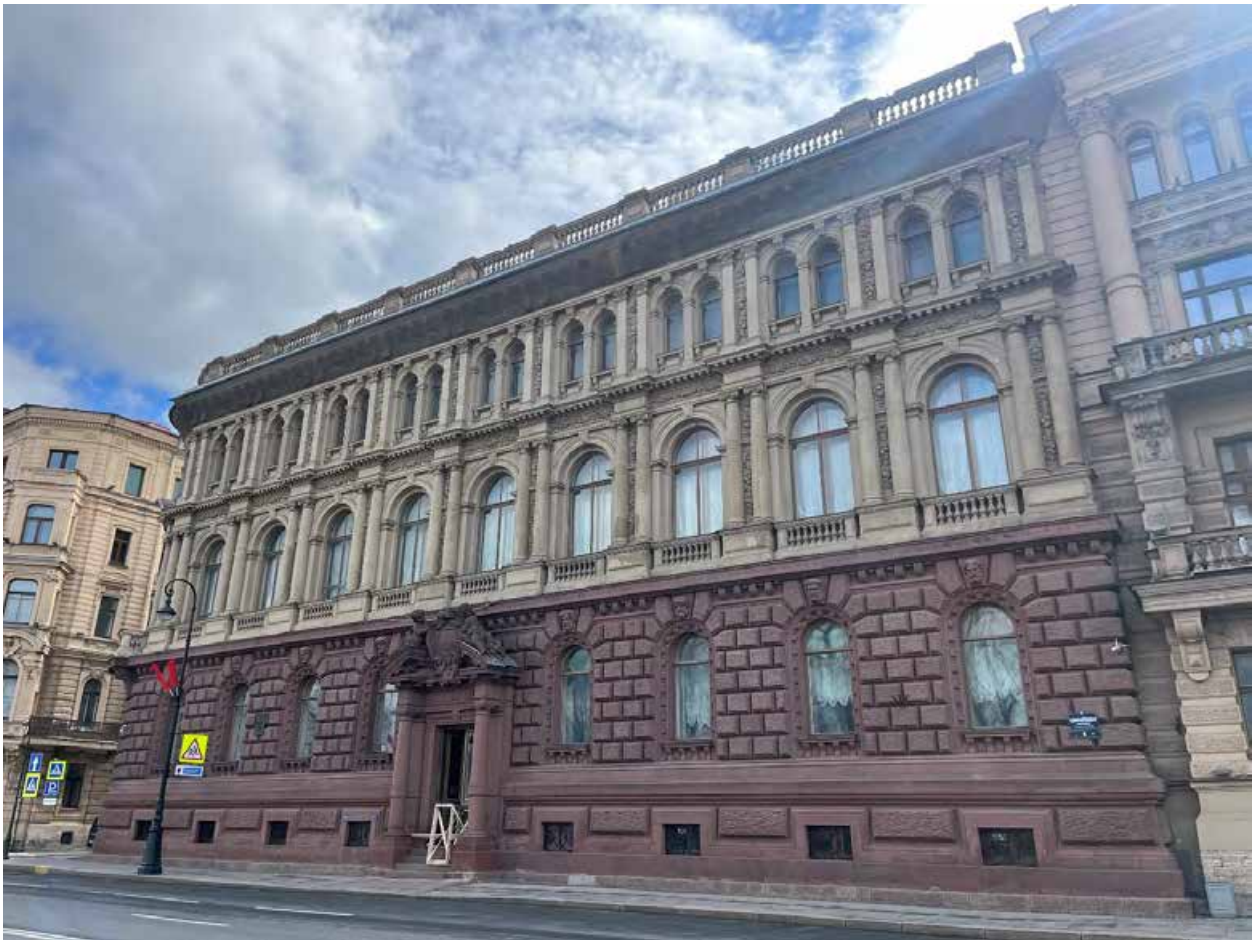
Фото №2. Юго-западный лицевой фасад, общий вид.
