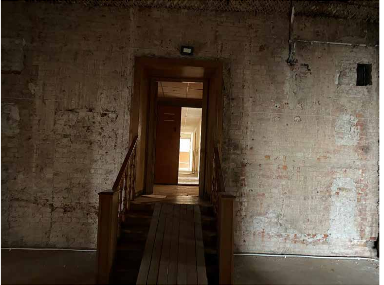
Фото № 355. 4 этаж, помещение 14-Н(2).
