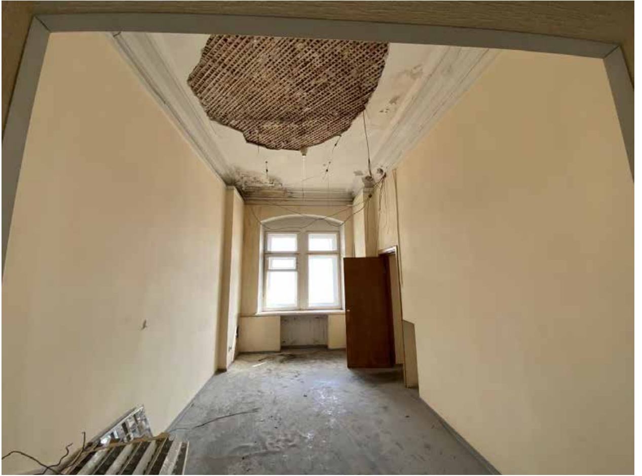
Фото № 317. 4 этаж, помещение 15-Н(7).
