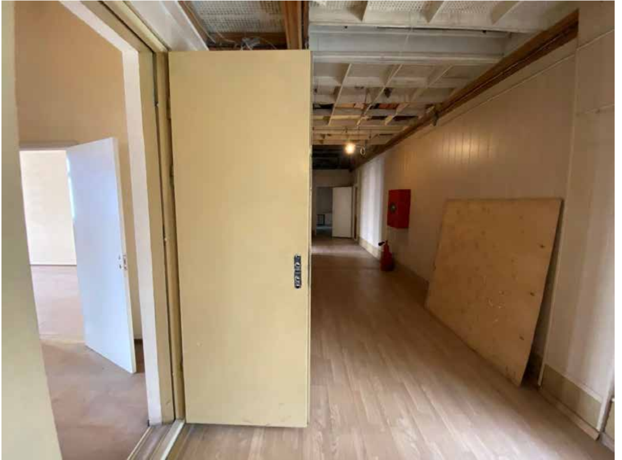
Фото № 305. 4 этаж, помещение 15-Н(18).
