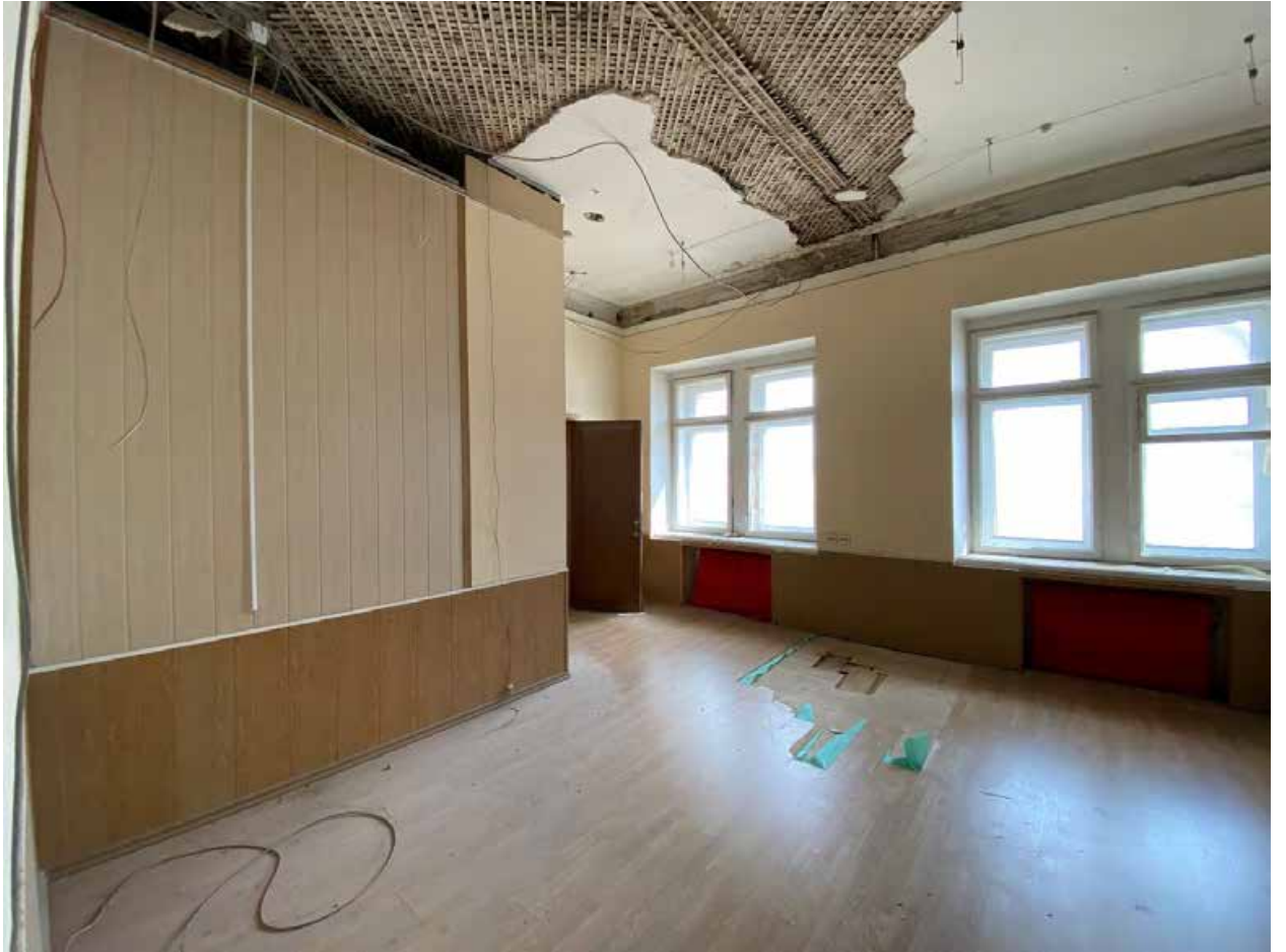
Фото № 322. 4 этаж, помещение 15-Н(8).
