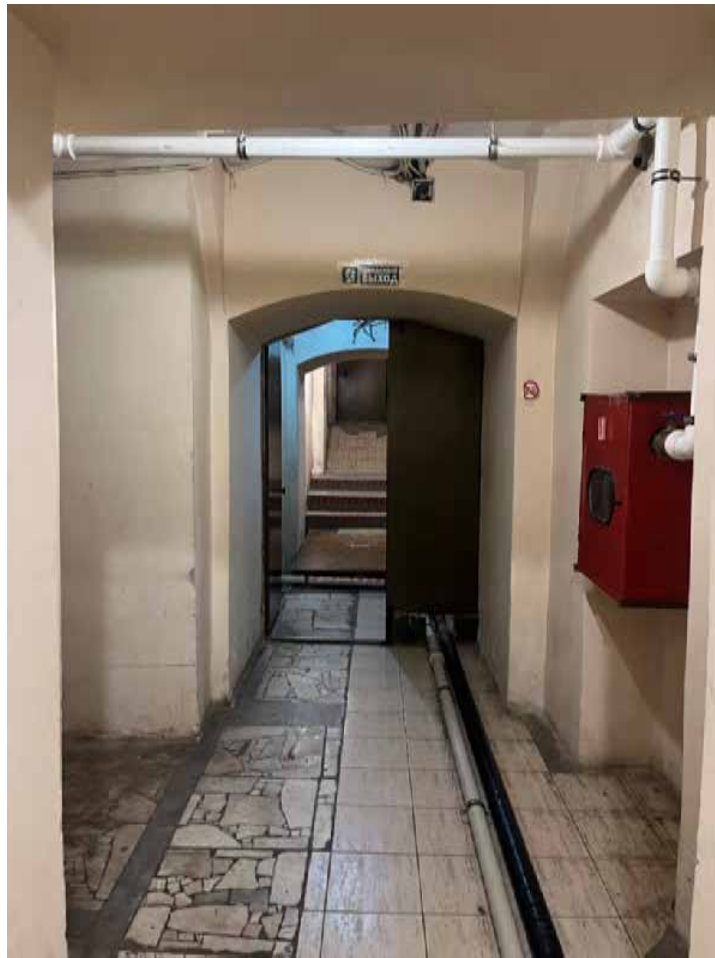
Фото № 97. Цокольный этаж, помещение 1-Н(110).
