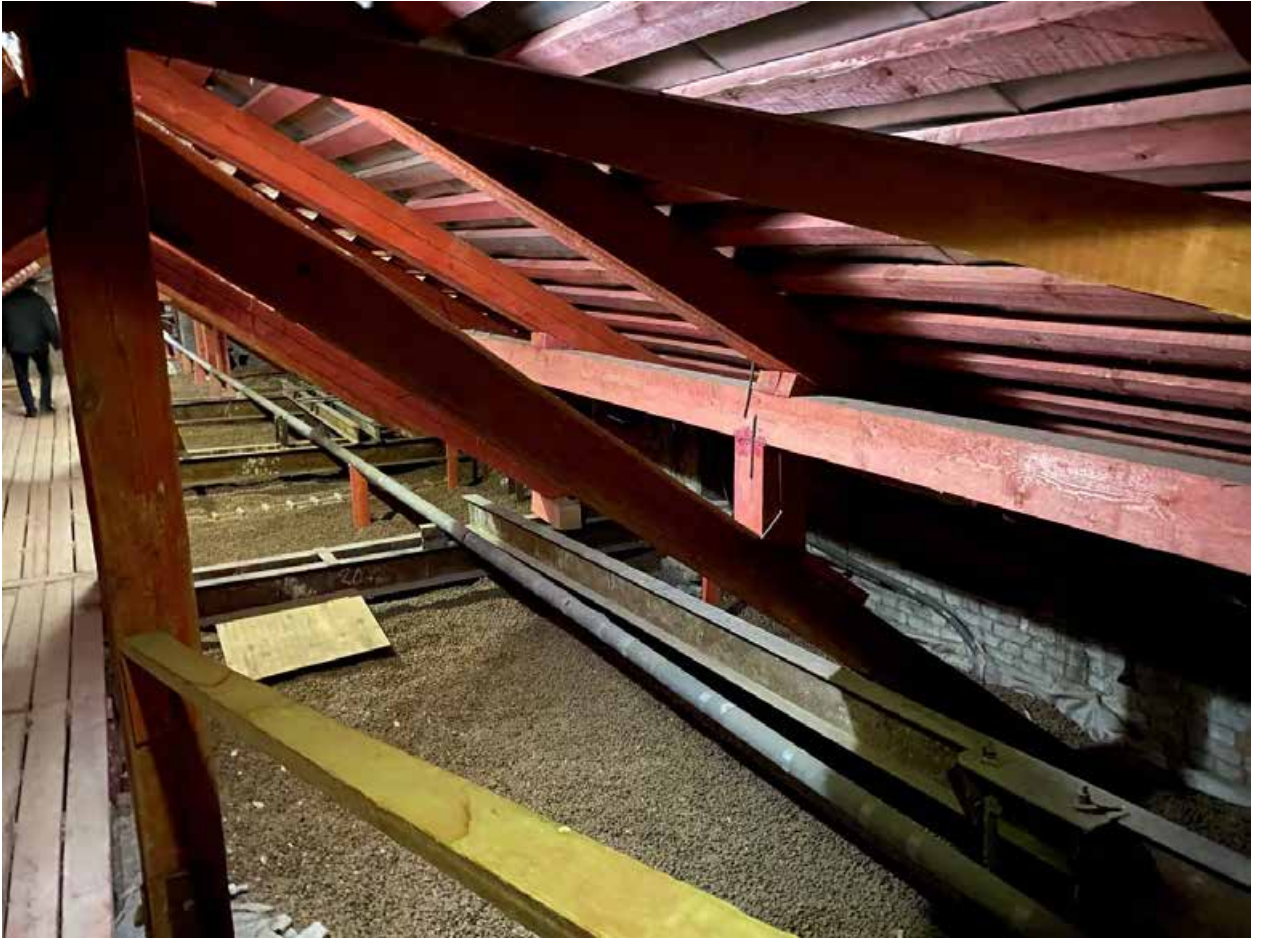
Фото № 380. Технический этаж. Чердак.
