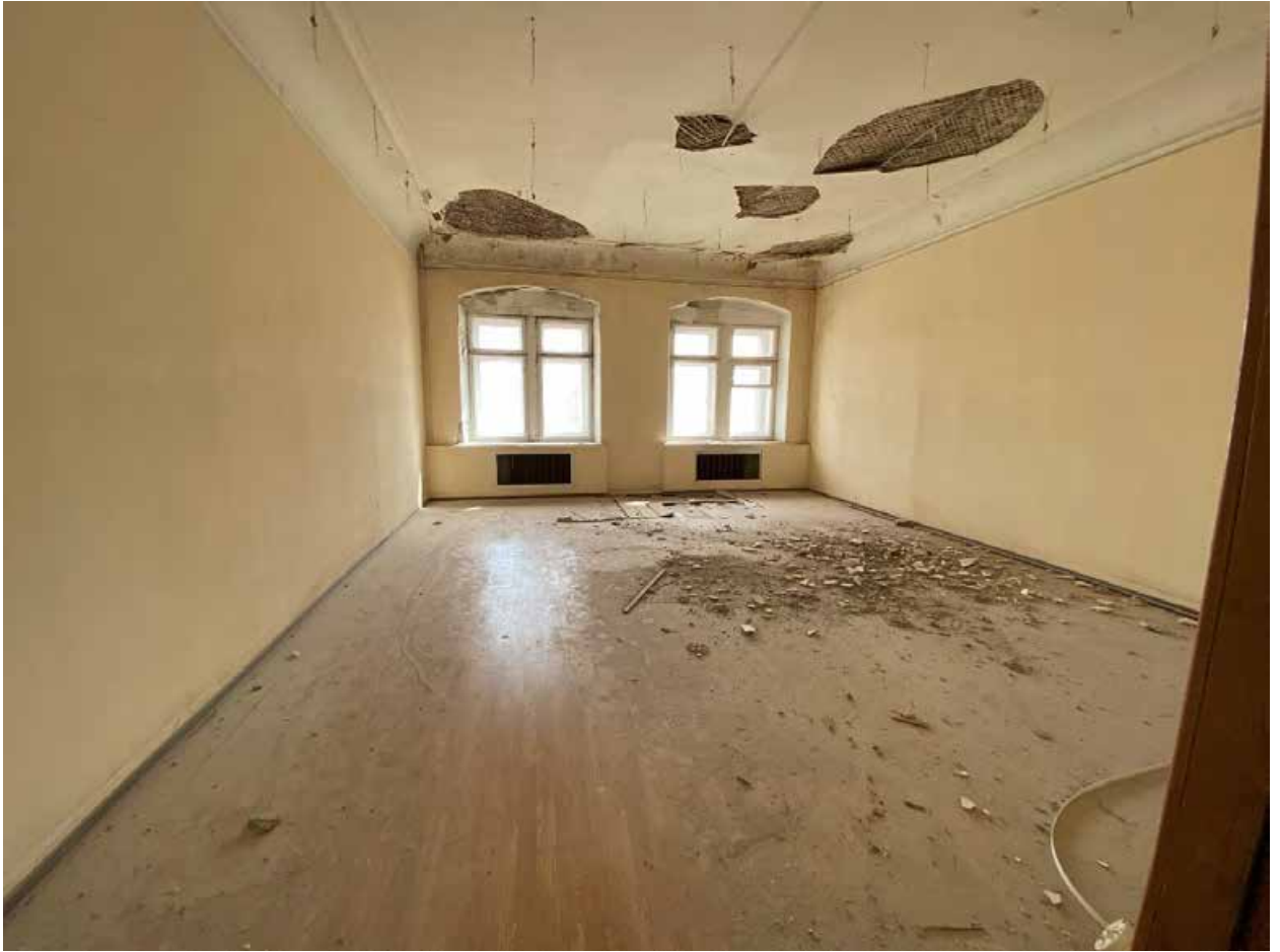
Фото № 312. 4 этаж, помещение 15-Н(6).
