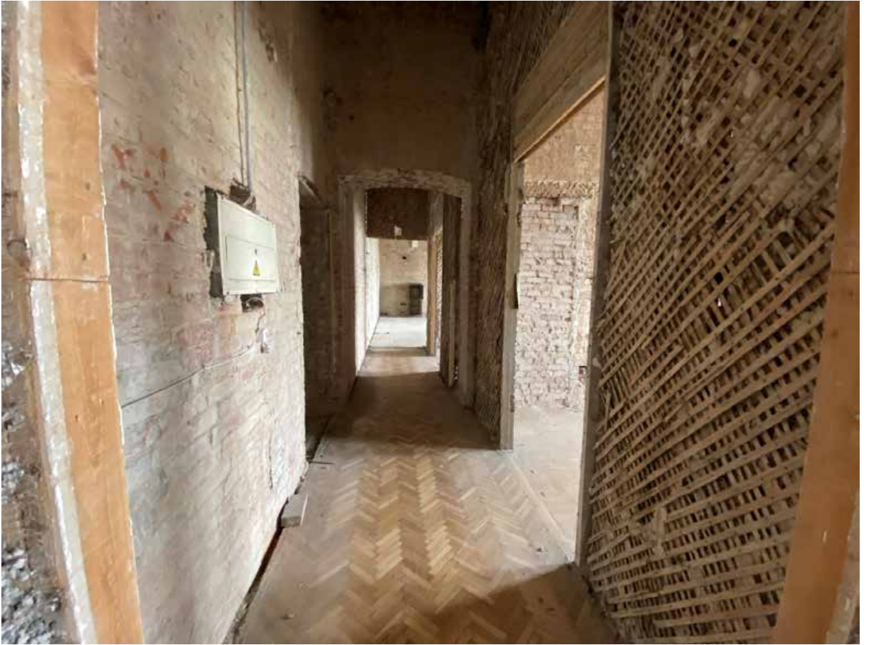
Фото № 358. 4 этаж, помещение 14-Н(20).
