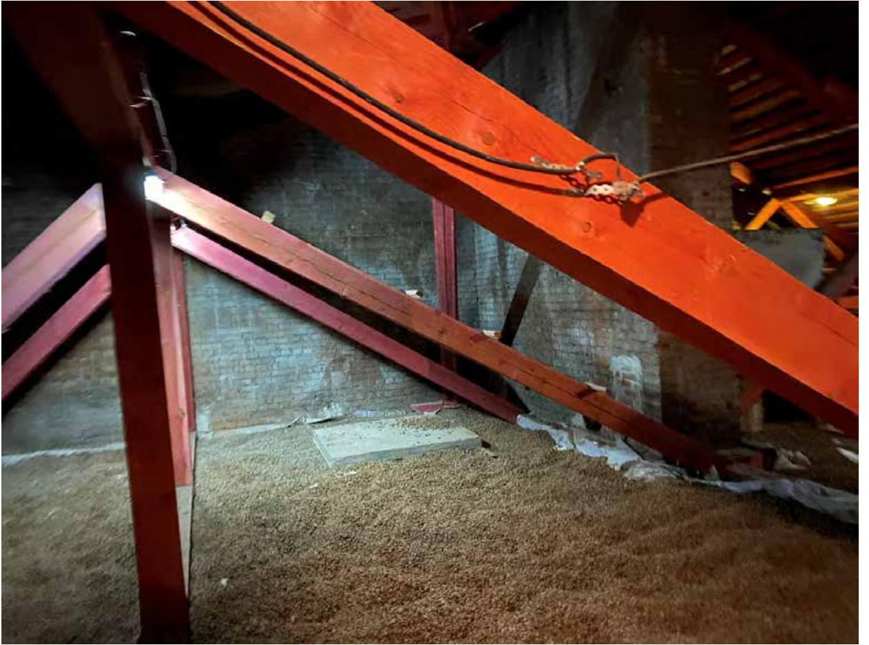
Фото № 389. Технический этаж. Чердак.
