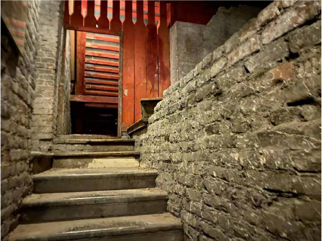
Фото № 367. Технический этаж. Чердак.
