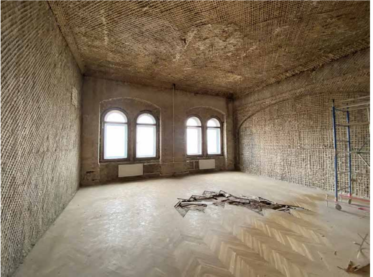
Фото № 357. 4 этаж, помещение 14-Н(22).
