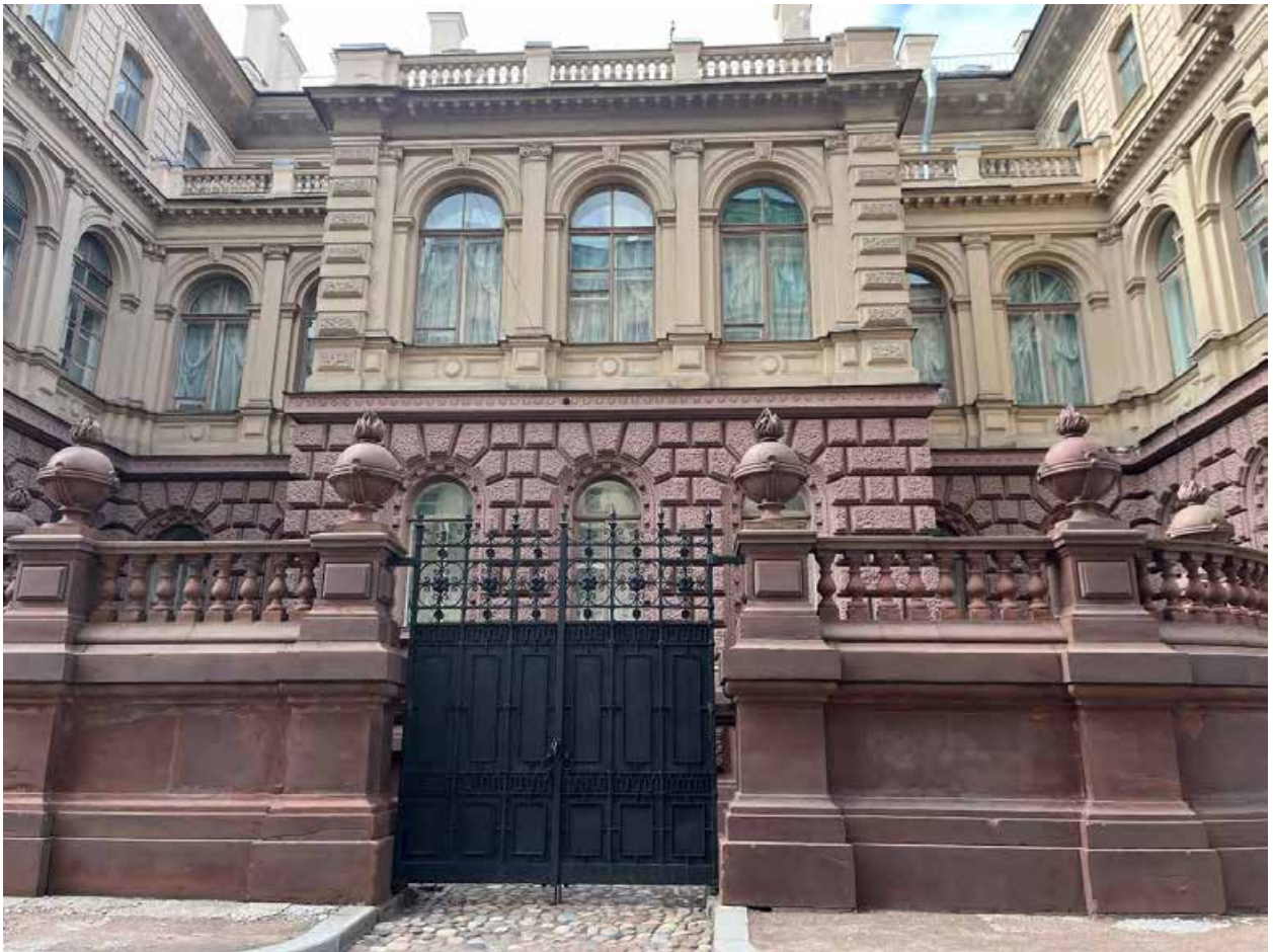
Фото № 6. Северо-восточный лицевой фасад, ограда курдонера с воротным заполнением.
