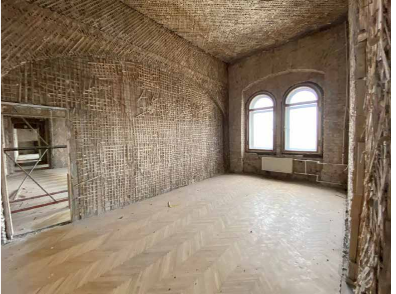
Фото № 365. 4 этаж, помещение 14-Н(23).
