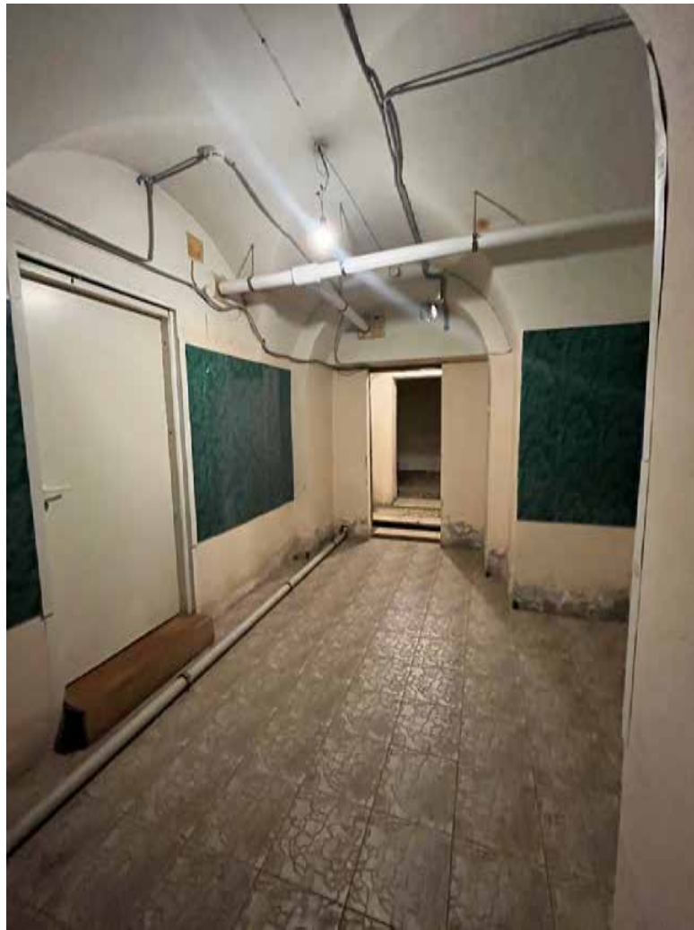
Фото № 93. Цокольный этаж, помещение 1-Н(106).
