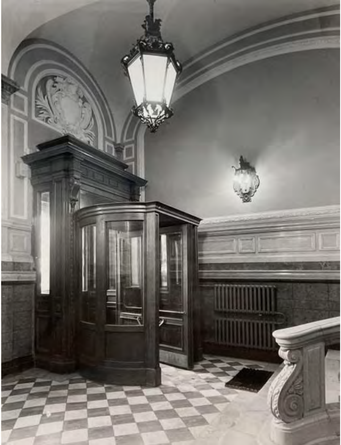
Илл. 55. В. А. Григорьев. Вестибюль дворца. Тамбур и советская пристройка с «вертушкой». Фотография. 1992 г. Архив КГИОП. П. 547. № Н-4046.
