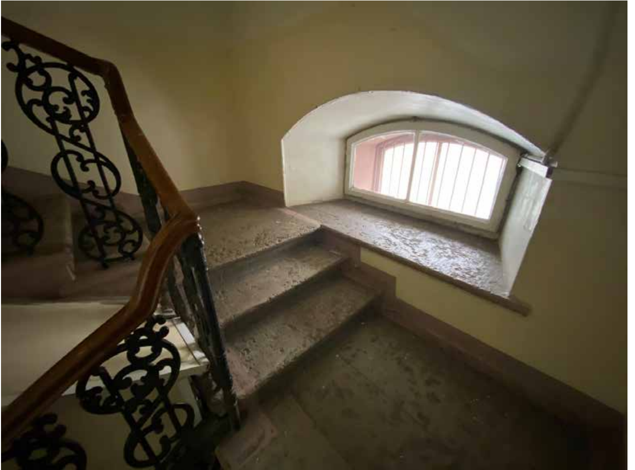
Фото № 20. Лестница 1ЛК между цокольным и первыми этажами.
