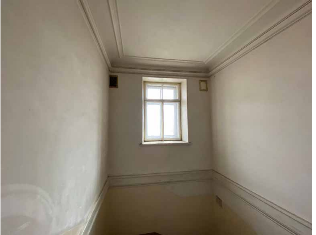
Фото № 38. Лестница 1ЛК в уровне четвертого этажа.
