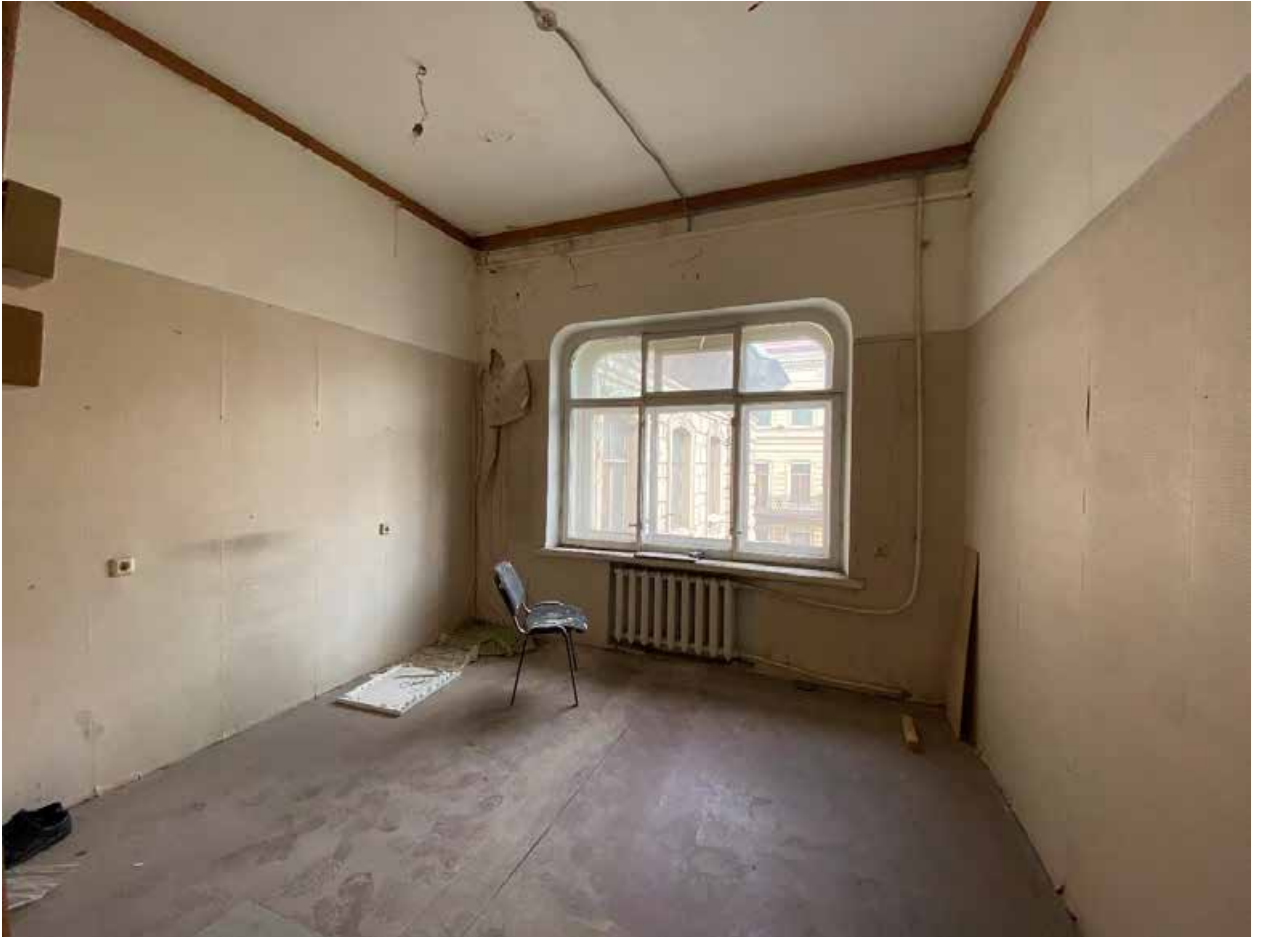
Фото № 344. 4 этаж, помещение 15-Н(4).
