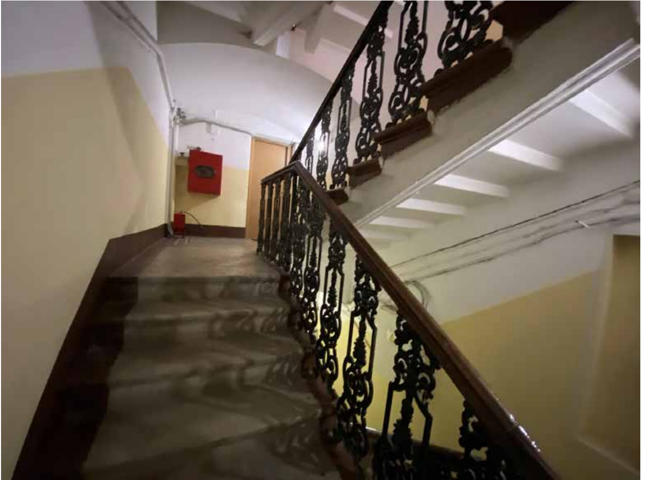
Фото № 69. Лестница ЗЛК между цокольным и первым этажами.
