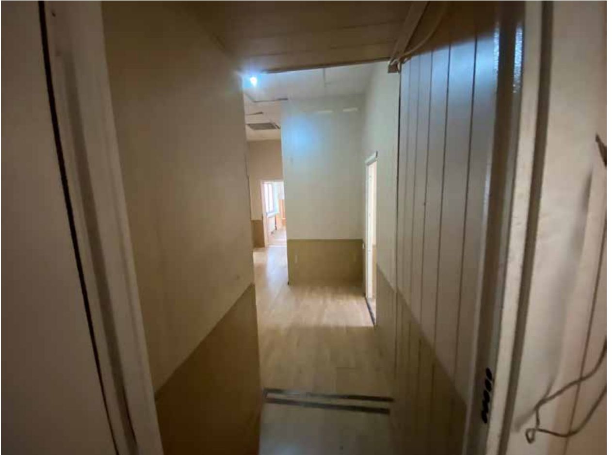
Фото № 313. 4 этаж, помещение 15-Н(17,18).
