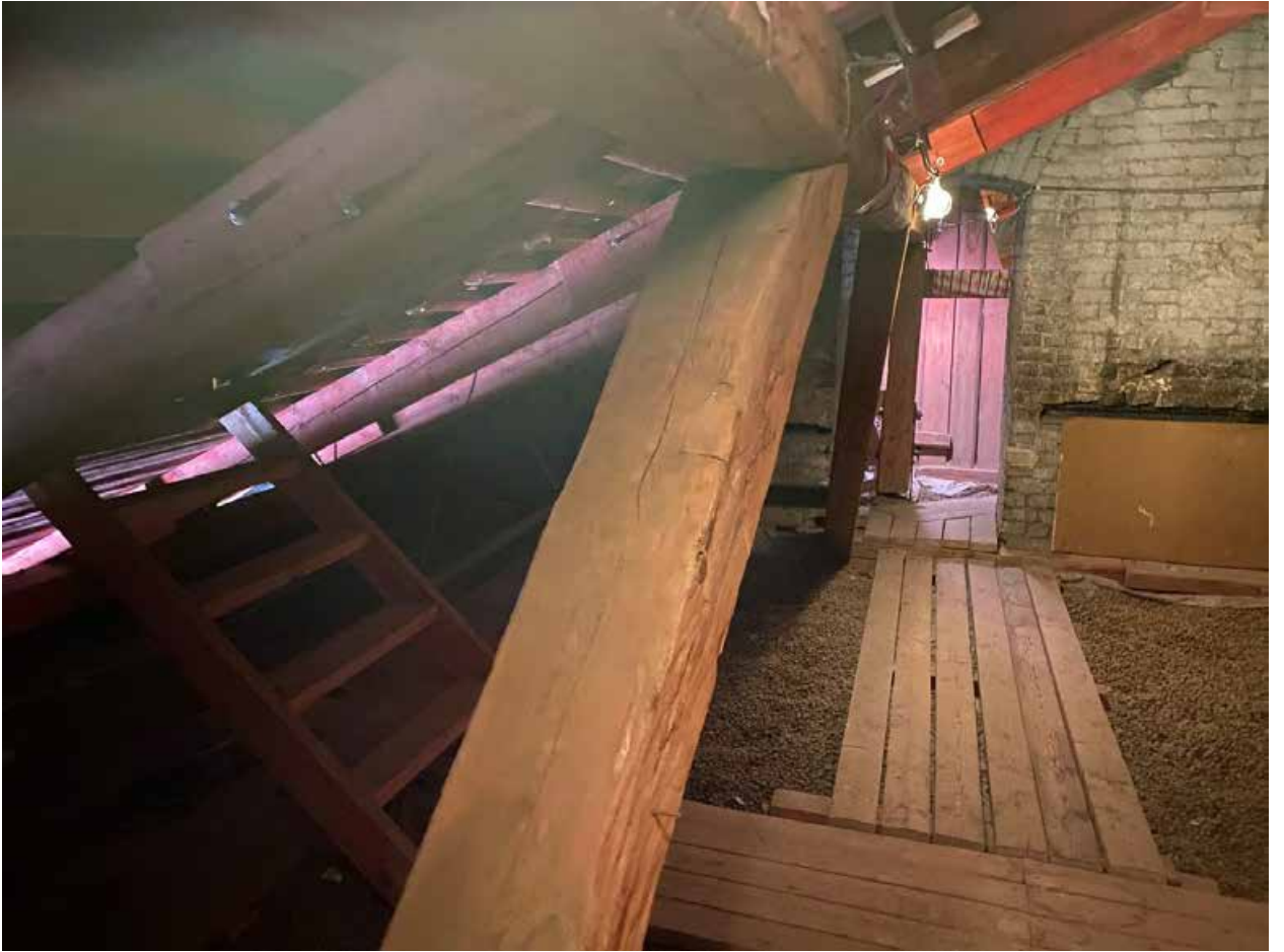
Фото № 372. Технический этаж. Чердак.
