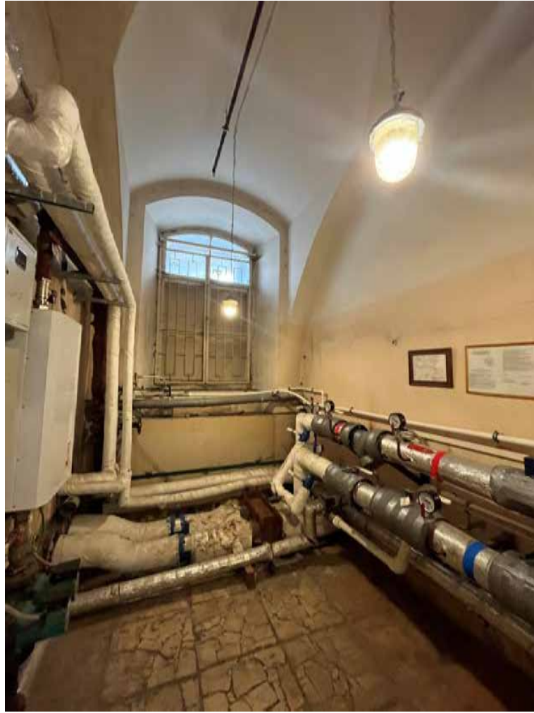
Фото № 103. Цокольный этаж, помещение 1-Н(115).
