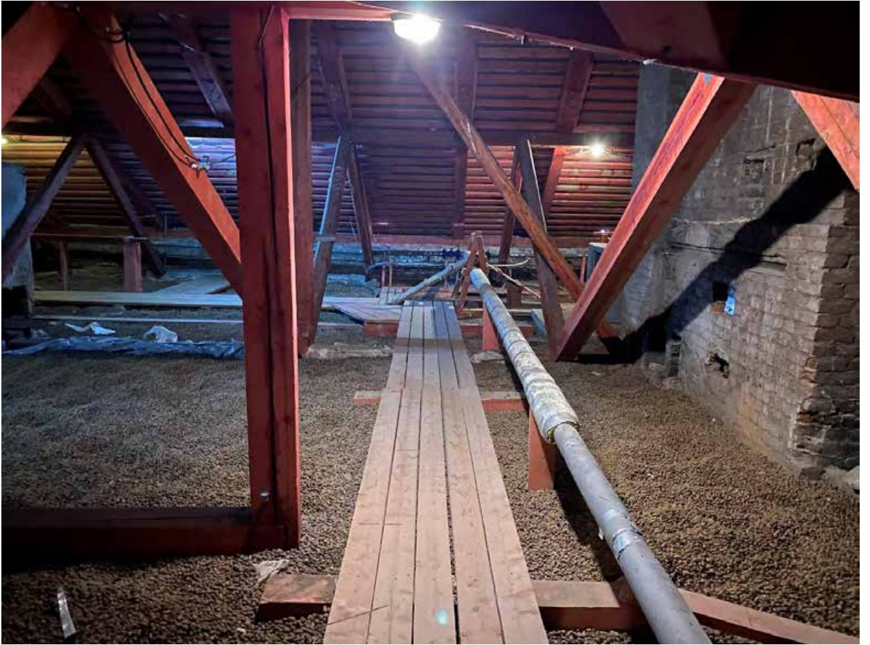
Фото № 387. Технический этаж. Чердак.
