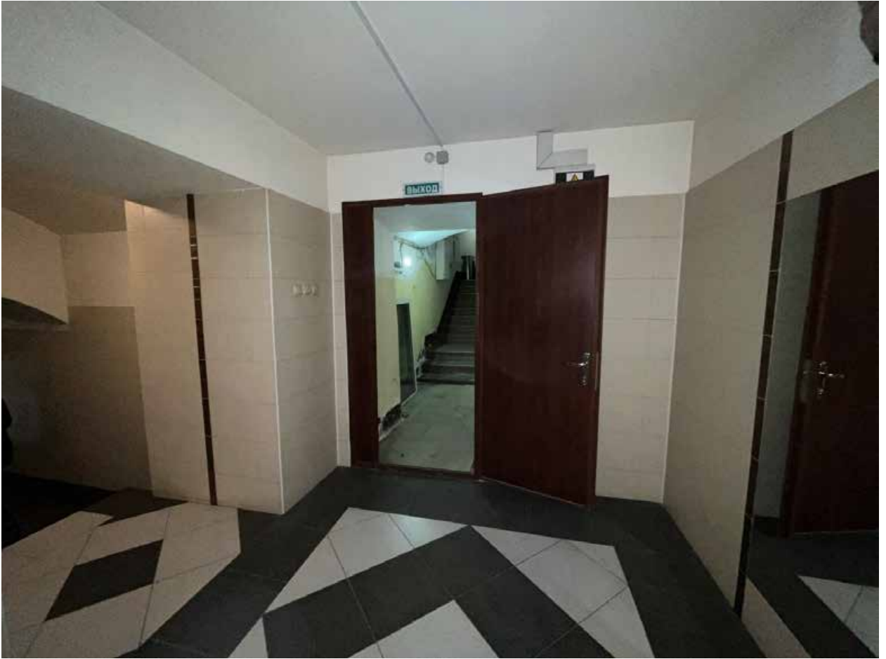
Фото № 82. Цокольный этаж, помещение 1-Н(98).
