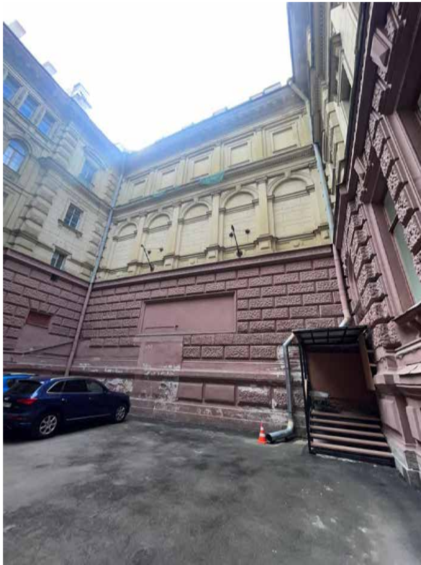
Фото № 14. Юго-западный дворовой фасад.
