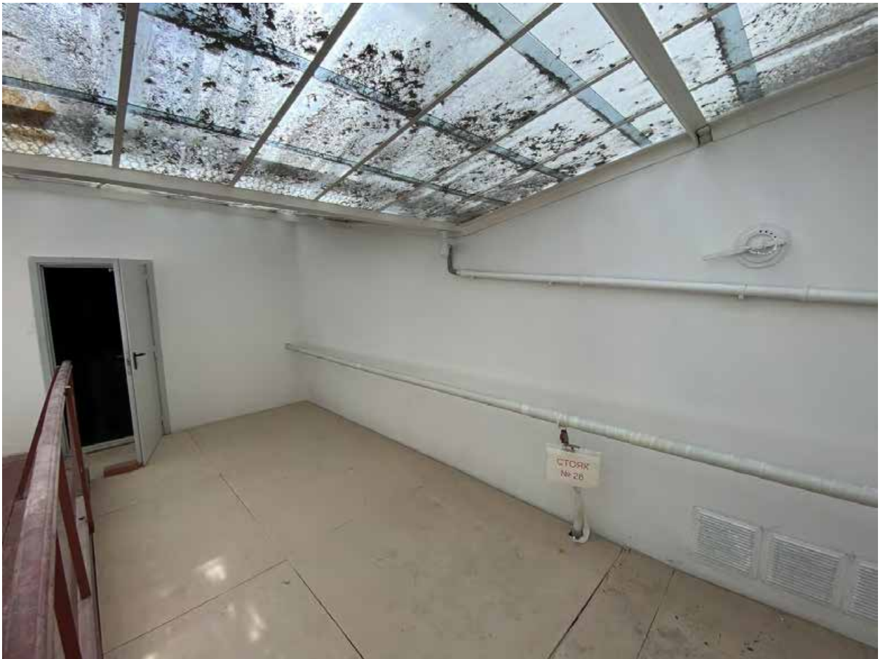
Фото № 395. Технический этаж. Чердак. Конструкции светового фонаря.
