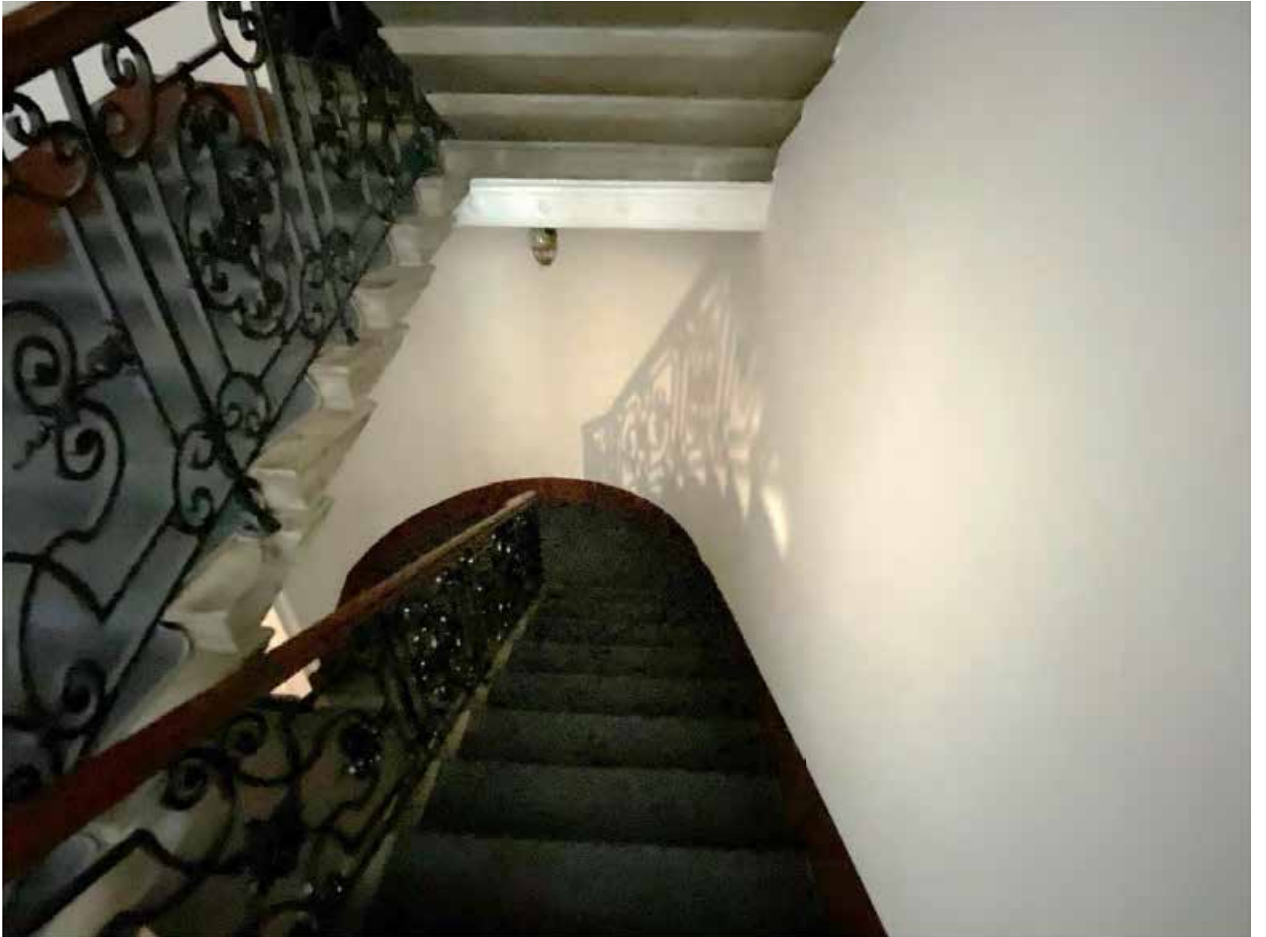
Фото № 54. Лестница в северной части здания между вторым и третьим этажами.
