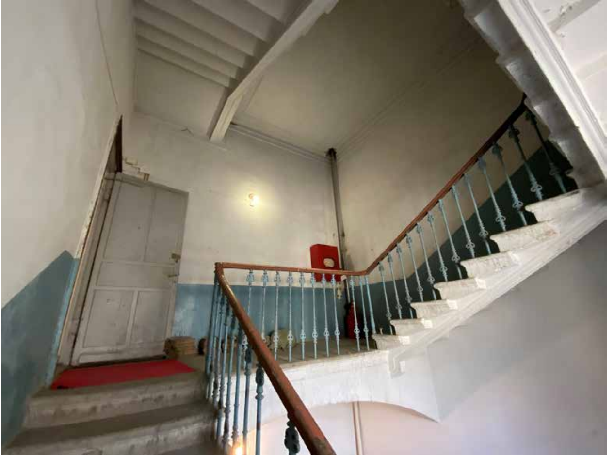
Фото № 67. Лестница 2ЛК в уровне четвертого этажа.
