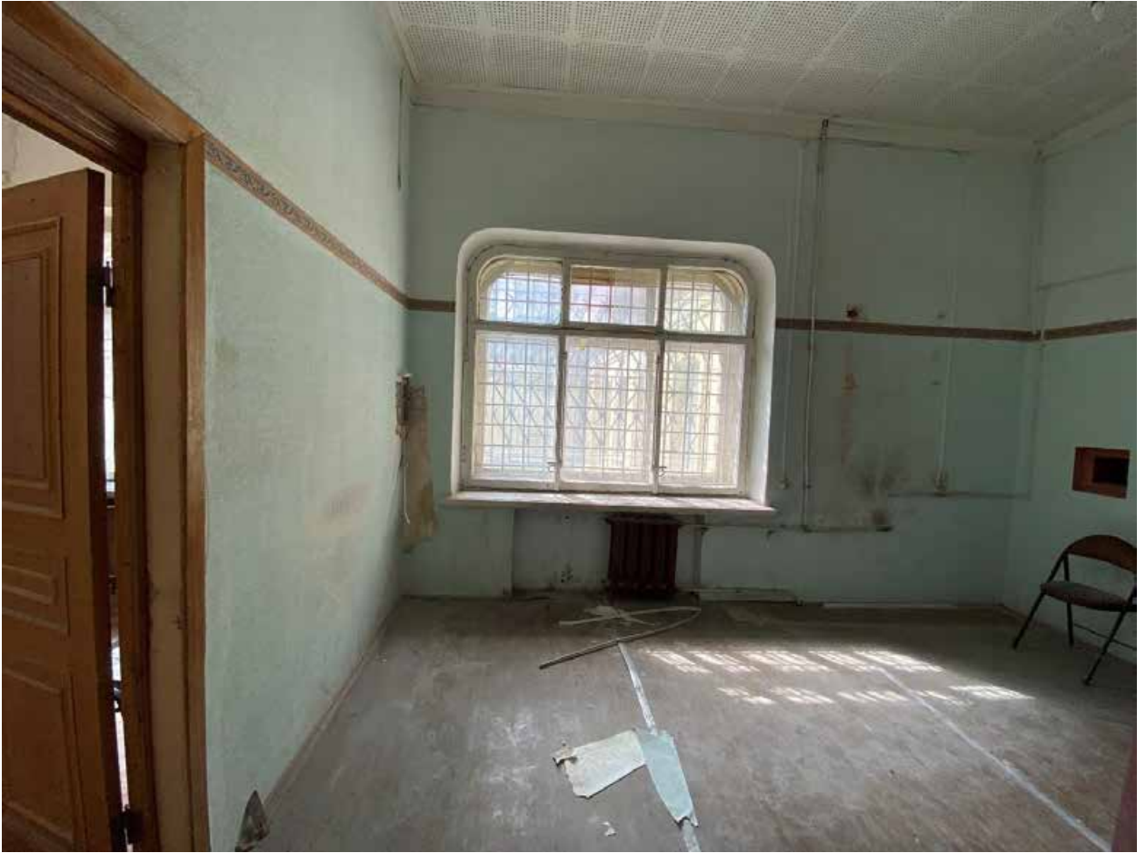
Фото № 335. 4 этаж, помещение 15-Н(9).
