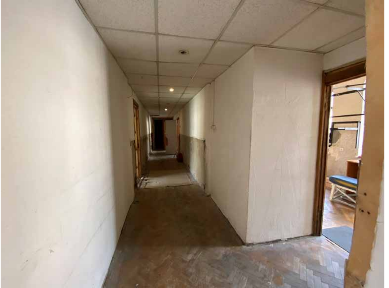
Фото № 333. 4 этаж, помещение 15-Н(7).
