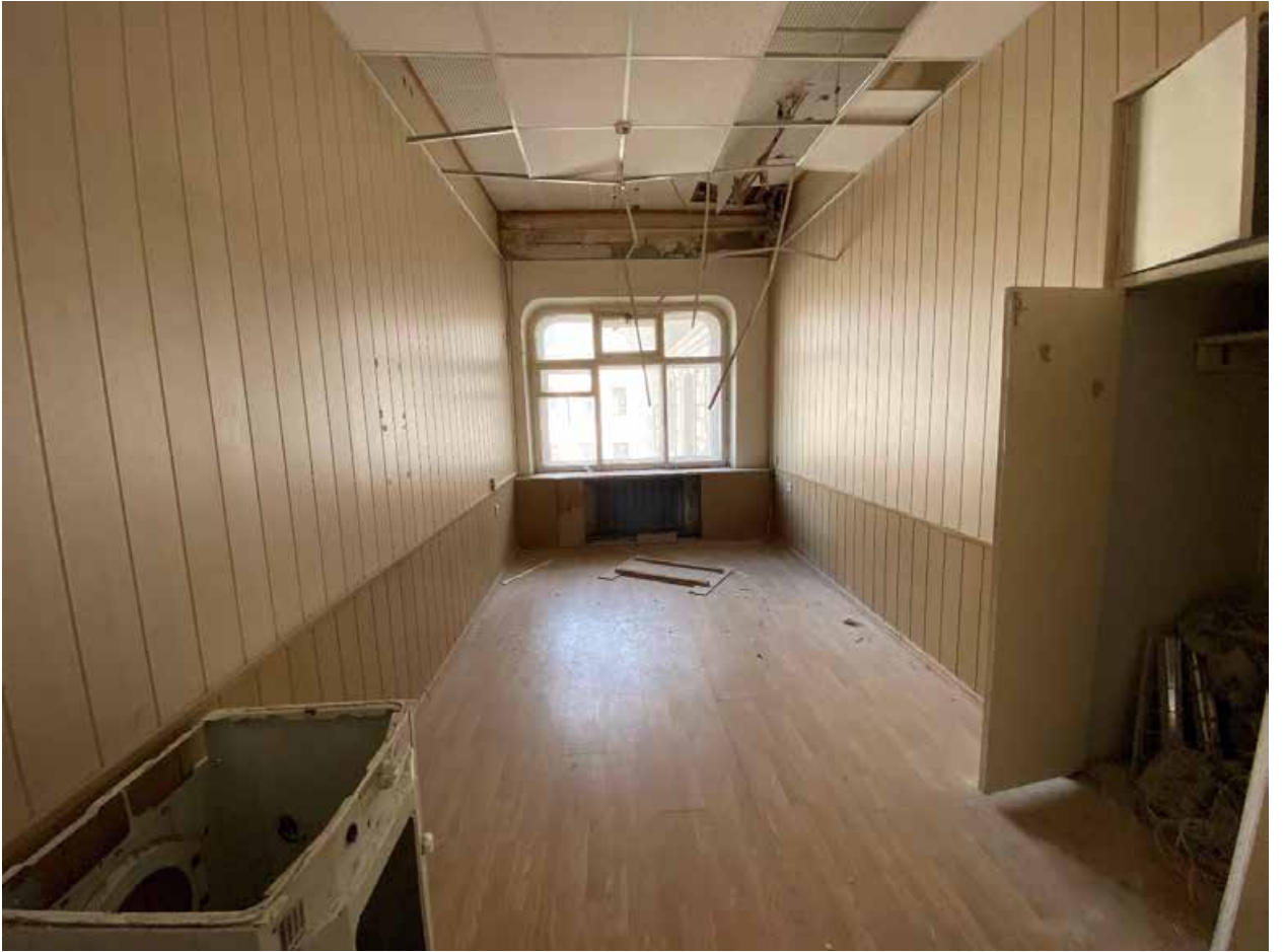
Фото № 328. 4 этаж, помещение 15-Н(24).
