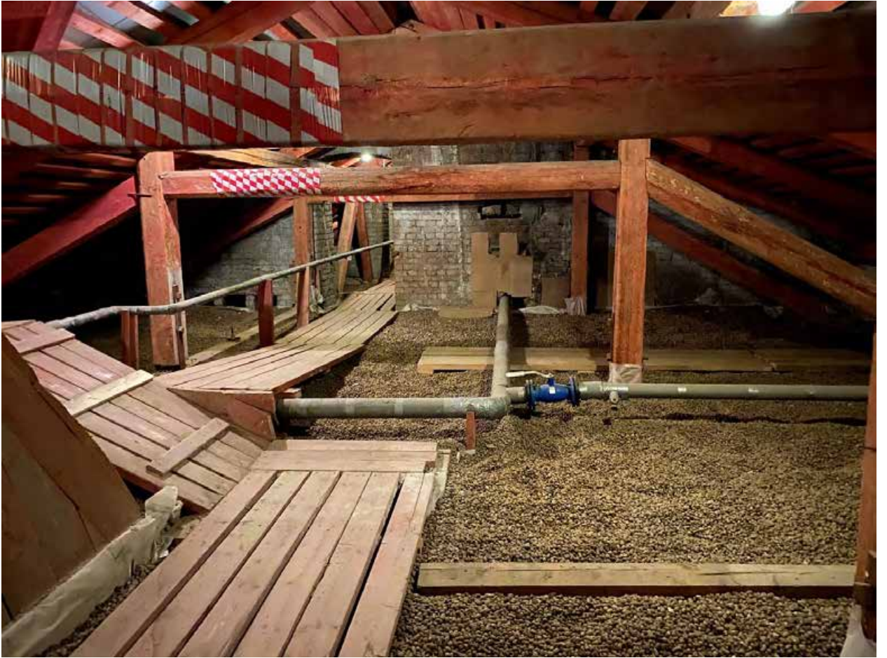
Фото № 374. Технический этаж. Чердак.
