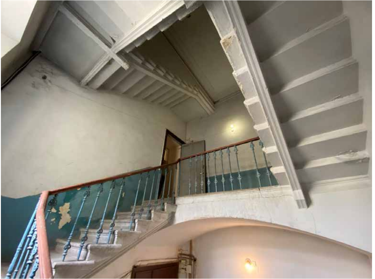
Фото № 66. Лестница 2ЛК между третьим и четвертым этажами.
