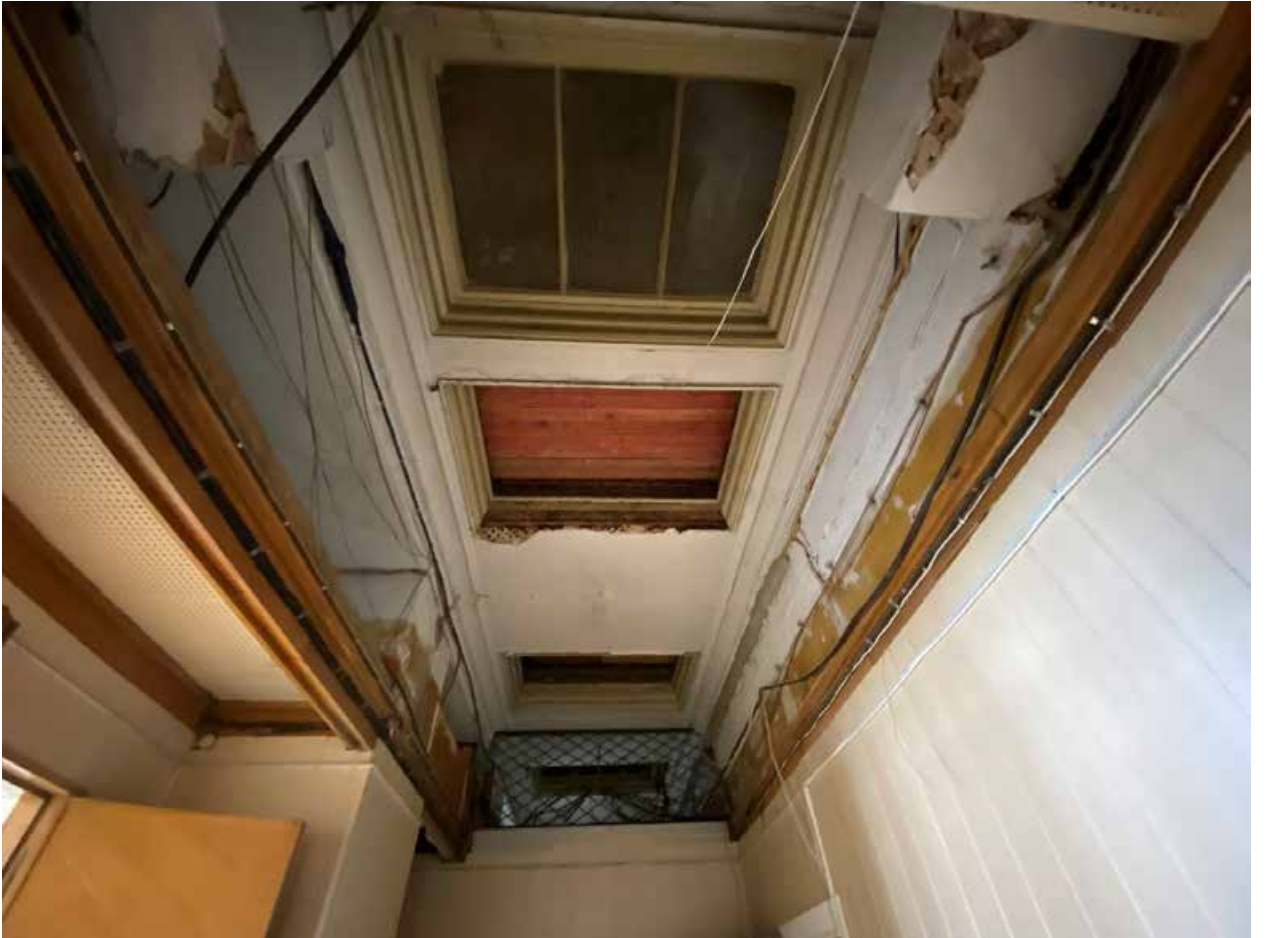
Фото № 311. 4 этаж, помещение 15-Н(18).
