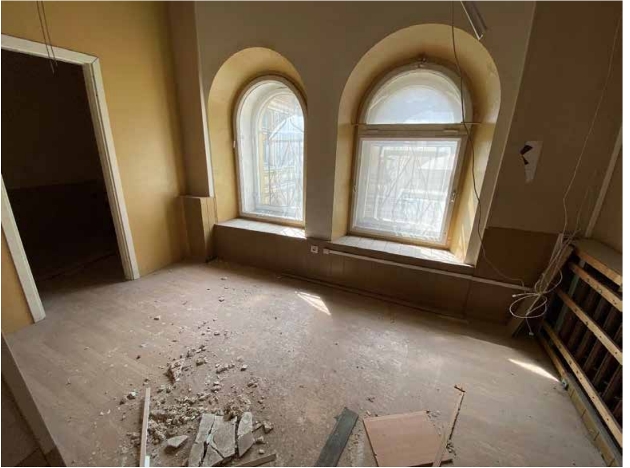
Фото № 330. 4 этаж, помещение 15-Н(20).
