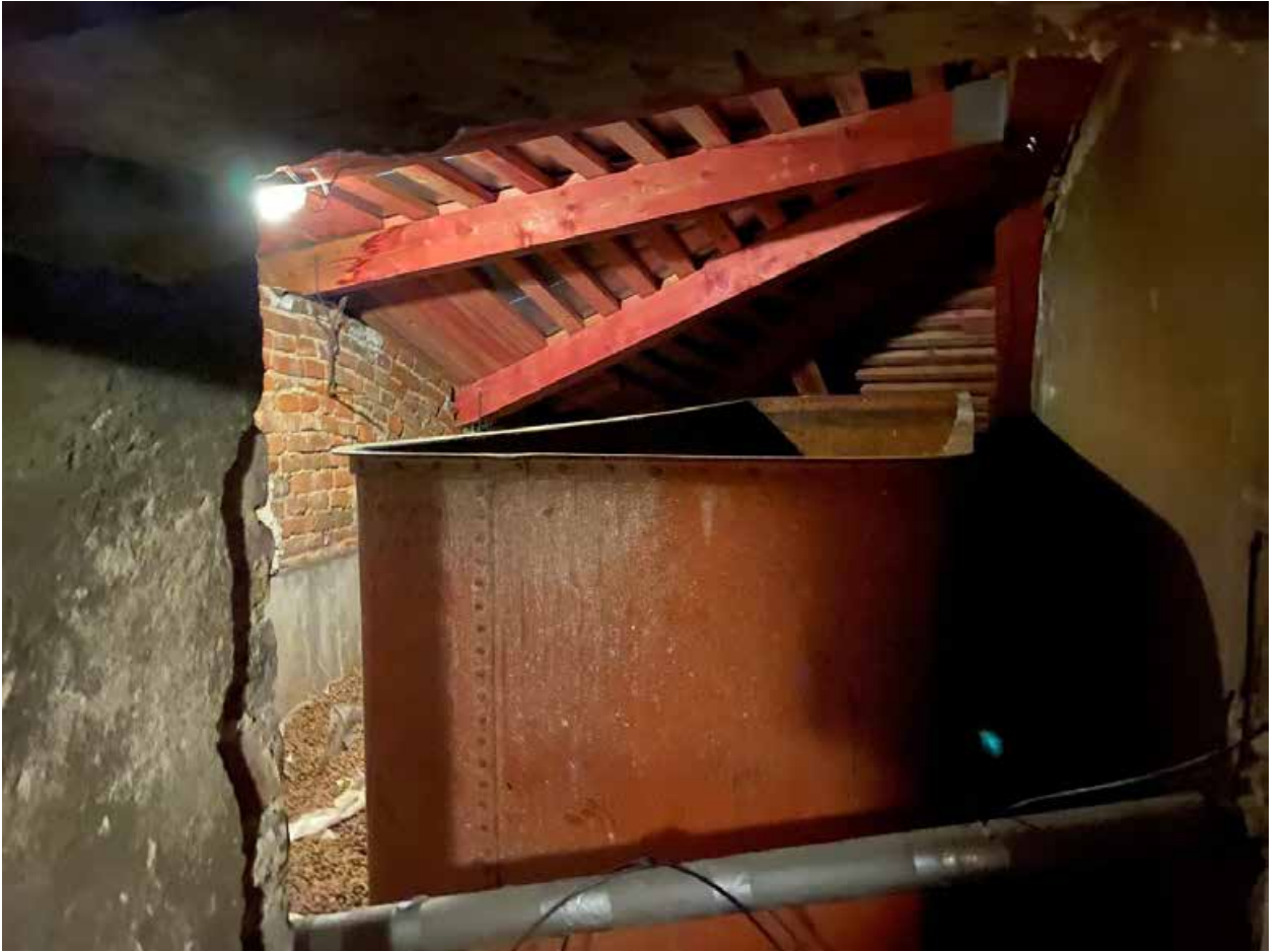
Фото № 378. Технический этаж. Чердак.
