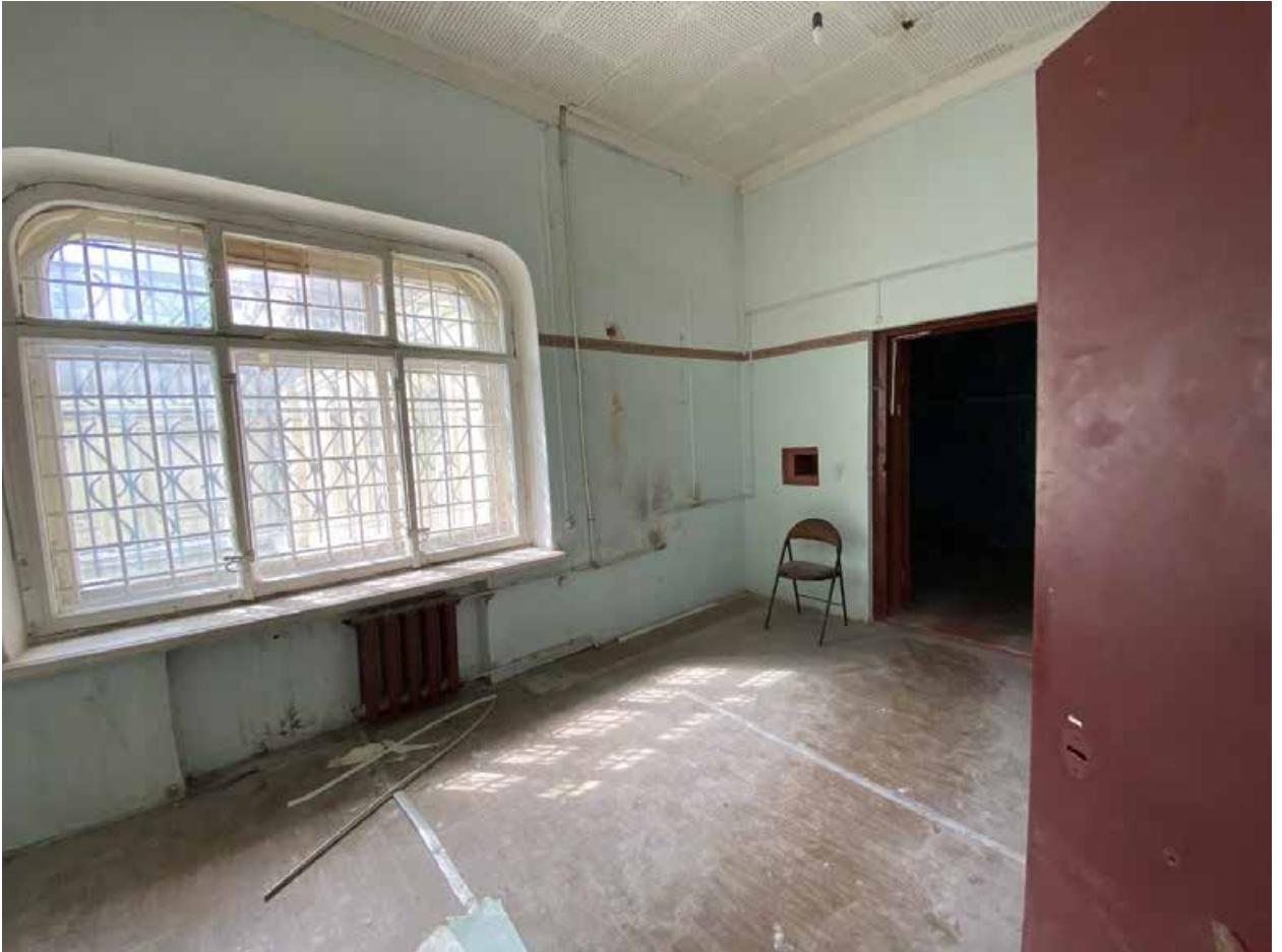
Фото № 336. 4 этаж, помещение 15-Н(9).
