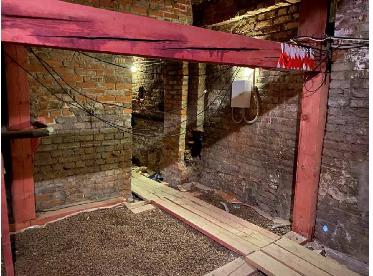
Фото № 383. Технический этаж. Чердак.
