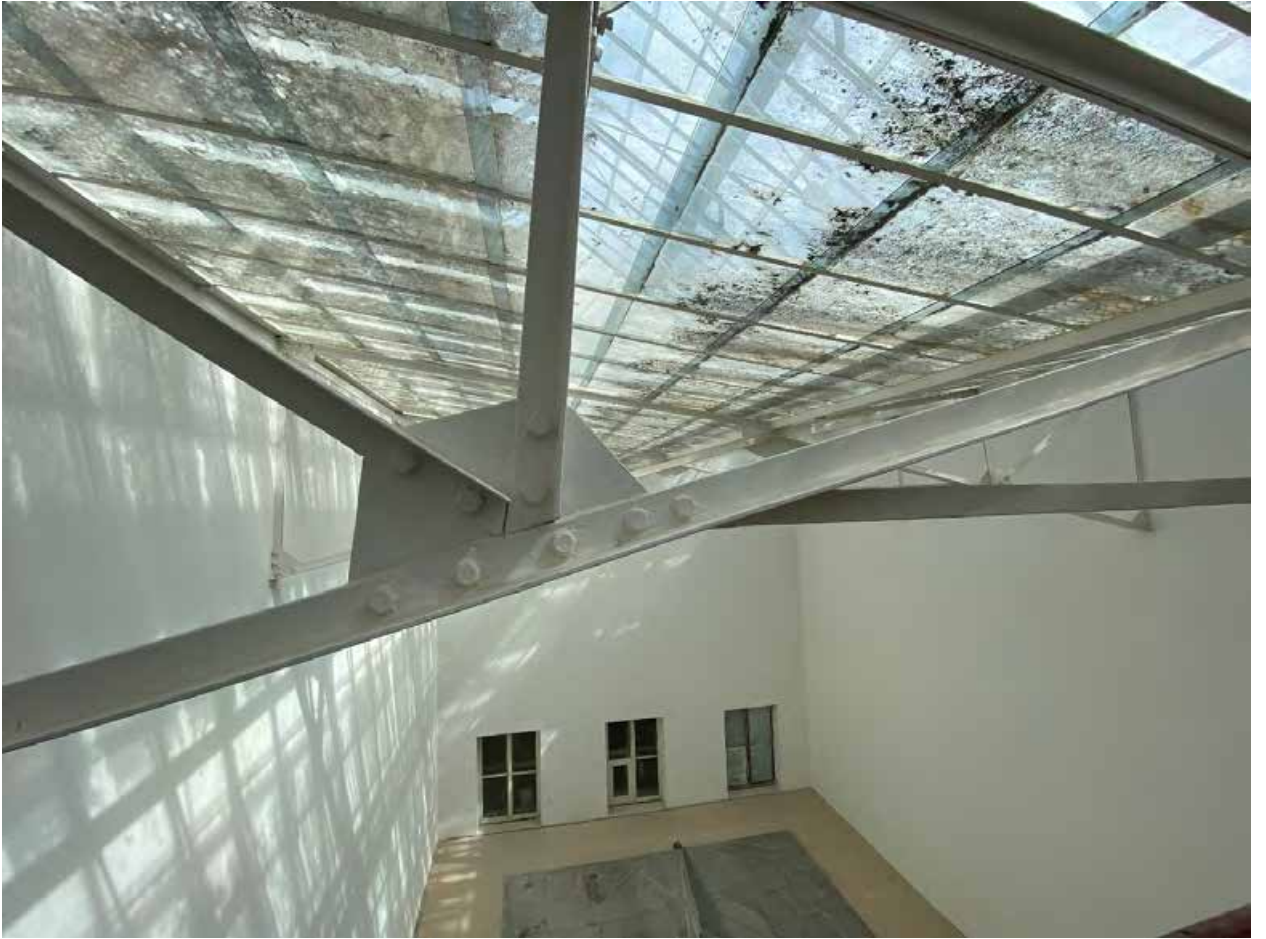
Фото № 392. Технический этаж. Чердак. Конструкции светового фонаря.
