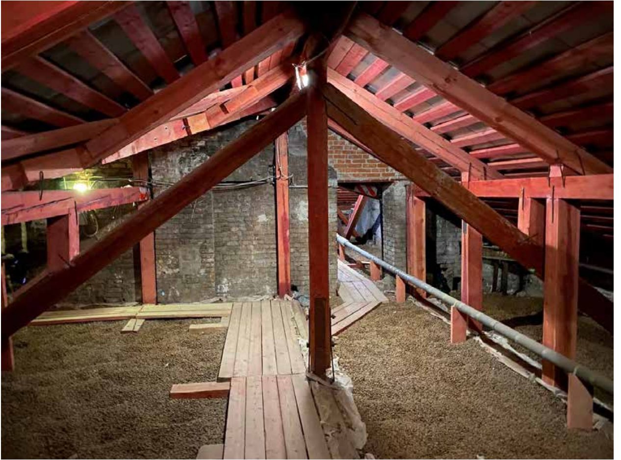
Фото № 382. Технический этаж. Чердак.
