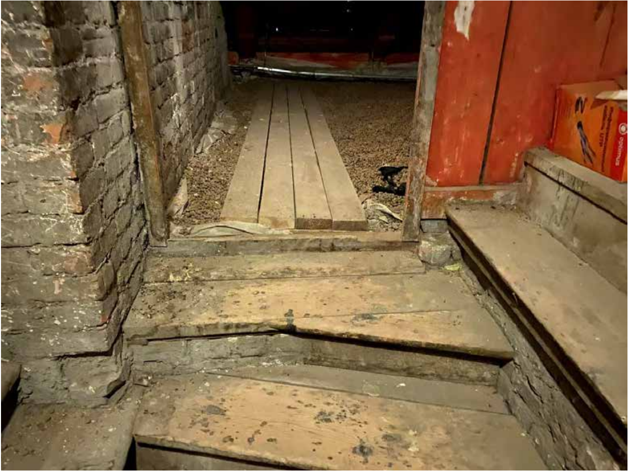
Фото № 369. Технический этаж. Чердак.
