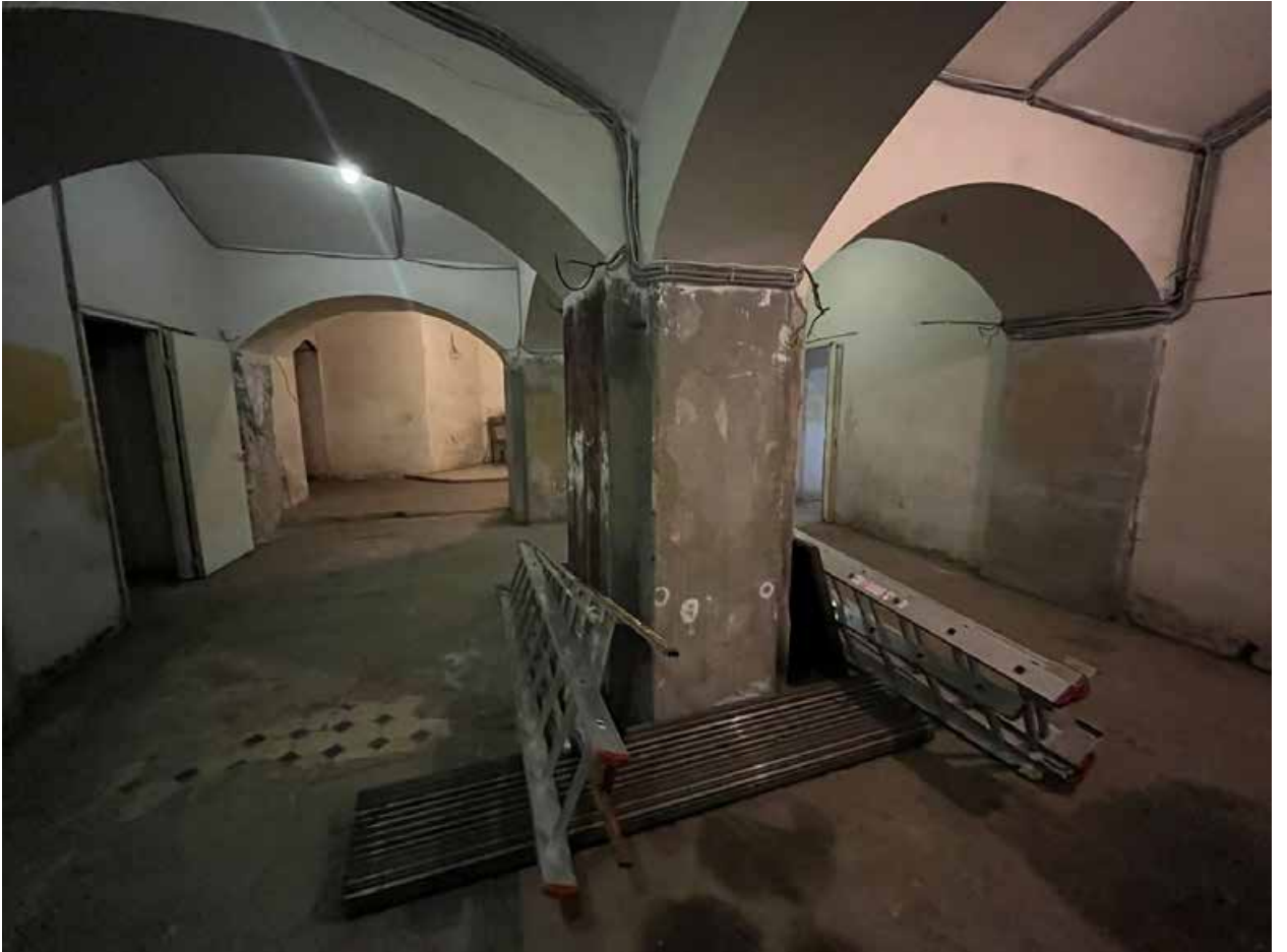
Фото № 84. Цокольный этаж, помещение 1-Н(93).
