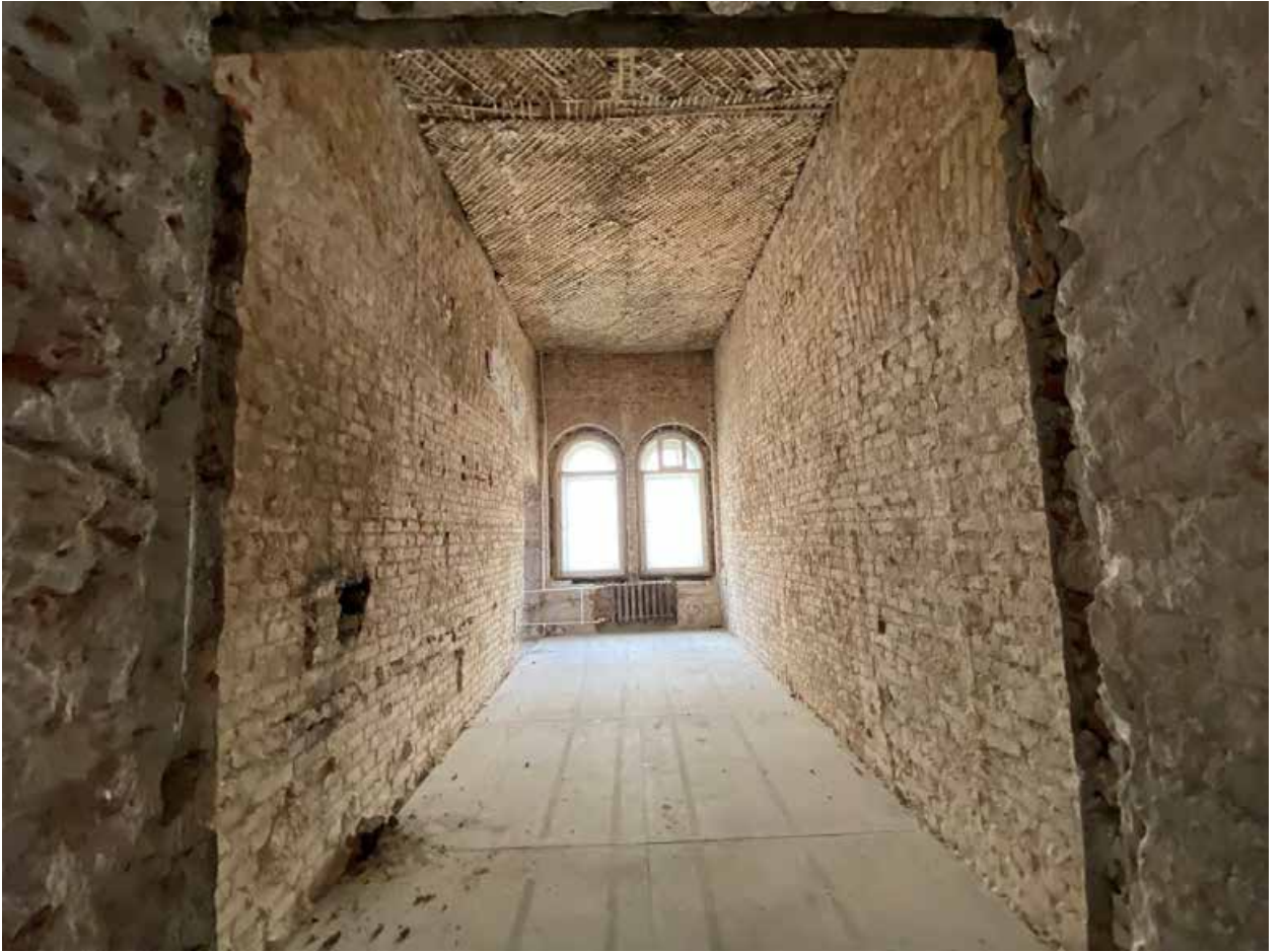
Фото № 363. 4 этаж, помещение 14-Н(25).
