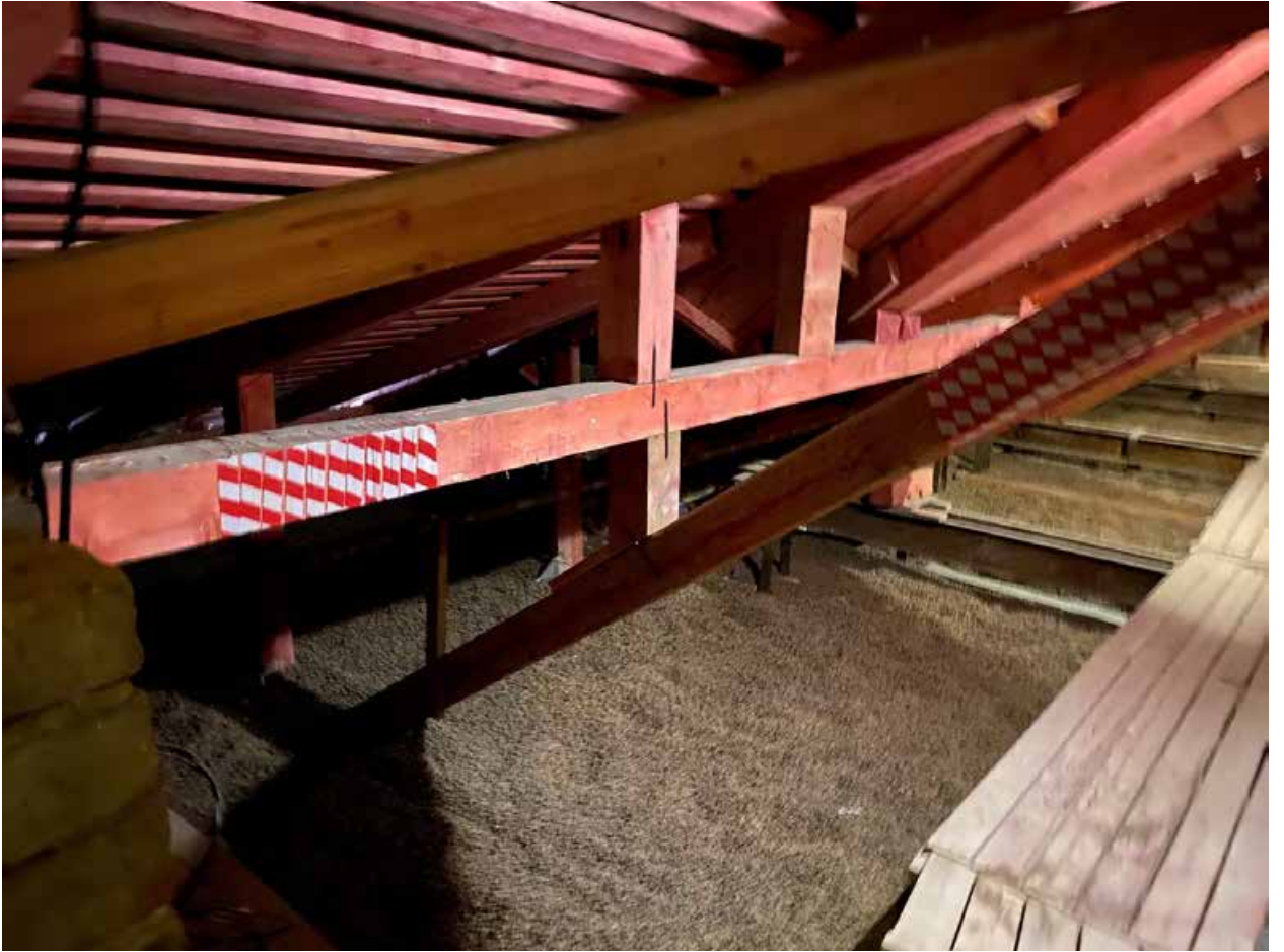
Фото № 379. Технический этаж. Чердак.
