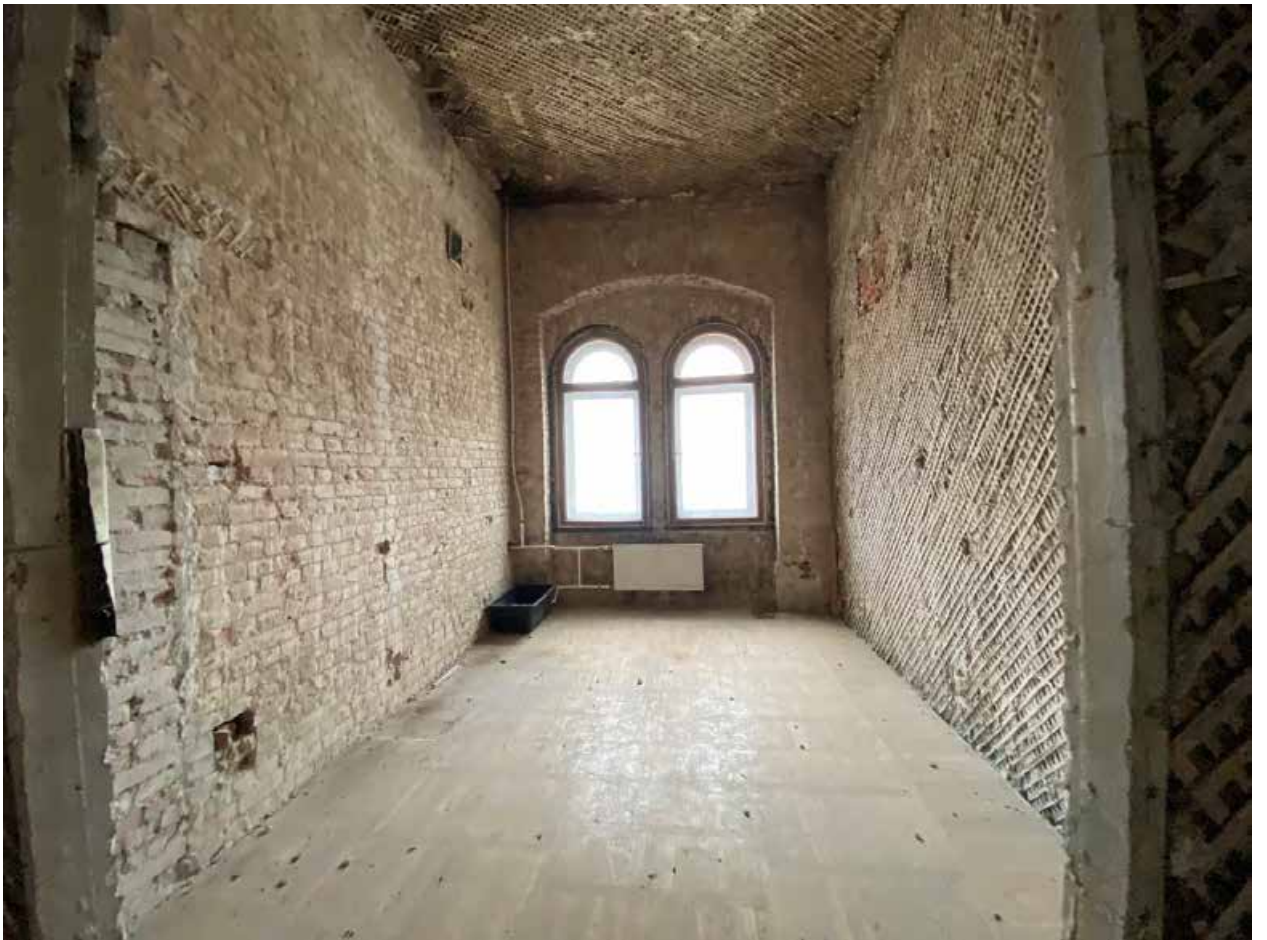
Фото № 359. 4 этаж, помещение 14-Н(21).
