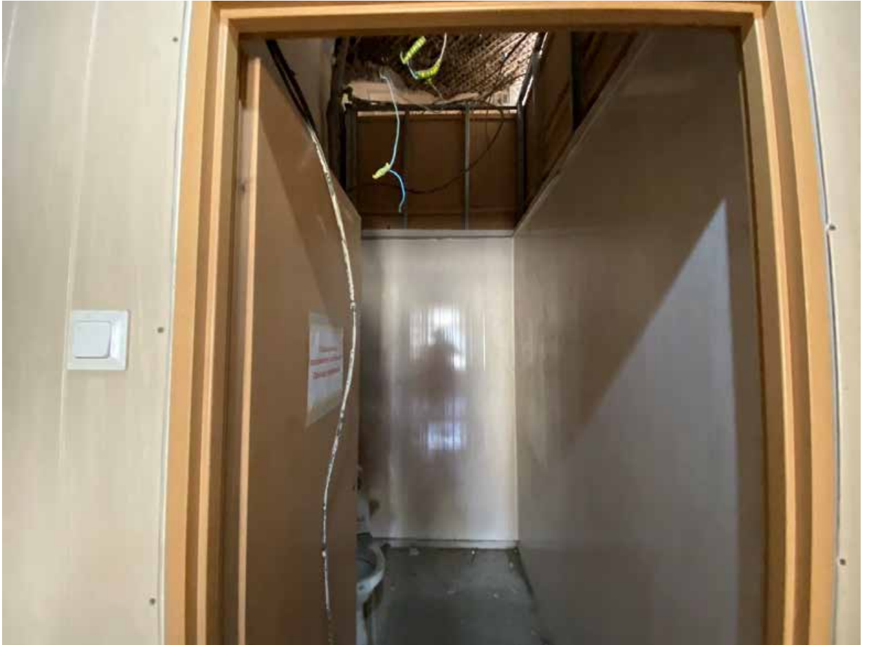
Фото № 318. 4 этаж, помещение 15-Н(11,16).
