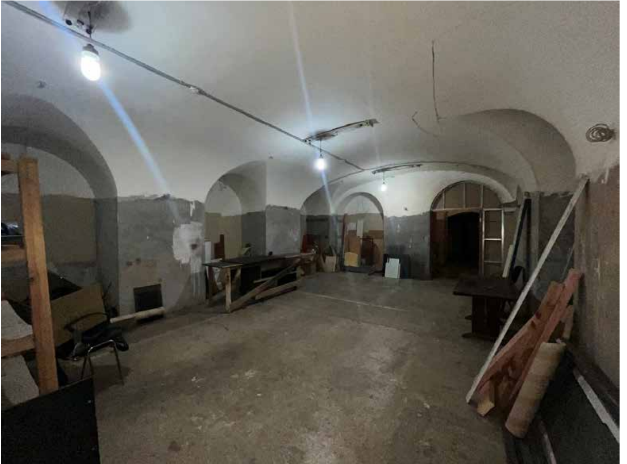
Фото № 90. Цокольный этаж, помещение 1-Н(101).
