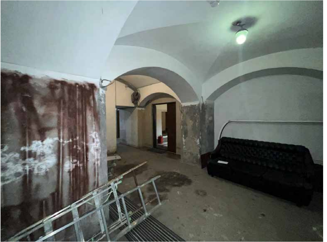
Фото № 86. Цокольный этаж, помещение 1-Н(93).
