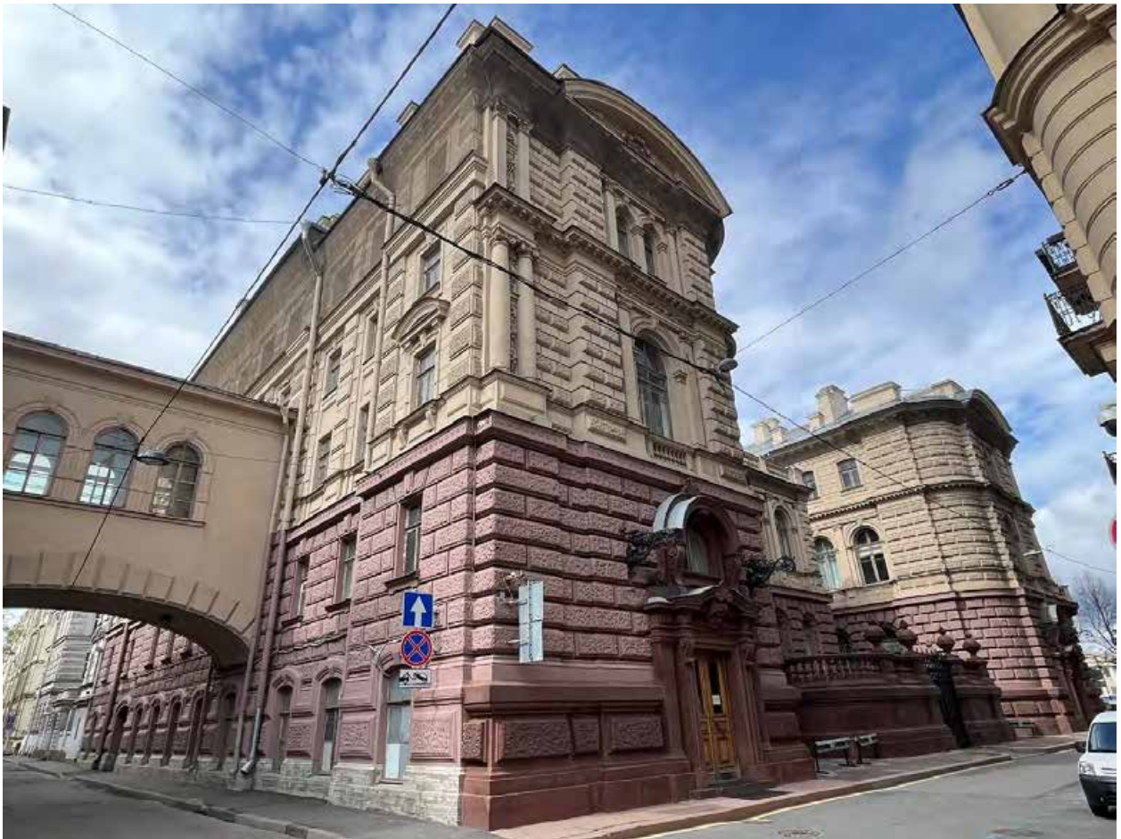
Фото № 8. Угол северо-восточного и юго-восточного лицевых фасадов.
