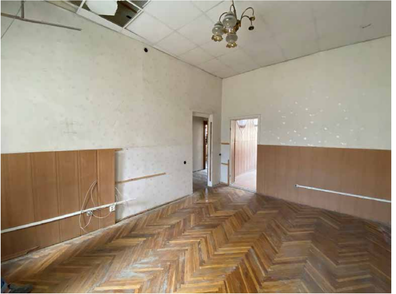
Фото № 331. 4 этаж, помещение 15-Н(21).
