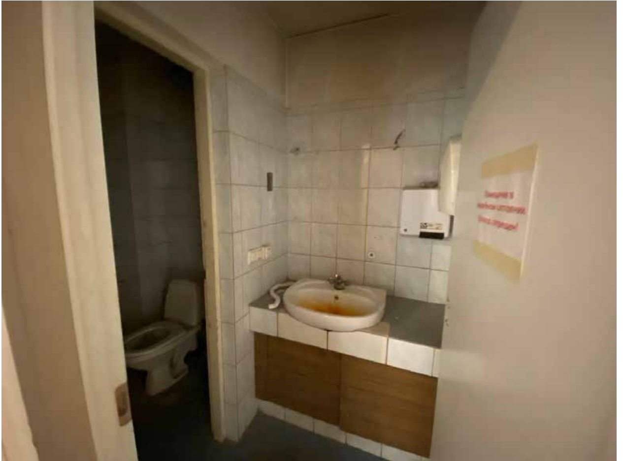
Фото № 303. 4 этаж, помещение 15-Н(2,3).
