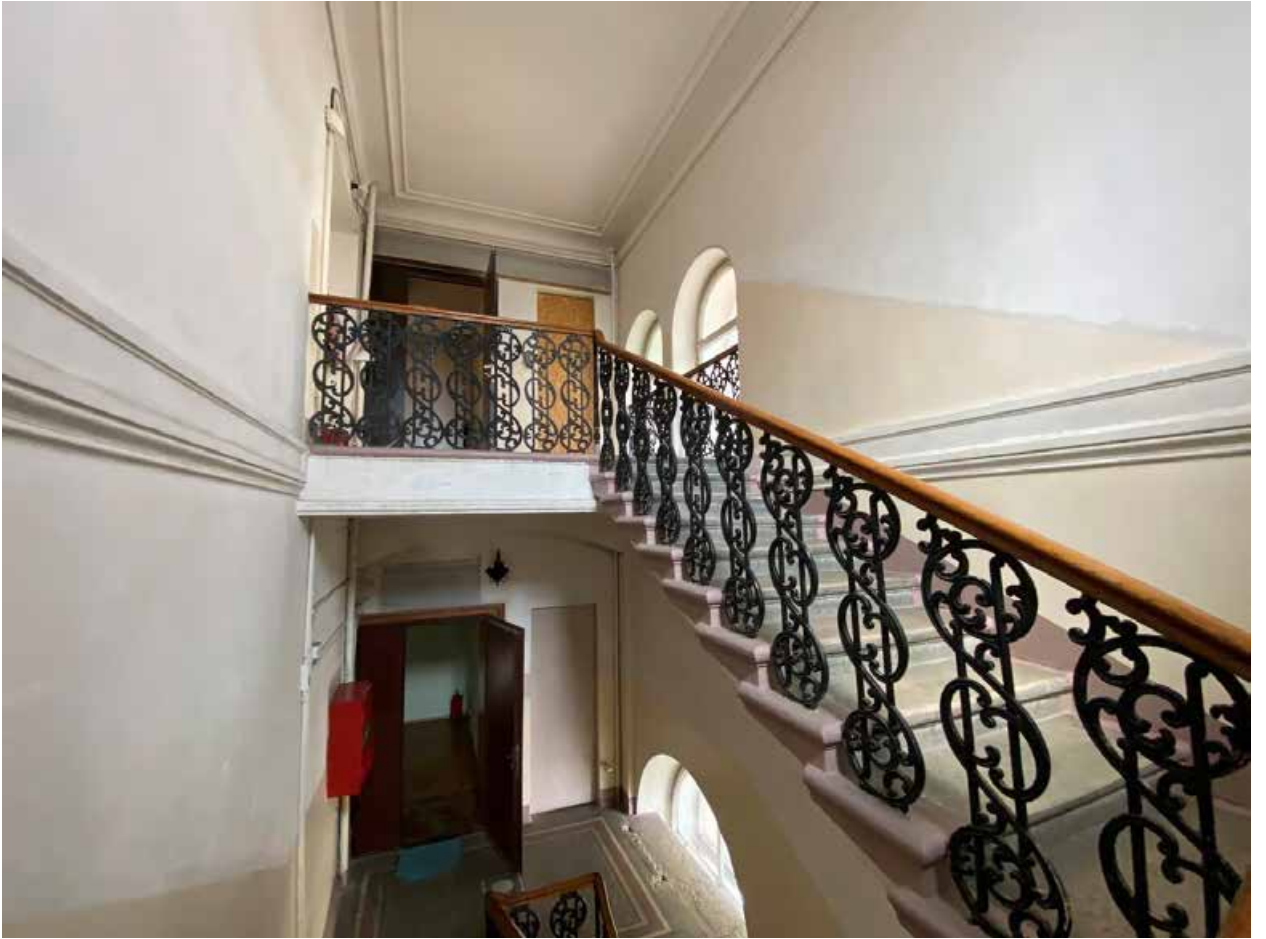
Фото № 35. Лестница 1ЛК между третьим и четвертым этажами.
