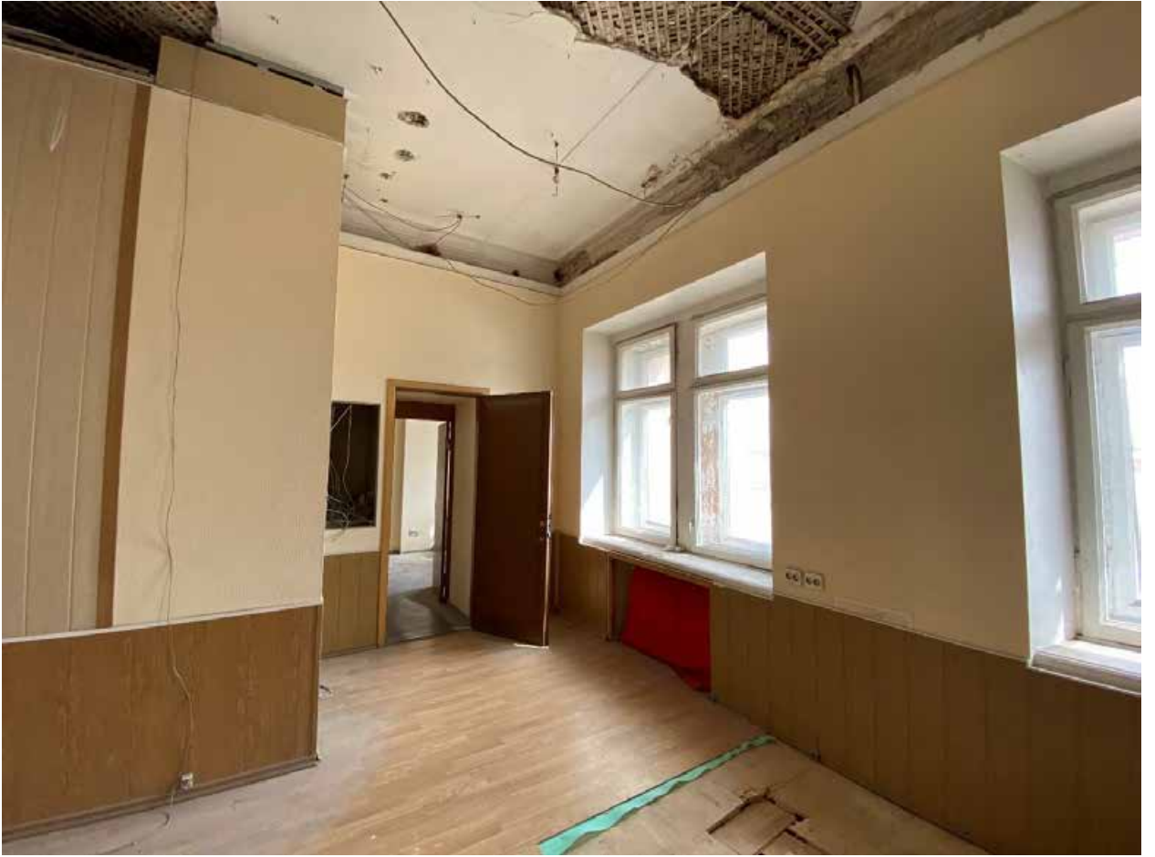
Фото № 323. 4 этаж, помещение 15-Н(8).
