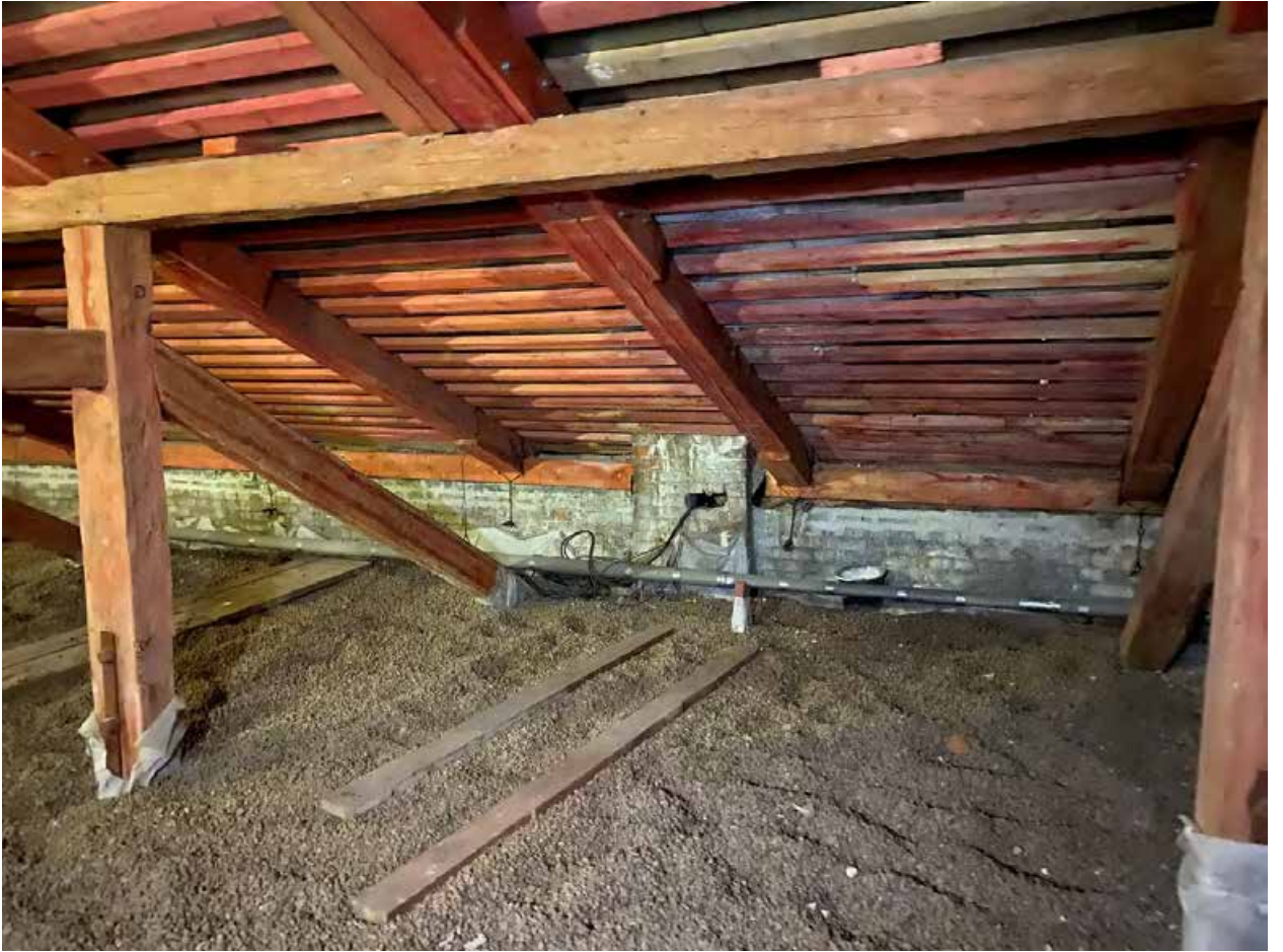
Фото № 373. Технический этаж. Чердак.
