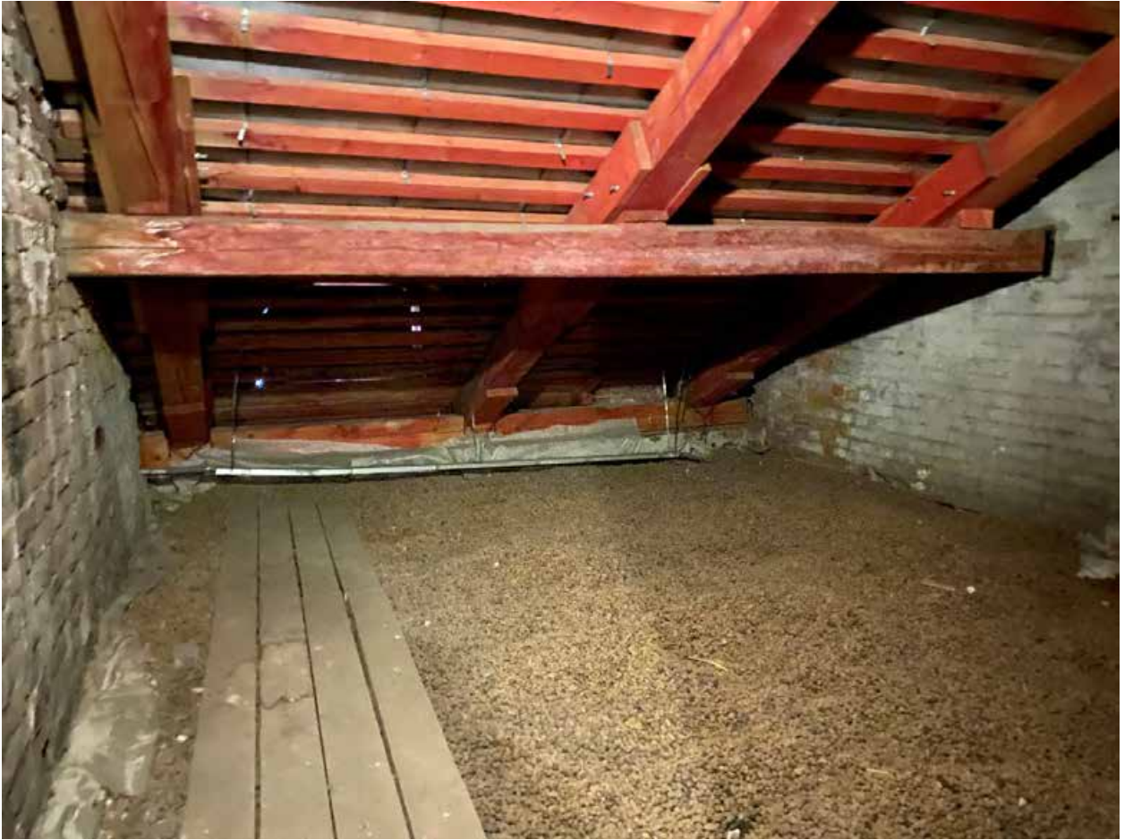
Фото № 370. Технический этаж. Чердак.
