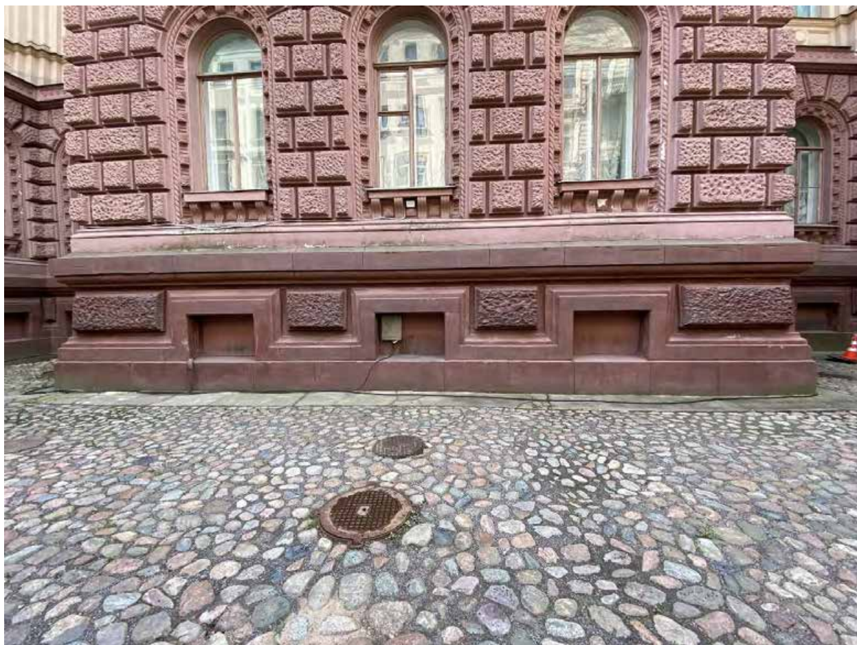
Фото № 17. Северо-восточный лицевой фасад.
