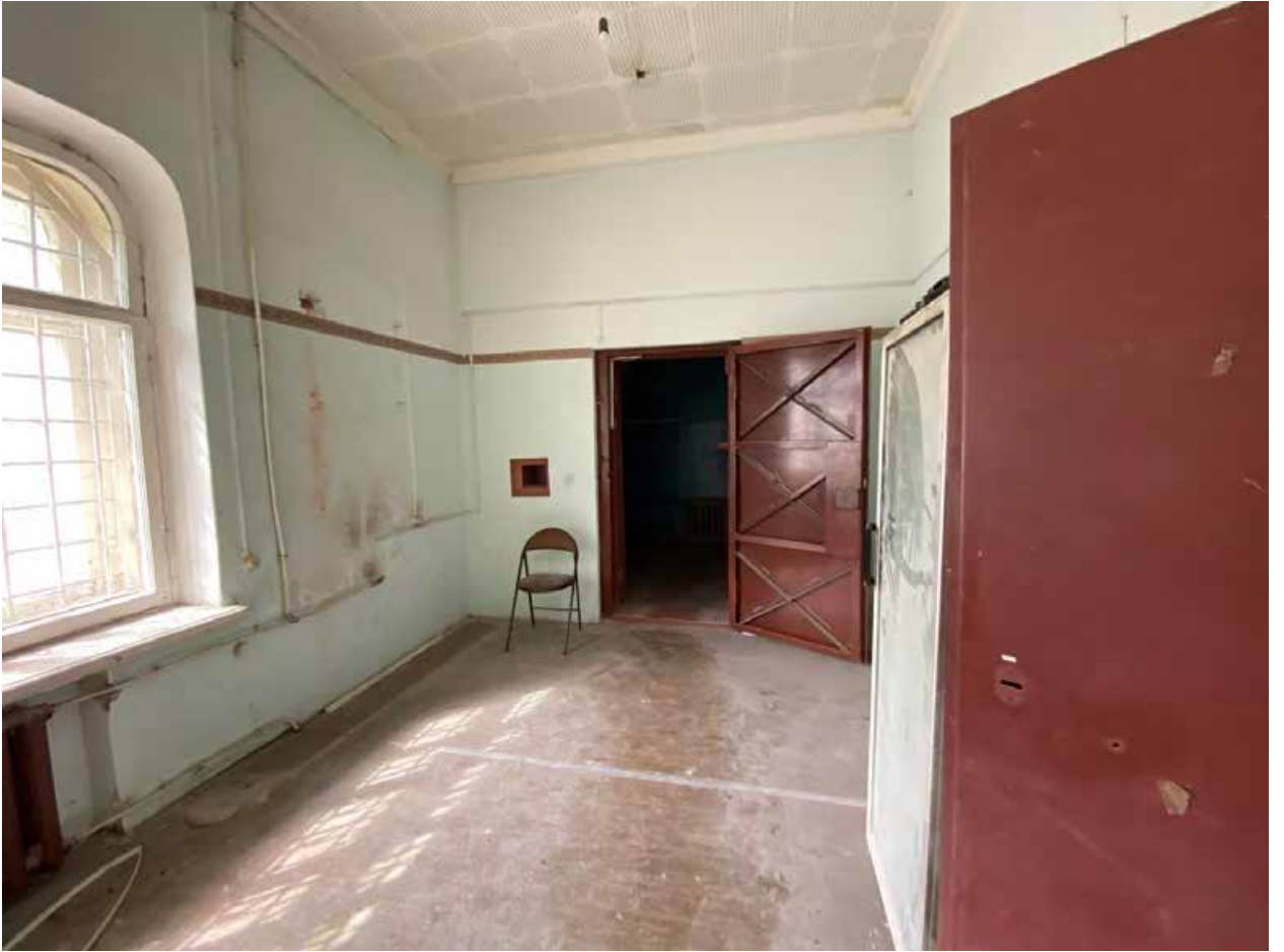
Фото № 337. 4 этаж, помещение 15-Н(9).
