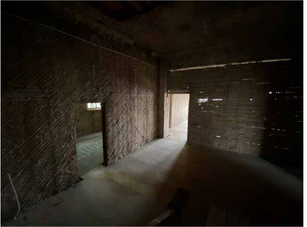
Фото № 353. 4 этаж, помещение 14-Н(2).
