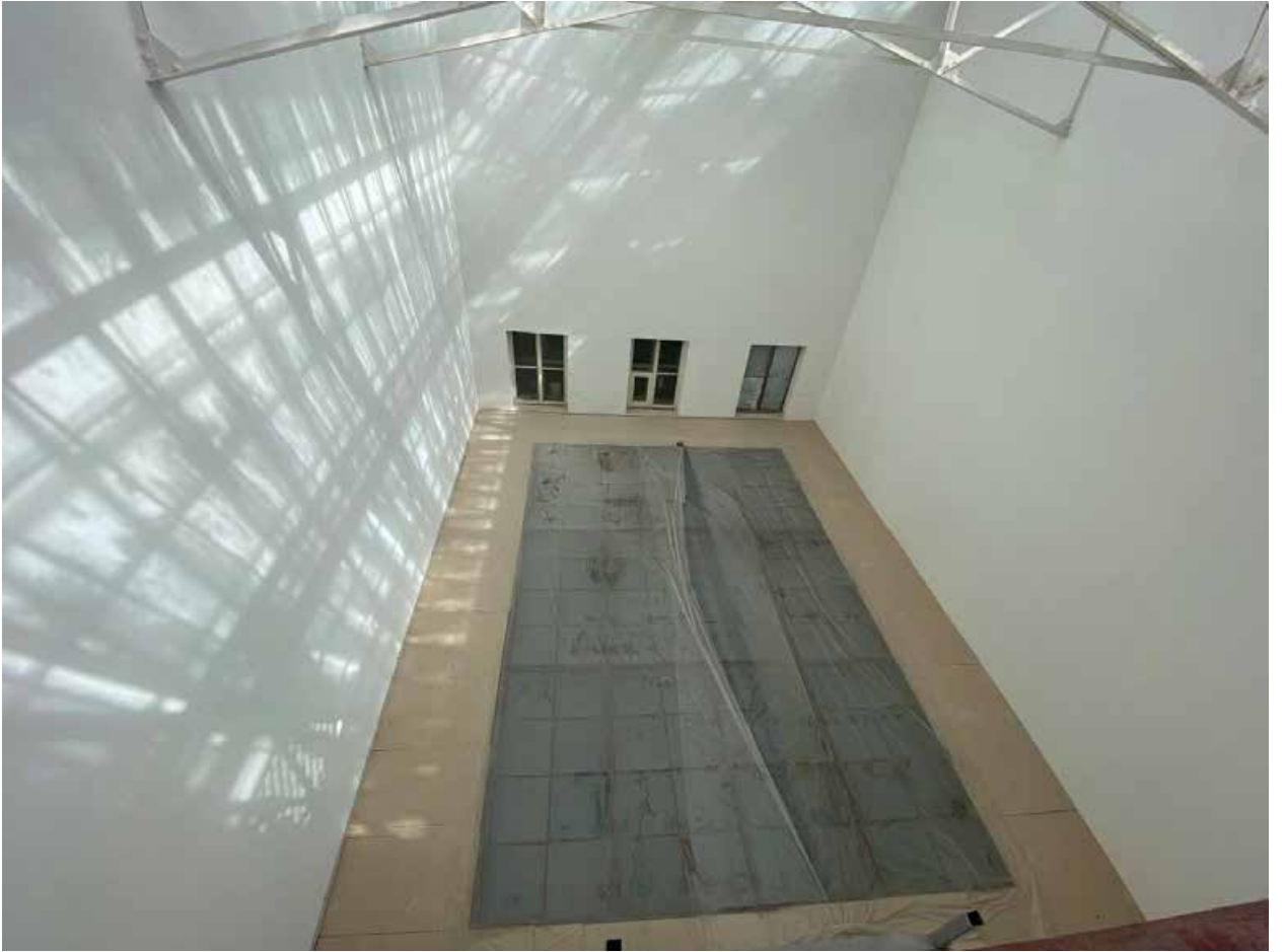
Фото № 393. Технический этаж. Чердак. Конструкции светового фонаря.
