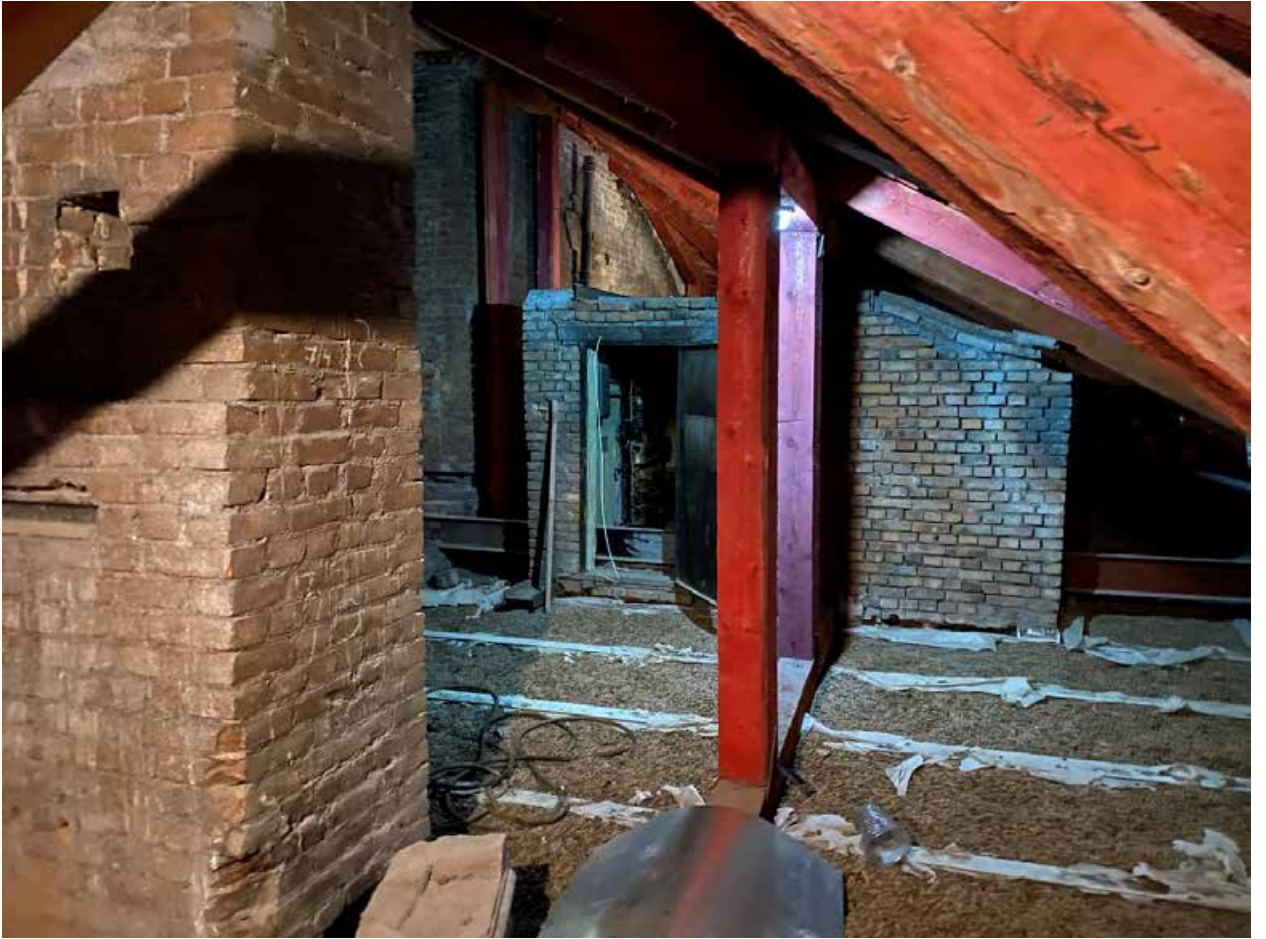
Фото № 388. Технический этаж. Чердак.
