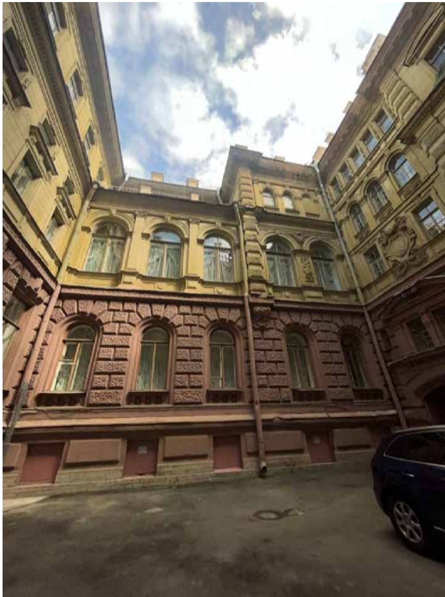
Фото № 15. Северо-восточный дворовый фасад.
