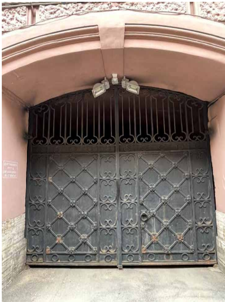
Фото № 11. Юго-западный лицевой фасад, заполнение воротного проема.
