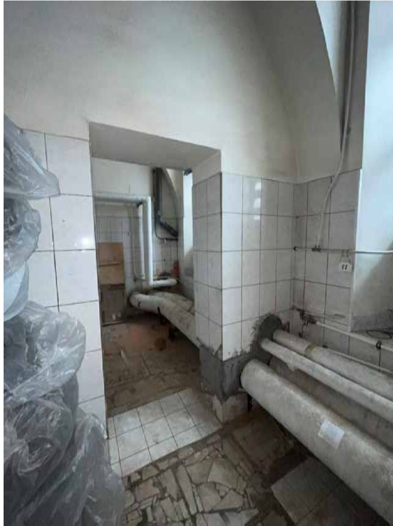
Фото № 107. Цокольный этаж, помещение 1-Н(112-114).
