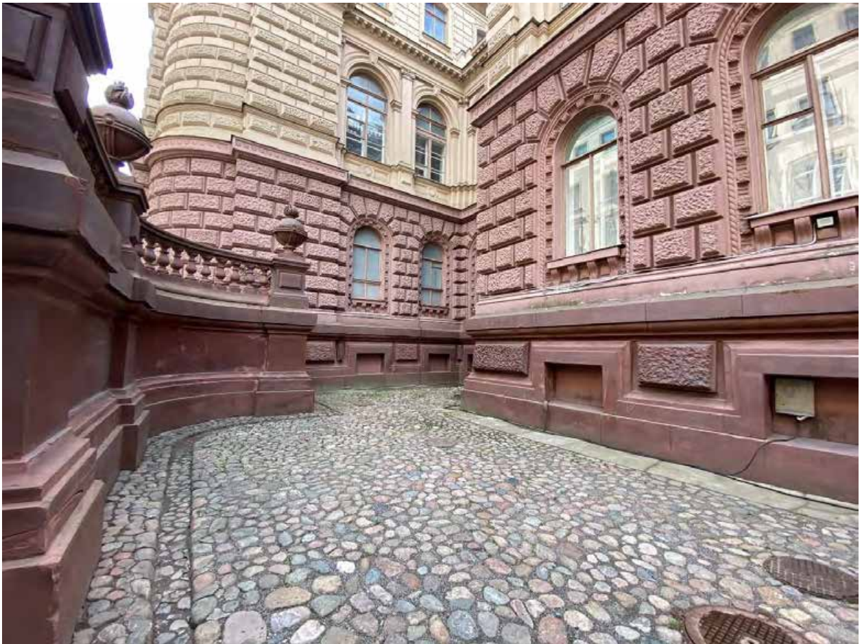
Фото № 16. Северо-восточный лицевой фасад.
