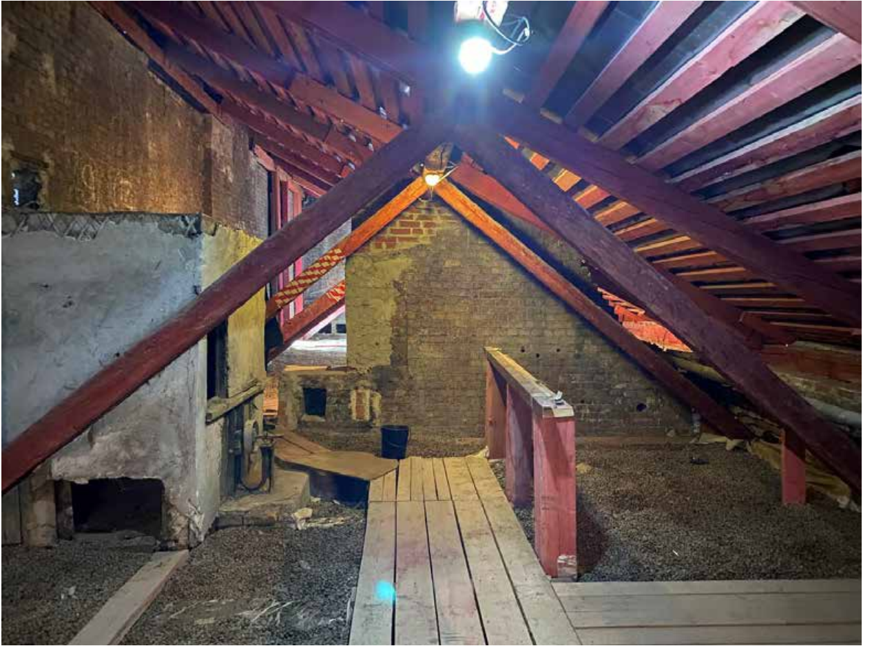
Фото № 390. Технический этаж. Чердак.
