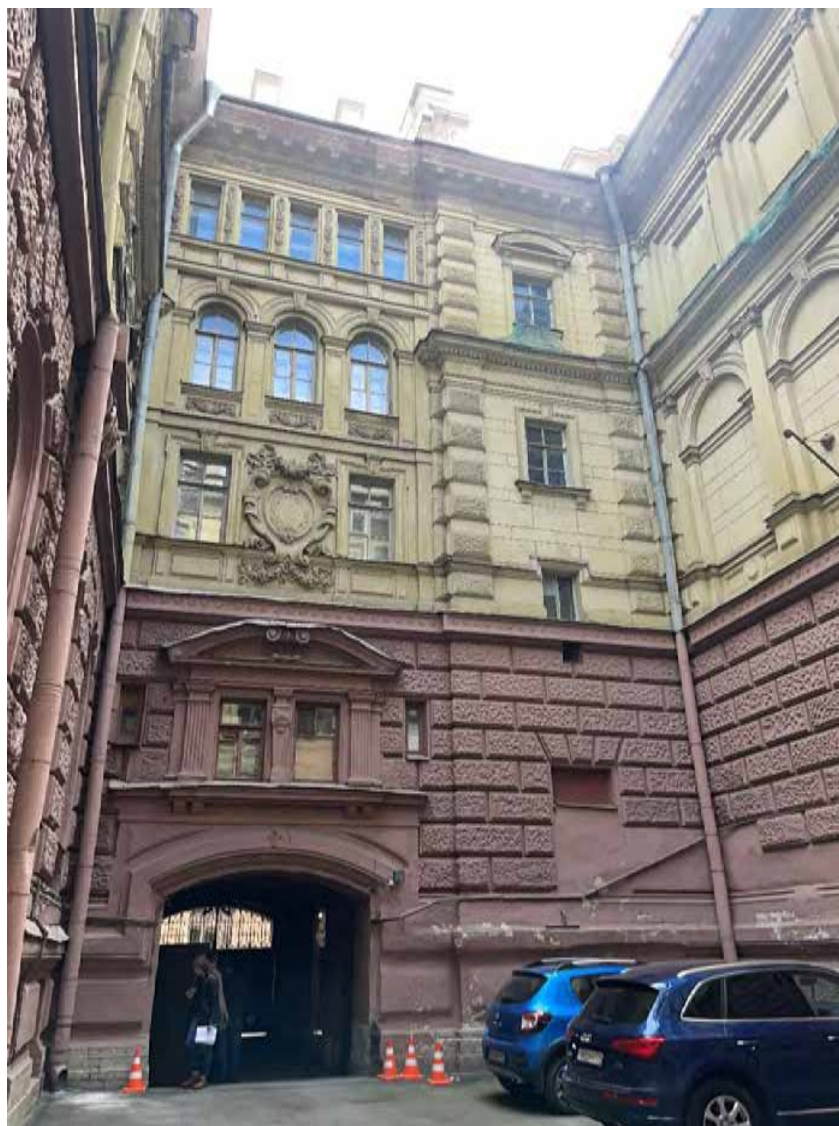
Фото № 13. Северо-западный дворовый фасад.
