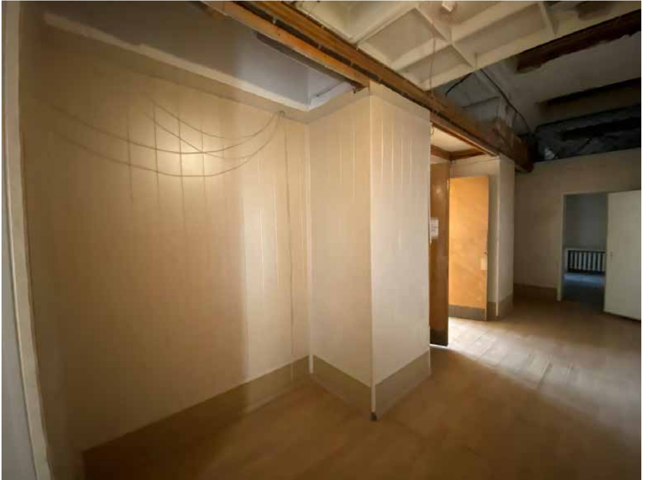
Фото № 310. 4 этаж, помещение 15-Н(18).
