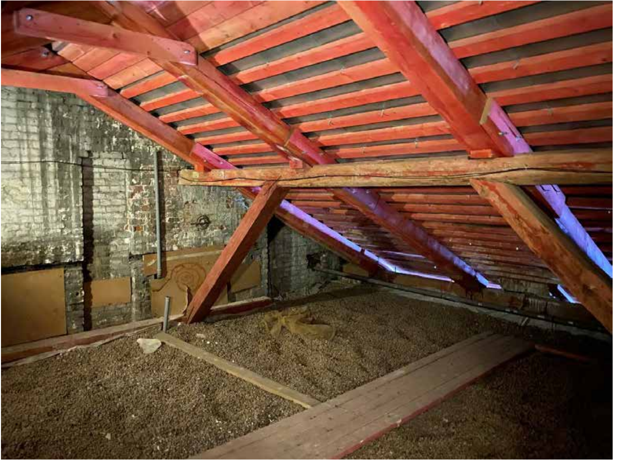
Фото № 371. Технический этаж. Чердак.
