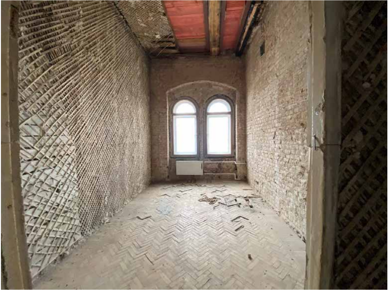
Фото № 360. 4 этаж, помещение 14-Н(18).
