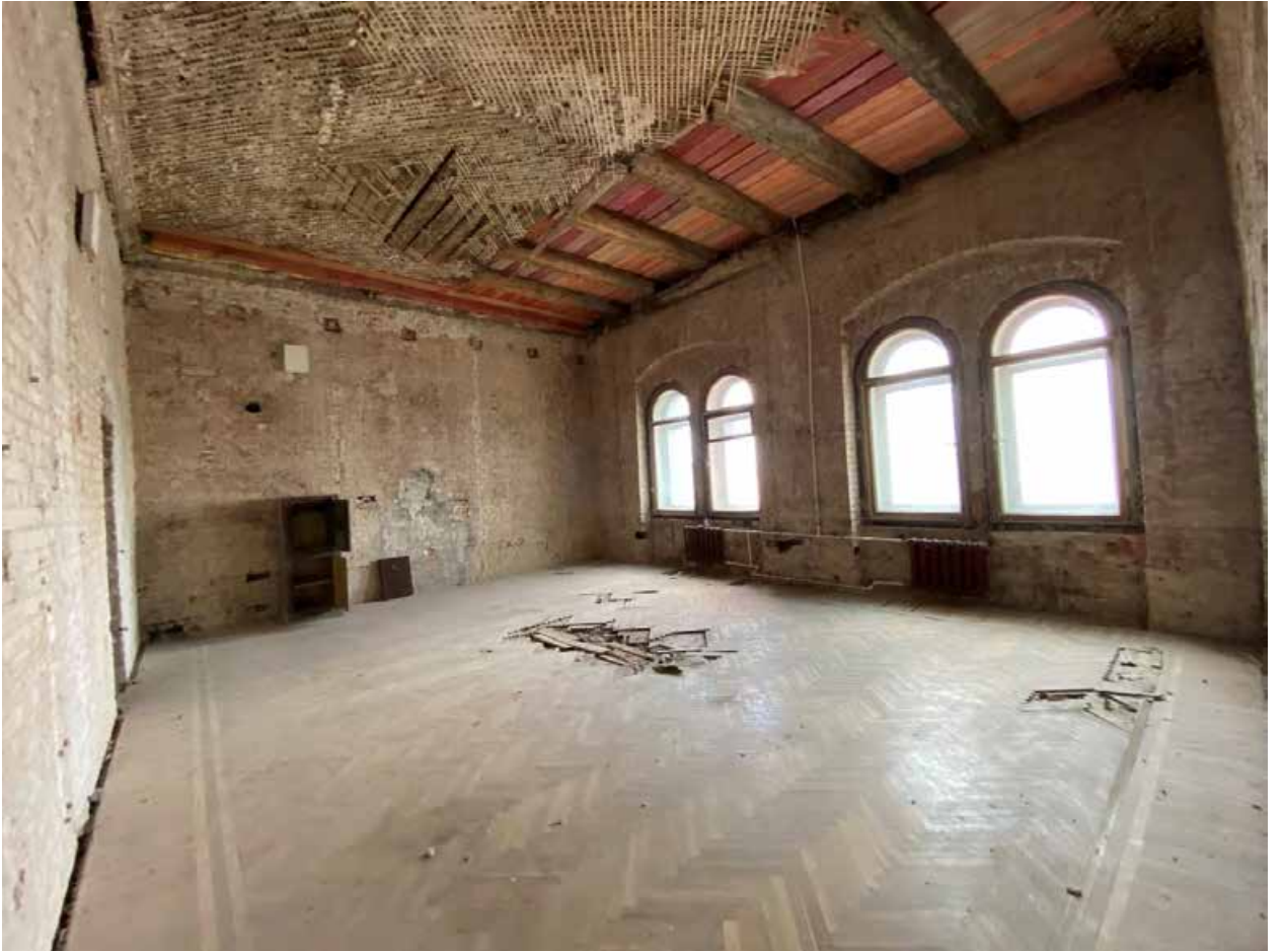
Фото № 361. 4 этаж, помещение 14-Н(17).
