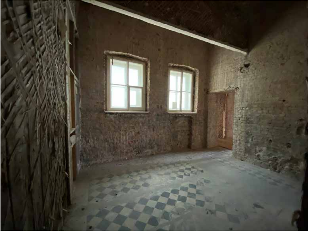
Фото № 356. 4 этаж, помещение 14-Н(16).
