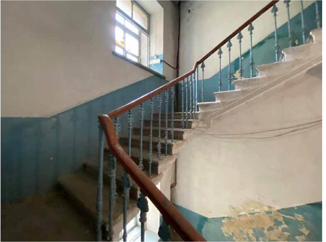
Фото № 65. Лестница 2ЛК между третьим и четвертым этажами.
