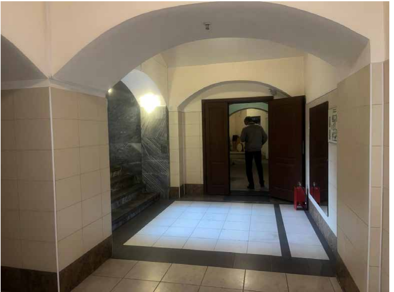
Фото № 83. Цокольный этаж, помещение 1-Н(100).
