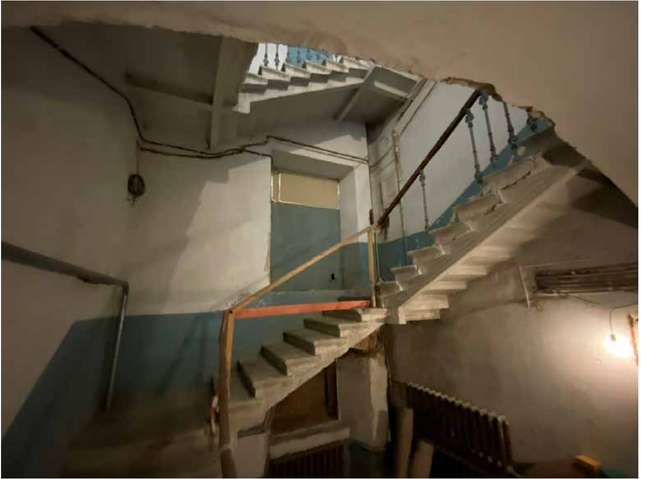
Фото № 56. Лестница 2ЛК между цокольным и первым этажами.
