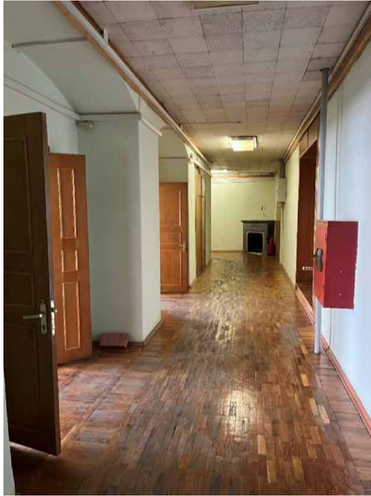
Фото № 282. 3 этаж, помещение 12-Н(12).
