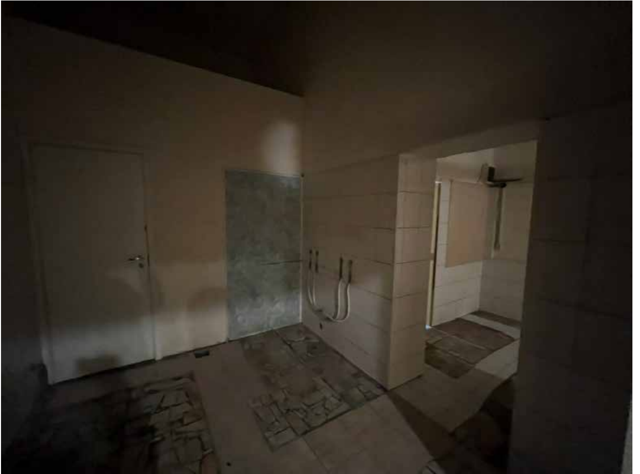
Фото № 98. Цокольный этаж, помещение 1-Н(114).
