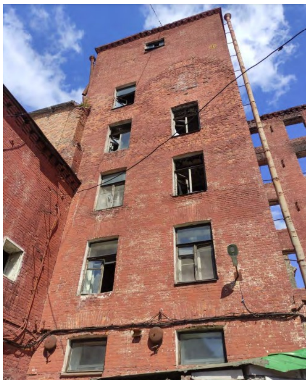
9. Объект культурного наследия регионального значения «Комплекс построек фабрики Товарищества шерстяных изделий «Торнтон» по адресу: г. Санкт-Петербург, Октябрьская наб., д. 50, литера А
