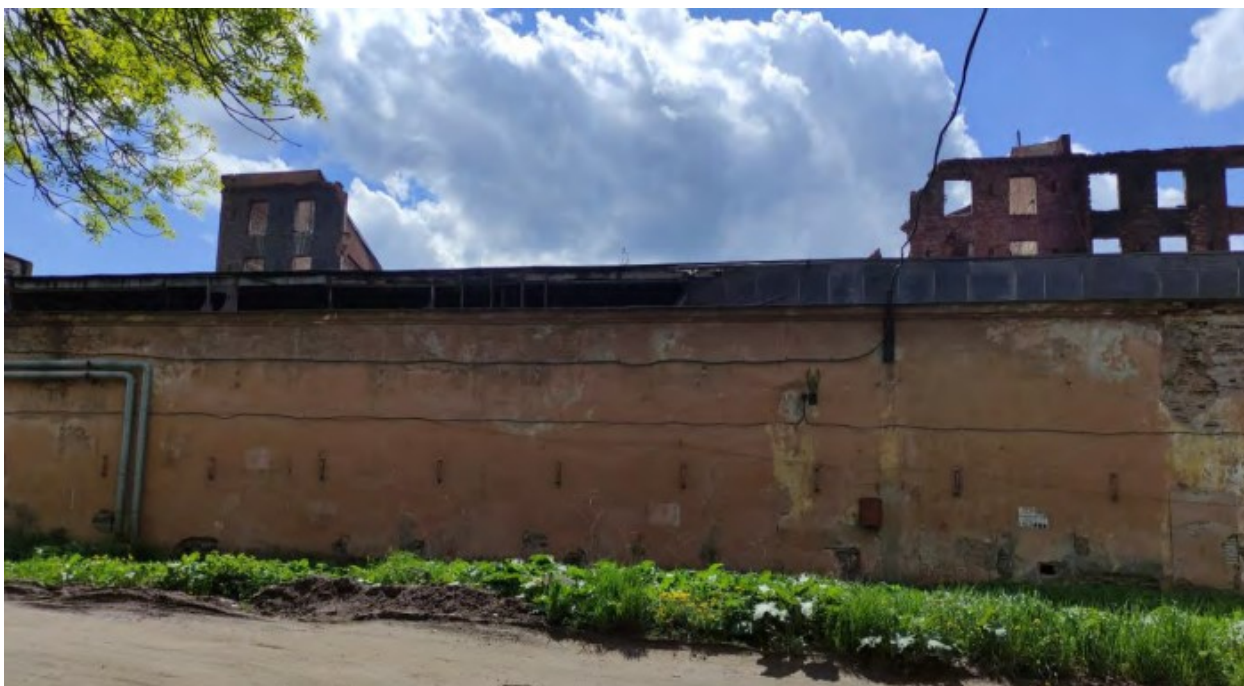
3. Демонтируемое здание по адресу: г. Санкт-Петербург, Октябрьская наб., д. 50, лит. А13 (1-3КН)
