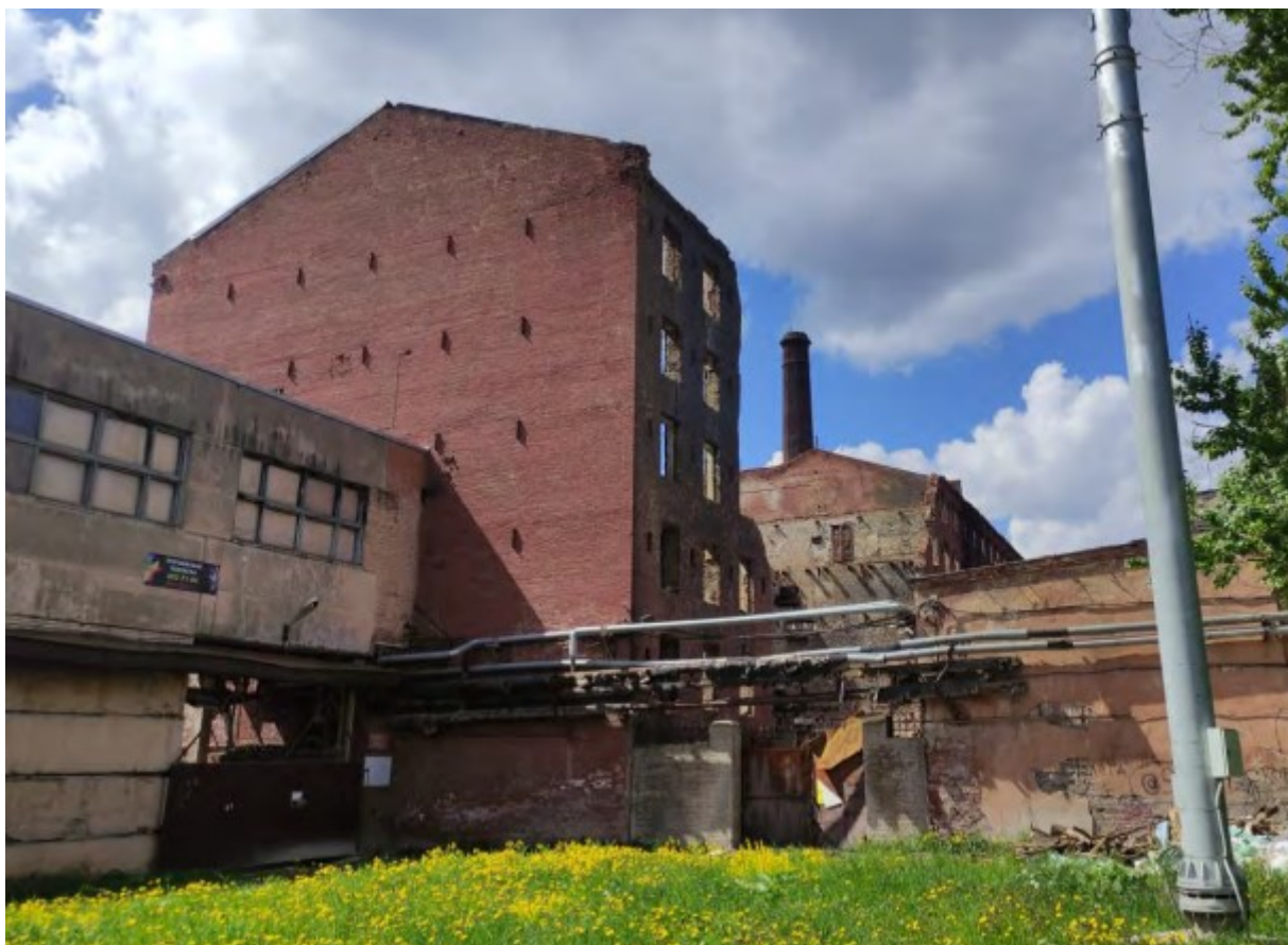
7. Объект культурного наследия регионального значения «Комплекс построек фабрики Товарищества шерстяных изделий «Торнтон» по адресу: г. Санкт-Петербург, Октябрьская наб., д. 50, литера А
