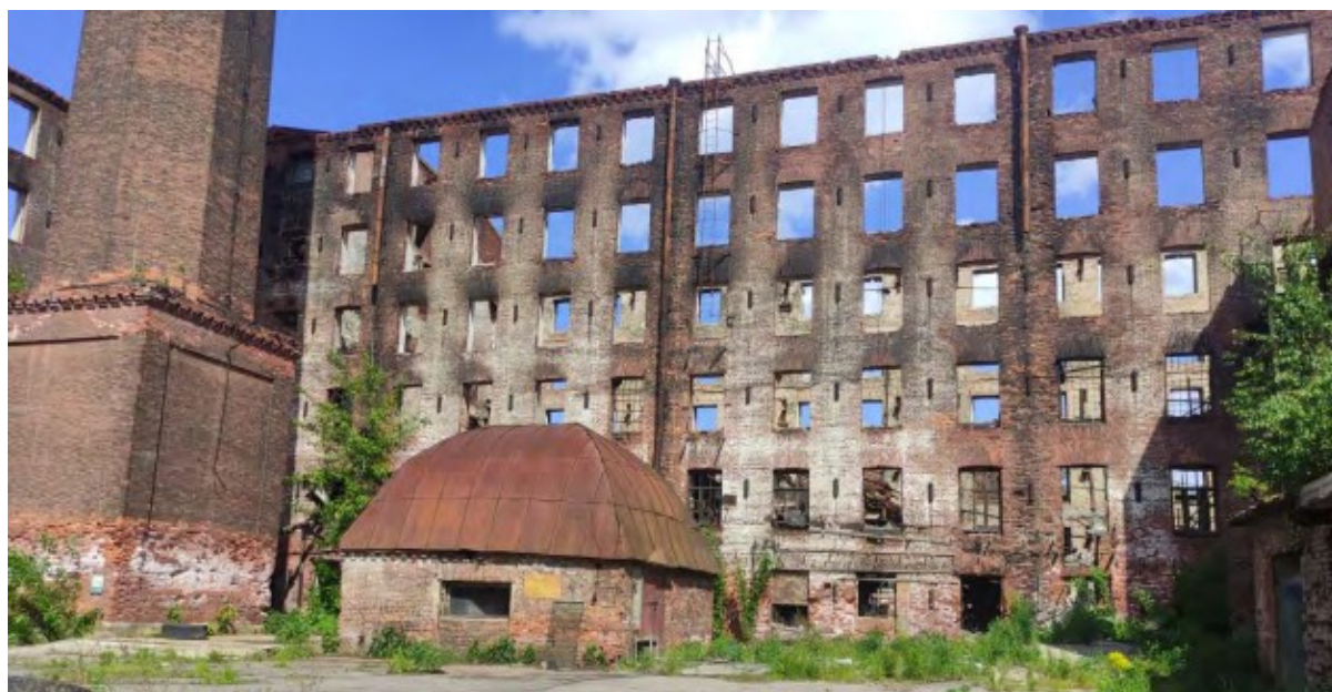
12. Объект культурного наследия регионального значения «Комплекс построек фабрики Товарищества шерстяных изделий «Торнтон» по адресу: г. Санкт-Петербург, Октябрьская наб., д. 50, литера А
