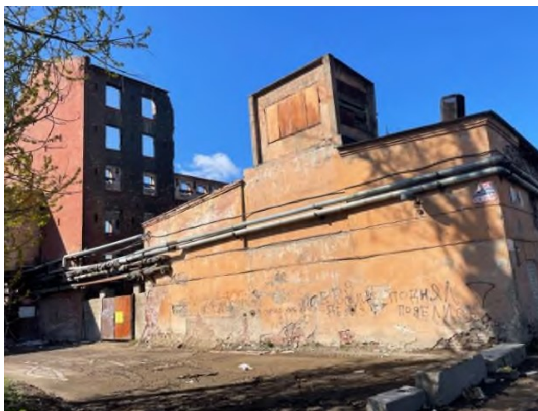
6. Демонируемое здание по адресу: г. Санкт-Петербург, Октябрьская наб., д. 50, лит. А12
