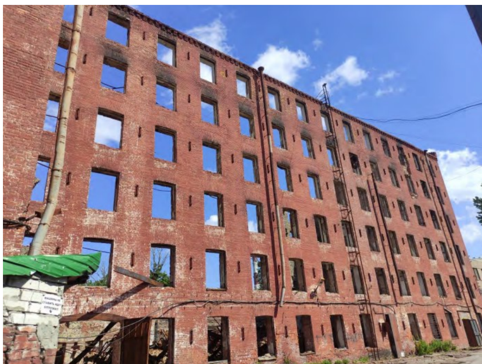
8. Объект культурного наследия регионального значения «Комплекс построек фабрики Товарищества шерстяных изделий «Торнтон» по адресу: г. Санкт-Петербург, Октябрьская наб., д. 50, литера А
