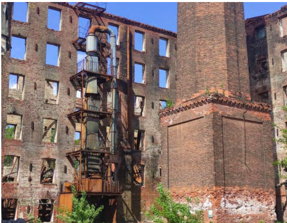
11. Объект культурного наследия регионального значения «Комплекс построек фабрики Товарищества шерстяных изделий «Торнтон» по адресу: г. Санкт-Петербург, Октябрьская наб., д. 50, литера А
