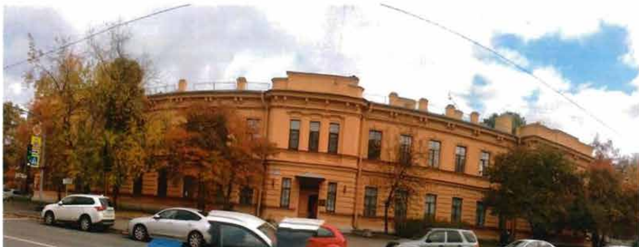
1. Вид на западный фасад объекта культурного наследия
