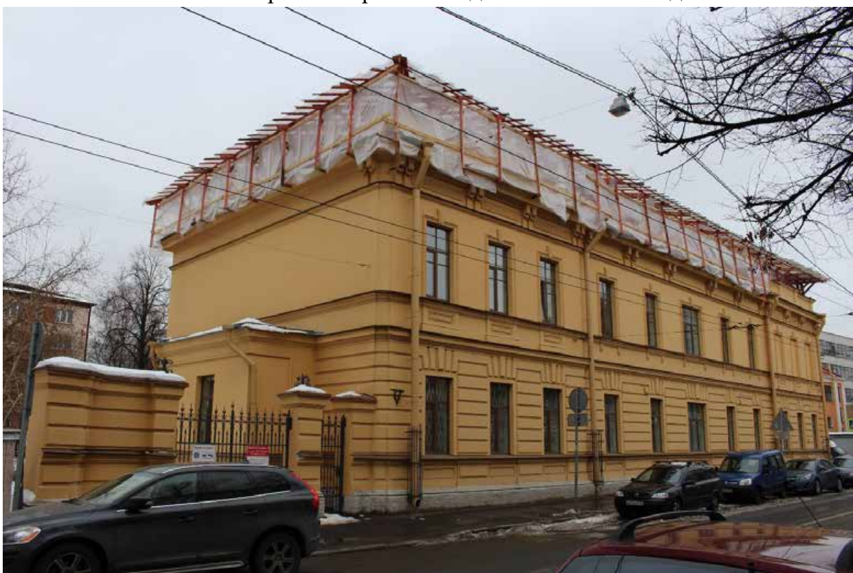
Фото 6. Вид на северный и восточный (торцовый) фасад объекта культурного наследия федерального значения «Приют Мариинский для воинов-инвалидов».
