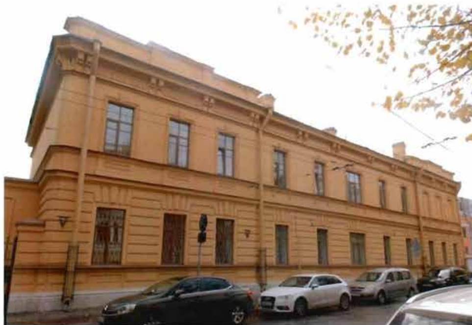
3. Вид на северный фасад объекта культурного наследия
