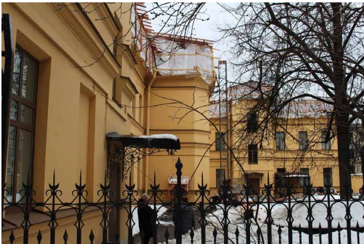
Фото 9. Вид на дворовые фасады объекта культурного наследия федерального значения «Приют Мариинский для воинов-инвалидов».
