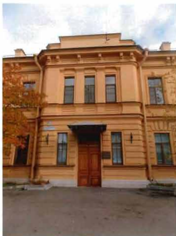
2. Парадный вход объекта культурного наследия
