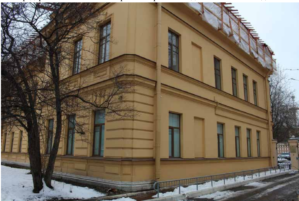
Фото 8. Вид на южный (торцовый) фасад объекта культурного наследия федерального значения «Приют Мариинский для воинов-инвалидов».
