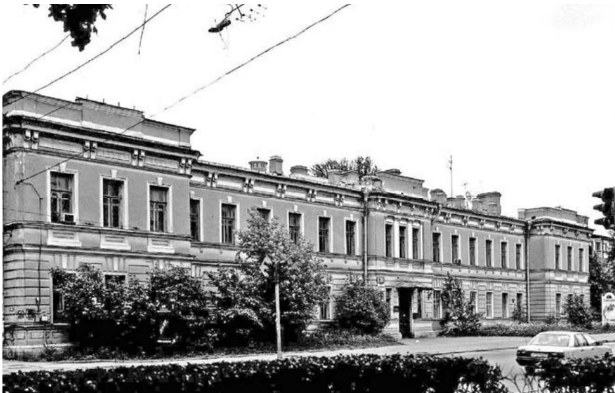
Илл. 17. Мариинский приют для ампутированных и увечных воинов проф. Альбрехта. Вид на западный фасад. 1997 г. (источник: архив КГИОП, инв. № 935-П)
