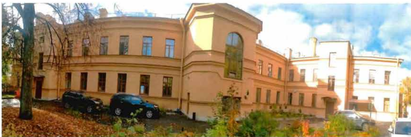
4. Вид на дворовый фасад объекта культурного наследия
