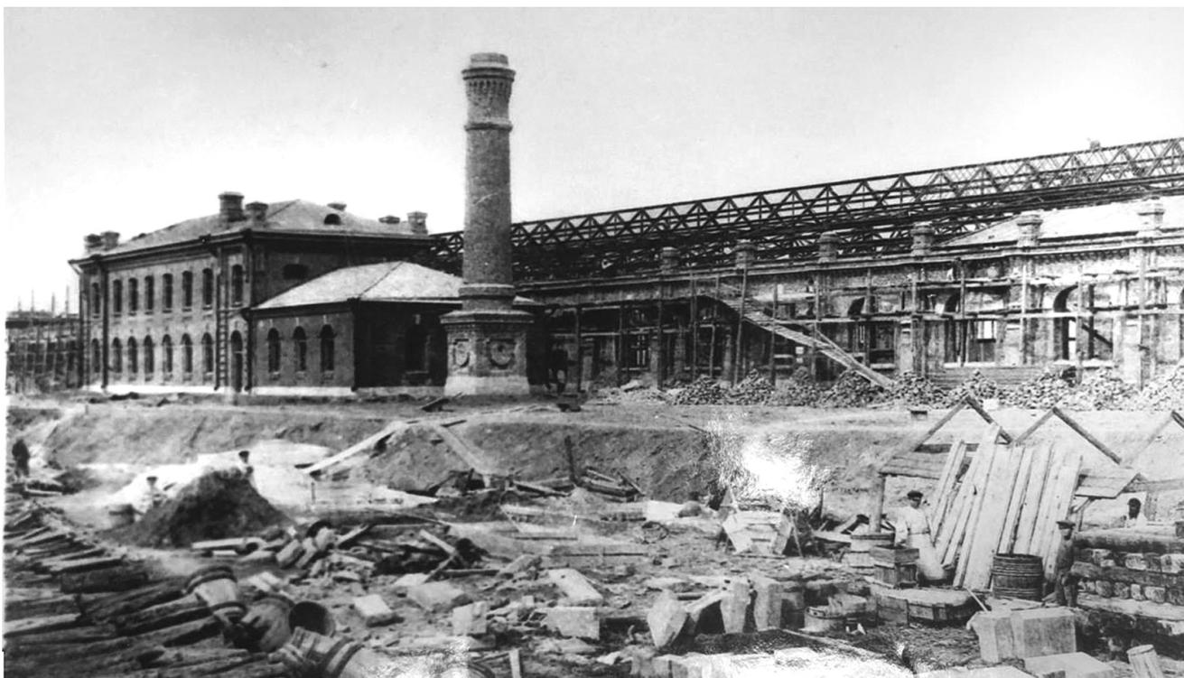
**Илл. 16.** «Общий вид сарая для Императорских поездов и пристройки к нему. Приготовление цементно-бетонных облицовочных камней». 1897-1898 гг. Retro View of Mankind's Habitat [Электронный ресурс]. Режим доступа: <https://pastvu.com/>.
