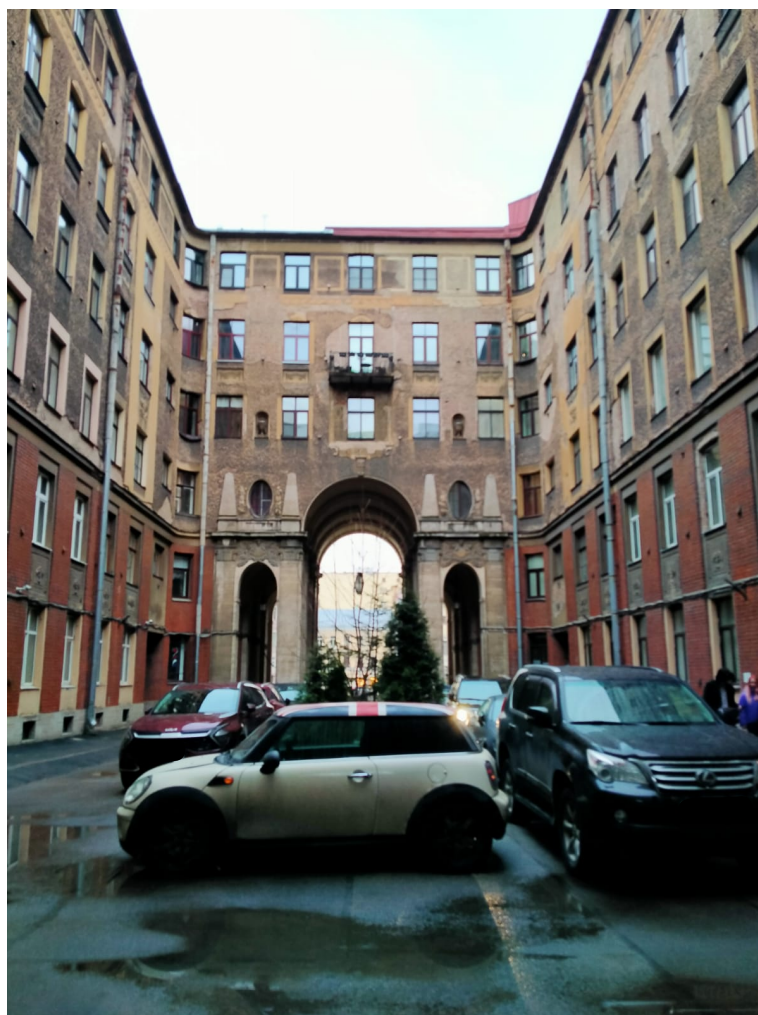
8. Общий вид дворовых фасадов здания по адресу: Санкт-Петербург, ул. Рубинштейна, д. 15-17, Лит. А
