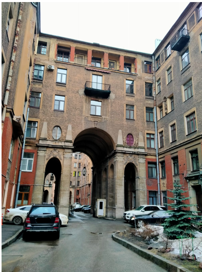
4. Общий вид дворовых фасадов здания по адресу: Санкт-Петербург, ул. Рубинштейна, д. 15-17, Лит. А
