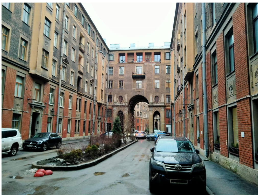
3. Общий вид дворовых фасадов здания адресу: Санкт-Петербург, ул. Рубинштейна, д. 15-17, Лит. А
