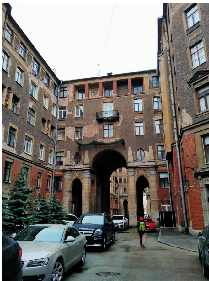
6. Общий вид дворовых фасадов здания по адресу: Санкт-Петербург, ул. Рубинштейна, д. 15-17, Лит. А
