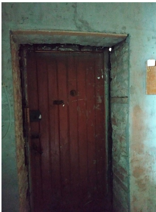
39. Входная дверь, ведущая на «черную» лестницу
