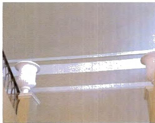
оформление потолка лестницы: профилированная тяга по периметру, падуга с распалубками, в которые вписаны полуциркульные профилированные архивольты, профилированный карниз с поясом модульонов;
