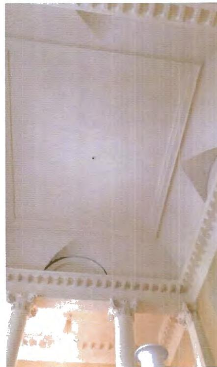
оформление потолка верхнего марша лестницы: профилированная тяга по периметру, профилированный карниз с поясом модульонов;
