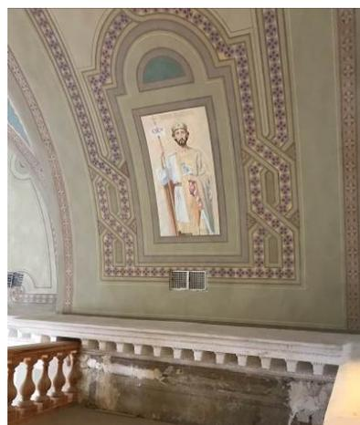
оформление стен: прямоугольные ниши в северной и южной стенах, с прямыми сандриками на фигурных кронштейнах, под нишами балюстрадное ограждение с гладкими опорными столбиками; профилированная тяга в нижних частях стен, под нишами;
