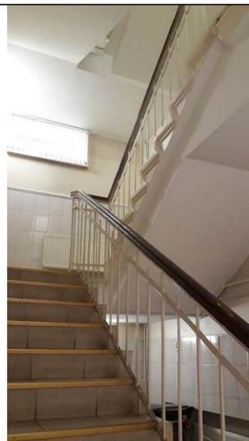
двухмаршевая межэтажная лестница (Л-1) в центральной части южного корпуса (литера В), с известняковыми ступенями и металлическим ограждением (рисунок – вертикальные стойки с пятниками, перехватами и набалдашниками) с деревянными профилированными поручнями, на косоурах;
