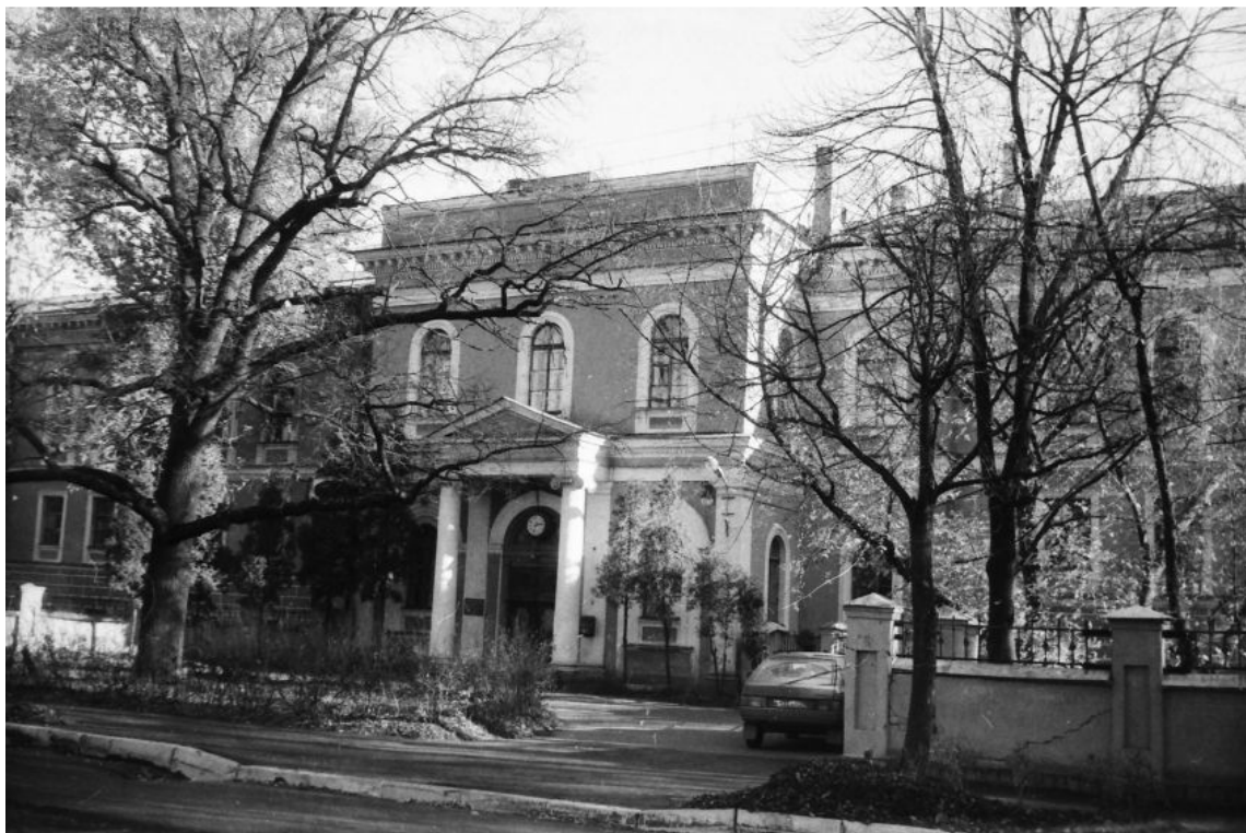
Илл. 19. Церковь иконы Божией Матери "Всех скорбящих Радость" при бывшем Дворцовом госпитале. Дата съемки: 1 апреля 1995 г. Автор фотографии: Андрей Агафонов // Источник: https://sobory.ru/photo/201287
