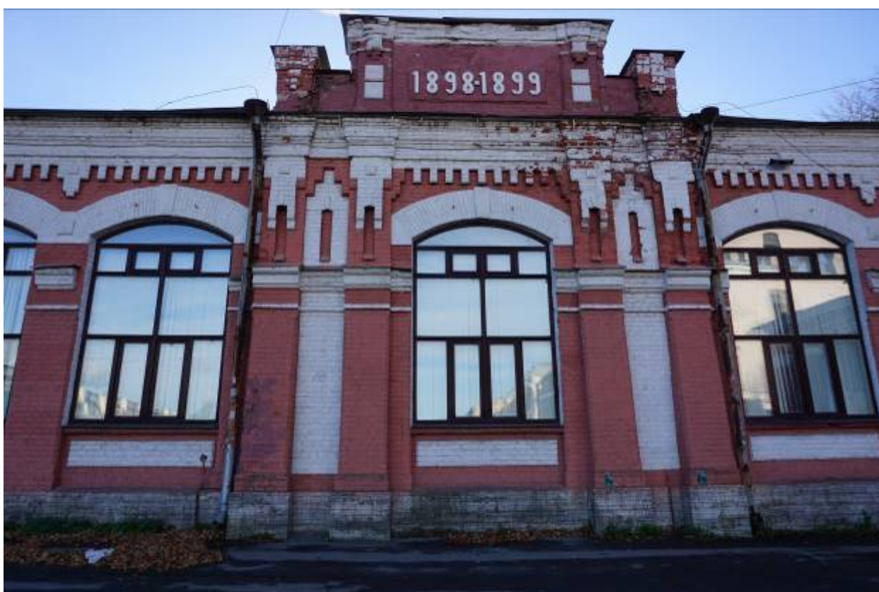
Фото 4. Фрагмент северного фасада здания. Вид на аттик и оконные проемы.
