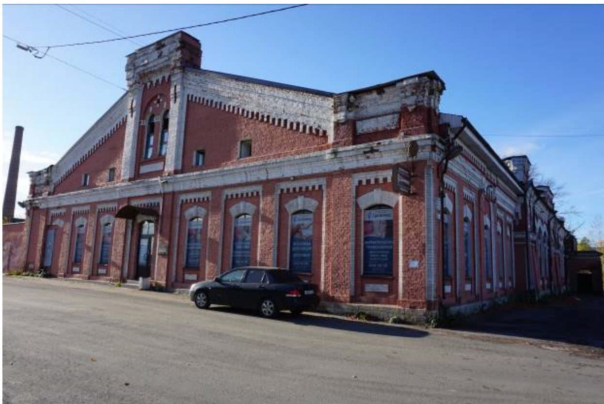
Фото 1. Восточный фасад здания.
