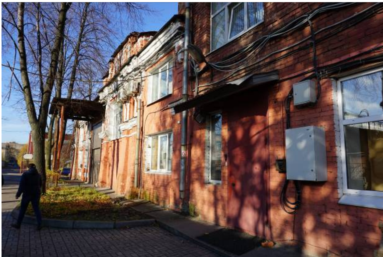
Фото 14. Фрагмент южного фасада здания.
