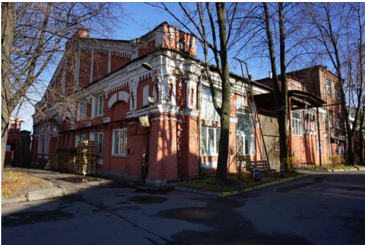
Фото 9. Западный и южный фасады здания.
