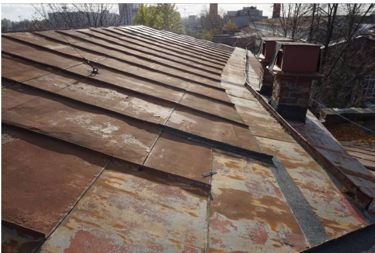
Фото 19. Металлическое покрытие кровли в северной части здания.
