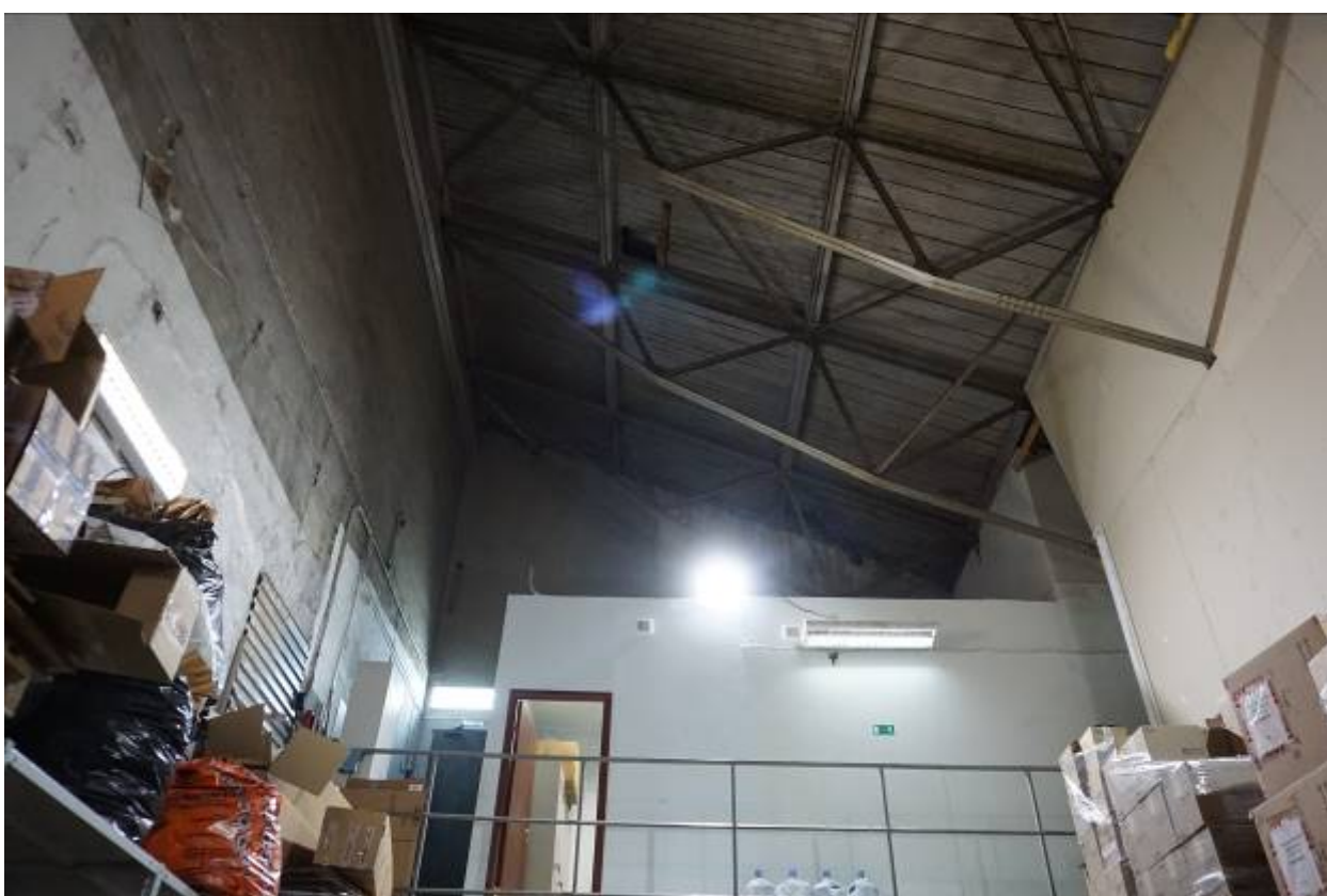
Фото 17. Серповидные металлические фермы в юго-восточной части здания.
