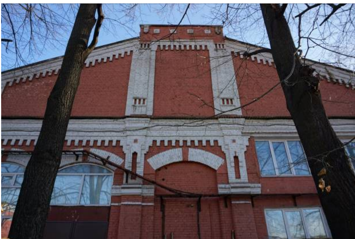
Фото 6. Фрагмент западного фасада здания.
