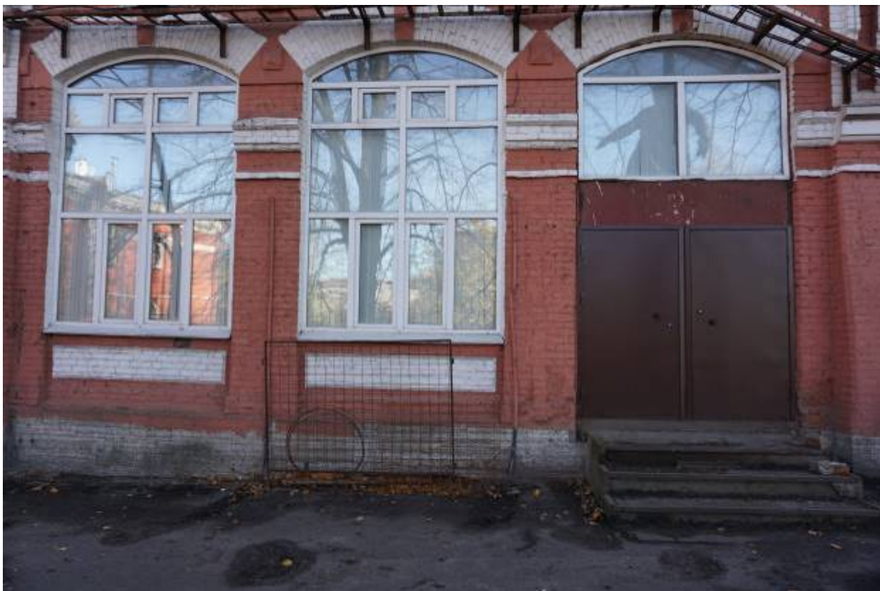
Фото 7. Фрагмент западного фасада здания.
