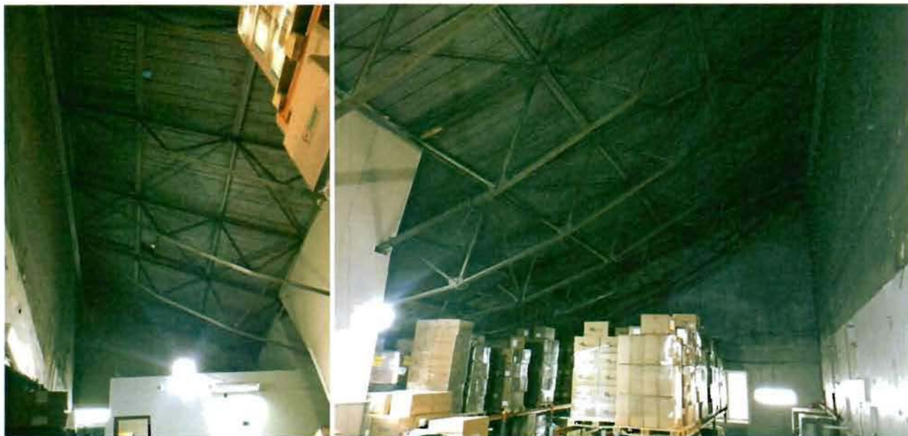
13, 14. Металлические фермы перекрытий складских помещений.
