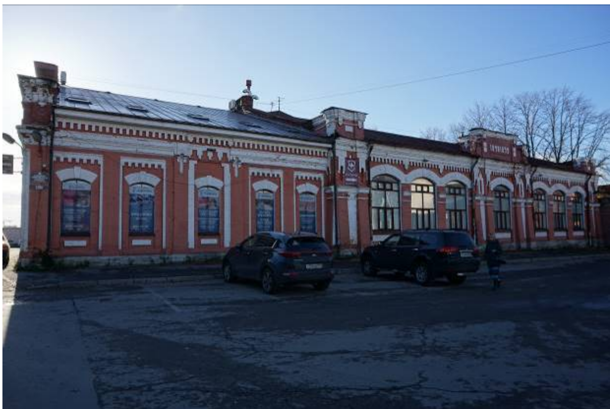
Фото 3. Общий вид северного фасада здания.
