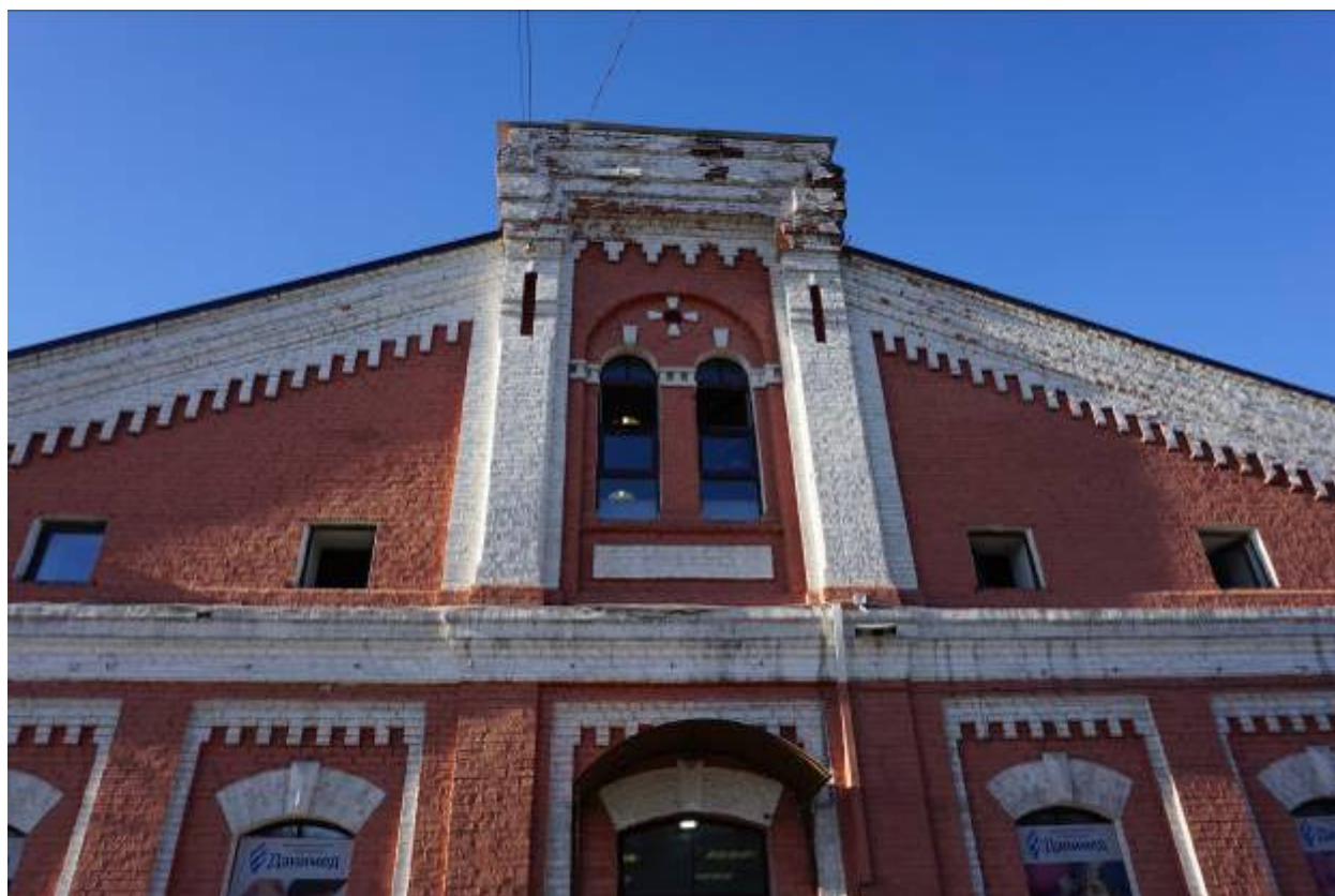
Фото 2. Фрагмент восточного фасада здания.
