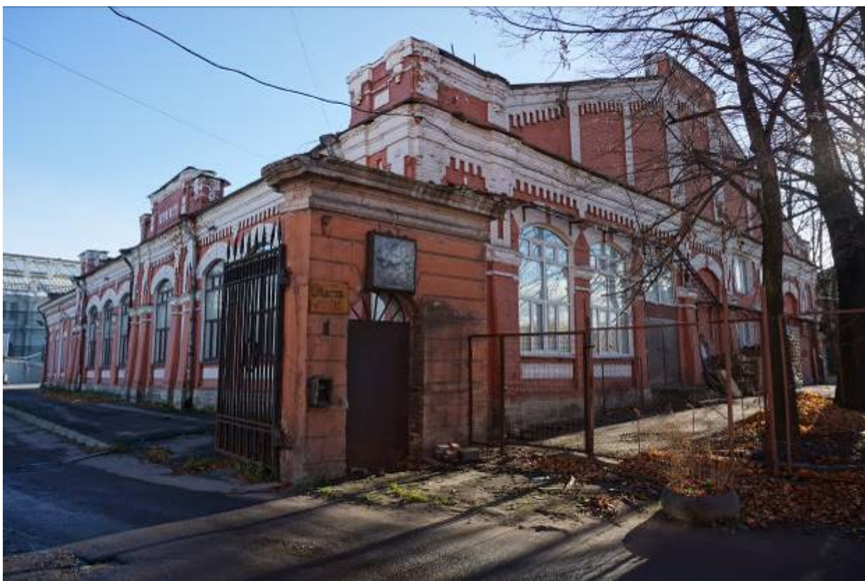
Фото 5. Северный и западный фасады здания.
