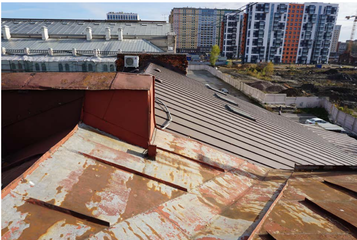
Фото 18. Металлическое покрытие кровли в южной части здания.
