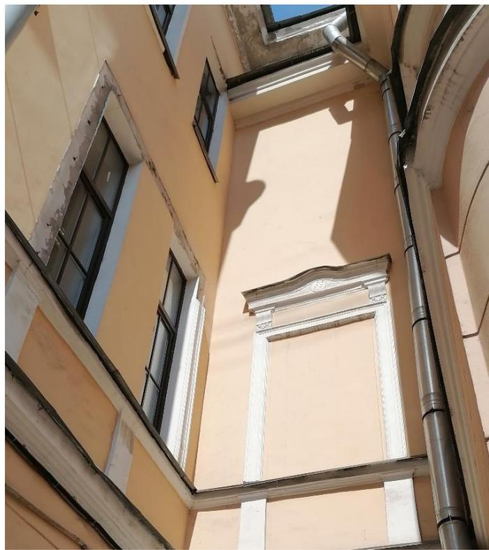
Фото 31. Здание детского отделения городской поликлиники №27. Состояние отделки оконных проемов второго этажа в примыкании к части здания пенсионного фонда. 23.05.2023г.
