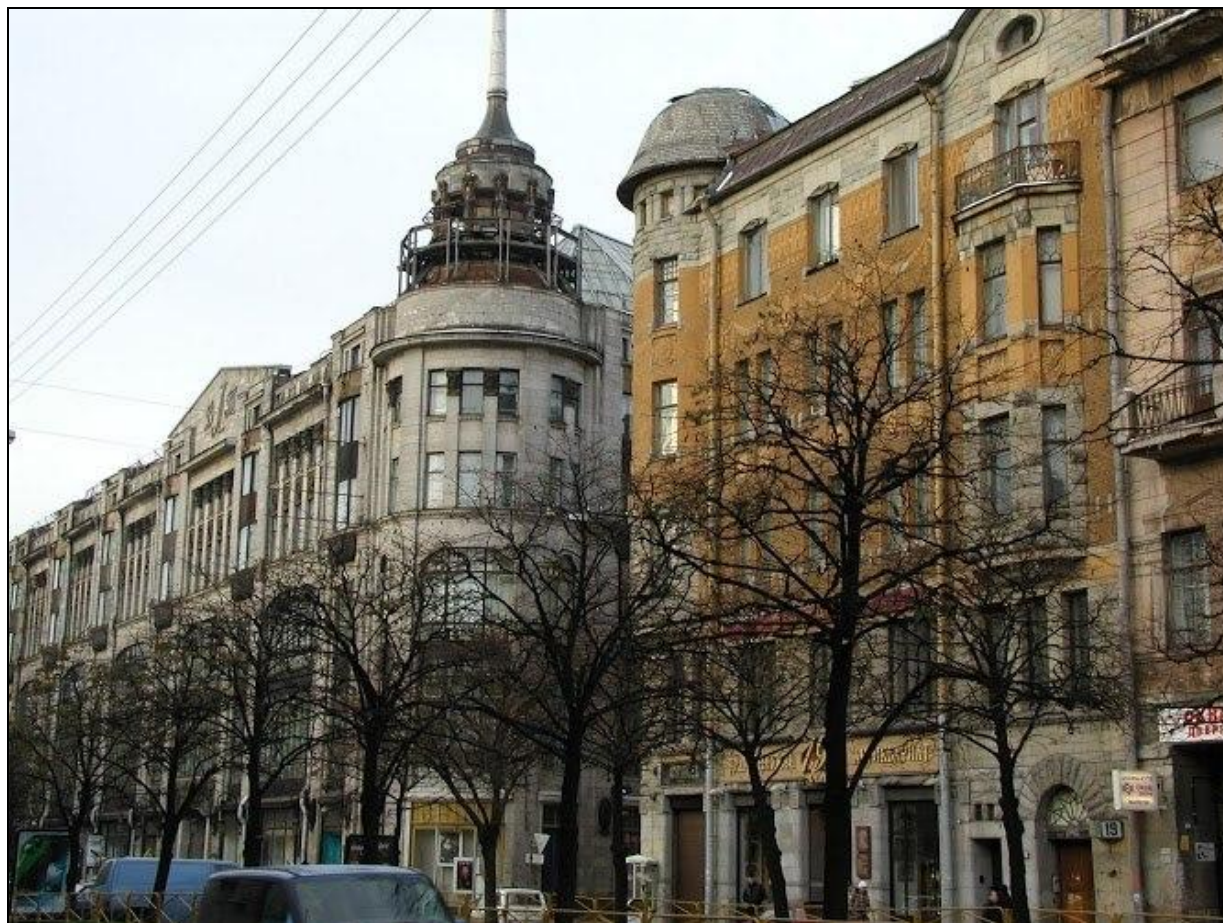
Илл. 29. «Дом М.Н. и Н.А. Мельцеров». Верхняя часть башенки углового эркера утрачена.
