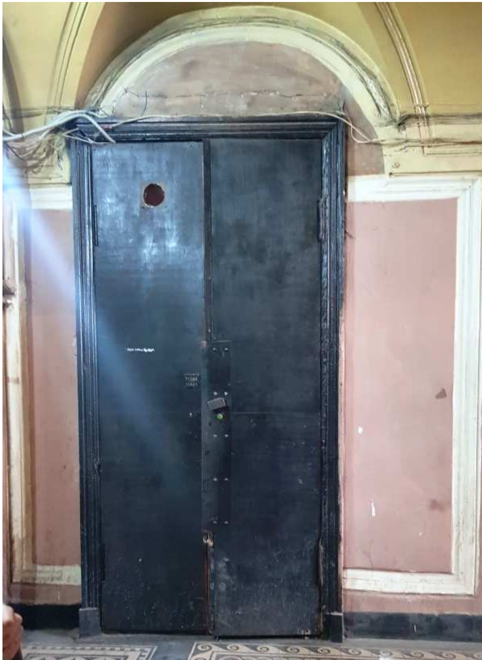
6. Вход в помещение 27-Н с лестничной площадки.
