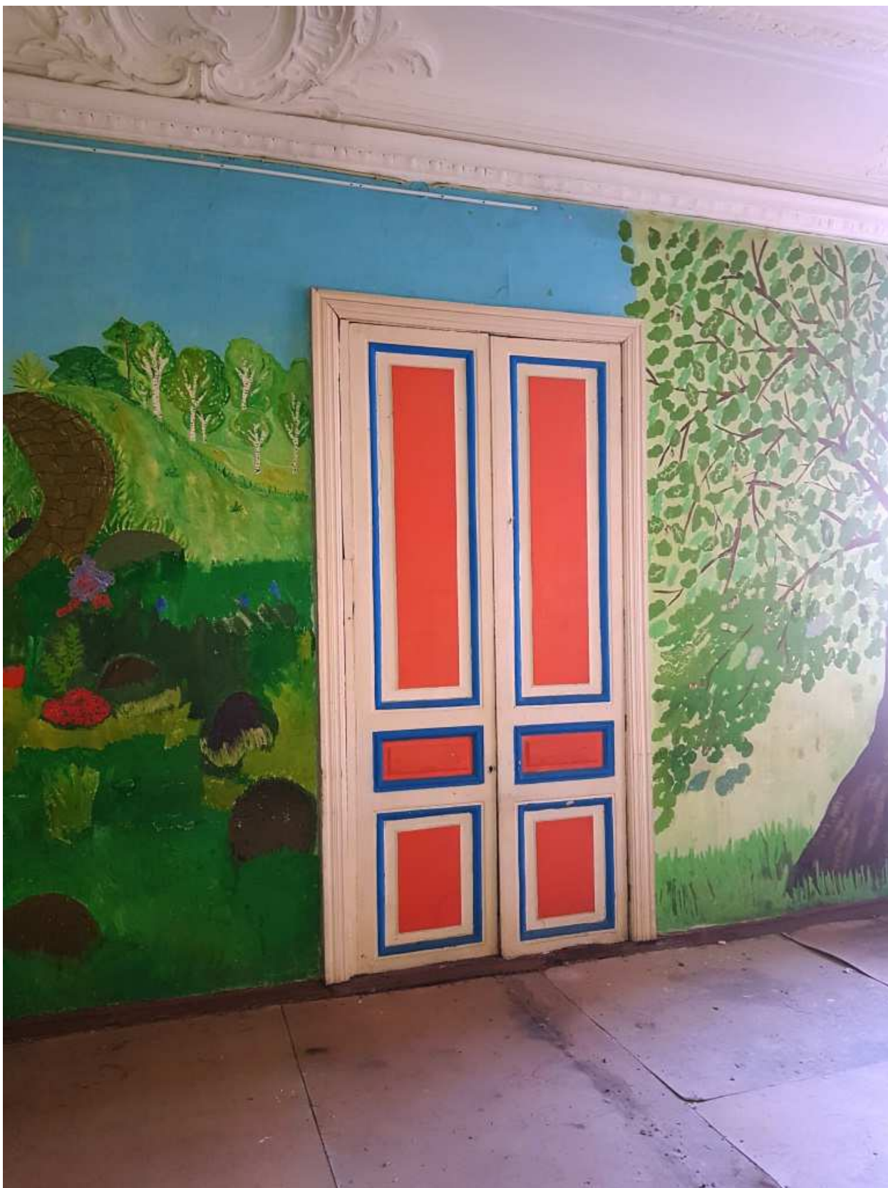
21. Пом.4. Дверной проем.
