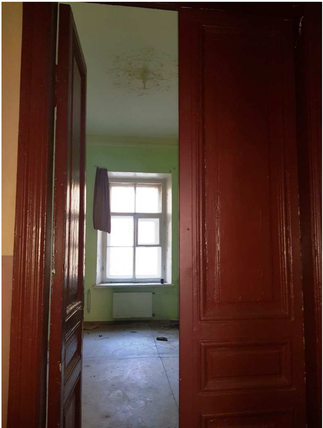
12. Пом.7. Общий вид.
