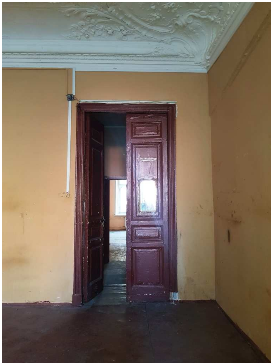
27. Пом. 3. Вид дверного проема (западная стена).
