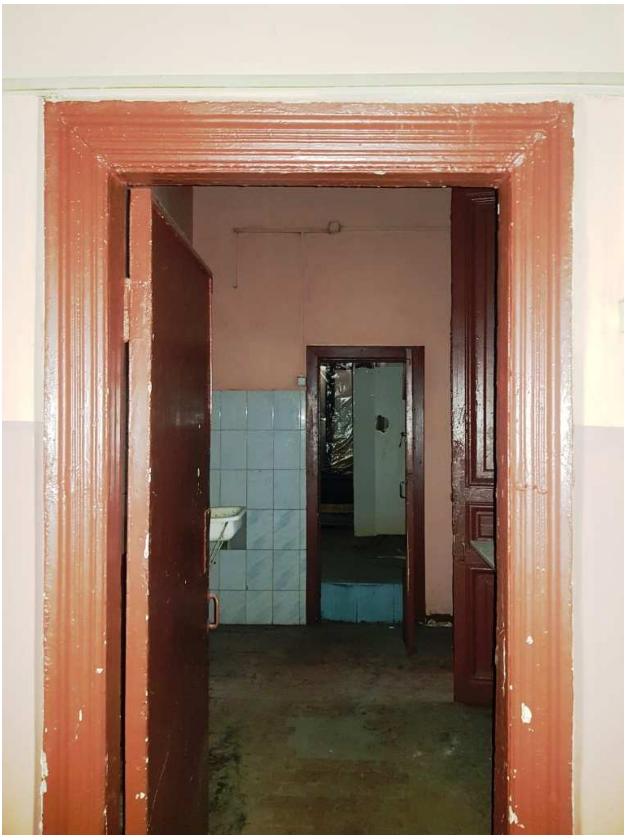
17. Пом.12. Общий вид.
