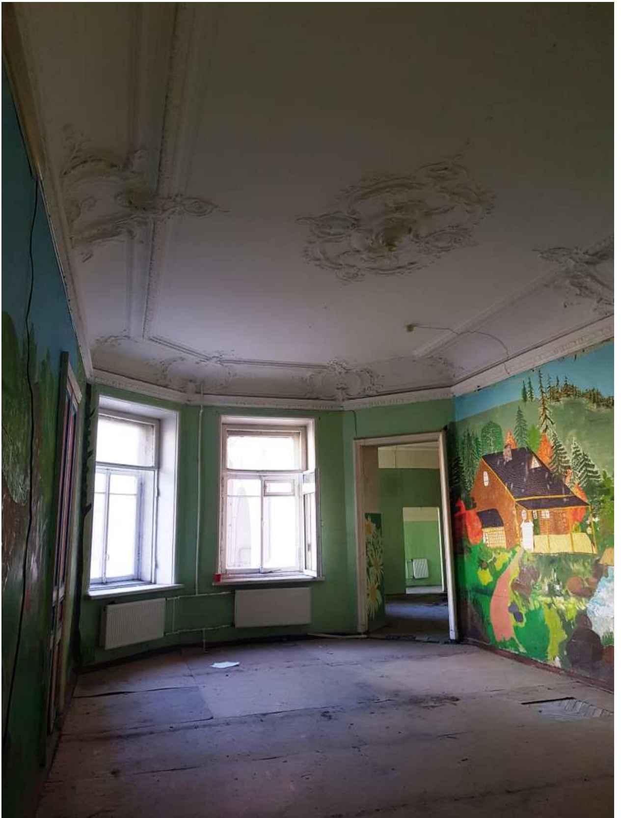
19. Пом. 4. Общий вид.
