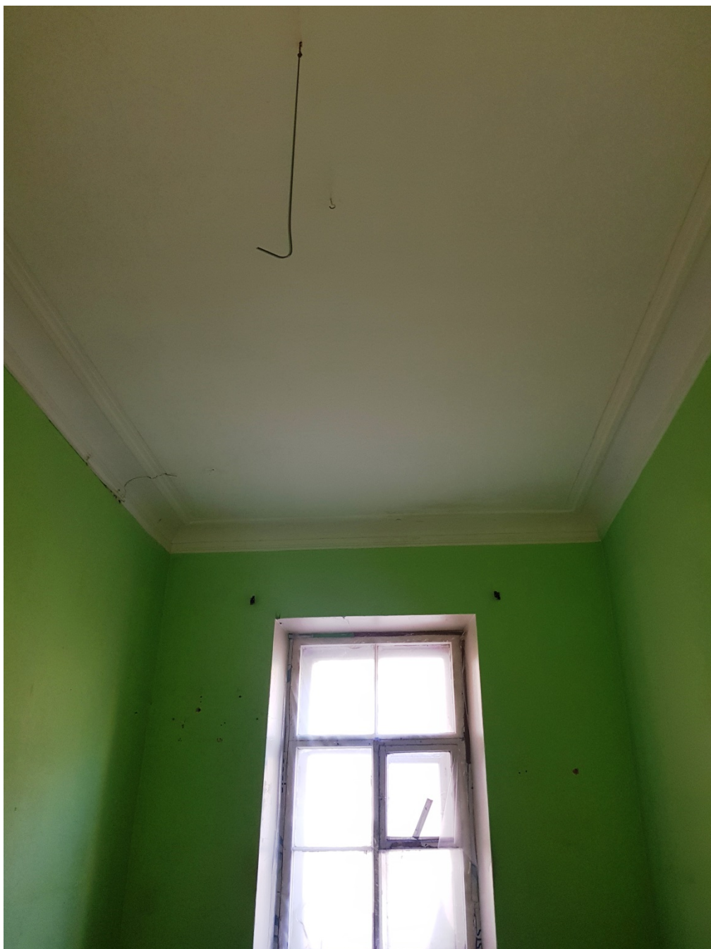
15. Пом.10. Общий вид.
