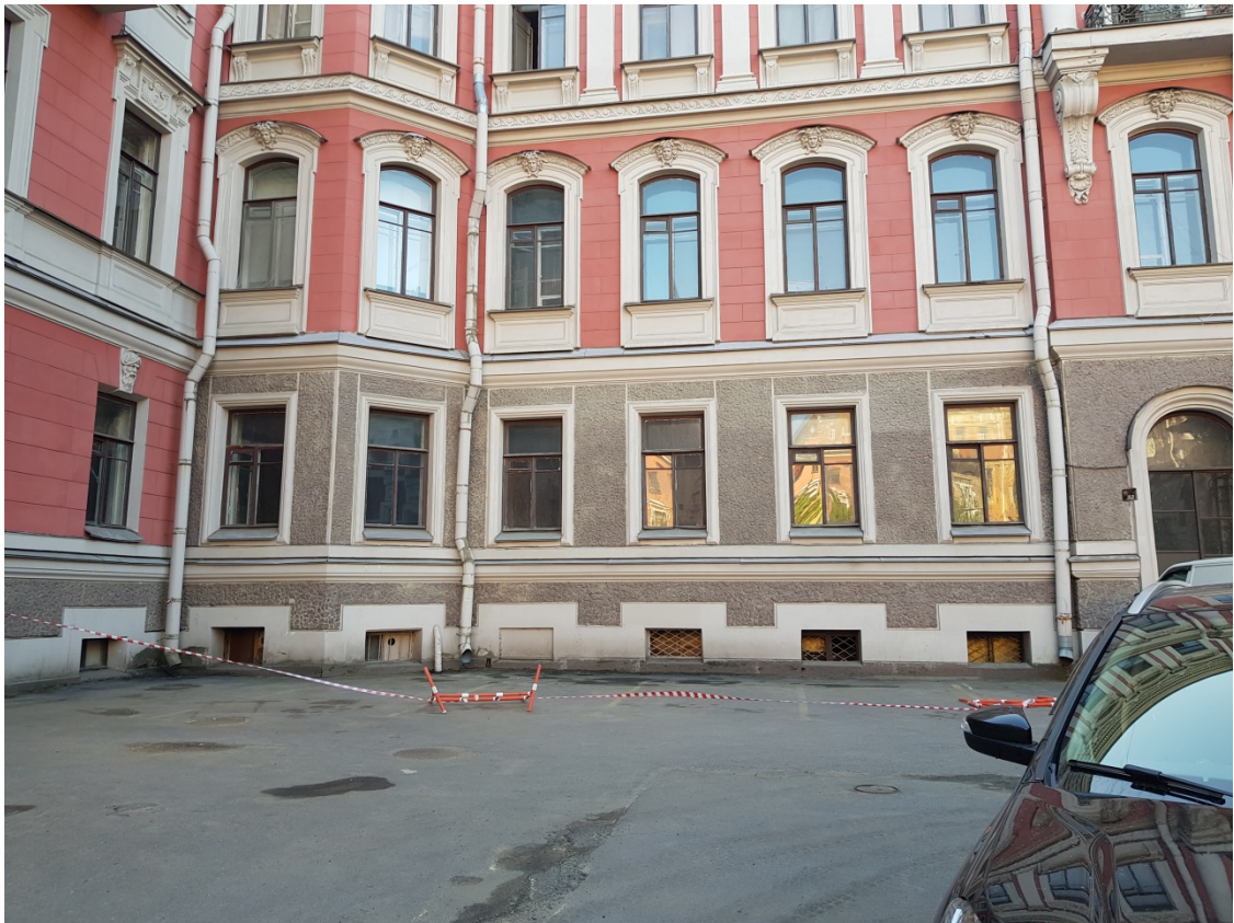
3. Фрагмент лицевого фасада. Оконные проемы помещения 27-Н.
