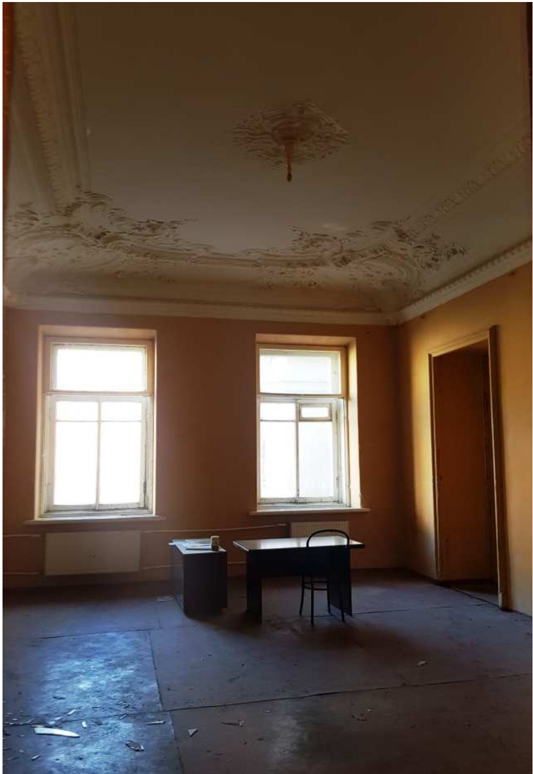
24. Пом.3. Общий вид.
