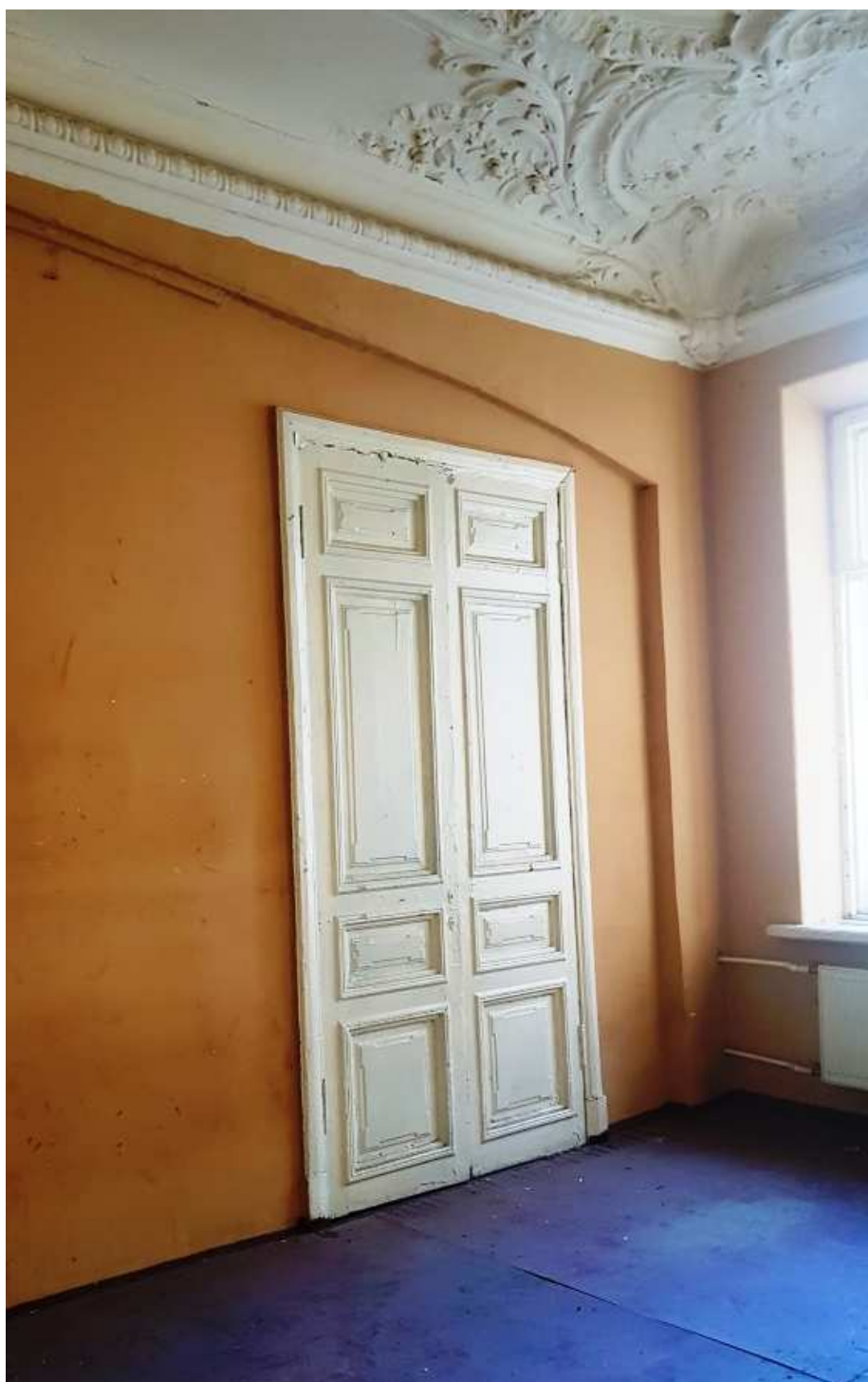
25. Пом. 3. Вид дверного проема (северная стена).
