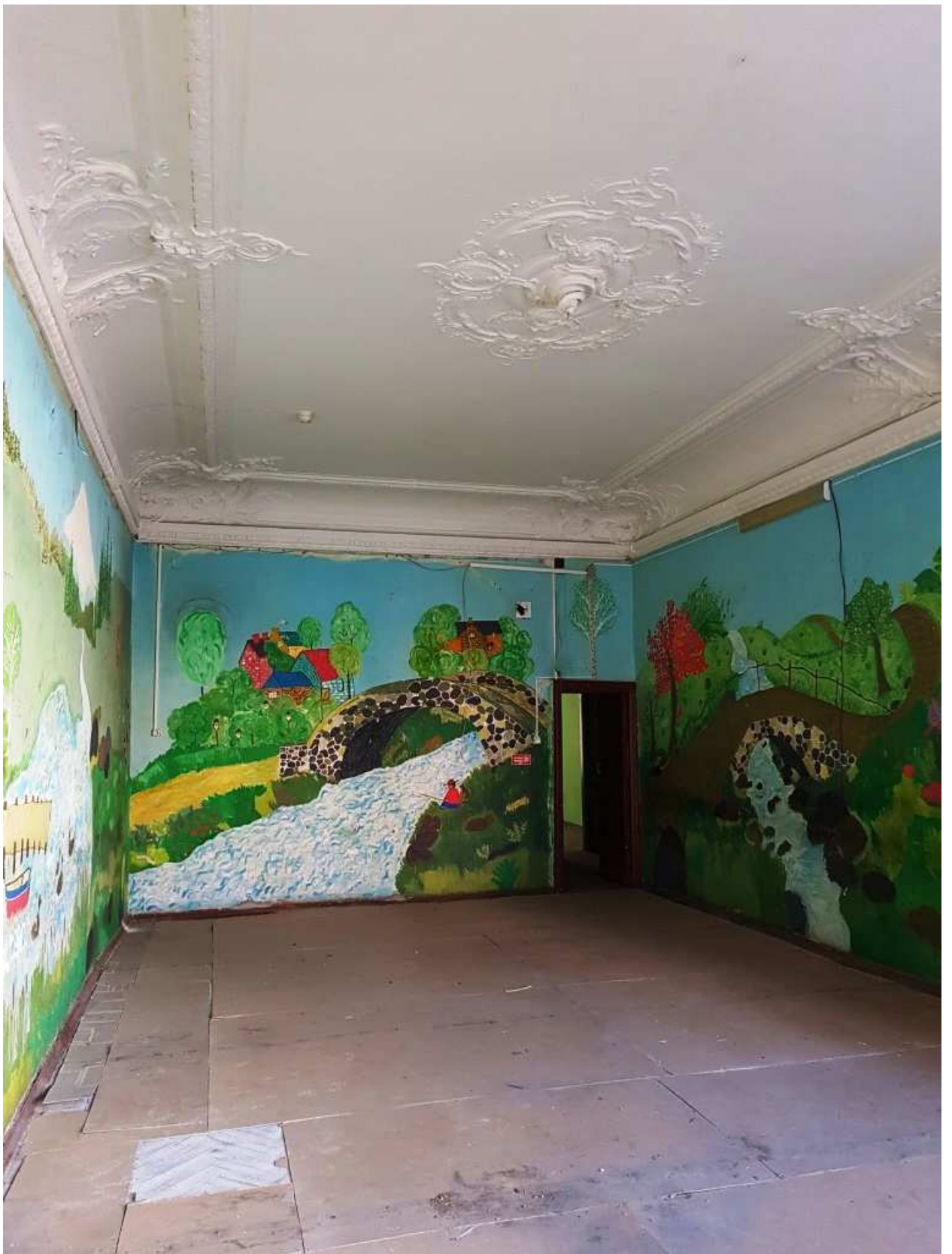
20. Пом.4. Общий вид.
