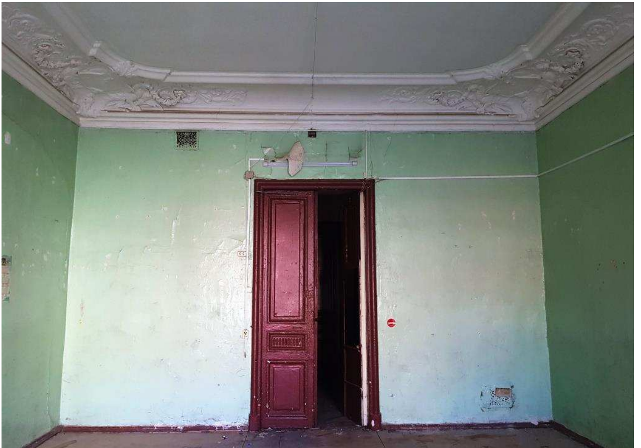
31. Пом.2. Вид дверного проема (западная стена).
