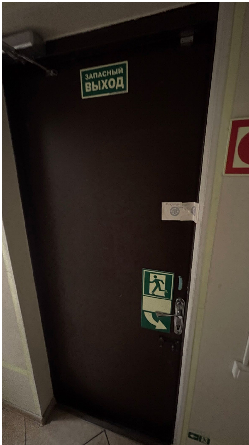
41. Вид на входную дверь в помещении;
