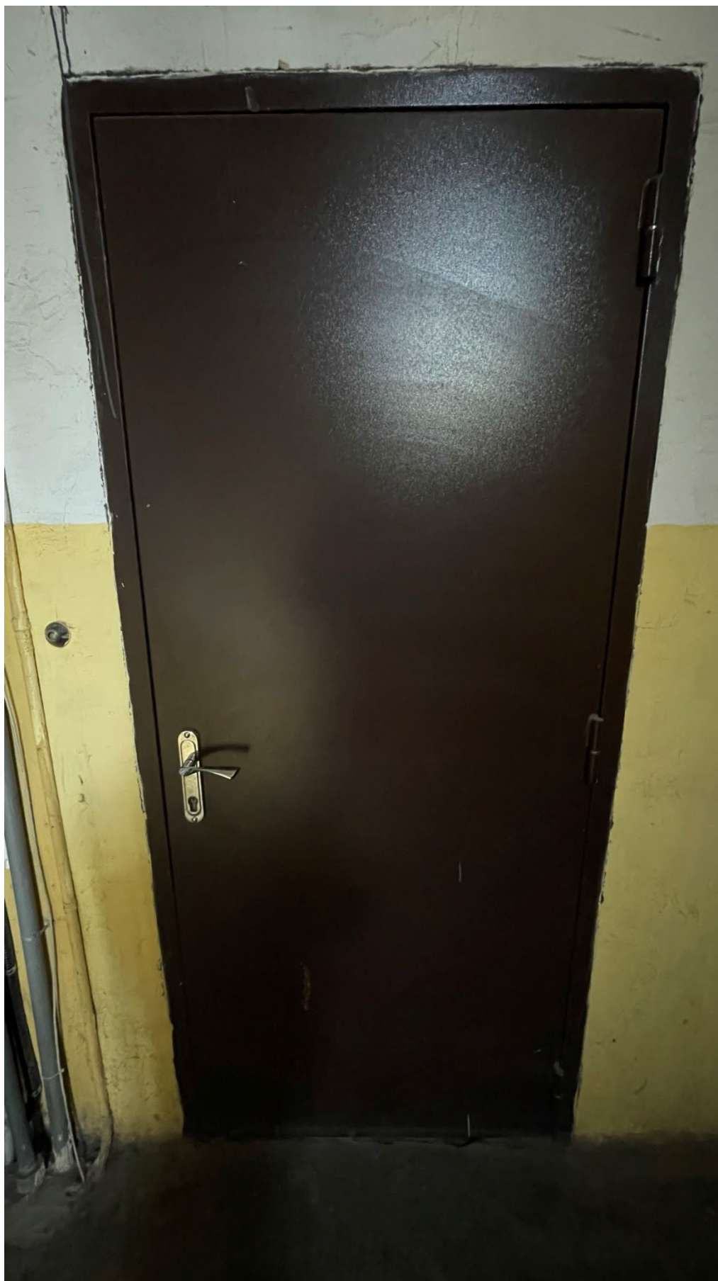
42. Вид на входную дверь с черной лестницы;
