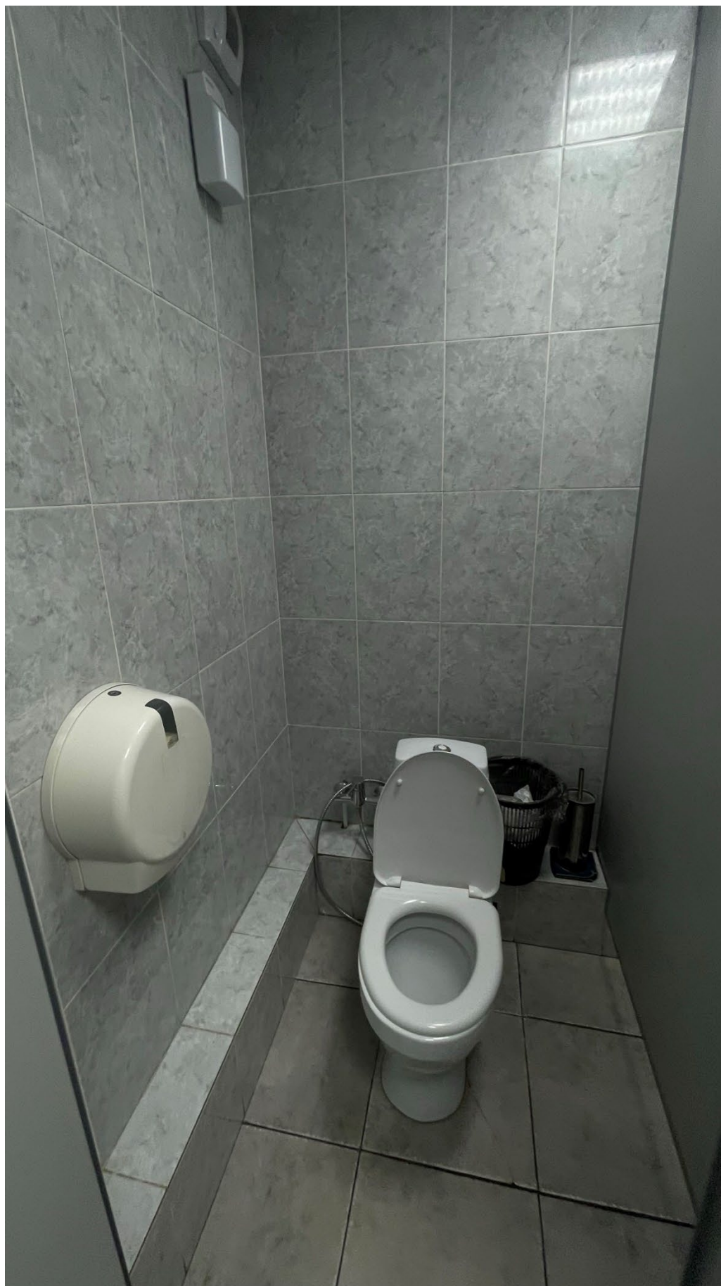
32. Фрагмент интеръера санузла (помещение 26/5.5);
