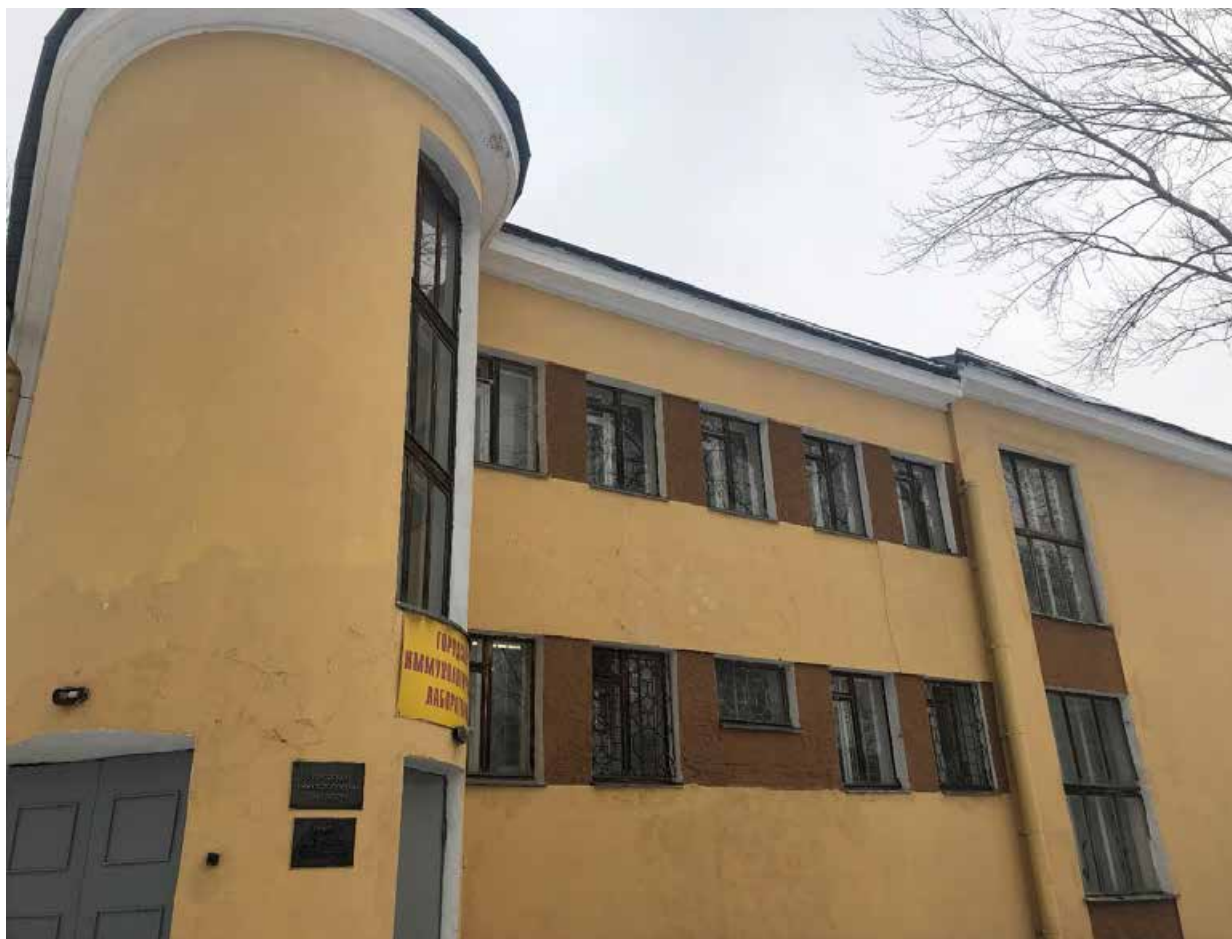
Фото 10 Территория объекта культурного наследия регионального значения «Комплекс Александровской барачной больницы (больницы им. С.П. Боткина)». Вид на задание литеры С
