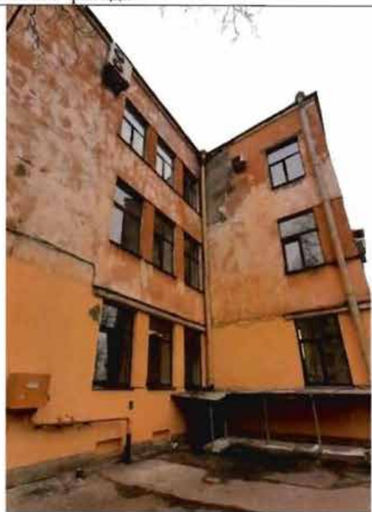
6. Фрагмент юго-западного фасада
