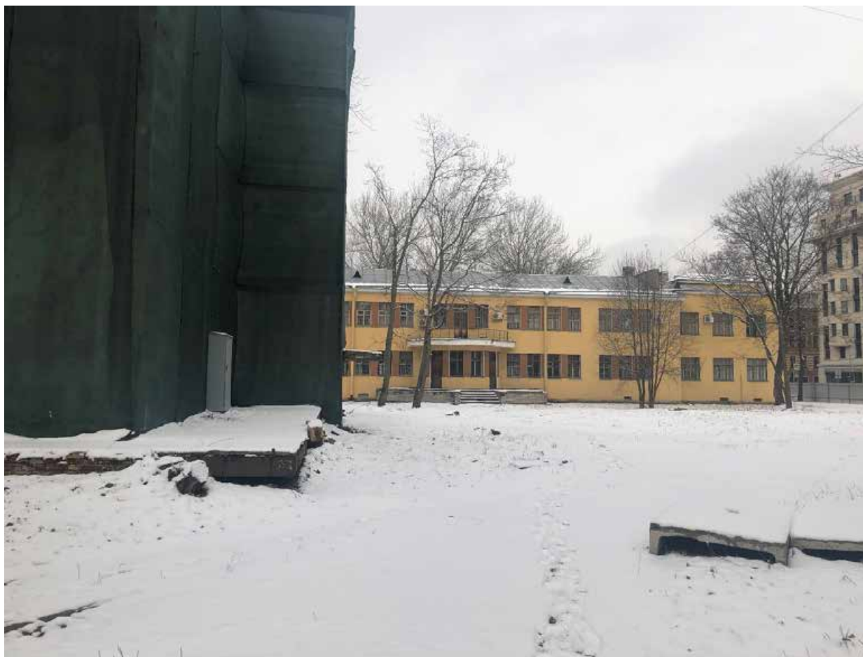
Фото 3. Территория объекта культурного наследия регионального значения «Комплекс Александровской барачной больницы (больницы им. С.П. Боткина)». Вид на задания литера Е и С.
