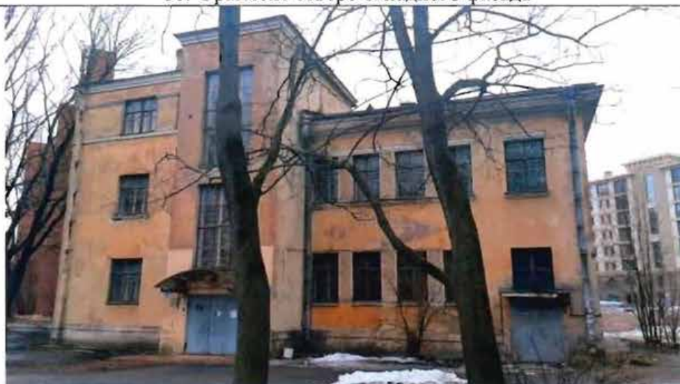
11. Фрагмент северо-восточного фасада
