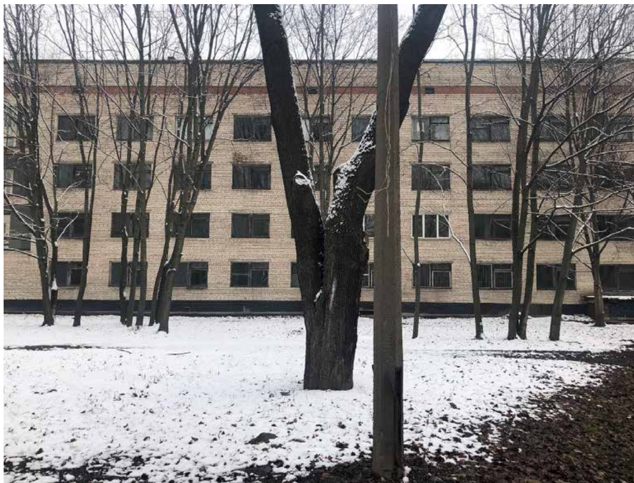
Фото 1. Территория объекта культурного наследия регионального значения «Комплекс Александровской барачной больницы (больницы им. С.П. Боткина)». Вид на задание литера К.
