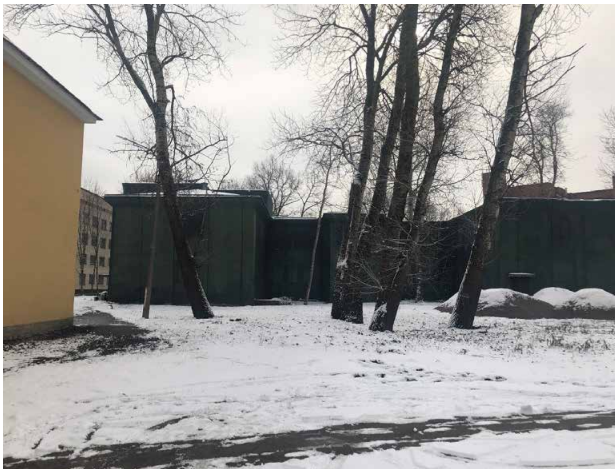
Фото 8 Территория объекта культурного наследия регионального значения «Комплекс Александровской барачной больницы (больницы им. С.П. Боткина)». Вид на задания литера С, Е, К.
