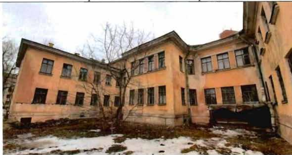
2. Фрагмент северо-западного фасада
