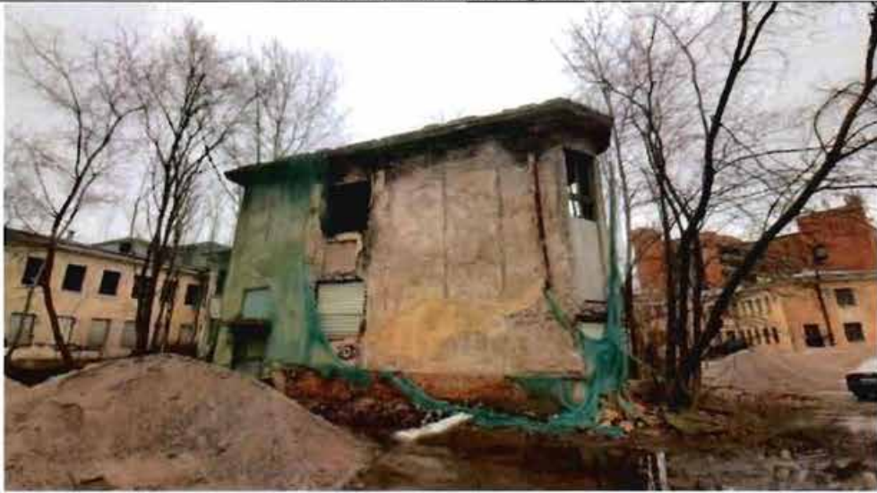
7. Фрагмент северо-западного фасада
