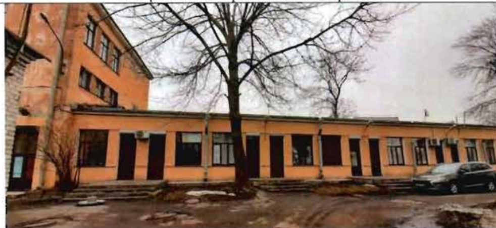
3. Фрагмент юго-западного фасада
