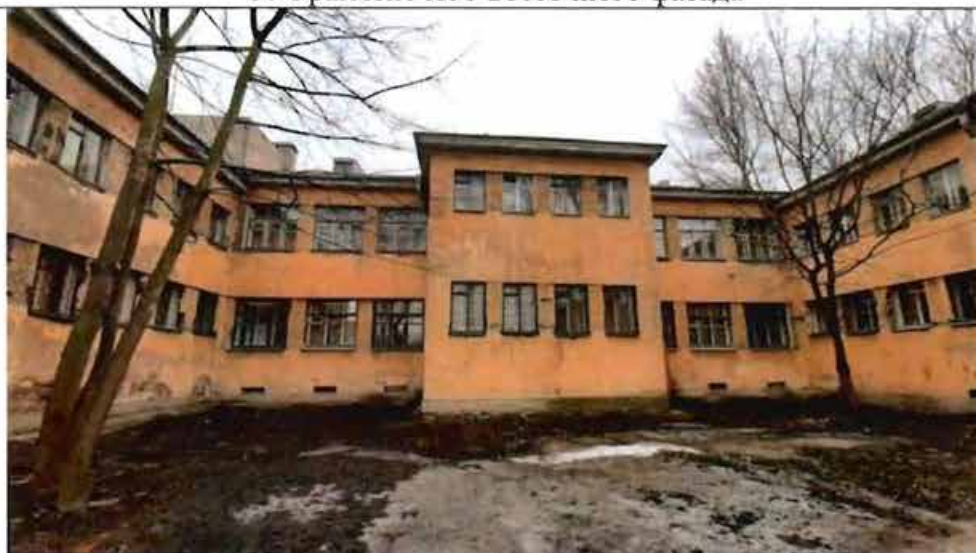
10. Фрагмент северо-западного фасада
