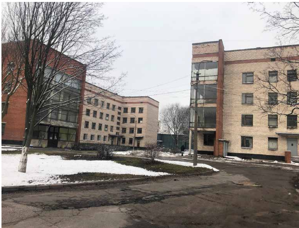
Фото 21 Территория объекта культурного наследия регионального значения «Комплекс Александровской барачной больницы (больницы им. С.П. Боткина)». Вид на здания литера К, И, Е
