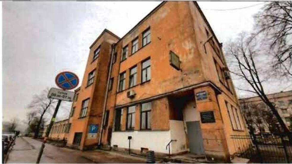
1. Фрагмент северо-восточного фасада
