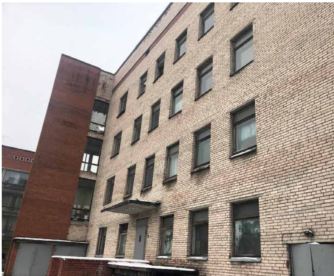
Фото 25 Территория объекта культурного наследия регионального значения «Комплекс Александровской барачной больницы (больницы им. С.П. Боткина)». Вид на здания литера И, А.
