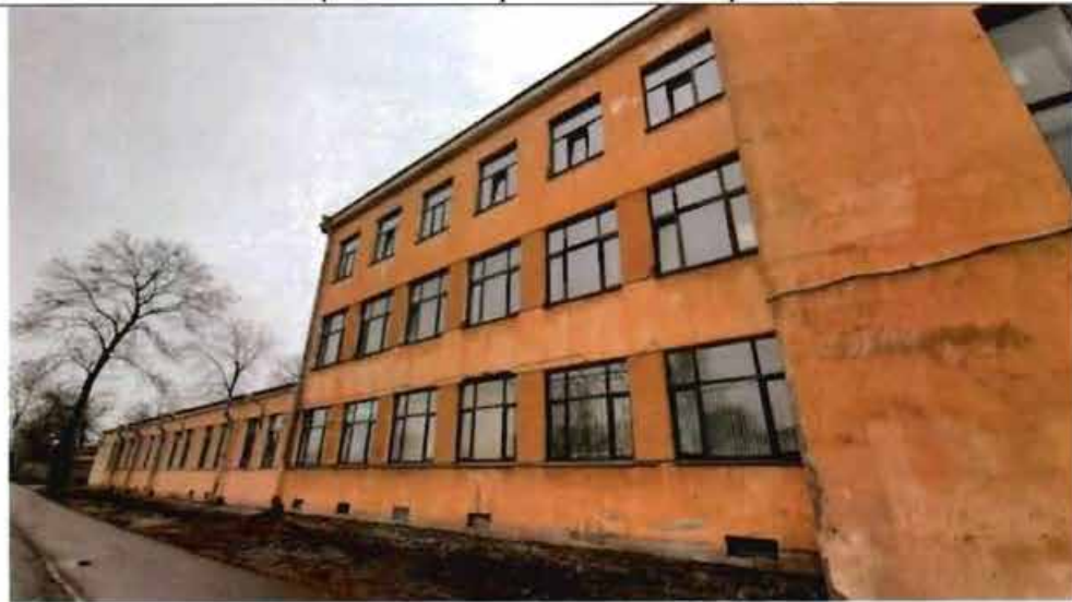
2. Фрагмент северо-восточного фасада
