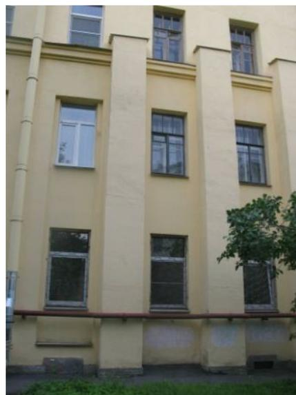
угловые пилястры в месте соединения двух корпусов (с северной стороны)– на всю высоту фасада, разделенные междуэтажным карнизом;
