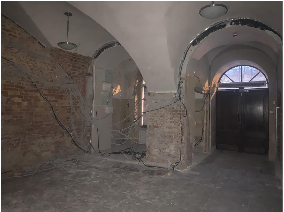
Фото 1. Помещение № 1. Вид на входную дверь.
