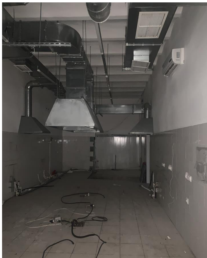
Фото 9. Помещение 11. Вид со стороны двери.
