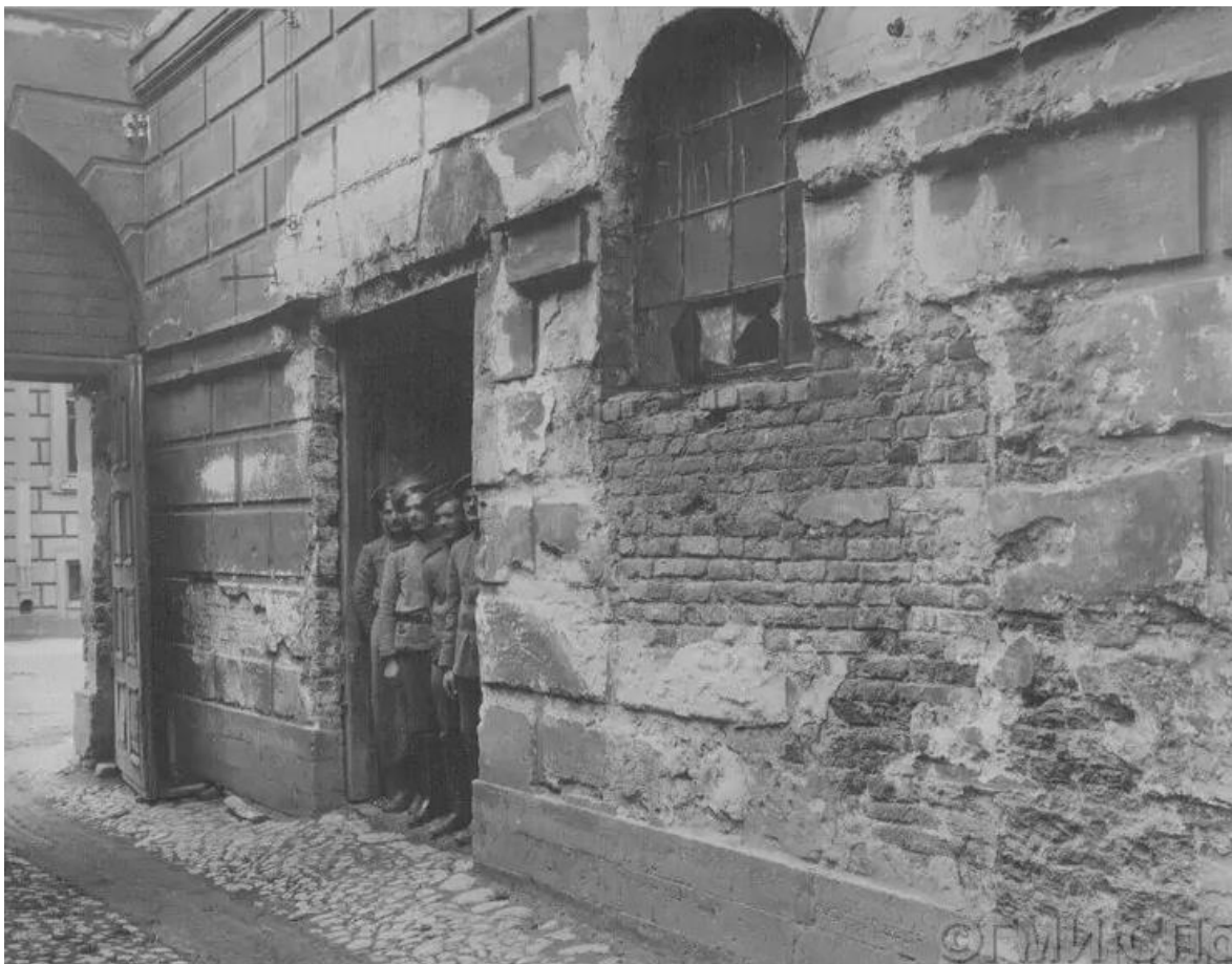
13. Фото Начало XX в. Казармы л.-гв. Конного полка. Корпус № 18 (вид со двора). ГМИ СПб 195831/4. Фото ателье К.Буллы.
