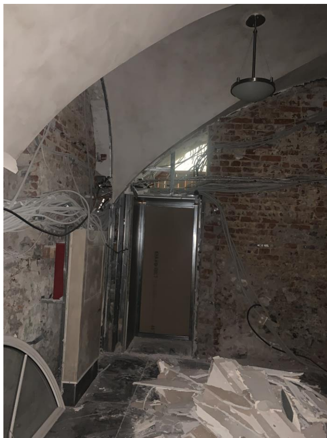
Фото 8. Помещение № 10. Вид на дверной проем в пом. № 1.
