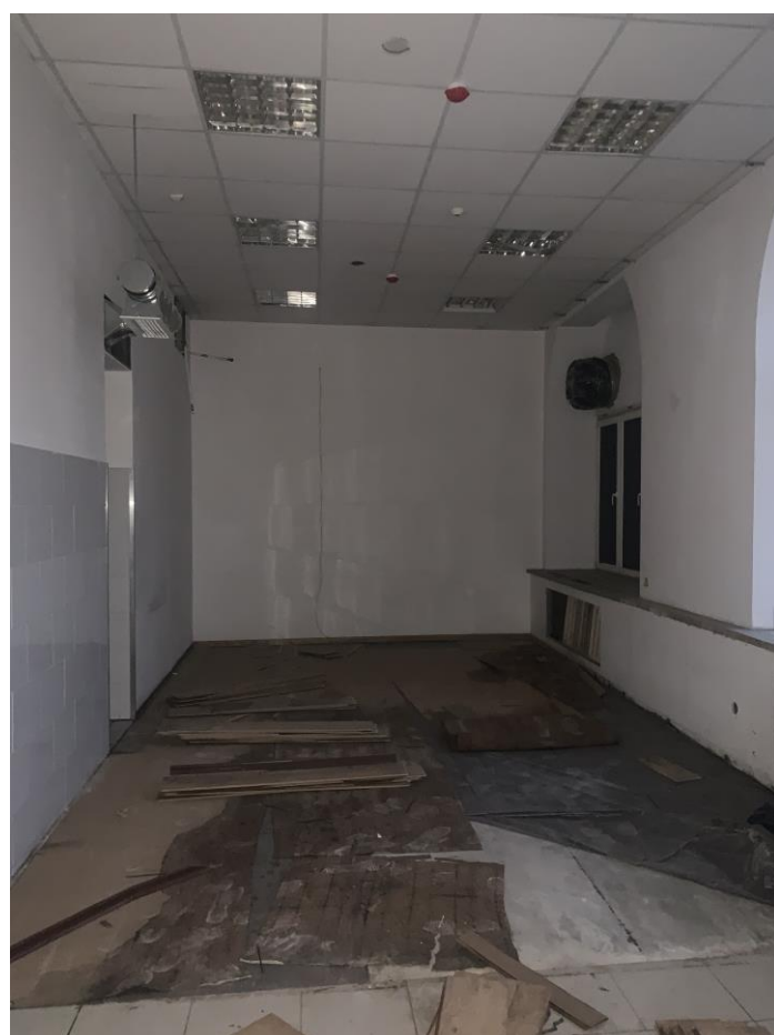
Фото 10. Помещение 12. Вид со стороны двери.
