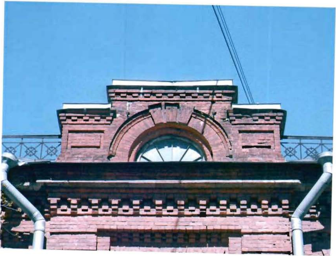
3. Фрагмент лицевого фасада (аттик)
