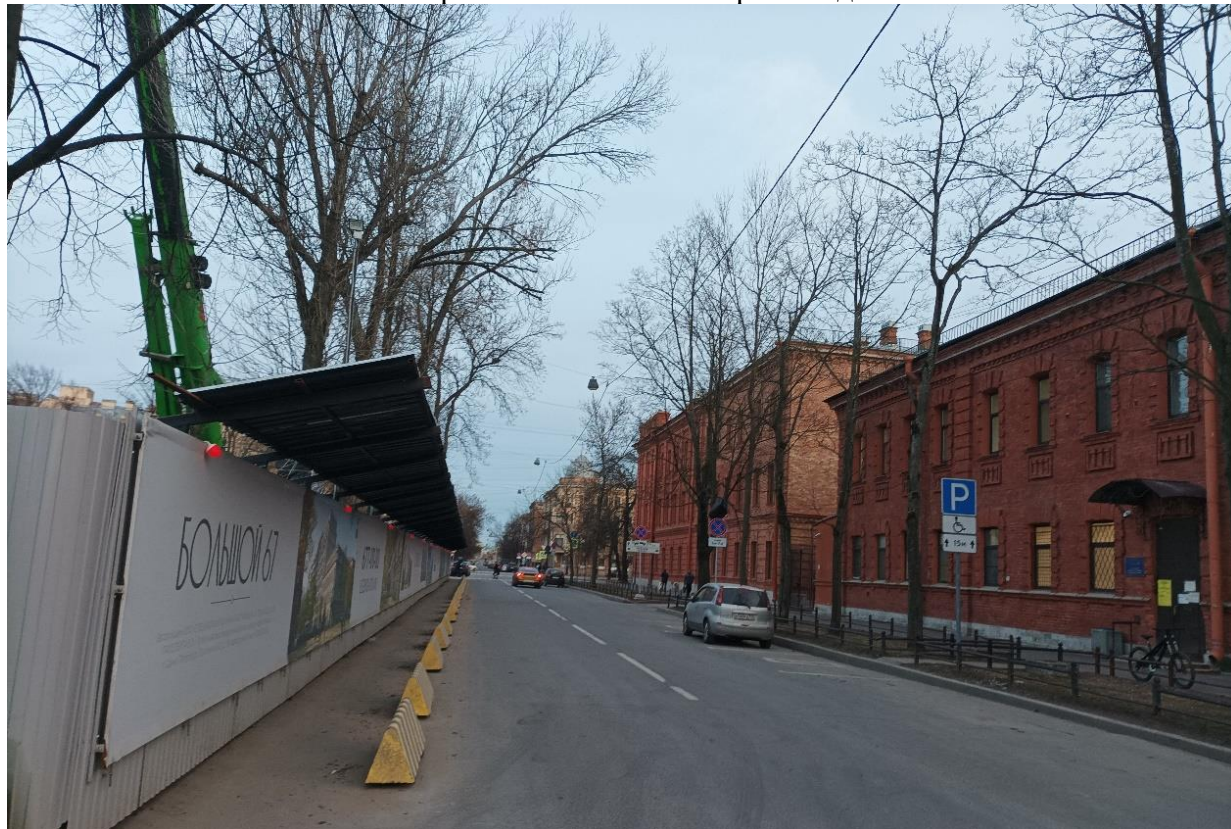
12. Вид на объект культурного наследия регионального значения «Арестантское отделение», 21-я линия В.О., дом 12, литера А. Направление съемки юго-восток.
