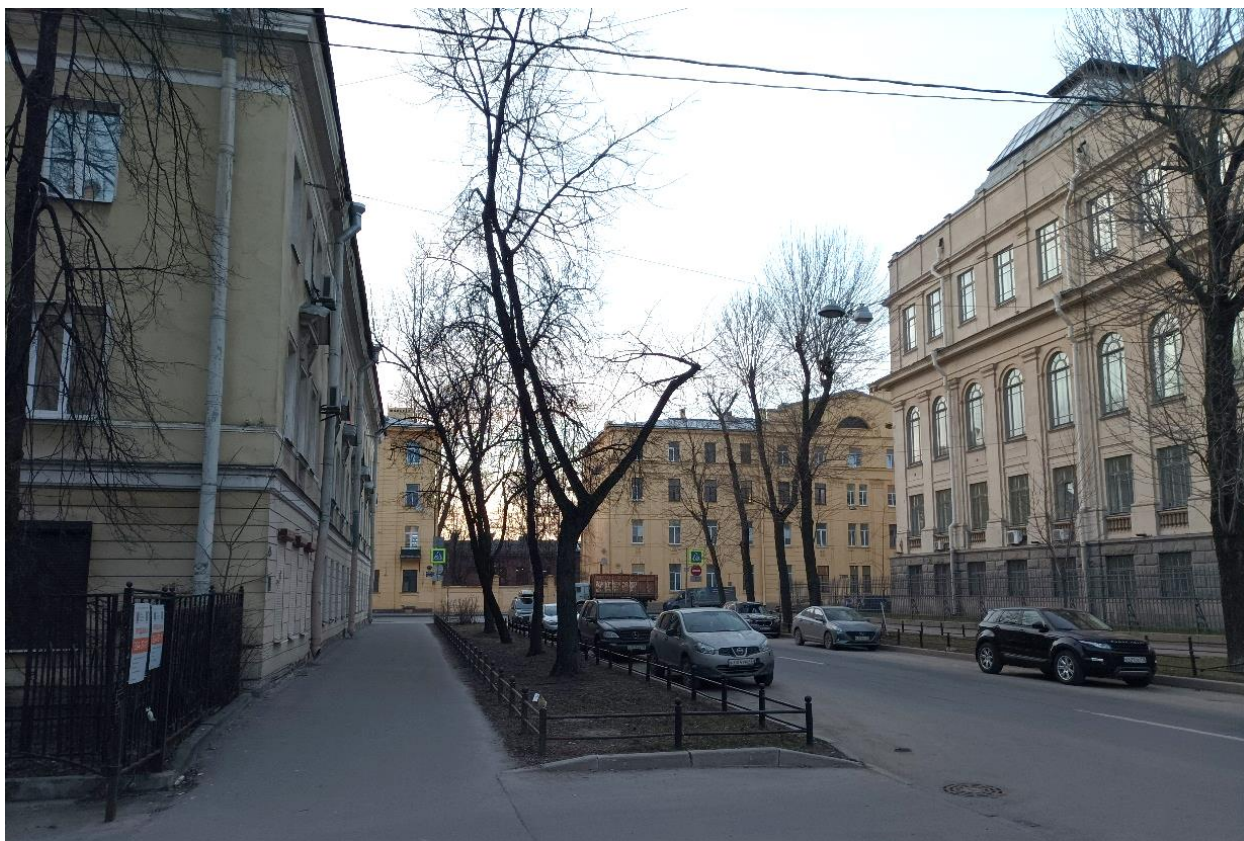
19. Общий вид 21-й линии В.О. Вид на выявленный объект культурного наследия «Здание Геологического комитета (с палисадником и оградой)». Направление съемки северо-запад.
