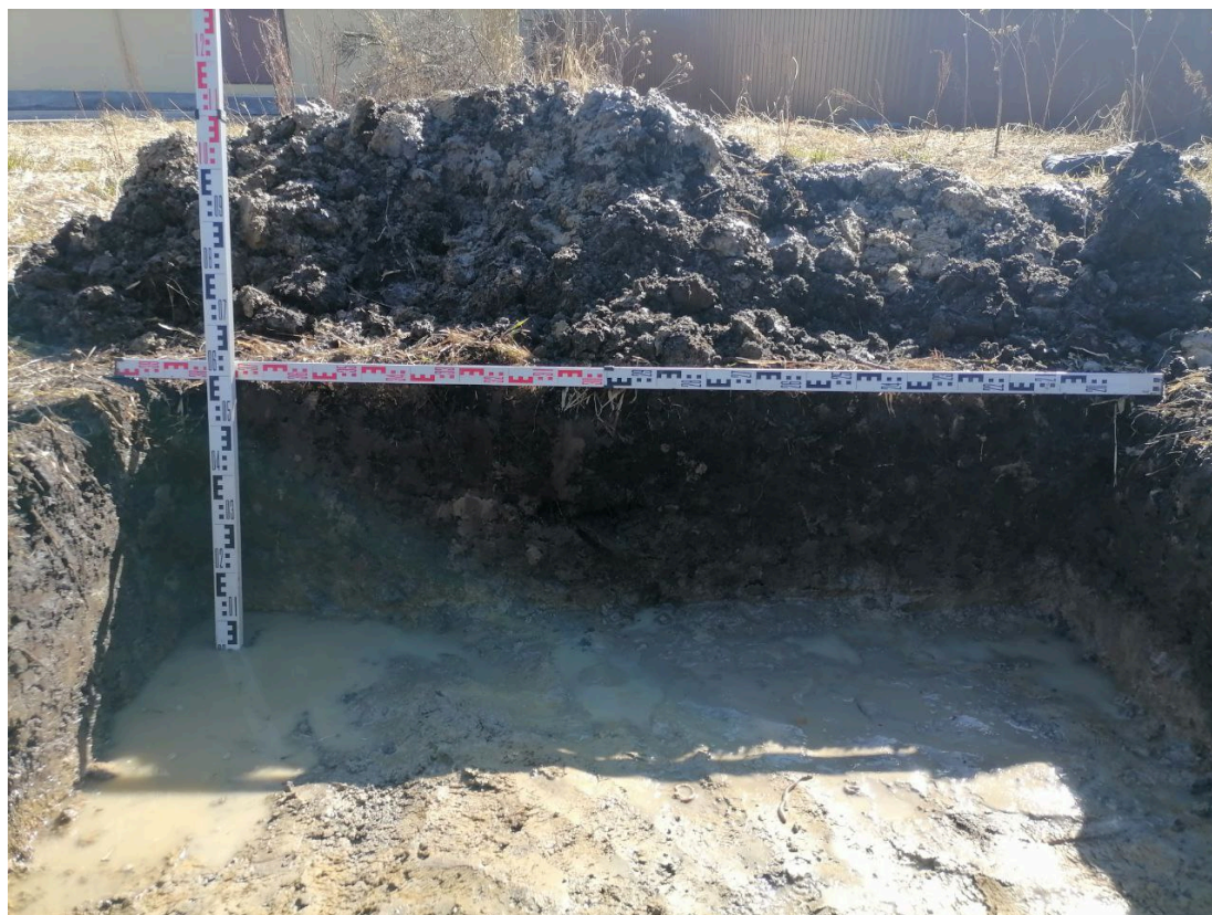
Рис. 25. Санкт-Петербург, Санкт-Петербургская Горветстанция» по адресу: Санкт-Петербург, пос. Володарский, ул. Володарского, д. 5, лит. А. Шурф 1. Восточная стенка.
