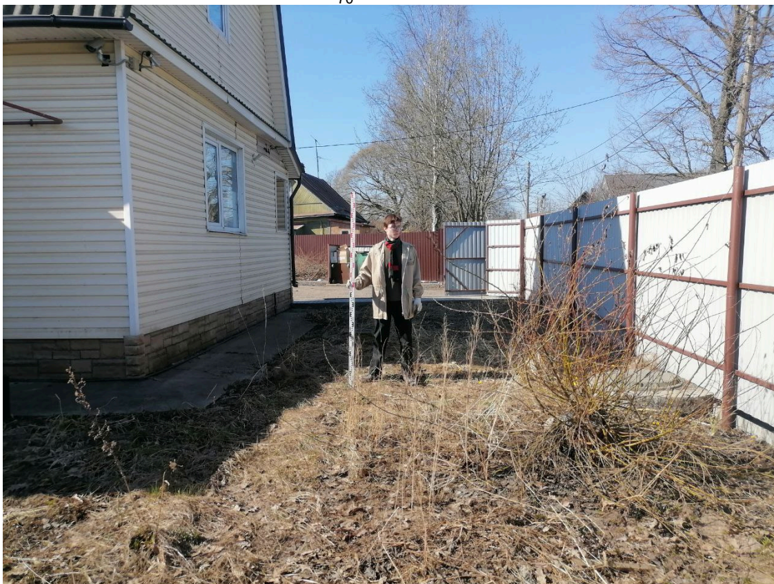
Рис. 13. Санкт-Петербург, Санкт-Петербургская Горветстанция» по адресу: Санкт-Петербург, пос. Володарский, ул. Володарского, д. 5, лит. А. Точка фотофиксации 5, вид на запад.
