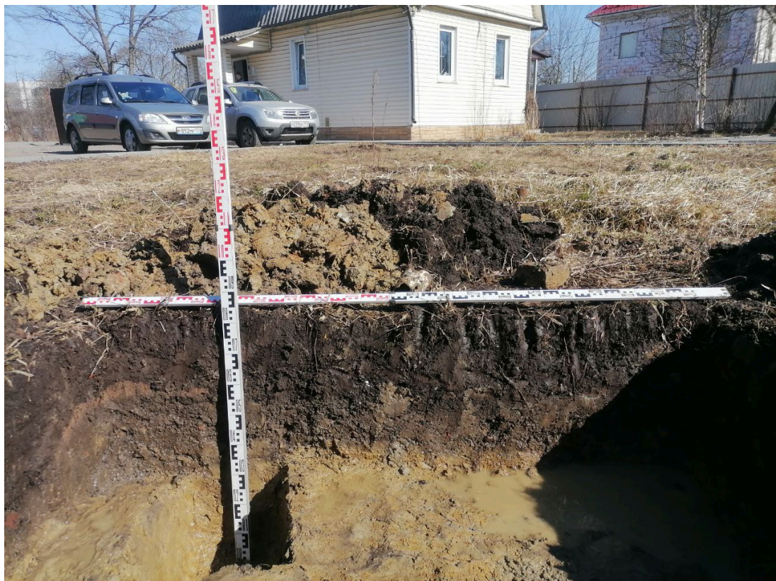
Рис. 23. Санкт-Петербург, Санкт-Петербургская Горветстанция» по адресу: Санкт-Петербург, пос. Володарский, ул. Володарского, д. 5, лит. А. Шурф 1. Северная стенка.
