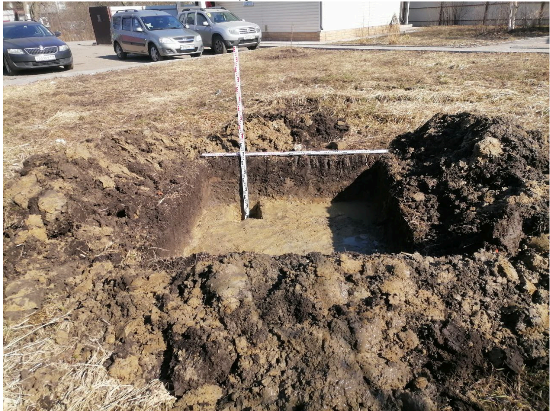
Рис. 22. Санкт-Петербург, Санкт-Петербургская Горветстанция» по адресу: Санкт-Петербург, пос. Володарский, ул. Володарского, д. 5, лит. А. Шурф 1. Фиксация по матерiku, вид на север.
