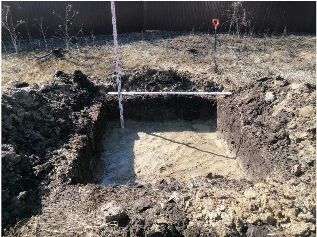
Рис. 26. Санкт-Петербург, Санкт-Петербургская Горветстанция» по адресу: Санкт-Петербург, пос. Володарский, ул. Володарского, д. 5, лит. А. Шурф 1. Фиксация по материку, вид на юг.
