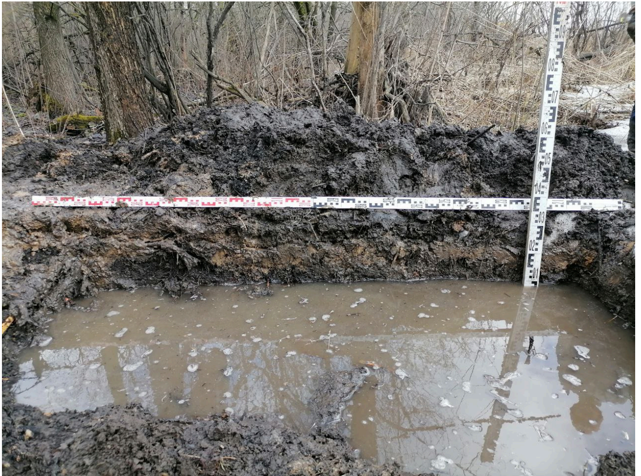
Рис. 28. Санкт-Петербург, Колпинское шоссе, Реконструкция Колпинского шоссе на участке от автодороги М- 10 «Россия» до Софийской ул. Шурф 1. Восточная стенка.
