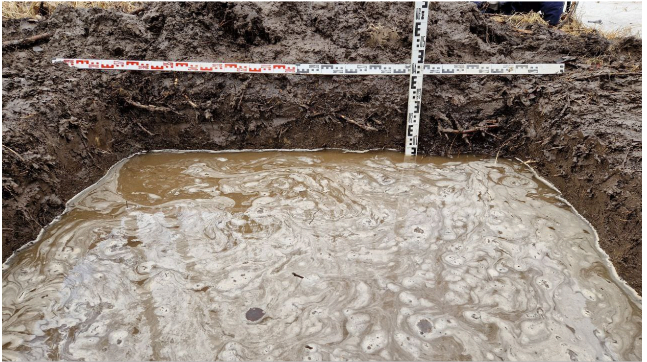
Рис. 44. Санкт-Петербург, Колпинское шоссе, Реконструкция Колпинского шоссе на участке от автодороги М- 10 «Россия» до Софийской ул. Шурф 2. Фиксация по уровню грунтовых вод. Западная стенка.
