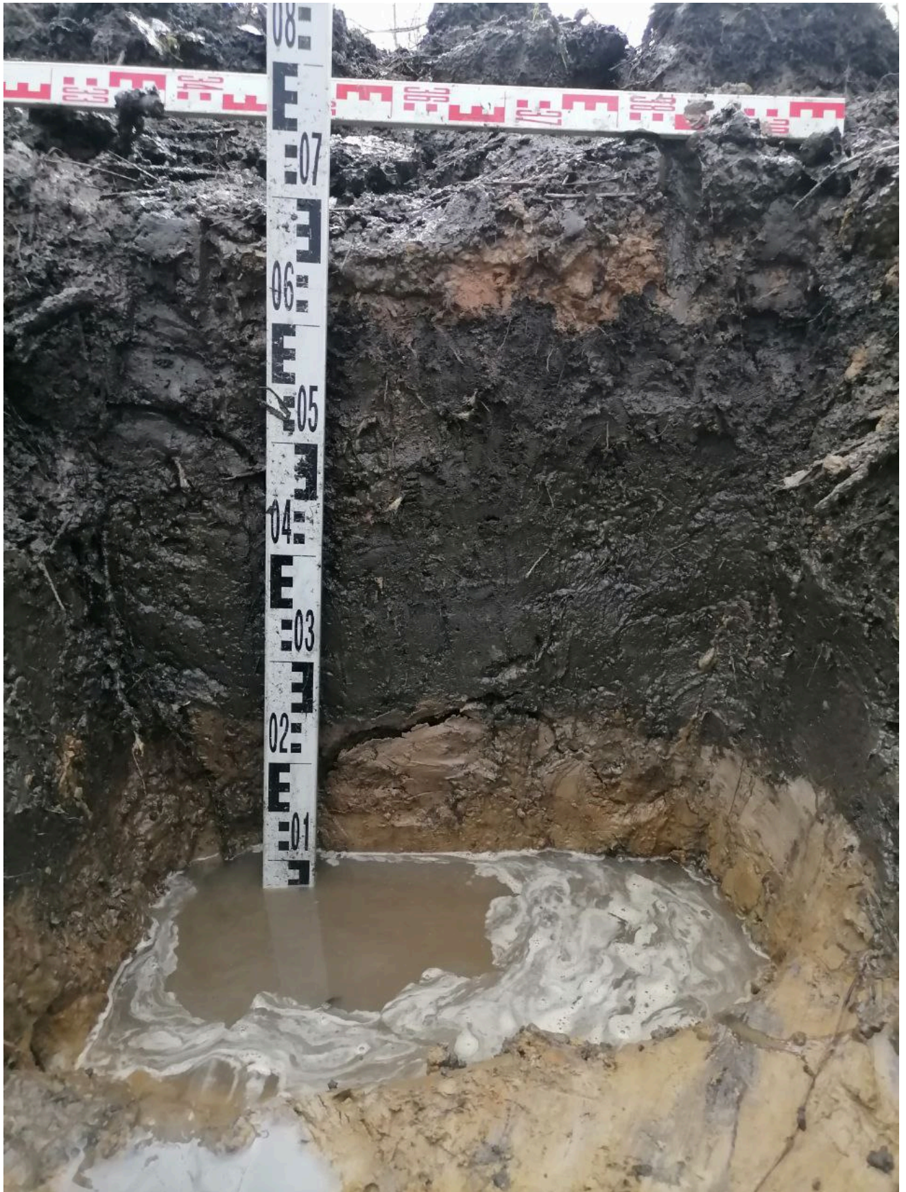
Рис. 29. Санкт-Петербург, Колпинское шоссе, Реконструкция Колпинского шоссе на участке от автодороги М- 10 «Россия» до Софийской ул. Шурф 1. Фото контрольного прокопа у южной стенки.
