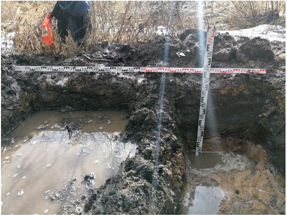
Рис. 26. Санкт-Петербург, Колпинское шоссе, Реконструкция Колпинского шоссе на участке от автодороги М- 10 «Россия» до Софийской ул. Шурф 1. Южная стенка.
