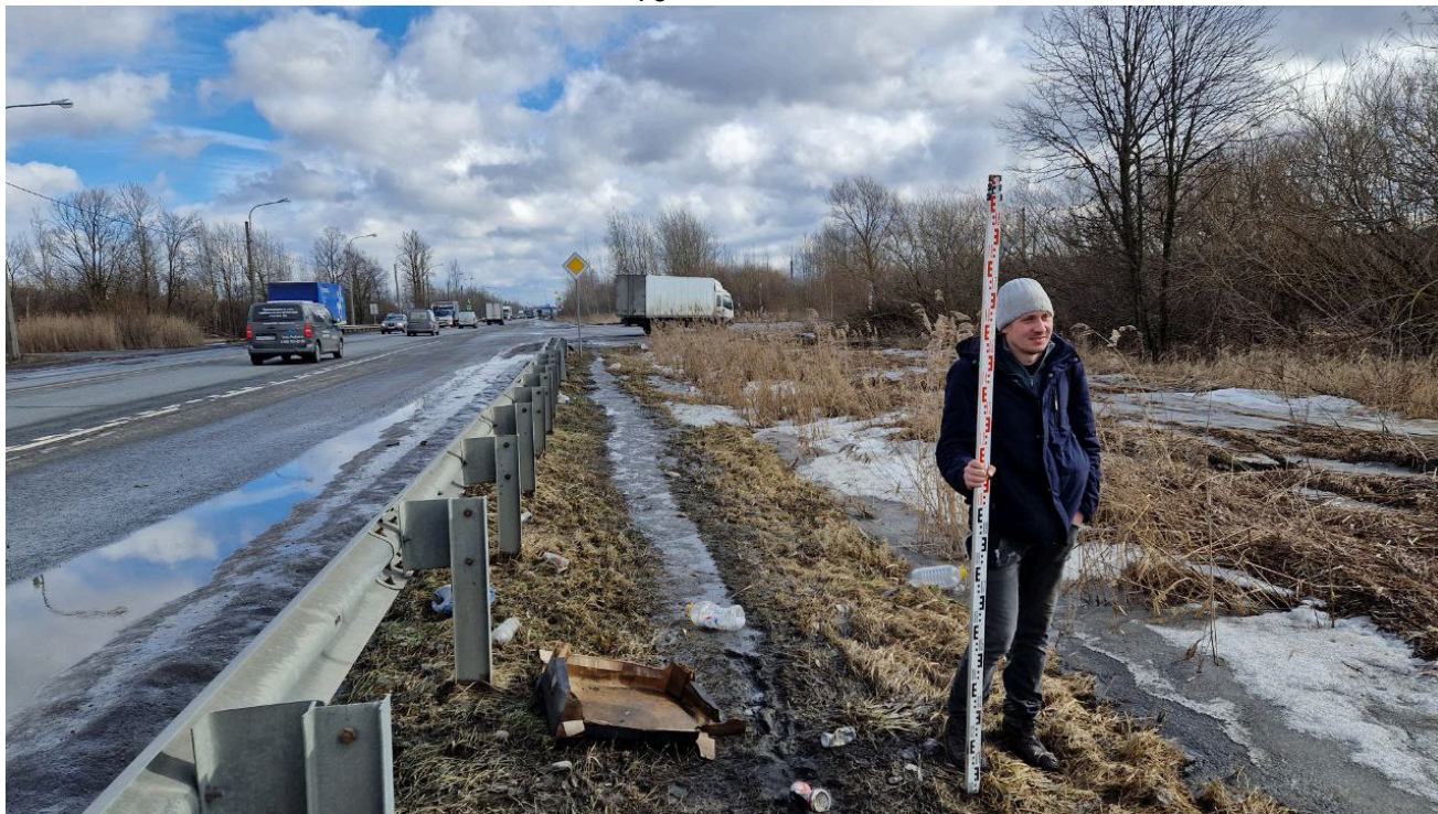
Рис. 17. Санкт-Петербург, Колпинское шоссе, Реконструкция Колпинского шоссе на участке от автодороги М- 10 «Россия» до Софийской ул. Точка фотофиксации 10, вид на восток
