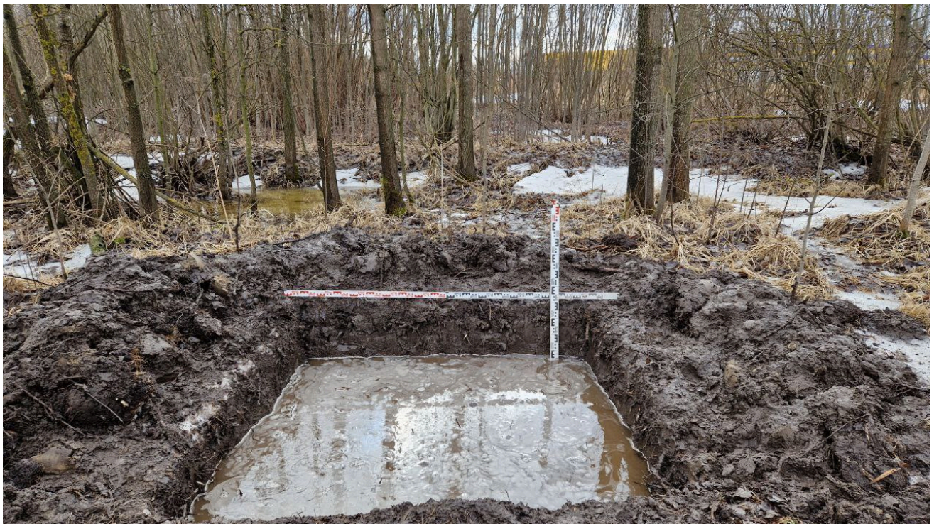
Рис. 41. Санкт-Петербург, Колпинское шоссе, Реконструкция Колпинского шоссе на участке от автодороги М- 10 «Россия» до Софийской ул. Шурф 2. Фиксация по уровню грунтовых вод. Вид на север.
