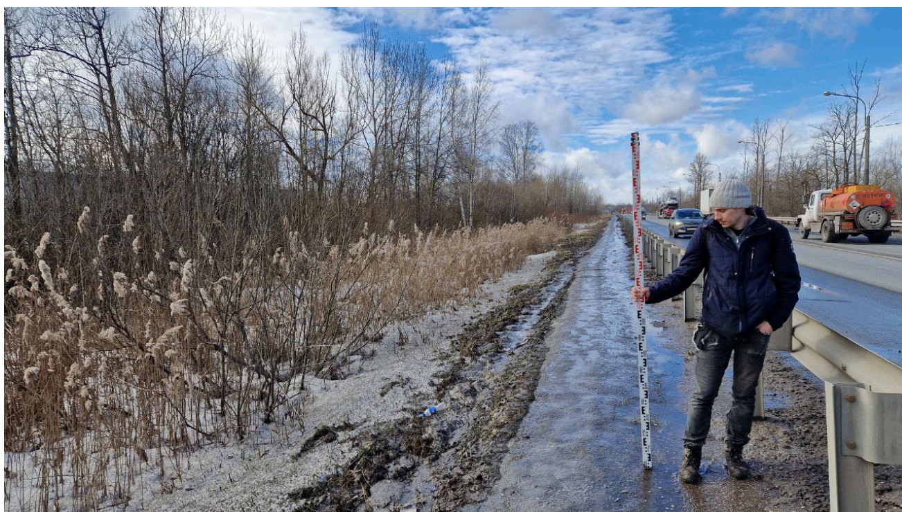
Рис. 16. Санкт-Петербург, Колпинское шоссе, Реконструкция Колпинского шоссе на участке от автодороги М- 10 «Россия» до Софийской ул. Точка фотофиксации 9, вид на запад
