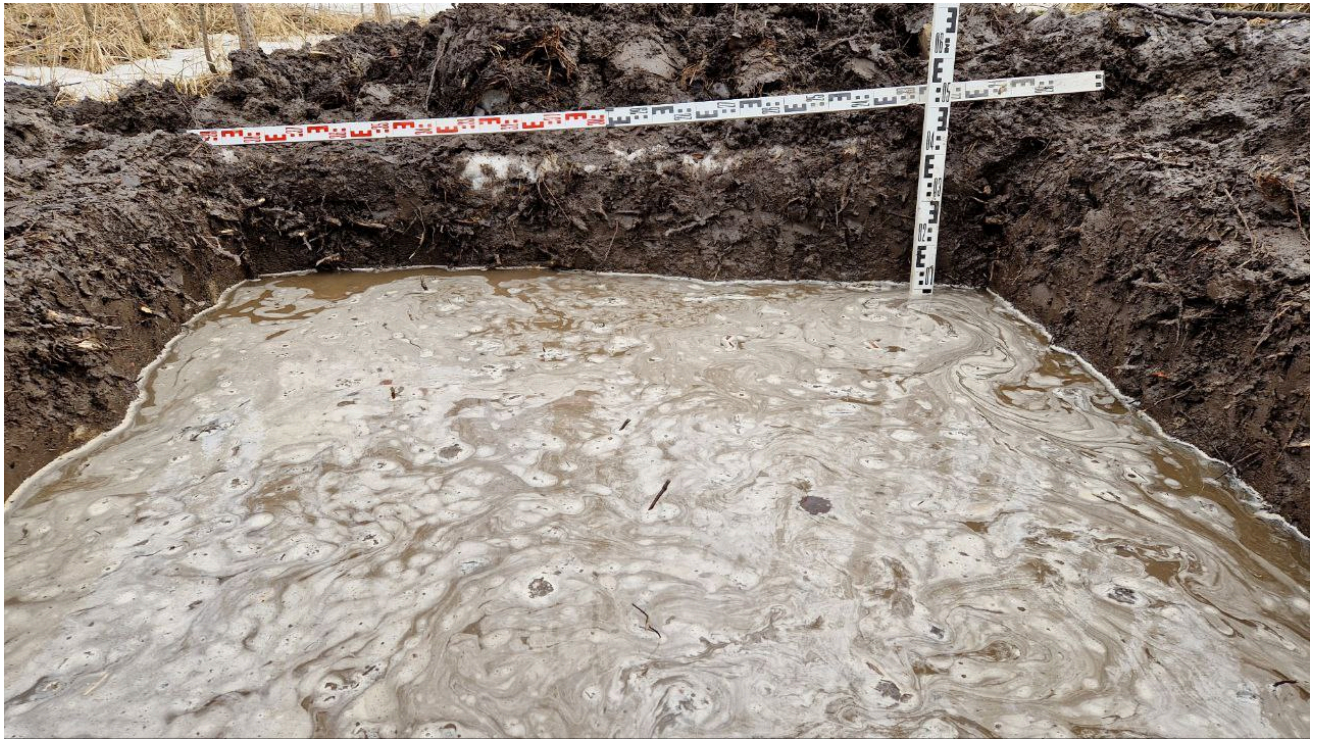
Рис. 40. Санкт-Петербург, Колпинское шоссе, Реконструкция Колпинского шоссе на участке от автодороги М- 10 «Россия» до Софийской ул. Шурф 2. Фиксация по уровню грунтовых вод. Восточная стенка.
