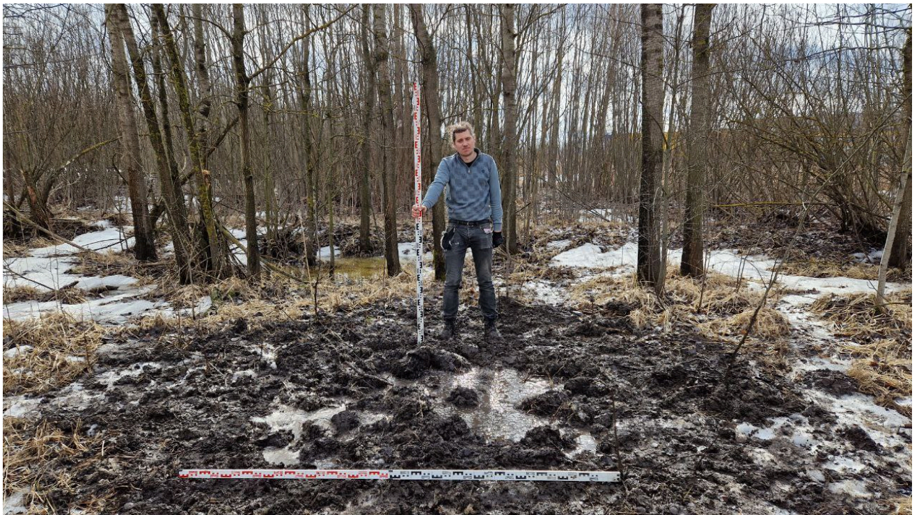
Рис. 45. Санкт-Петербург, Колпинское шоссе, Реконструкция Колпинского шоссе на участке от автодороги М- 10 «Россия» до Софийской ул. Шурф 2. Фото после рекультивации шурфа, вид на юг.
