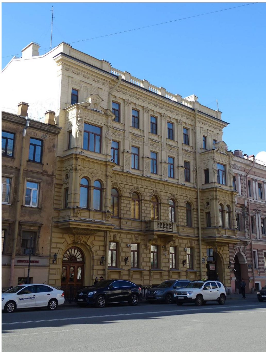
Фото 01. Объект культурного наследия регионального значения «Дом Тузова И.Л.». Лицевой фасад. Съемка 03.04.2023 г. Трушковский В.Э.
