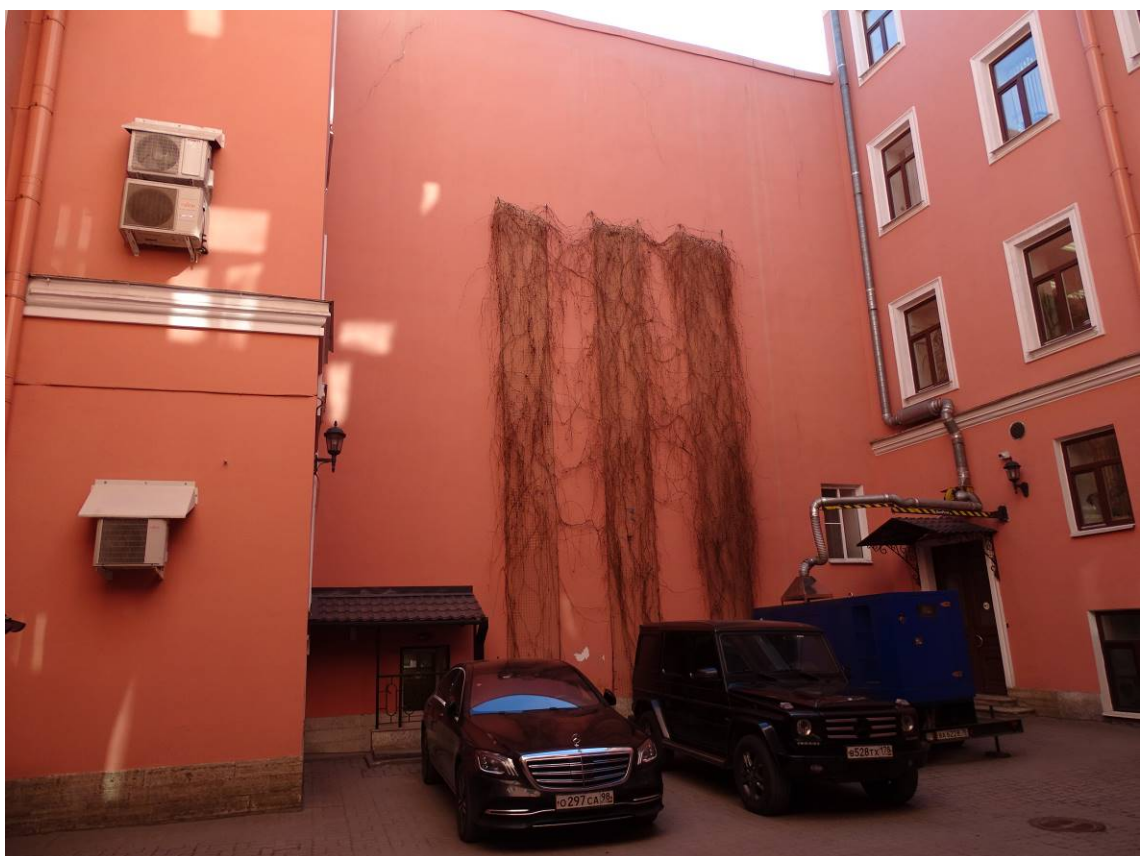
Фото 09. Объект культурного наследия регионального значения «Дом Тузова И.Л.». Внутренний двор. Южная часть. Съемка 03.04.2023 г. Трушковский В.Э.
