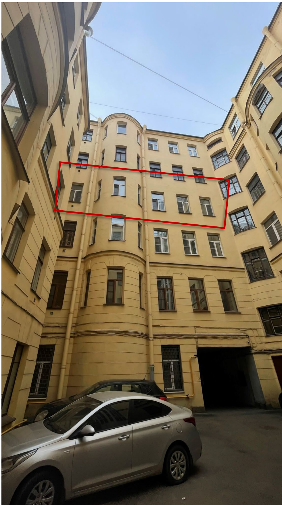
2. Вид на дворовой фасад здания и окна квартиры по адресу: г. Санкт-Петербург, ул. Союза Печатников, д. 10, литера. А;
