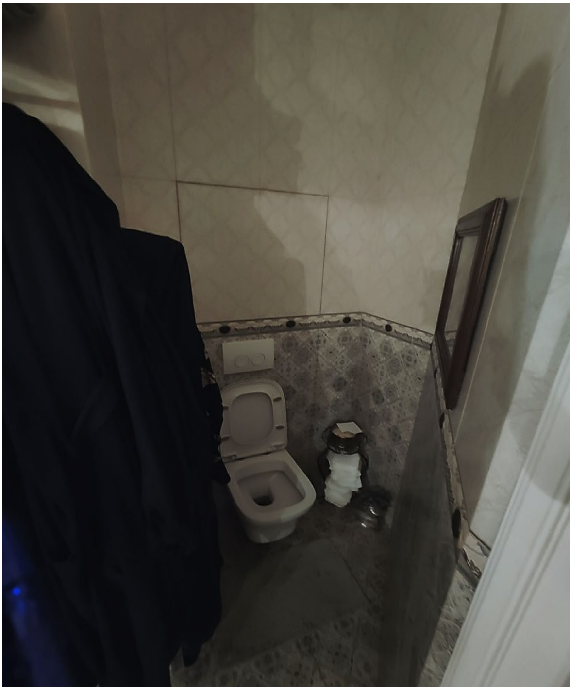
17. Фрагмент интерьера туалета (помещение 8/1.00).
