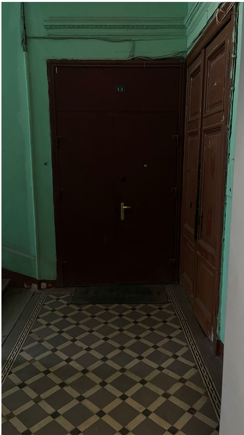
3. Вид на входную дверь в квартиру;
