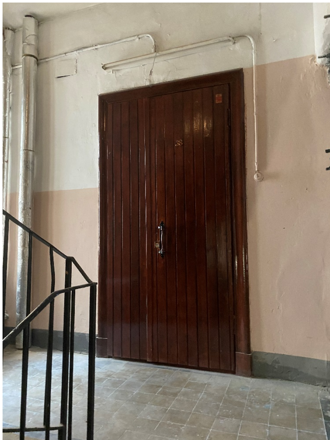
Фото 8. Вход в квартиру № 38 с общедомовой лестничной клетки. .
