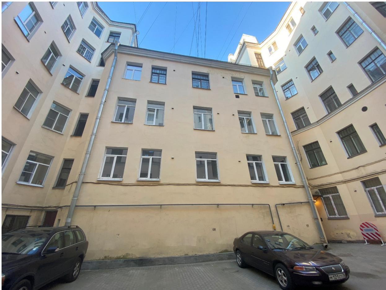
Фото 6. Юго-западный дворовый фасад.
