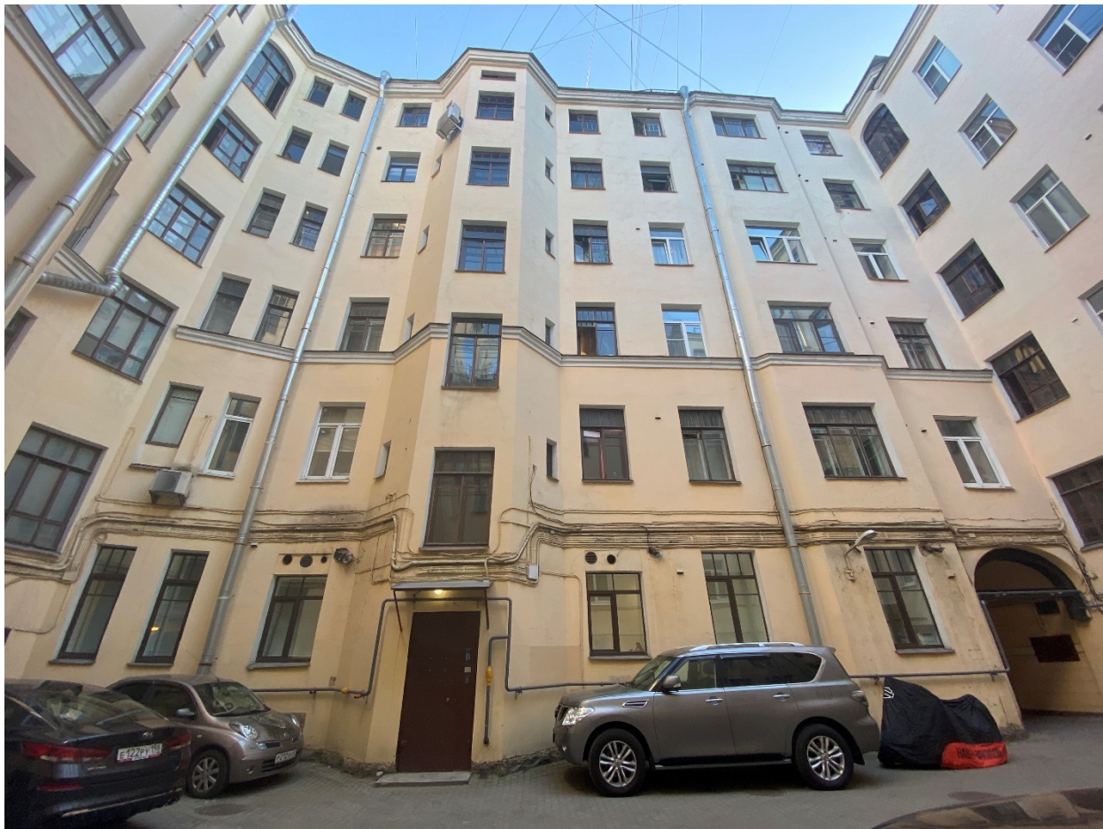
Фото 4. Северо-восточный дворовый фасад.
