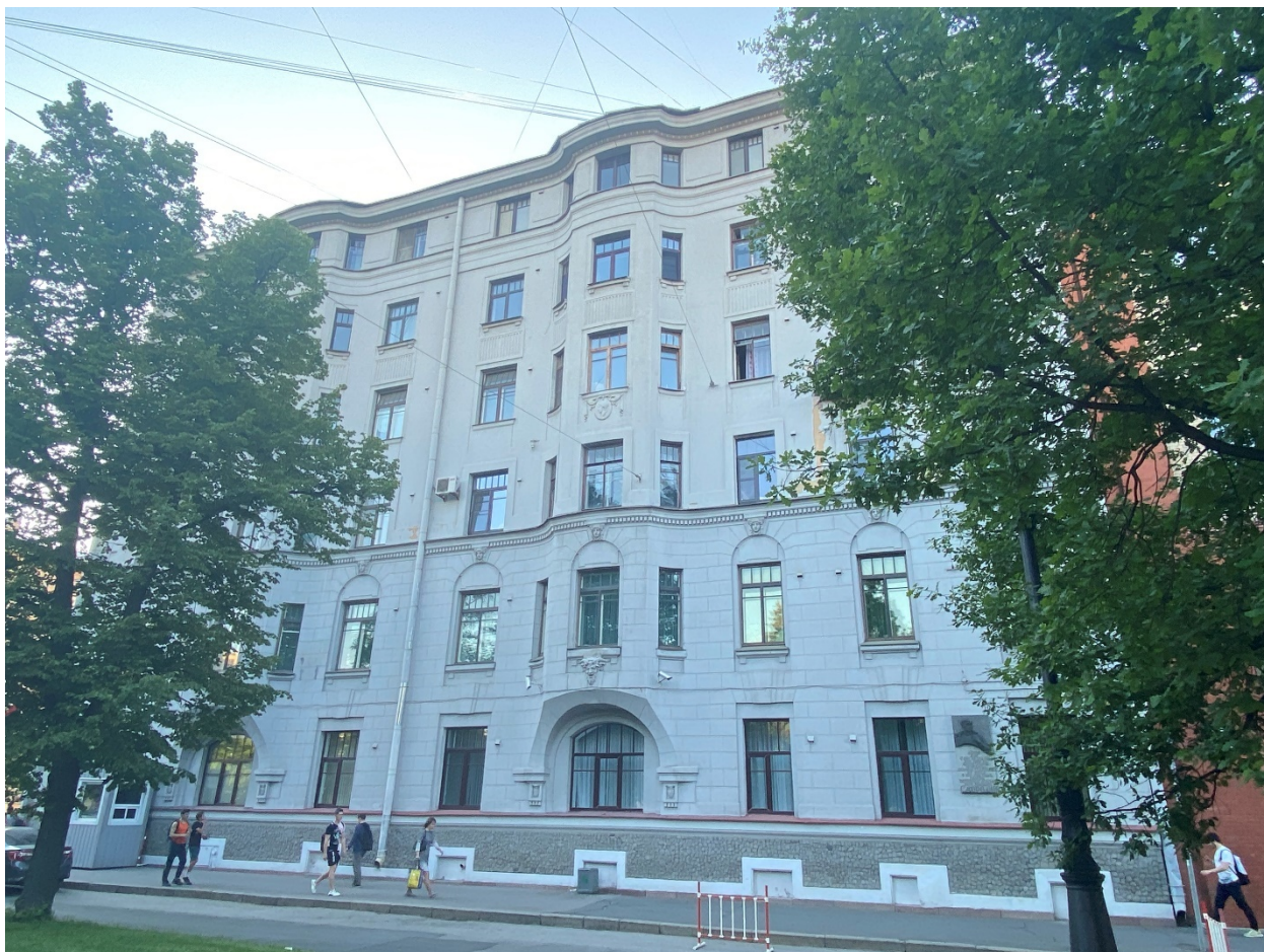
Фото 3. Юго-восточный лицевой фасад.
