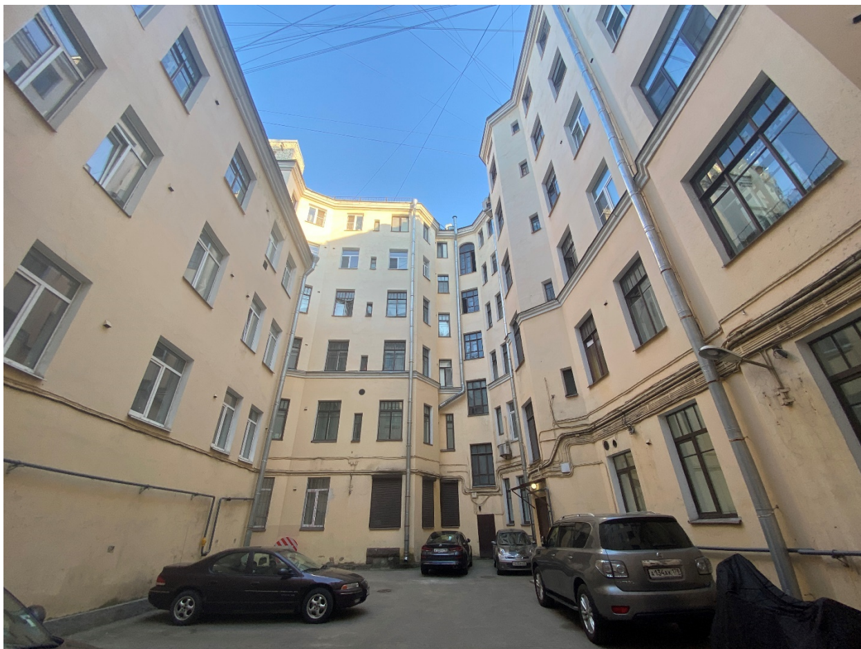
Фото 7. Северо-западный дворовый фасад.
