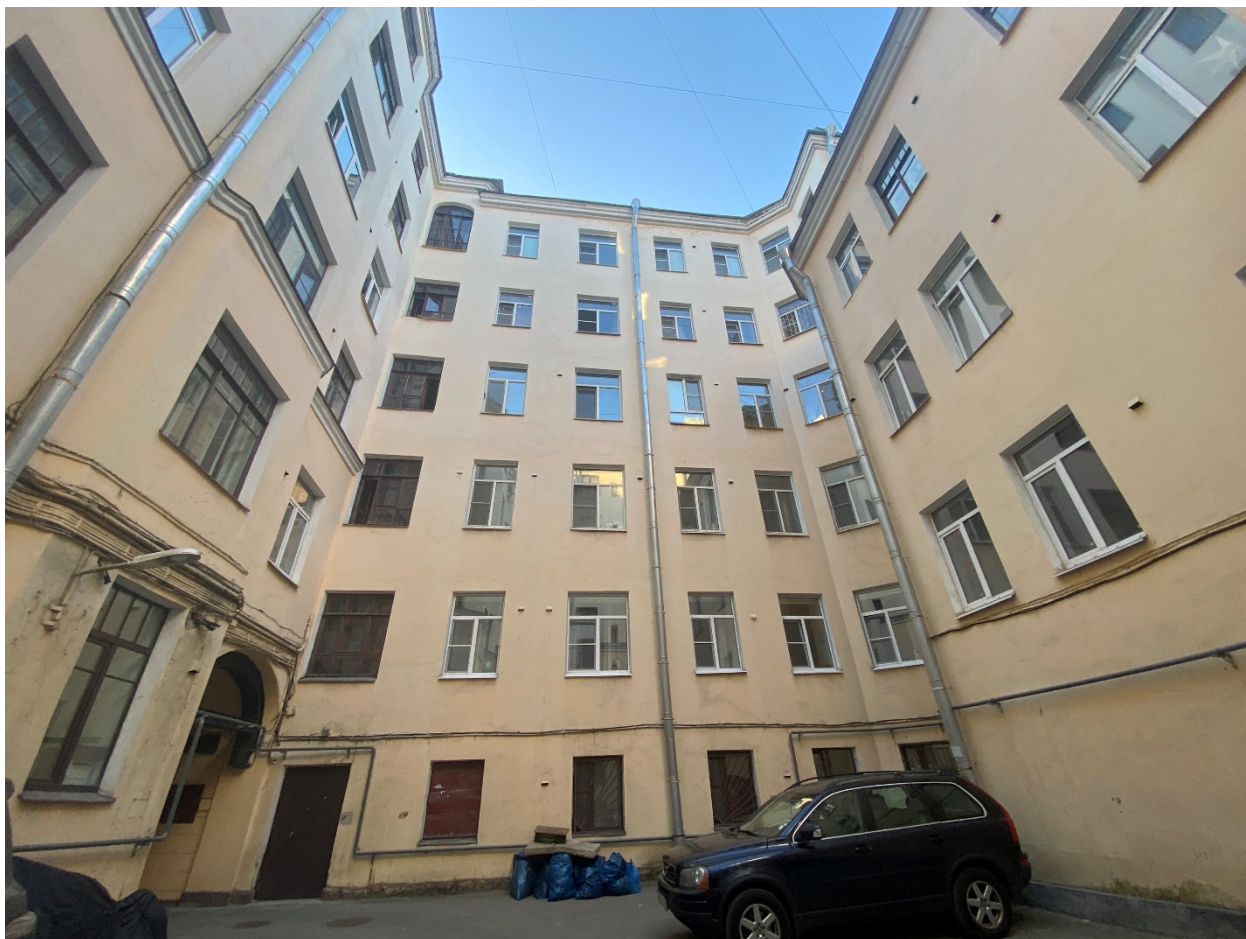
Фото 5. Юго-восточный дворовый фасад.
