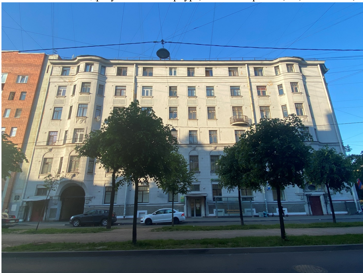
Фото 2. Юго-западный лицевой фасад.
