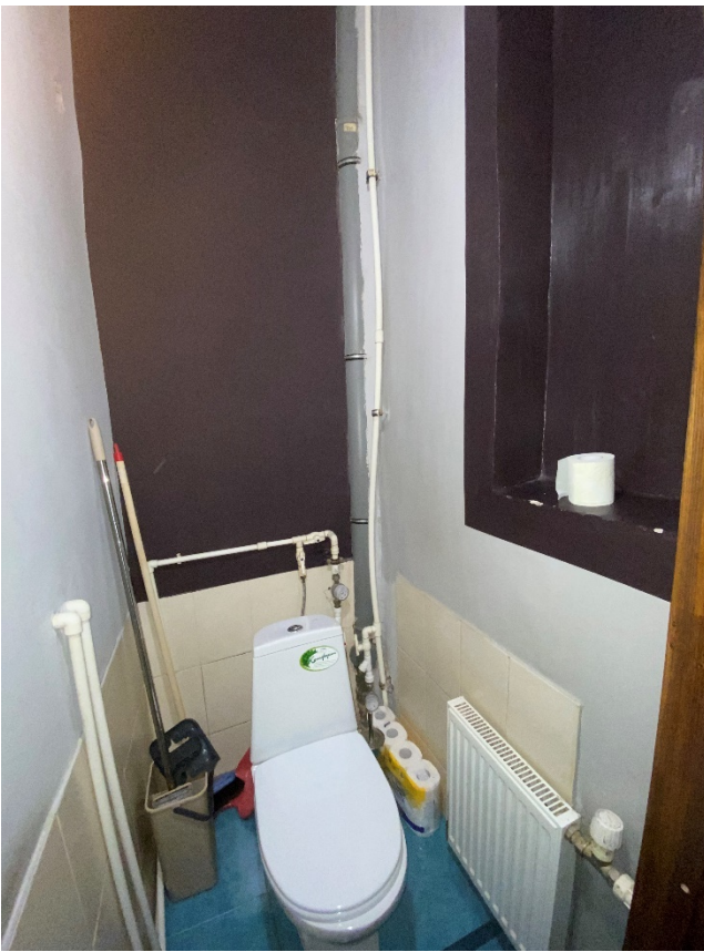
Фото 22. Помещение № 7. Туалет. Вид с юго-востока.
