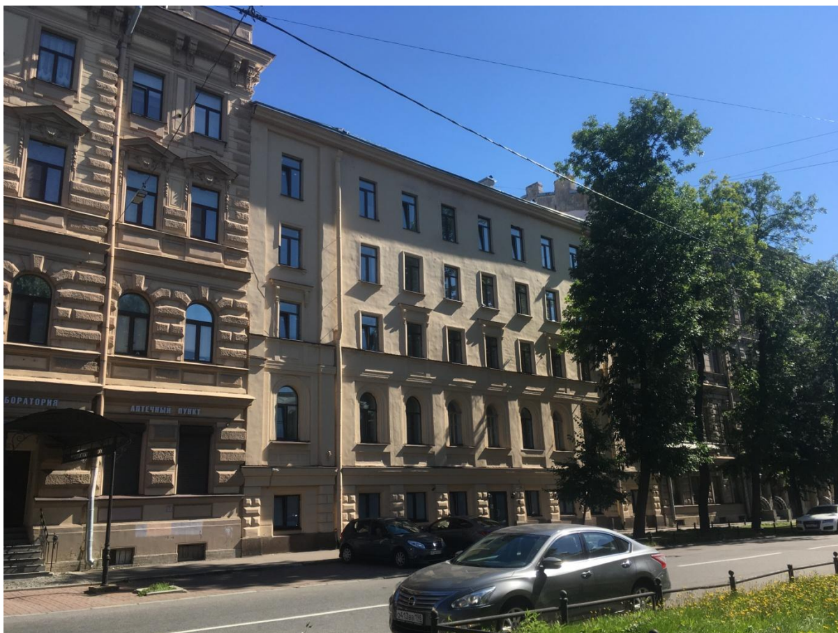
1. Лицевой фасад выявленного объекта культурного наследия «Дом Н.Д. Быкова (В.Н. фон Дервиз)»
