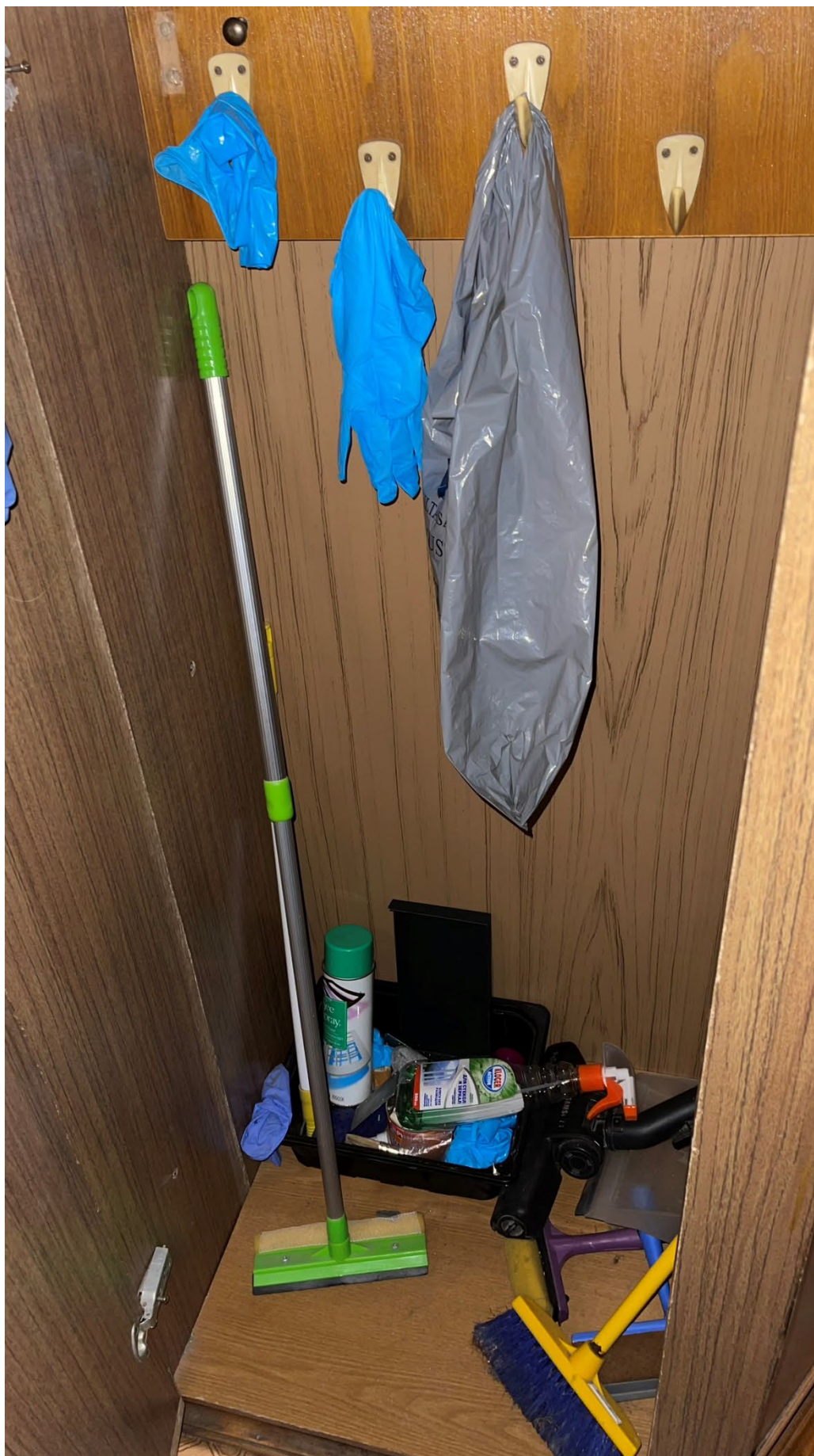
11. Фрагмент встроенного шкафа (помещение 9/0.30);
