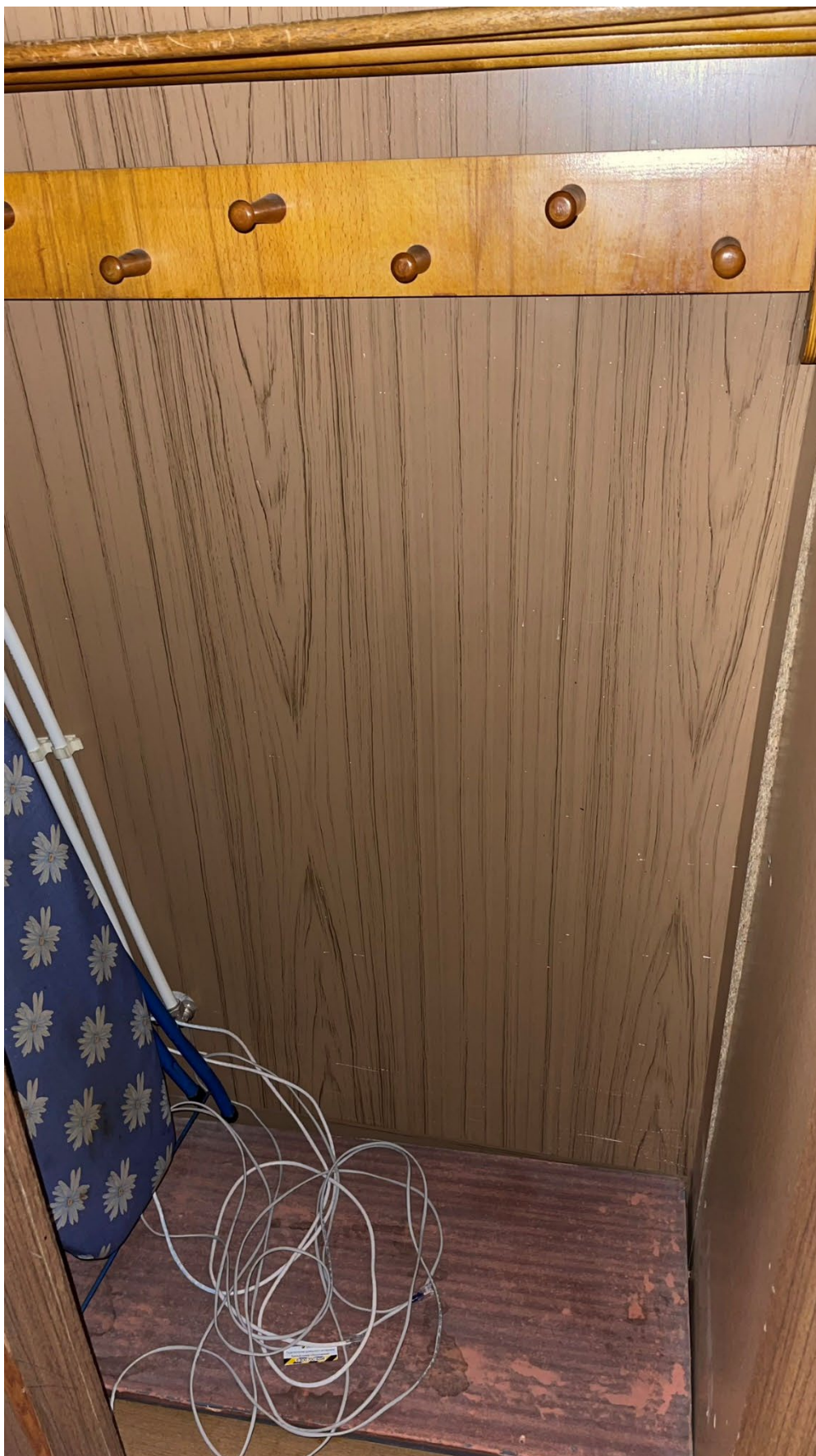
10. Фрагмент встроенного шкафа (помещение 9/0.40);
