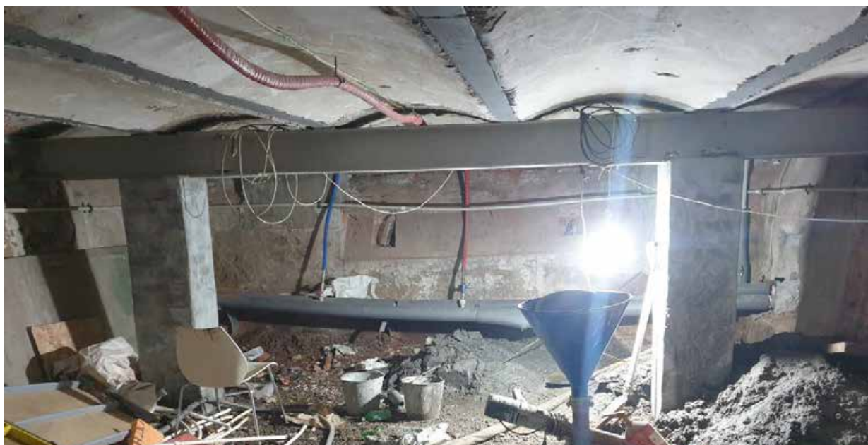
Фото 9 – Помещение подвала в осях А/11-12
