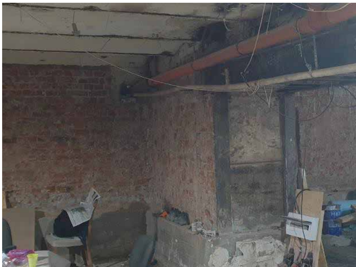
Фото 6 – Помещение подвала в осях А-В/10-11
