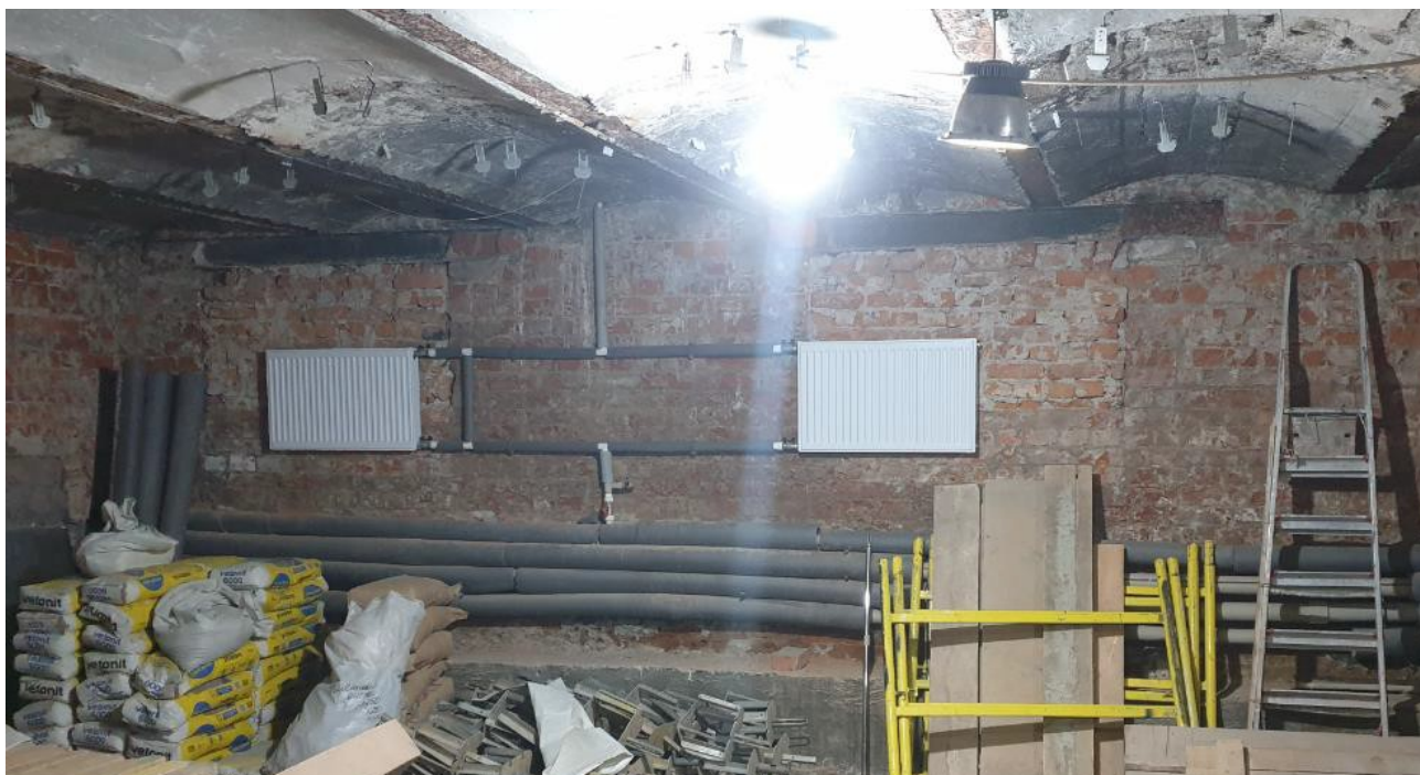
Фото 13 – Помещение подвала в осях Г/10-11
