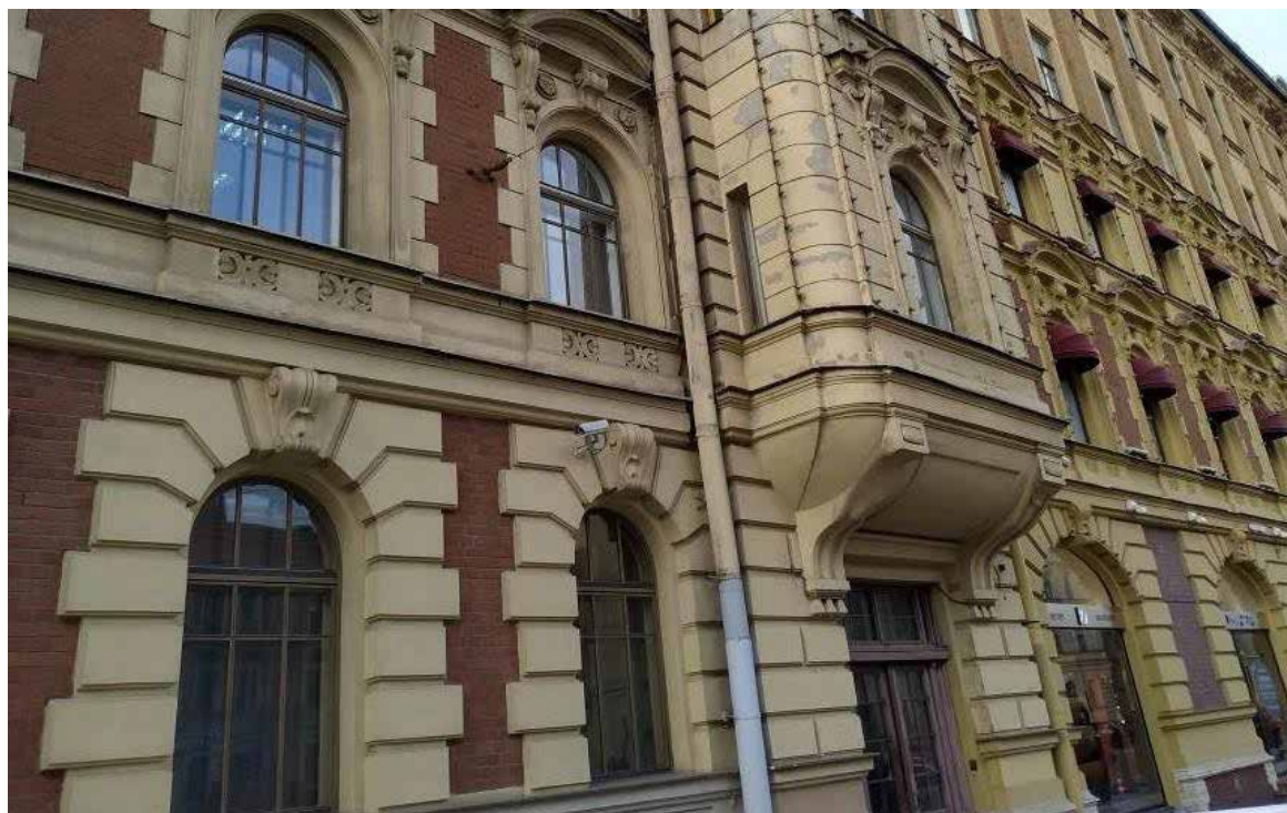
Фото 1 – Лицевой фасад здания в осях «Б/2-13». Вид со стороны Невского проспекта
