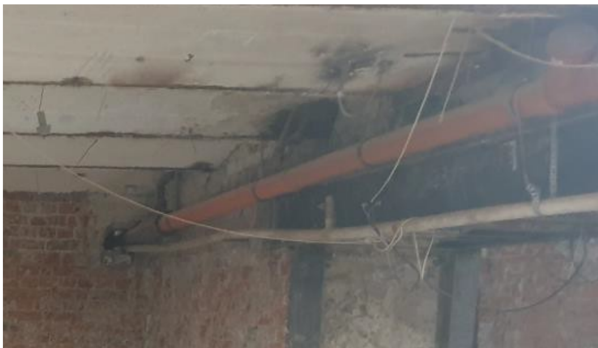
Фото 16 – Стена, разделяющая помещения подвала в осях А-В/10-11, В-Г/10-11
