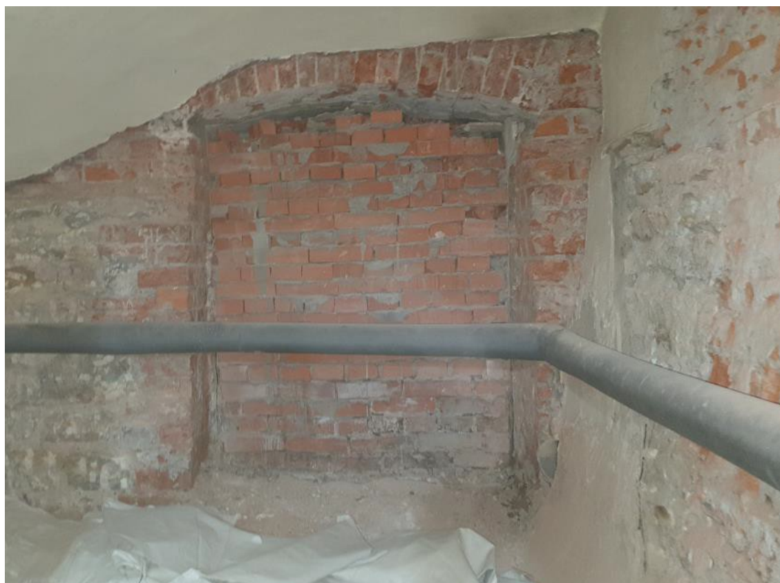
Фото 10 – Помещение подвала в осях Г/10-11
