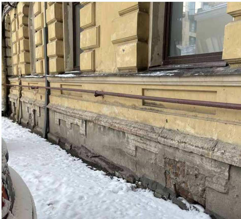
Фото 5 – Фрагмент дворового фасада здания
