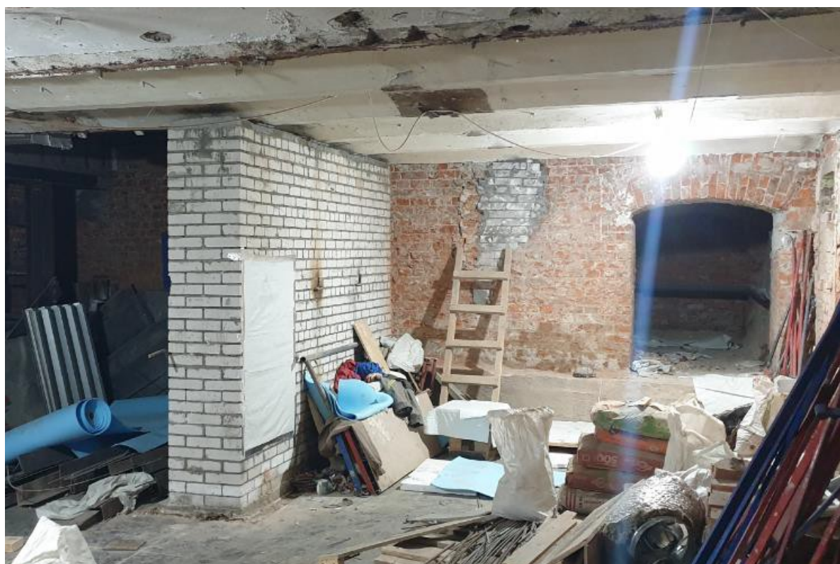
Фото 8 – Помещение подвала в осях А-В/10-11
