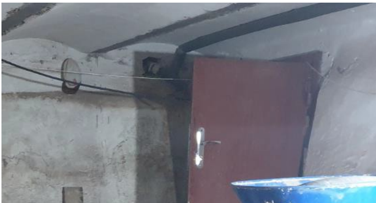
Фото 14 – Помещение подвала в осях А-В/12
