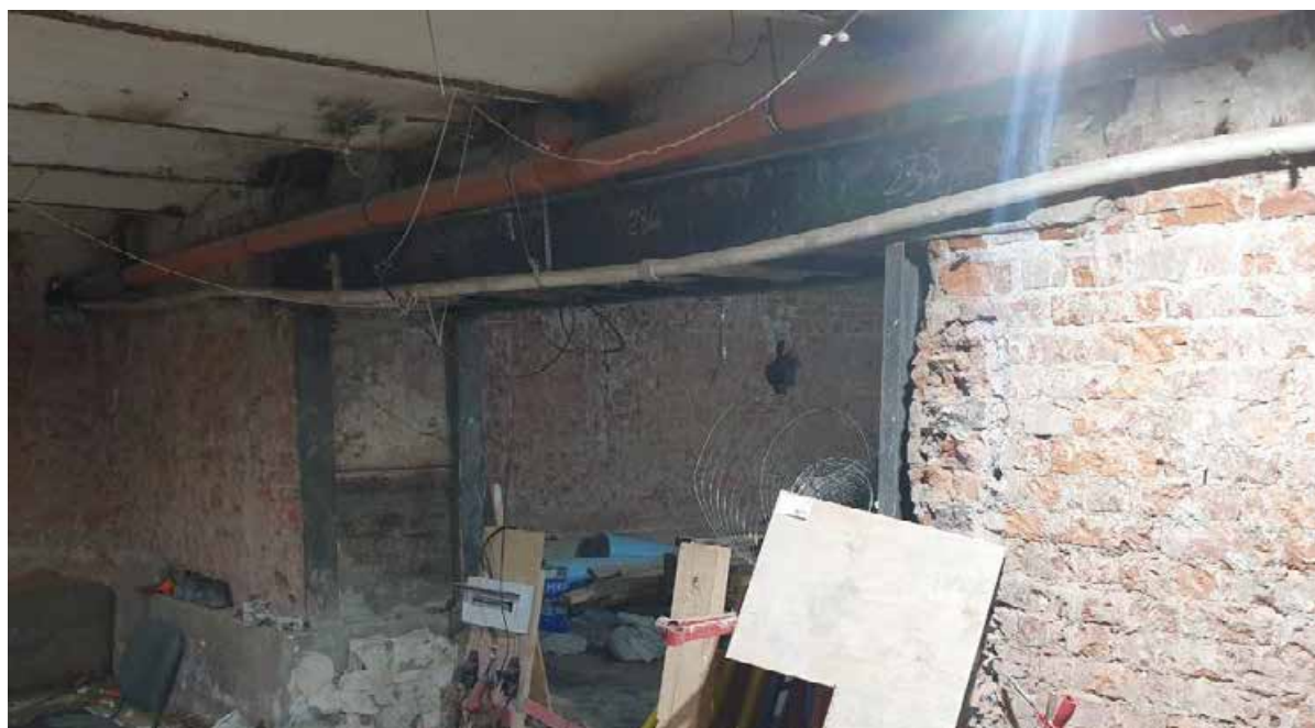
Фото 12 – Помещение подвала в осях В/10-11
