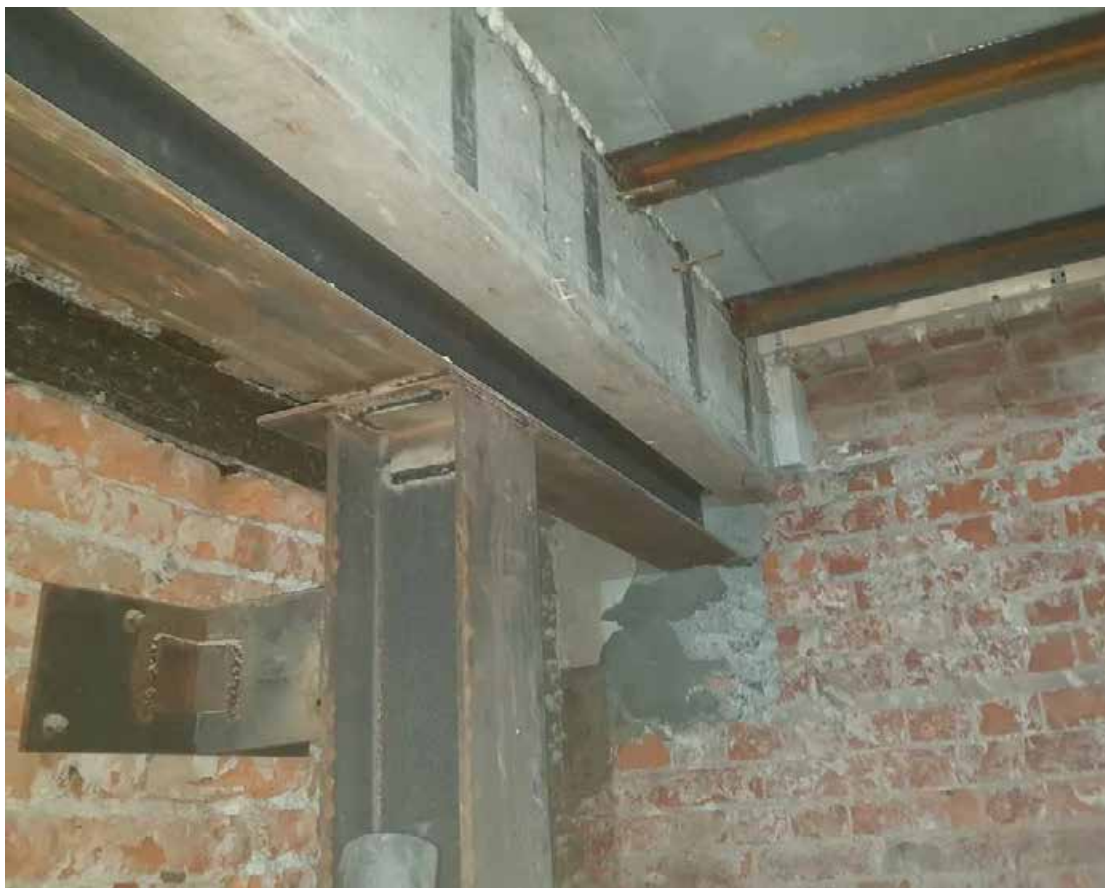
Фото 19 – Фрагмент колонны в помещении подвала в осях А-Б/10-11
