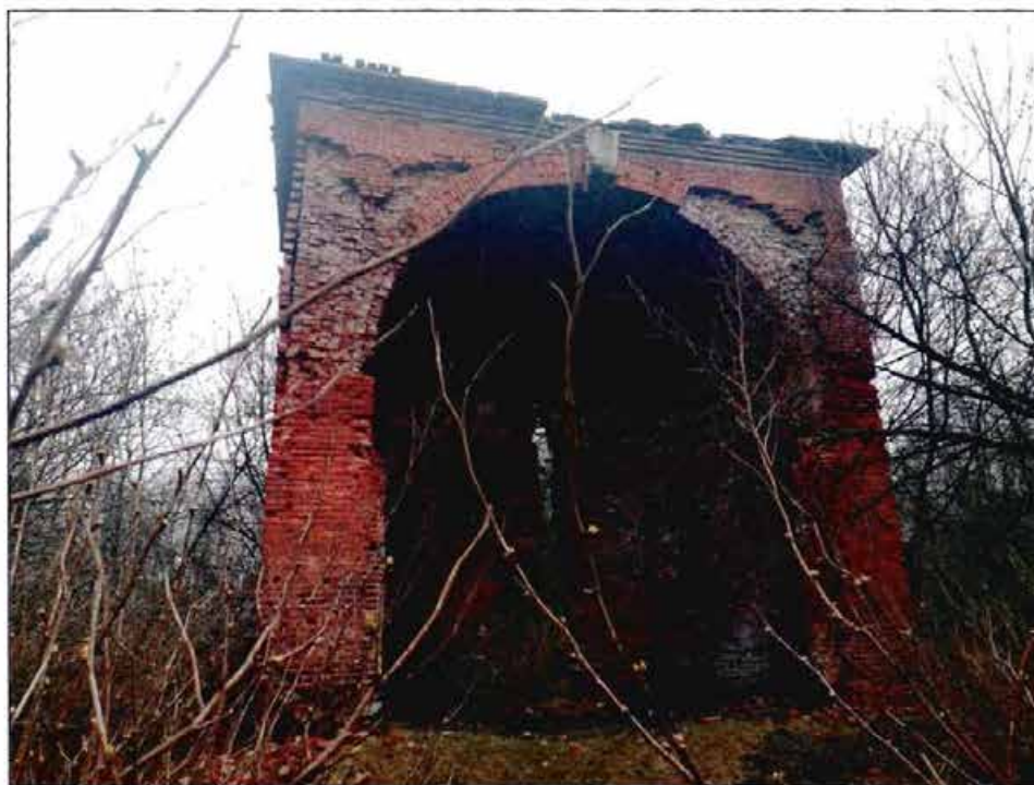
1.Общий вид на объект культурного наследия.
