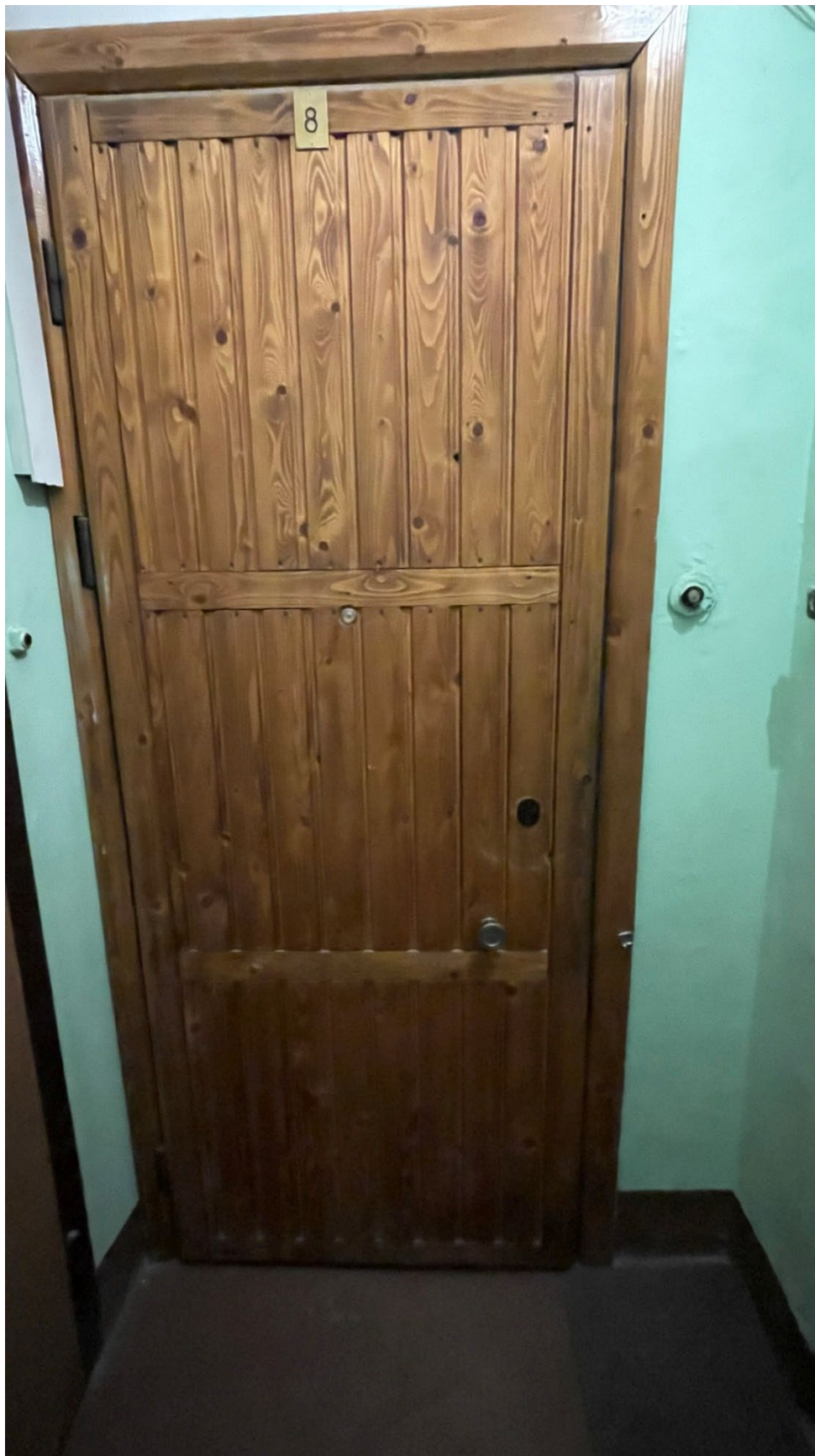
3. Вид на входную дверь в квартиру;
