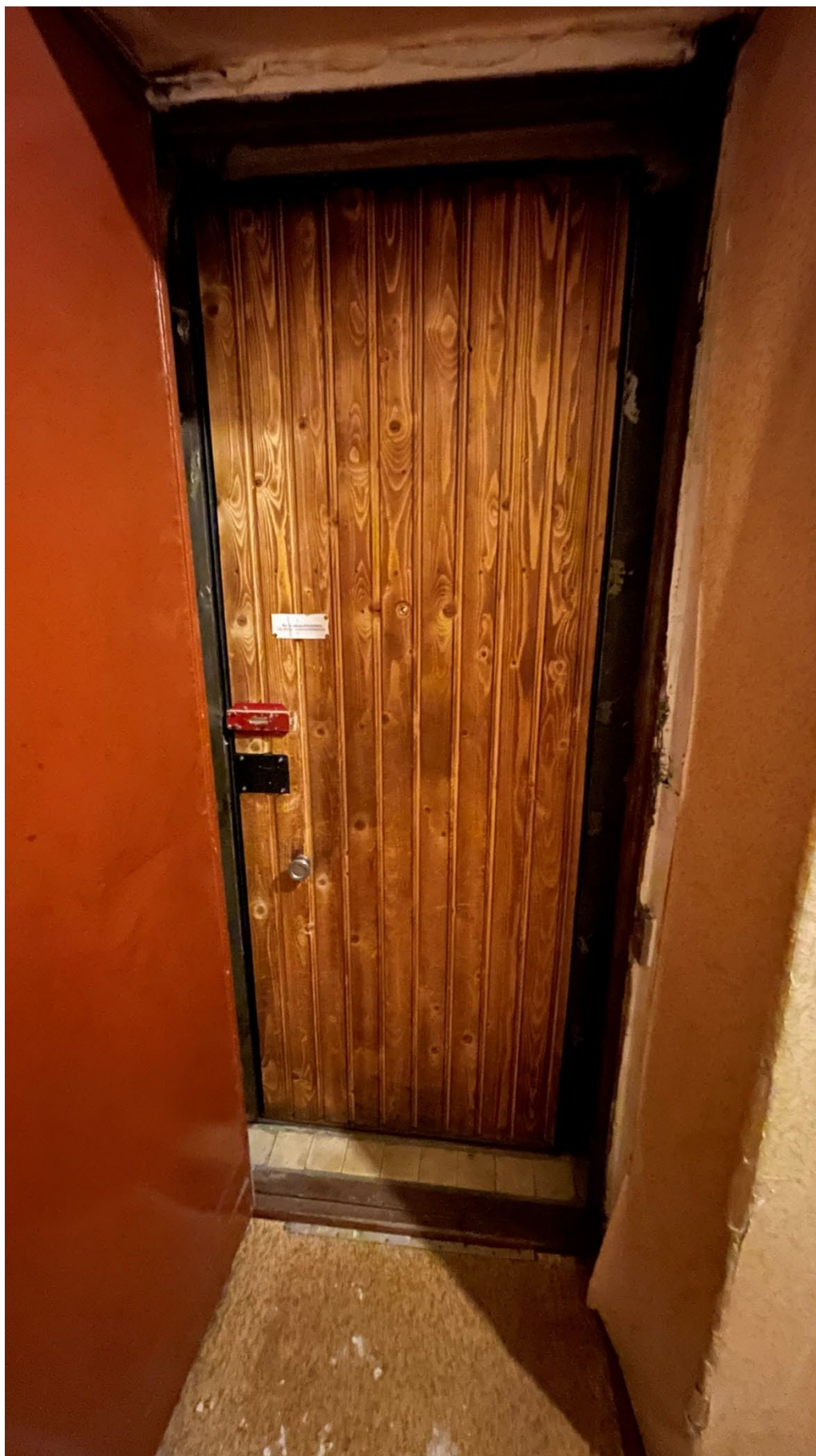
24. Вид на входную дверь в квартире.
