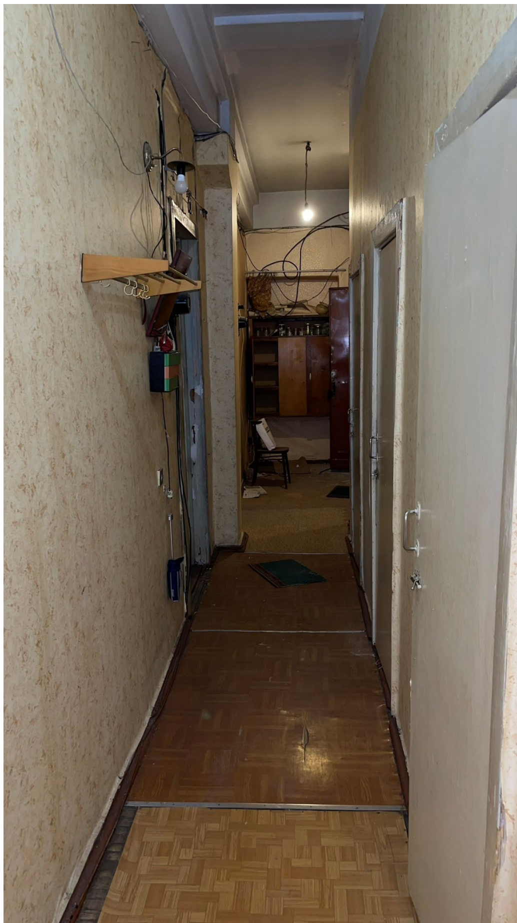
14. Фрагмент интеръера коридора (помещение 1/13.5)
