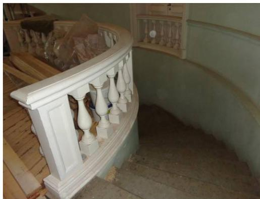
2. лестница, расположенная в северо-восточной части центральной части здания, ведущая из помещения 1Н(67) в помещения второго этажа: средистенная, двухмаршевая, площадки на коробовых сводах, ступени из лещадной плиты; деревянный профилированный поручень; на полу площадок - метлахская плитка белого и серого цветов, выложенная в орнамент «соты»;
