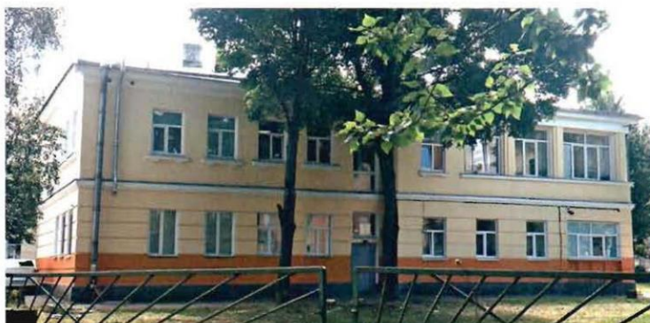
4. Общий вид дворовых фасадов.
