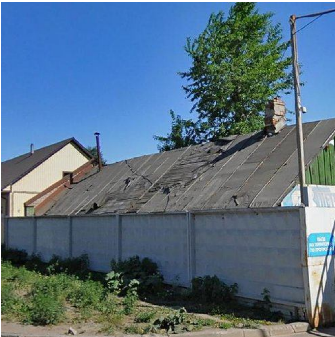
59. Здание по Малой Митрофаньевской ул., д. 10, корп. 4, литера Л. Фото 2000-х гг.
