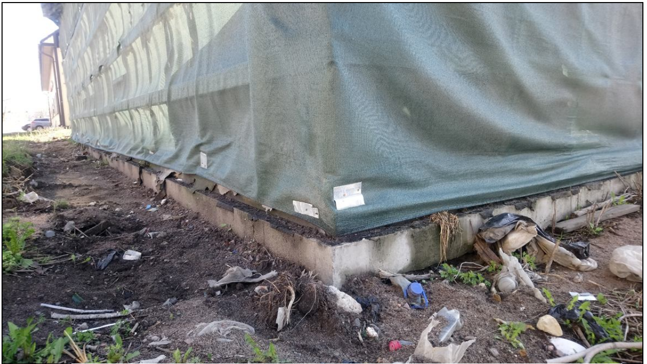
7. Здание по адресу: Малая Митрофаньевская улица, дом 10, корпус 4, литера Л. Фундамент. Вид с северо-западной стороны.
