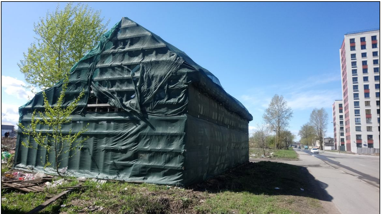
5. Здание по адресу: Малая Митрофаньевская улица, дом 10, корпус 4, литера Л. Общий вид с северо-восточной стороны.
