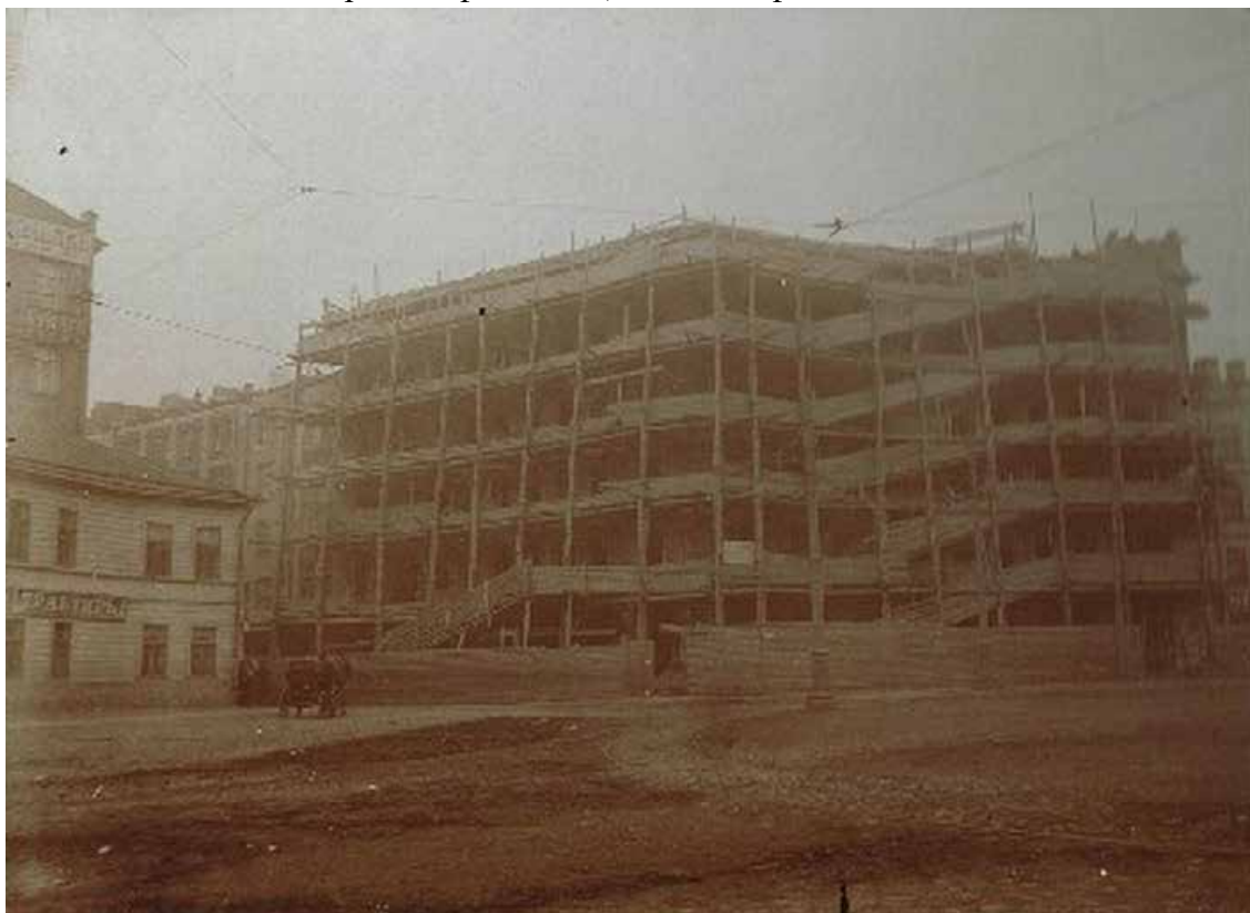
41. Строительство дома 24 по Нарвскому проспекту. 1912 – 1913 гг. [Электронный ресурс] URL: https://pastvu.com/p/320680
