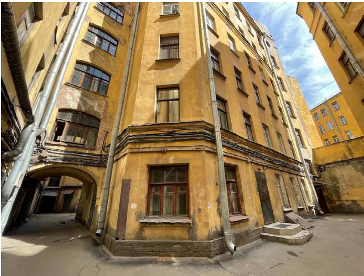
5. Фрагмент дворовых фасадов
