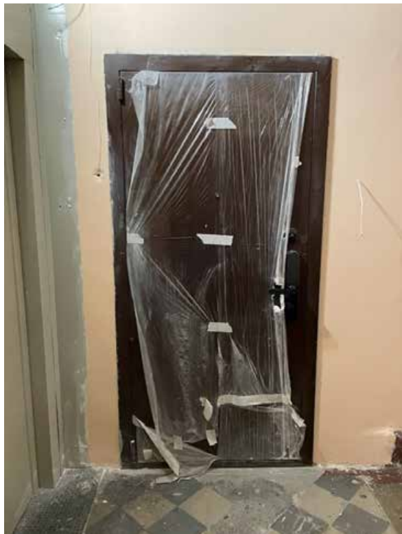
8. Дверь в квартиру с парадной лестницы
