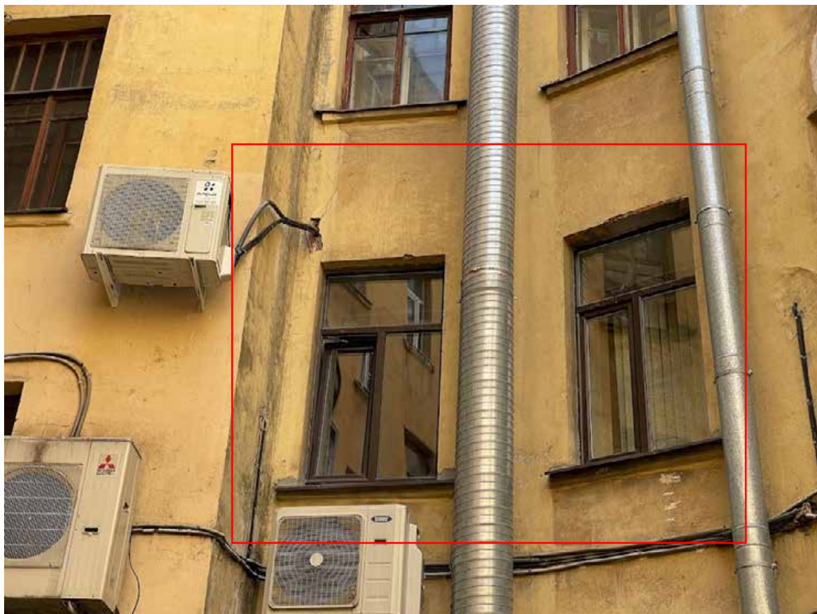
7. Фрагмент дворового фасада
