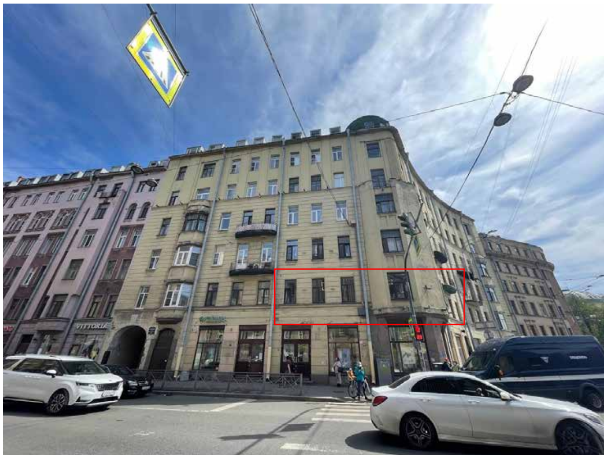
1. Общий вид с Нарвского проспекта
