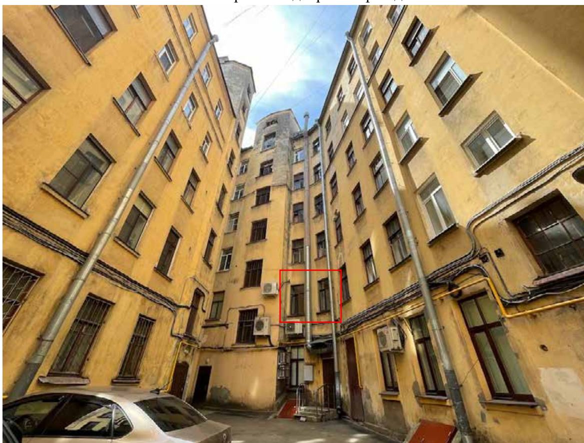
6. Фрагмент дворовых фасадов
