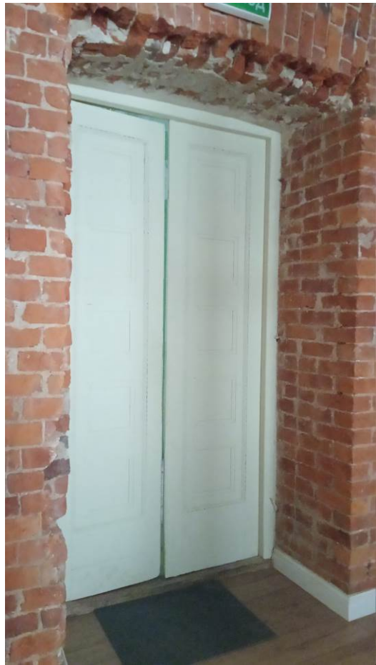
Фото 18. Входная дверь в вестибюль главного входа со стороны помещения 2-Н.
