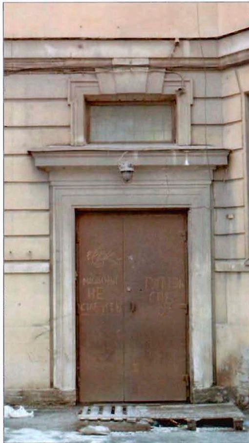
6. Оформление дверного проема. Юго-восточный фасад. Фрагмент.
