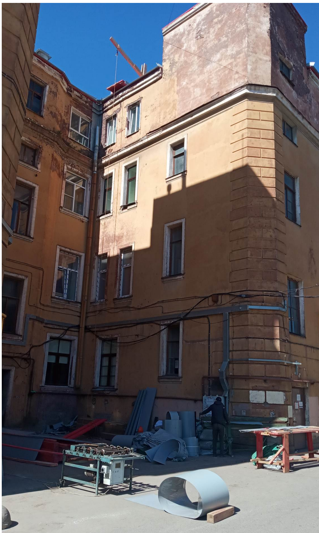
Фото 2. Общий вид дворового юго-восточного фасада здания. Фото от 02.06.2022 г.
