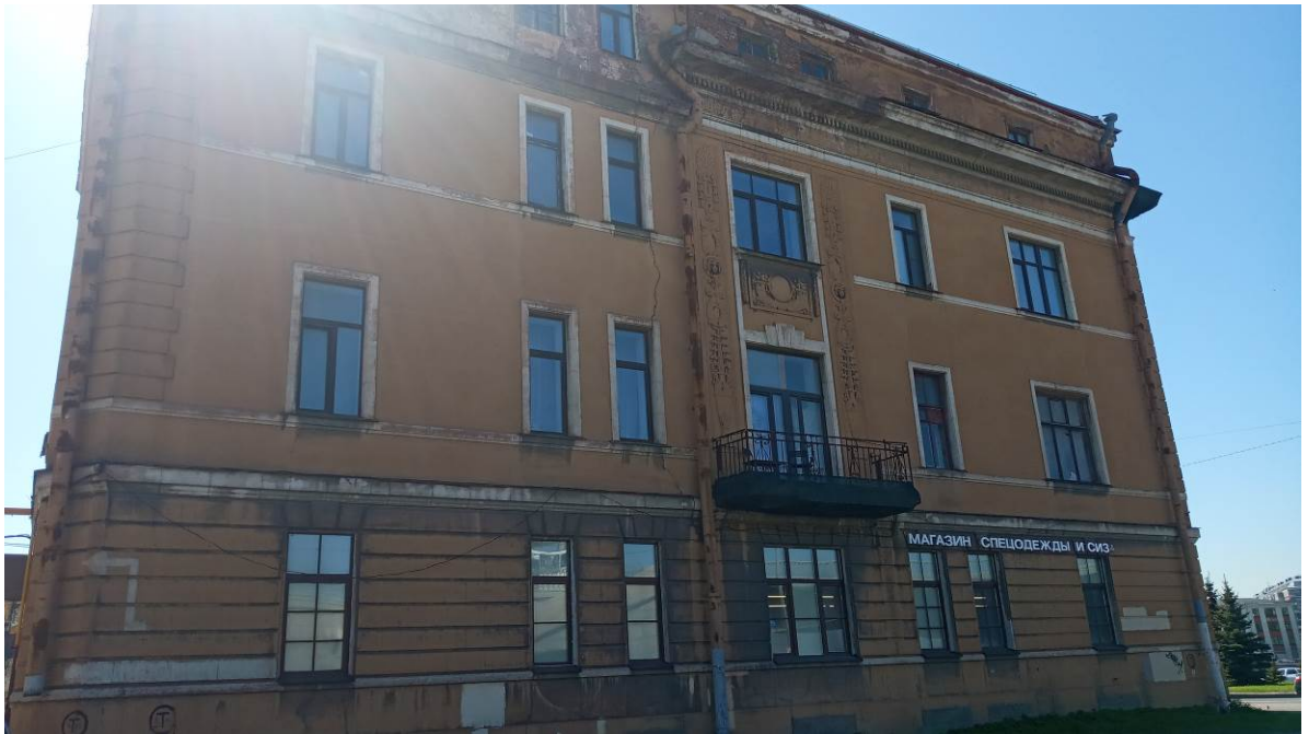
Фото 3. Общій вид бокового северо-западного фасада здания. Фото от 02.06.2022 г.
