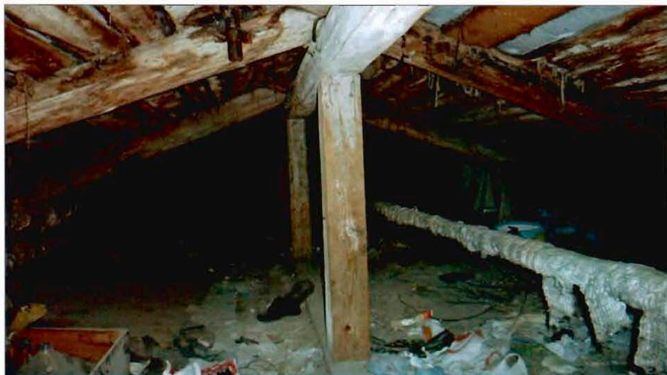
7. Стропильная система. Чердак.
