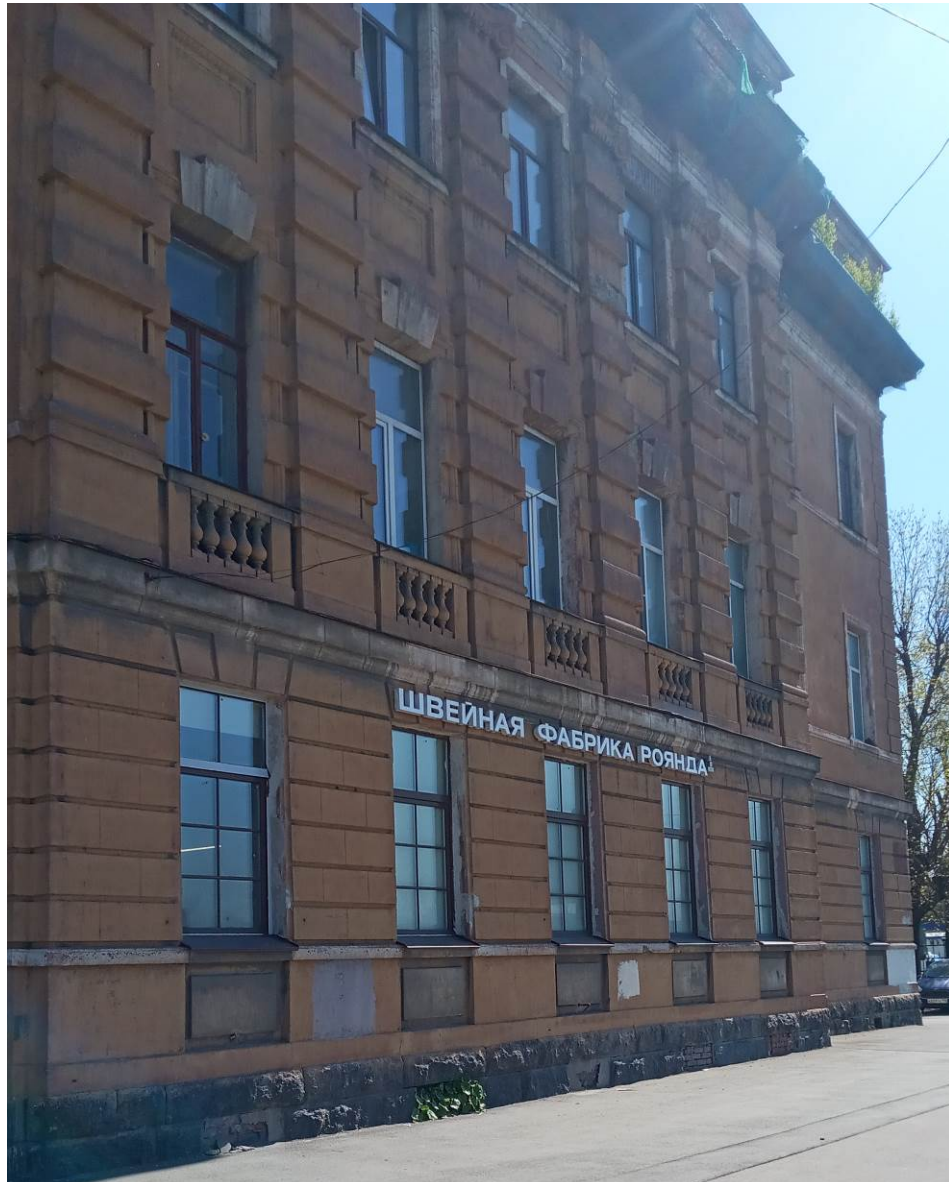
Фото 4. Общій вид лицевого юго-западного фасада здания. Фото от 02.06.2022 г.
