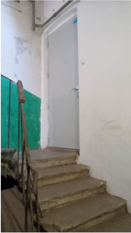
Фото 5. Входная дверь в помещение 2-Н со стороны правой лестничной клетки. Фото от 02.06.2022 г.
