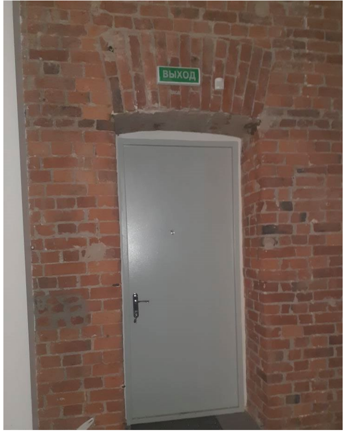
Фото 6. Входная дверь со стороны помещения 2-Н. Фото от 02.06.2022 г.
