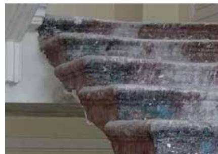
южная лестница – местоположение, габариты, тип (двухмаршевая), конструкция (наборные марши на оштукатуренных металлических косоурах), материал (известняк) и профиль ступеней;
