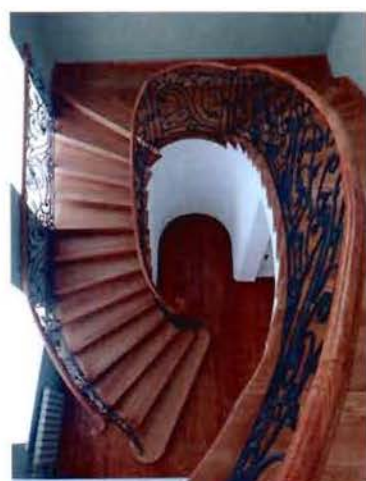
6. Лестница бокового ризалита. (Санкт-Петербург, город Петергоф, Дворцовая площадь, дом 8, литера А).
