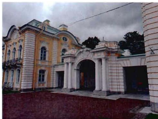
3. Часть объекта культурного наследия – галерея. Вид с северной стороны.
