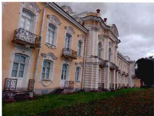
2. Вид на северный фасад объекта культурного наследия.
