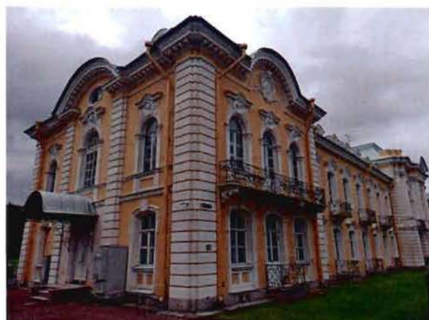
5. Вид на восточный фасад объекта культурного наследия.
