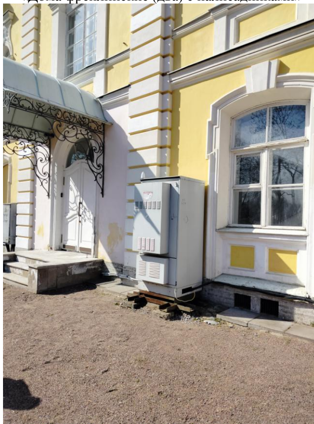
Фото 6. Фрагмент лицевого фасада объекта культурного наследия федерального значения «Дома фрейлинские (два) с палисадниками»
