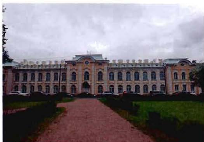
4. Вид на южный фасад объекта культурного наследия.
