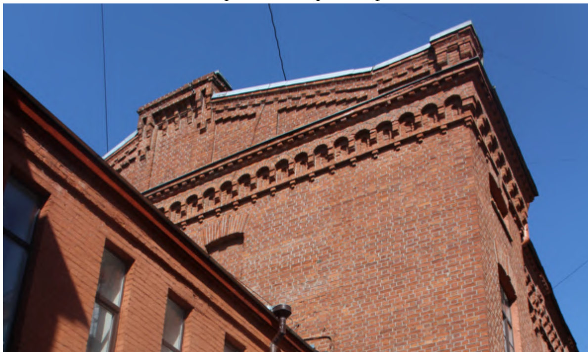
13. Вид на юго-восточный угол здания
