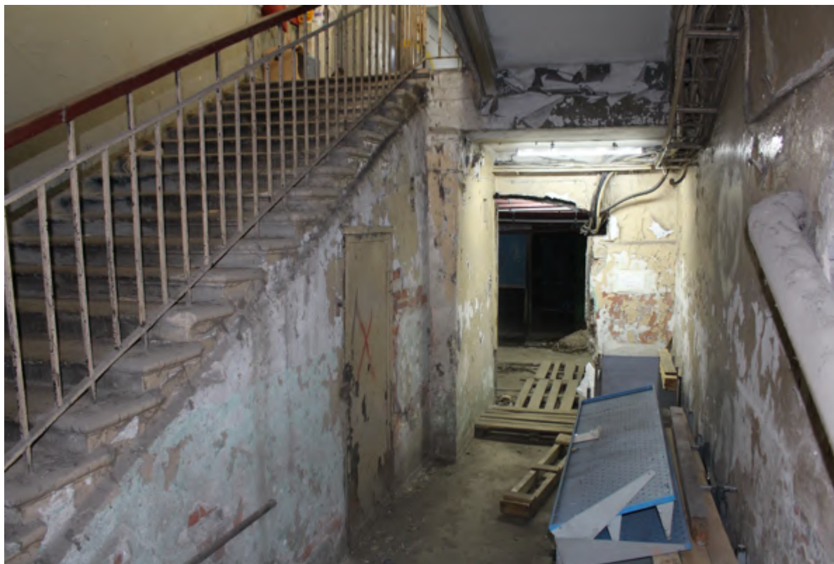
42. Фрагмент интеръера подвала
