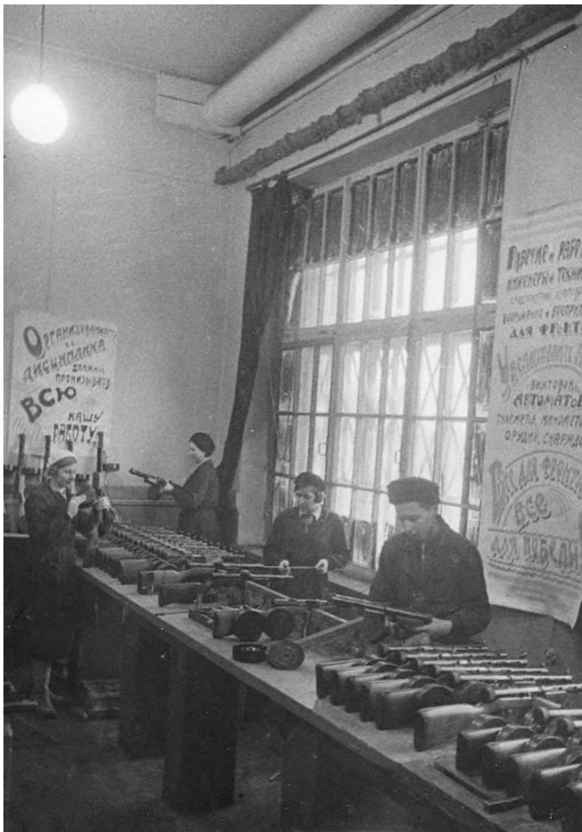
140. Сборка автоматов ППД на заводе "Красный инструментальщик". 1942. «История Второй Мировой Войны 1939-1945». Ордена Трудового Красного Знамени Военное Издательство Министерства Обороны СССР, Москва, 1977. Том 8, стр. 128-129.
