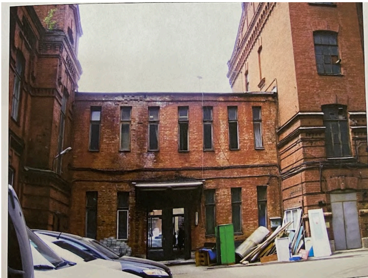
146. Здание проходной. 2009 г. Архив КГИОП Н-15400
