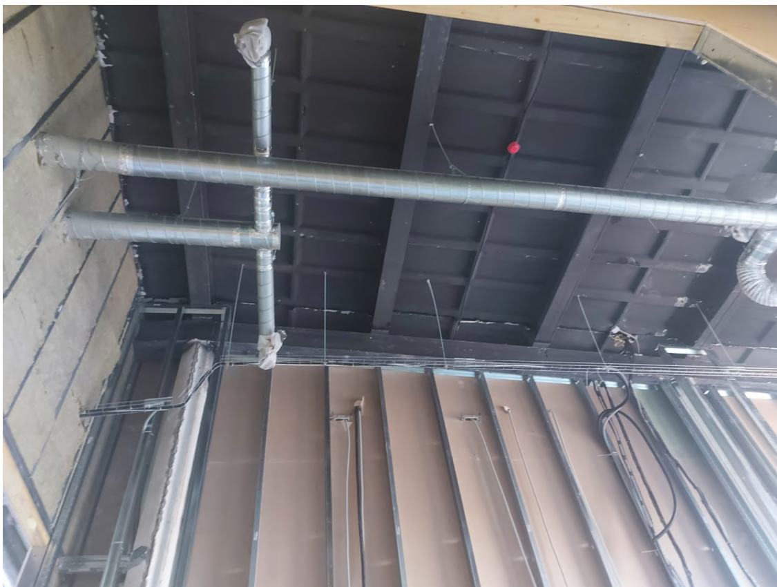
89. Перекрытия четвертого этажа
