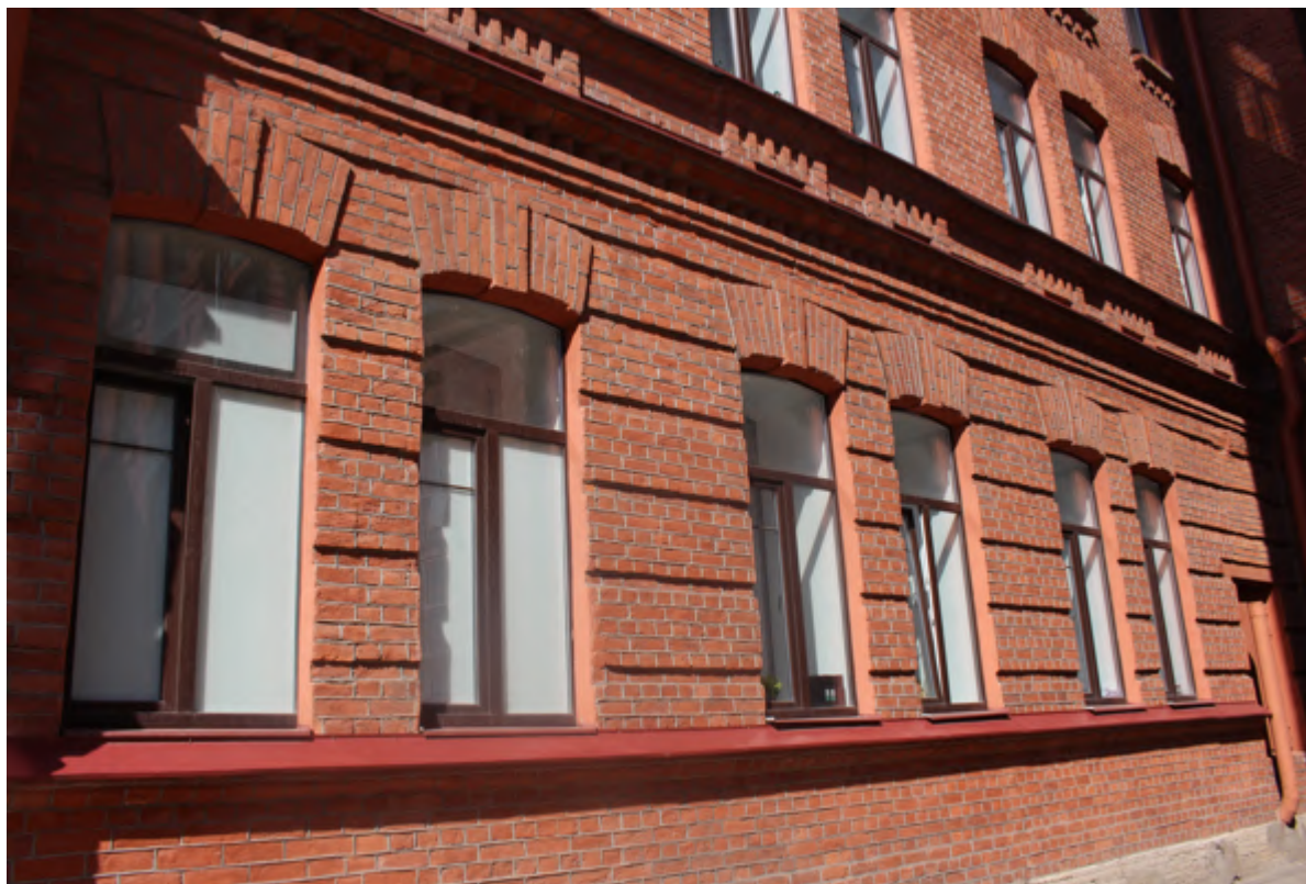
12. Фрагмент дворового фасада
