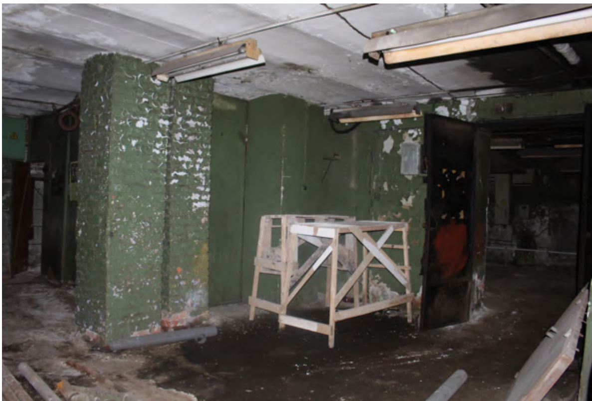
44. Фрагмент интеръера подвала
