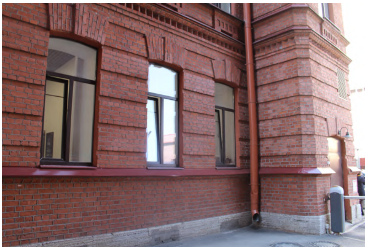
8. Фрагмент дворового фасада
