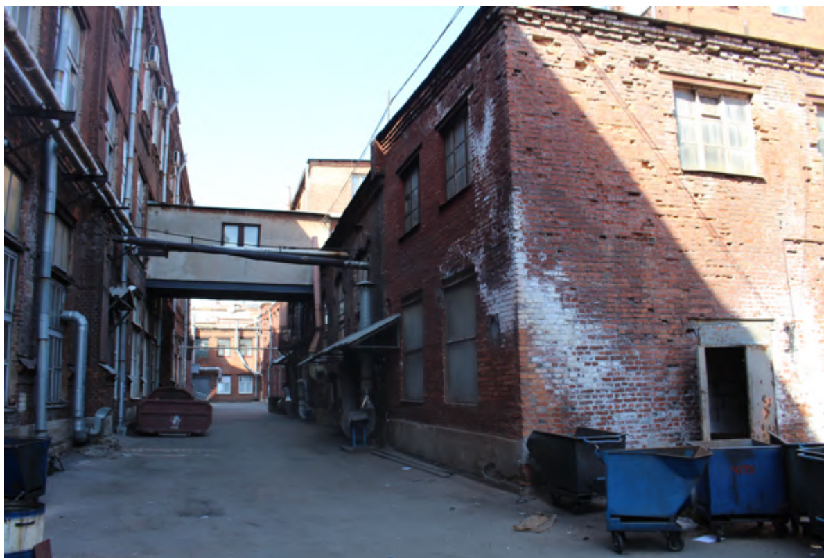
4. Фрагмент фасада поздней пристройки
