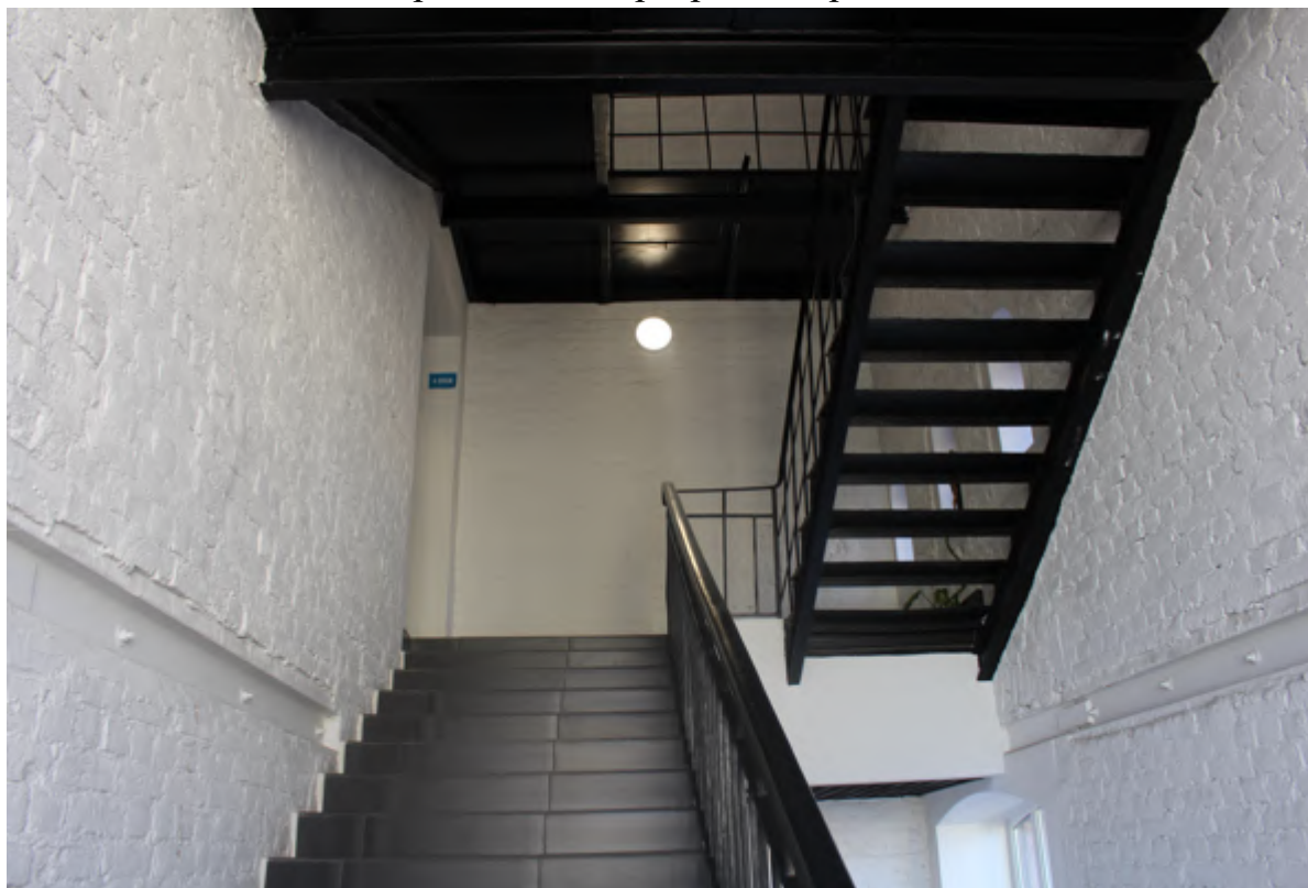
80. Фрагмент интерьера четвертого этажа
