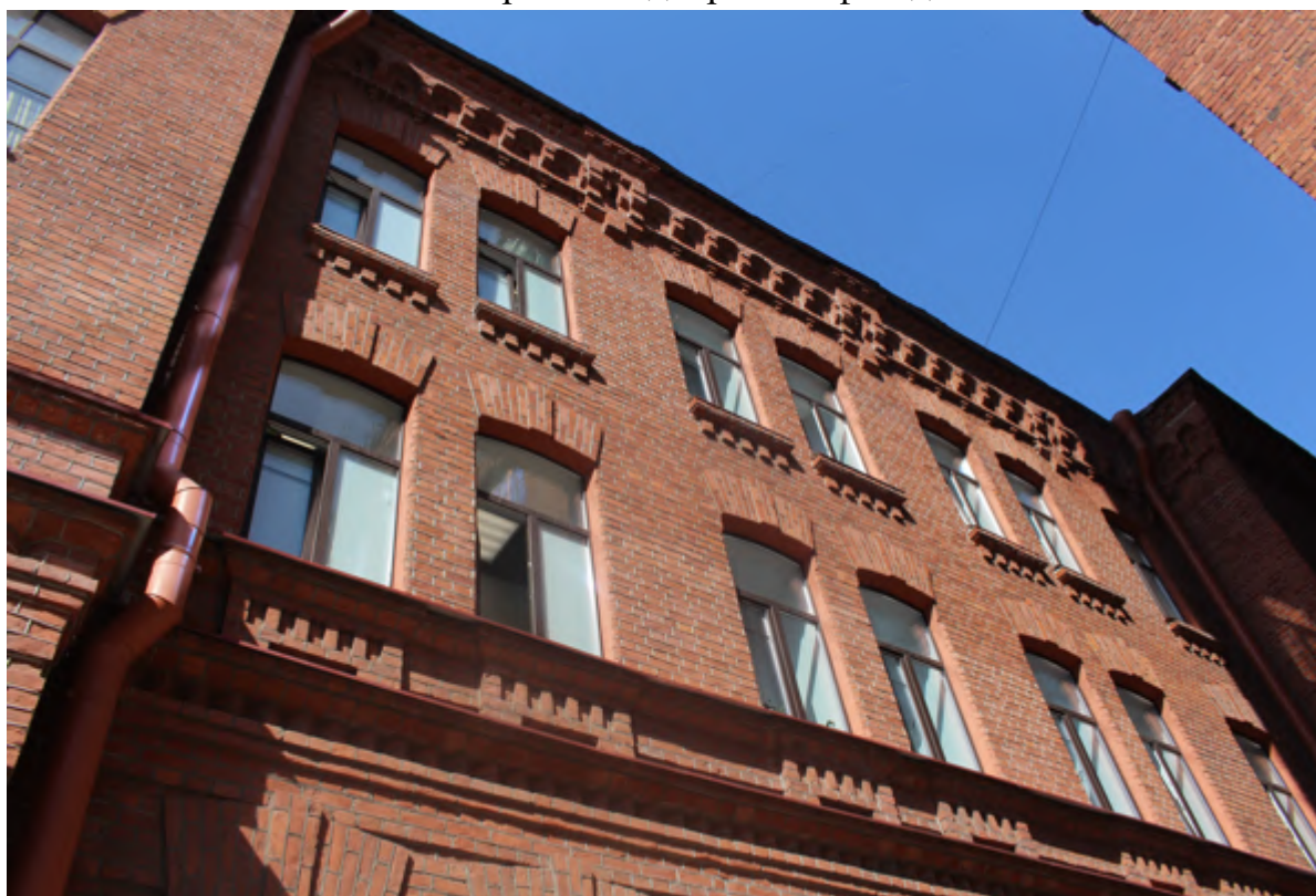
11. Фрагмент дворового фасада
