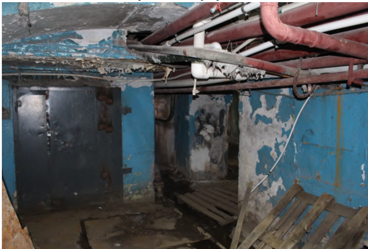
43. Фрагмент интеръера подвала
