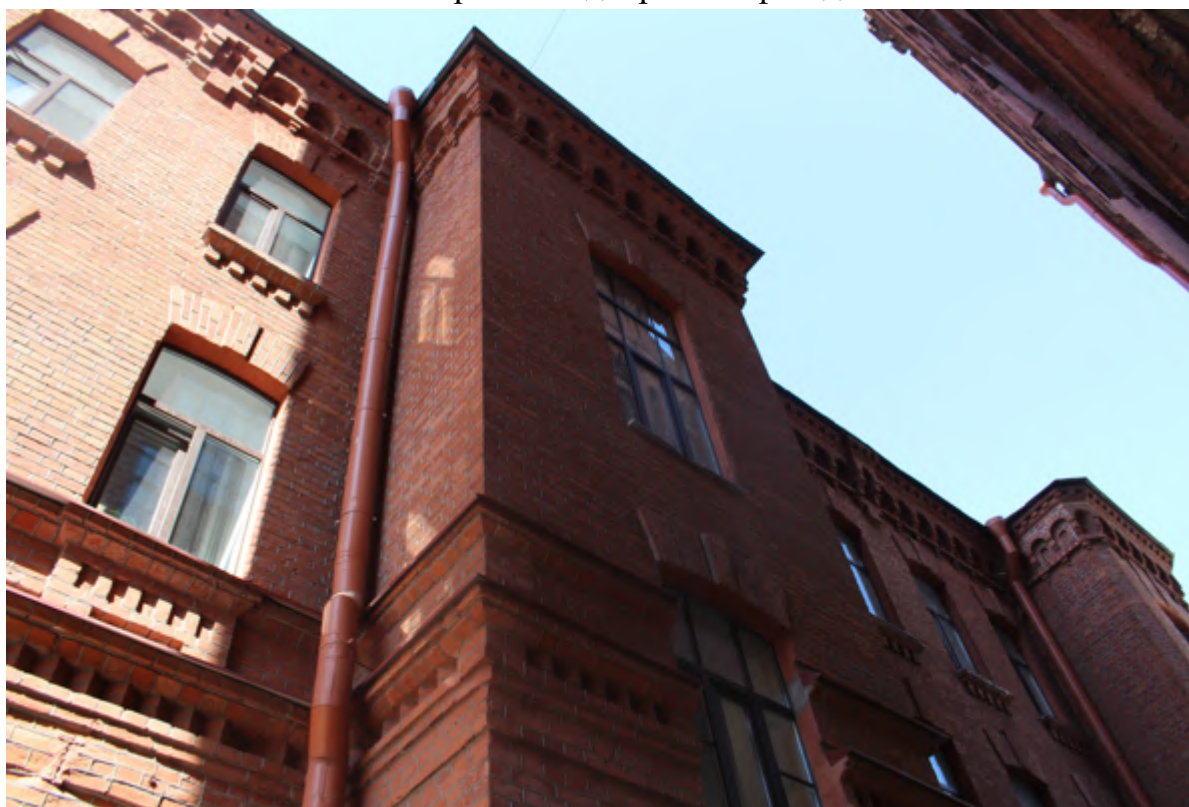
9. Фрагмент дворового фасада
