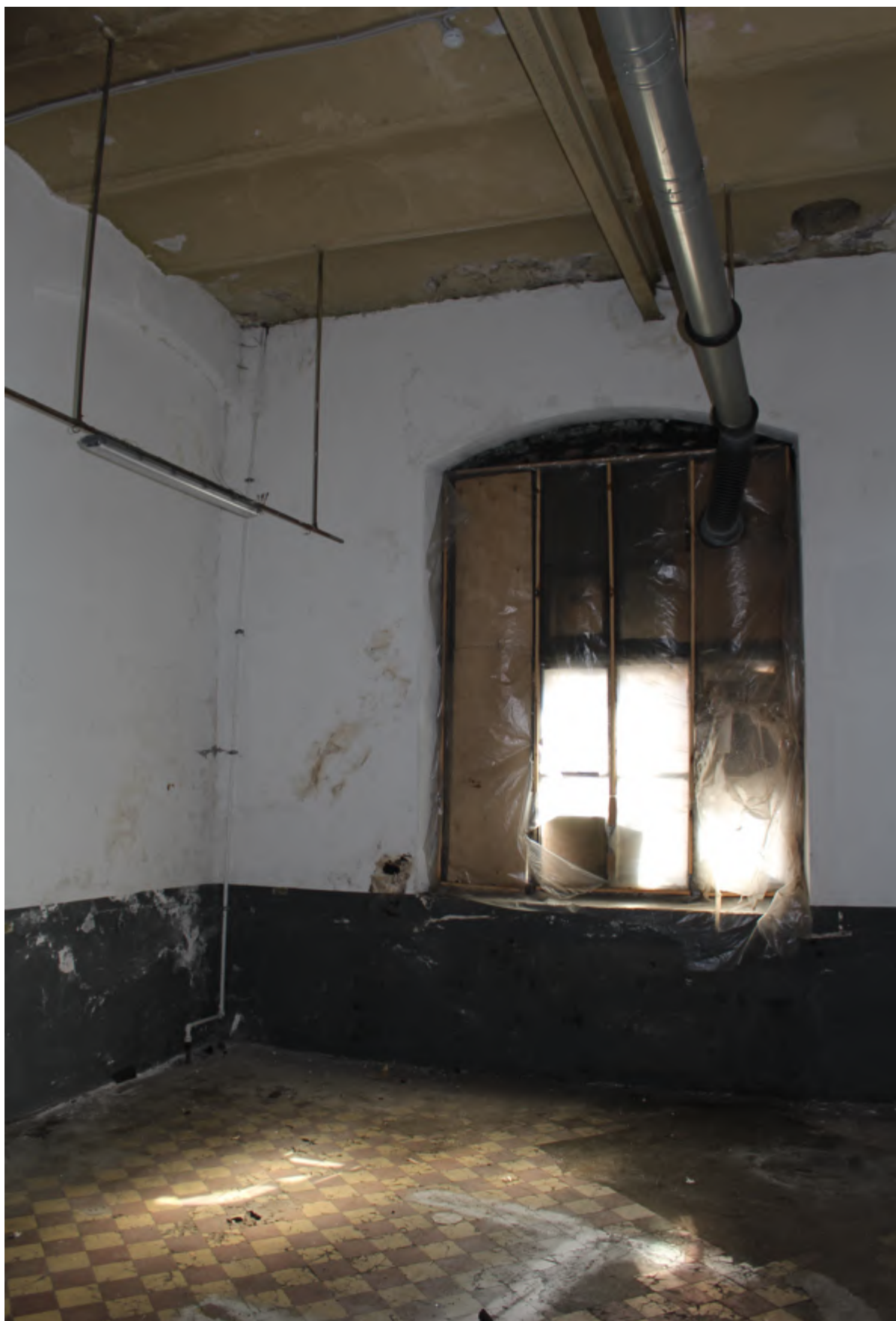
25. Фрагмент интерьера первого этажа
