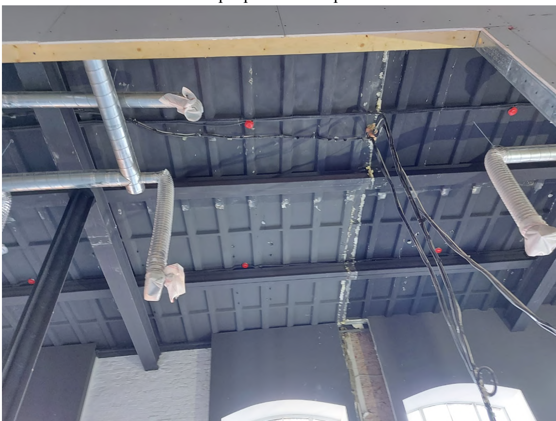
90. Перекрытия четвертого этажа
