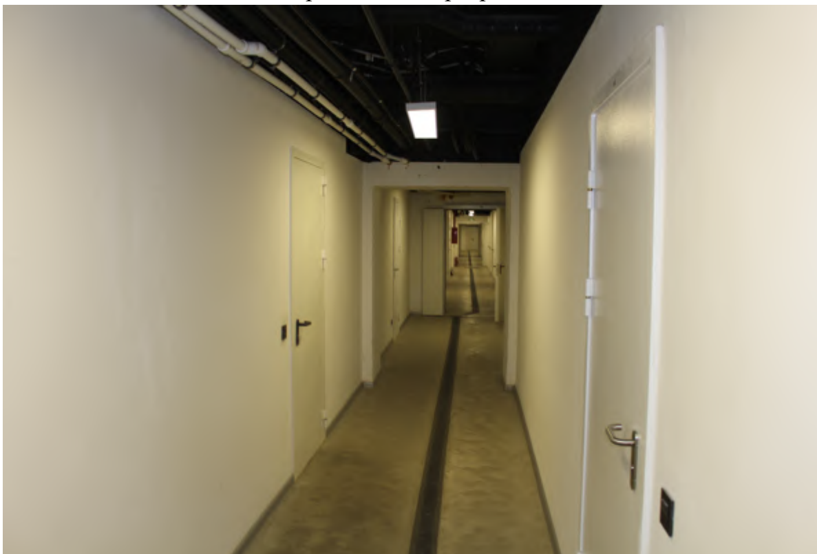
45. Фрагмент интеръера подвала
