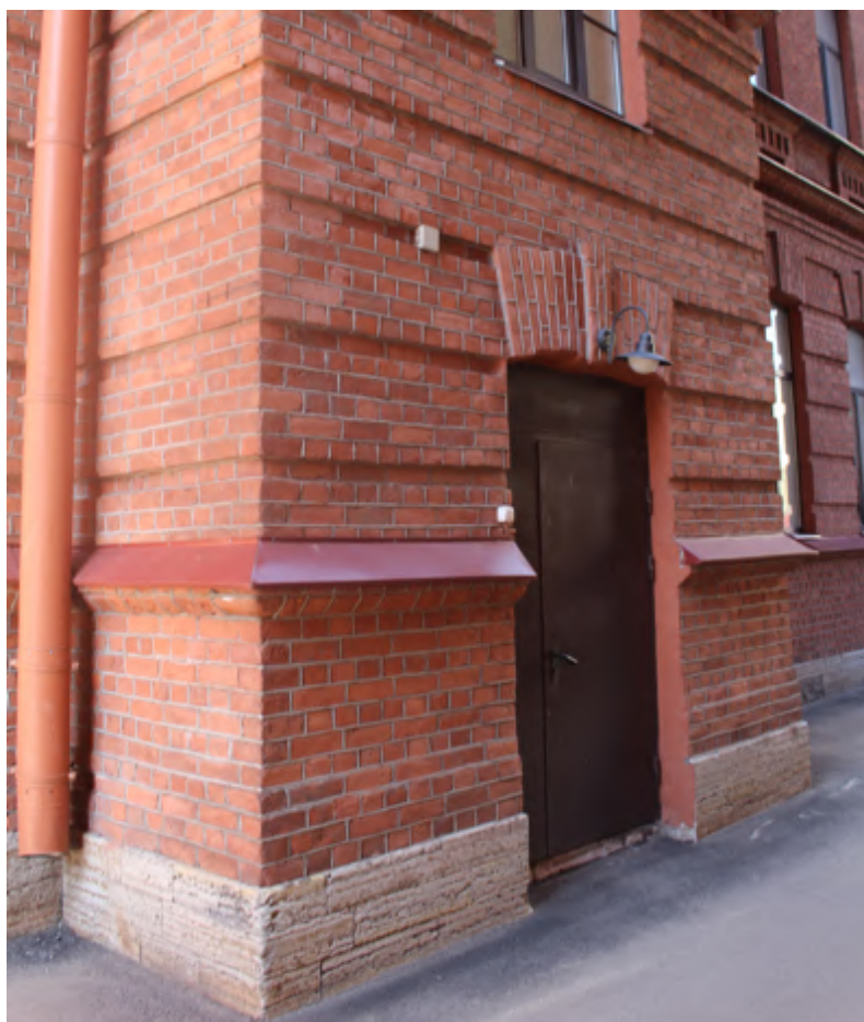
10. Фрагмент дворового фасада
