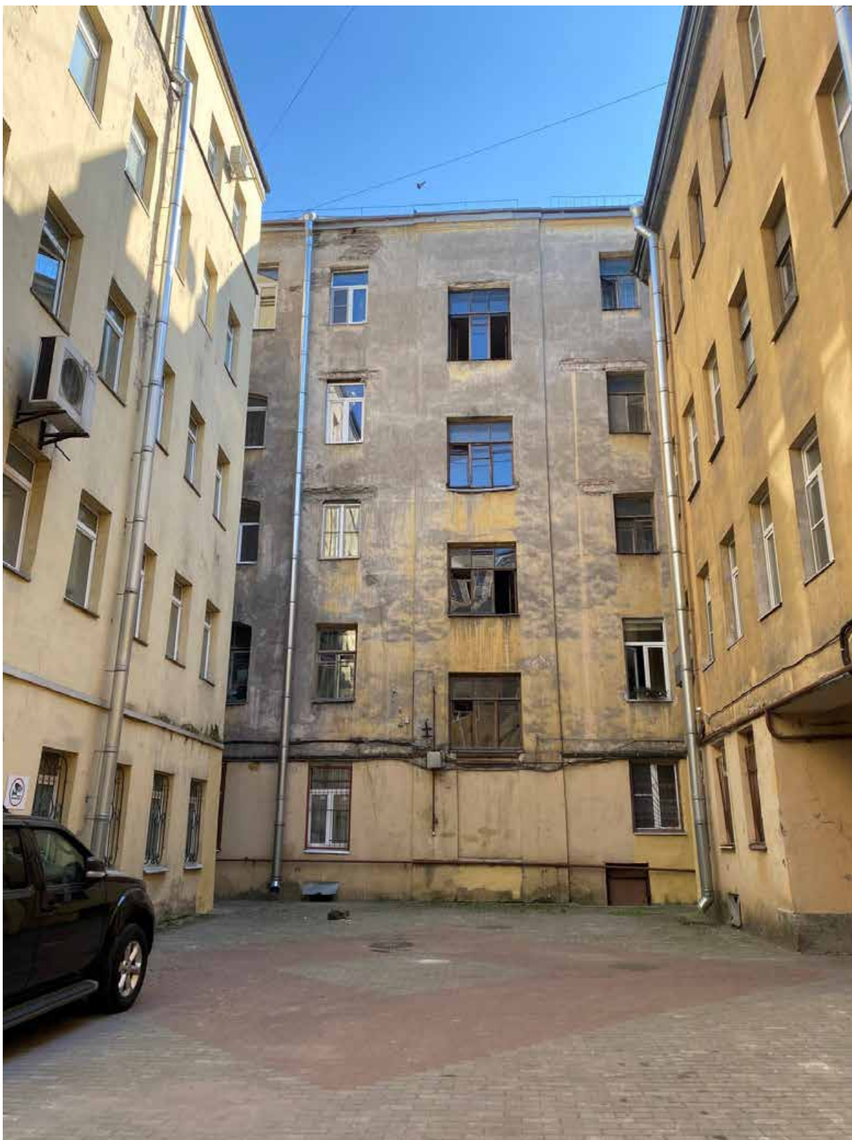
Фото 9. Вид на часть дворовых фасадов объекта культурного наследия.
