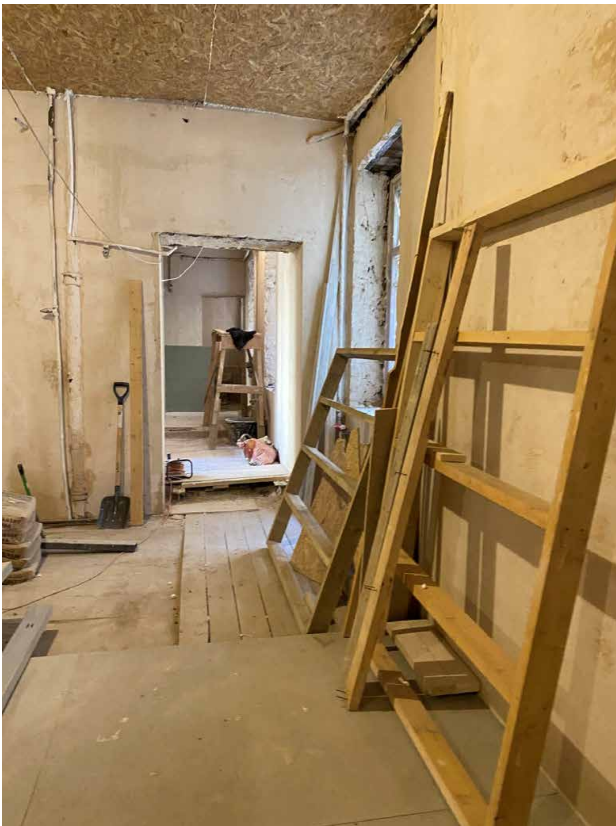
Фото 36. Вид на помещение квартиры № 5 объекта культурного наследия.
