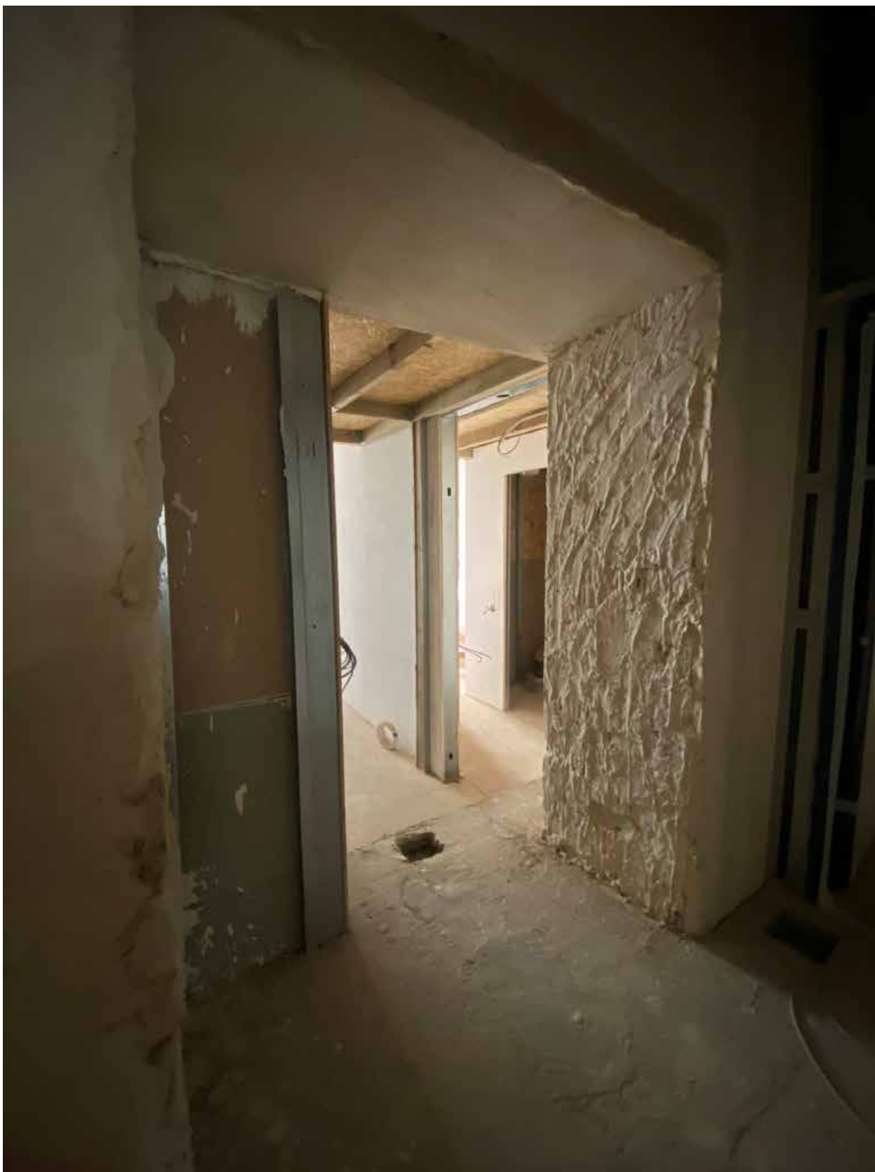
Фото 28. Вид на помещение квартиры № 5 объекта культурного наследия.
