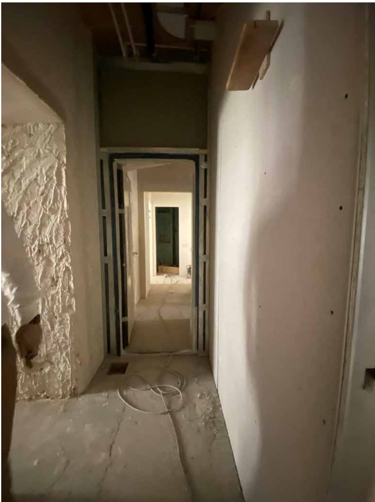
Фото 26. Вид на помещение квартиры № 5 объекта культурного наследия.
