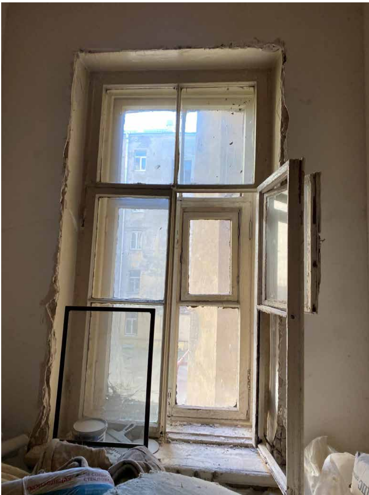
Фото 32. Вид на оконное заполнение в части квартиры № 5 объекта культурного наследия.
