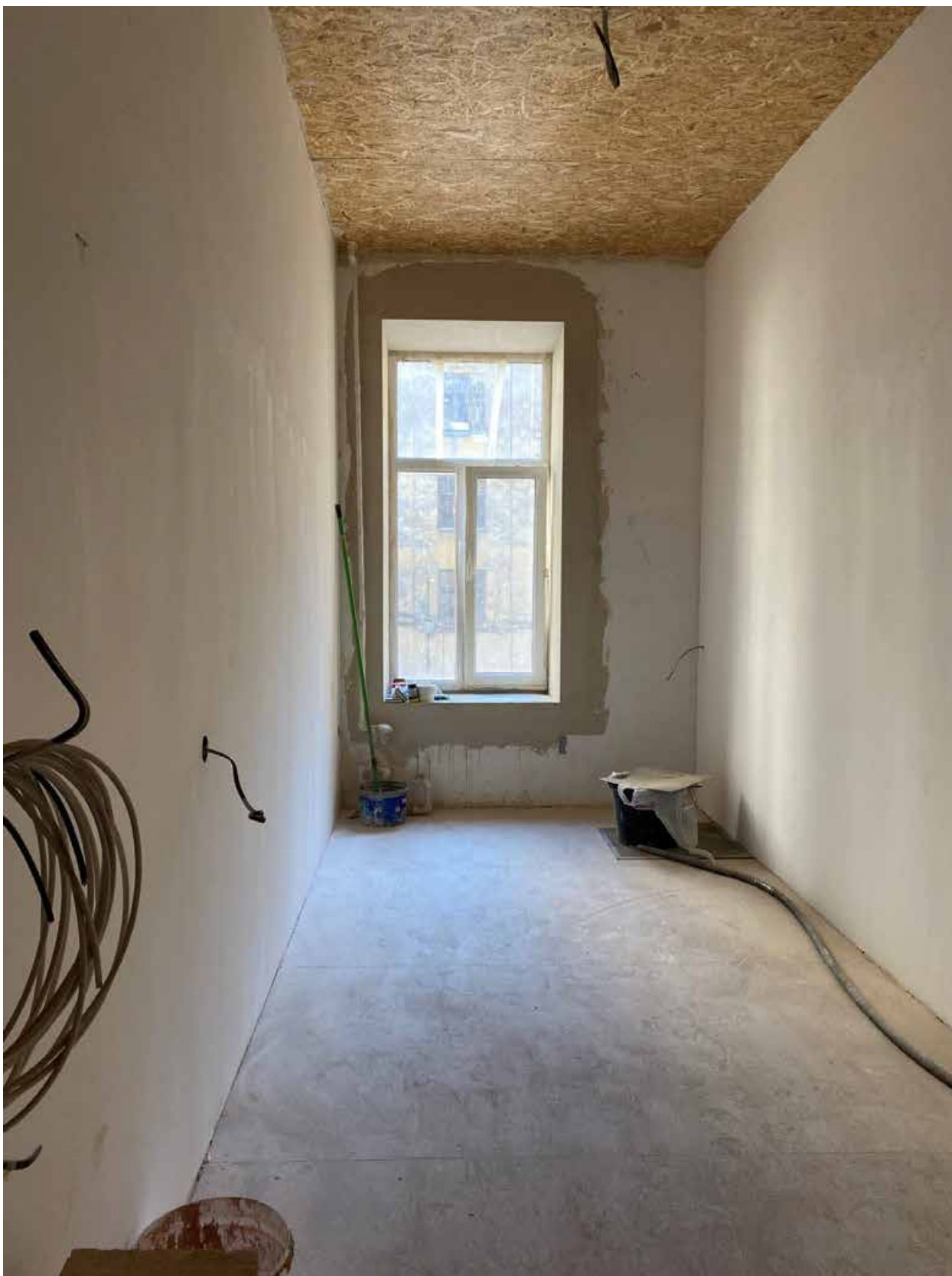
Фото 17. Вид на помещение квартиры № 5 объекта культурного наследия.
