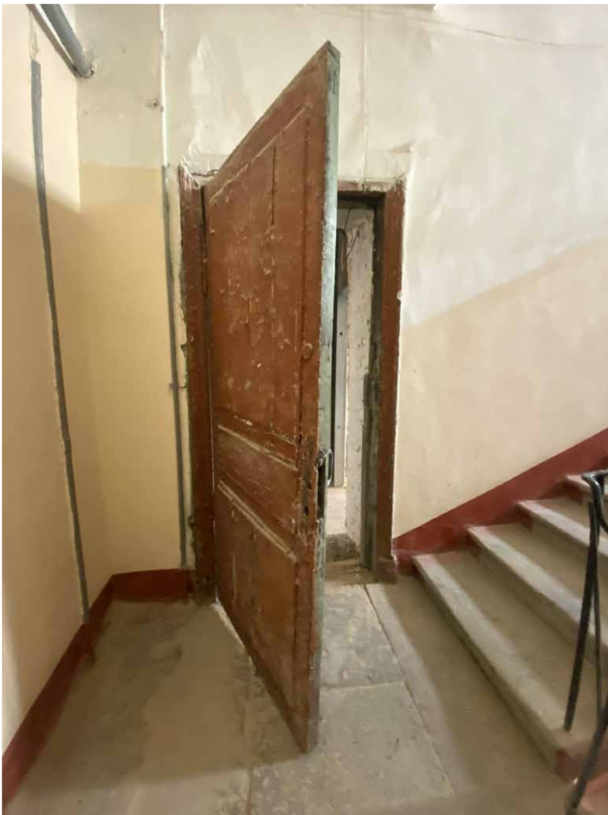
Фото 13. Вид на вход с черной лестницы в квартиру № 5 объекта культурного наследия.
