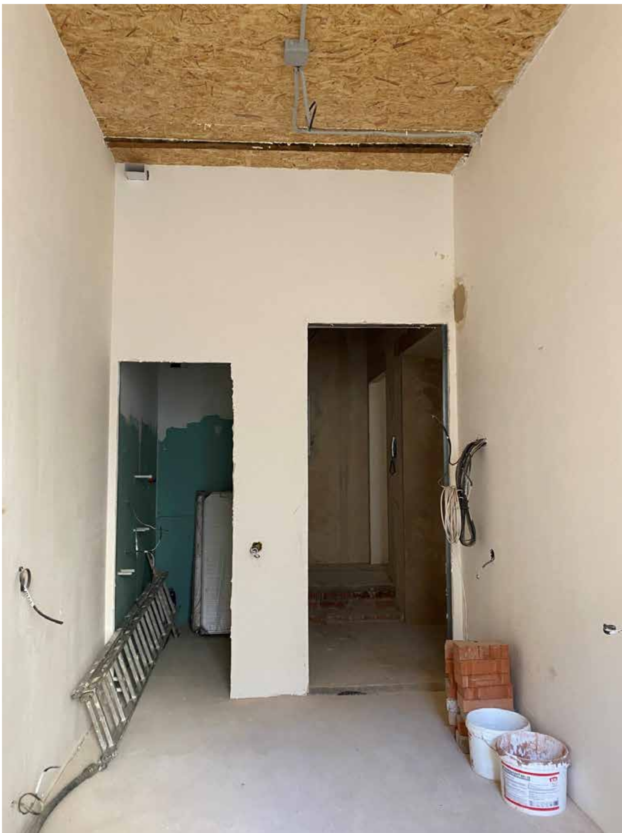
Фото 19. Вид на помещение квартиры № 5 объекта культурного наследия.
