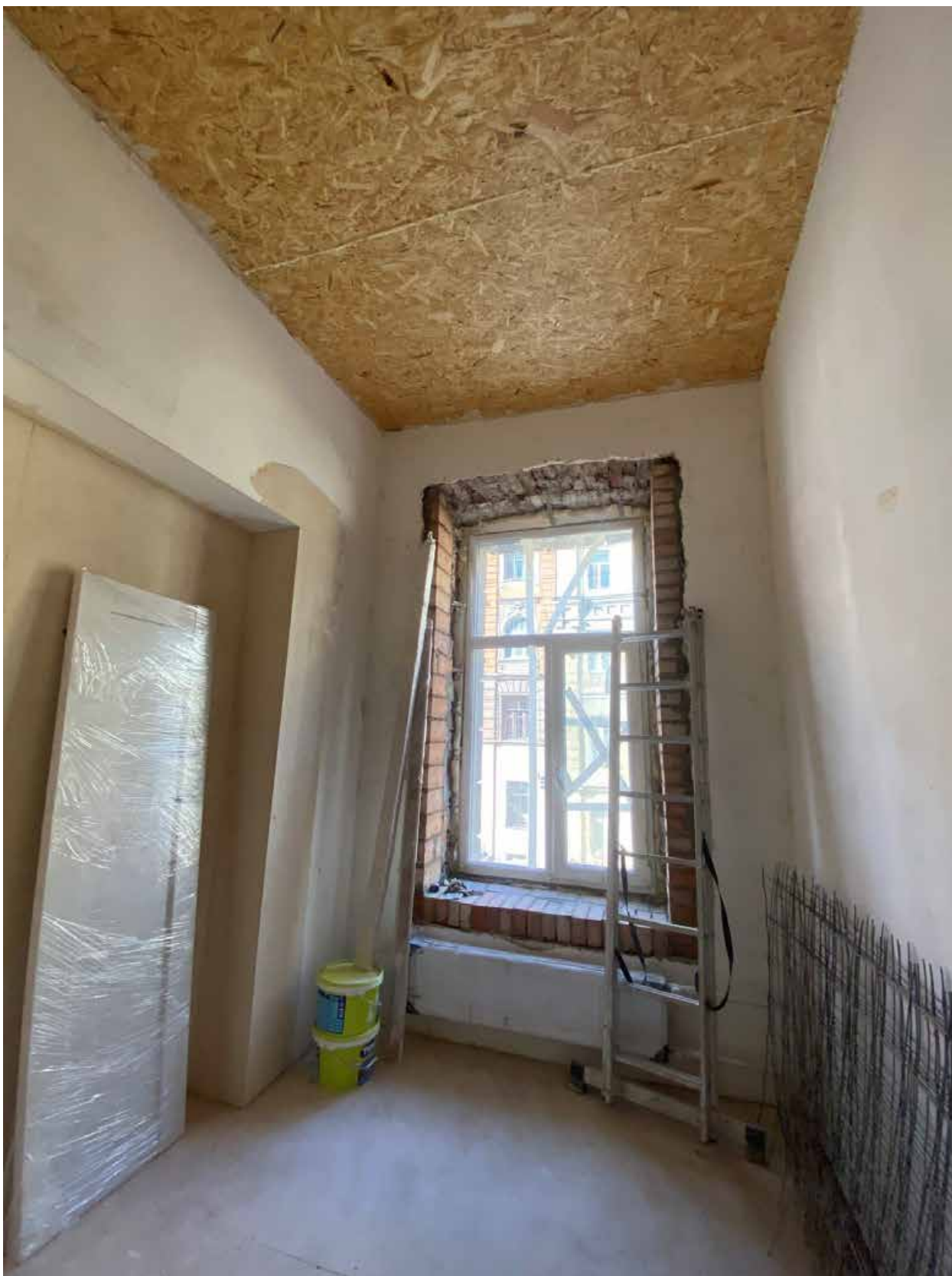
Фото 44. Вид на помещение квартиры № 5 объекта культурного наследия.
