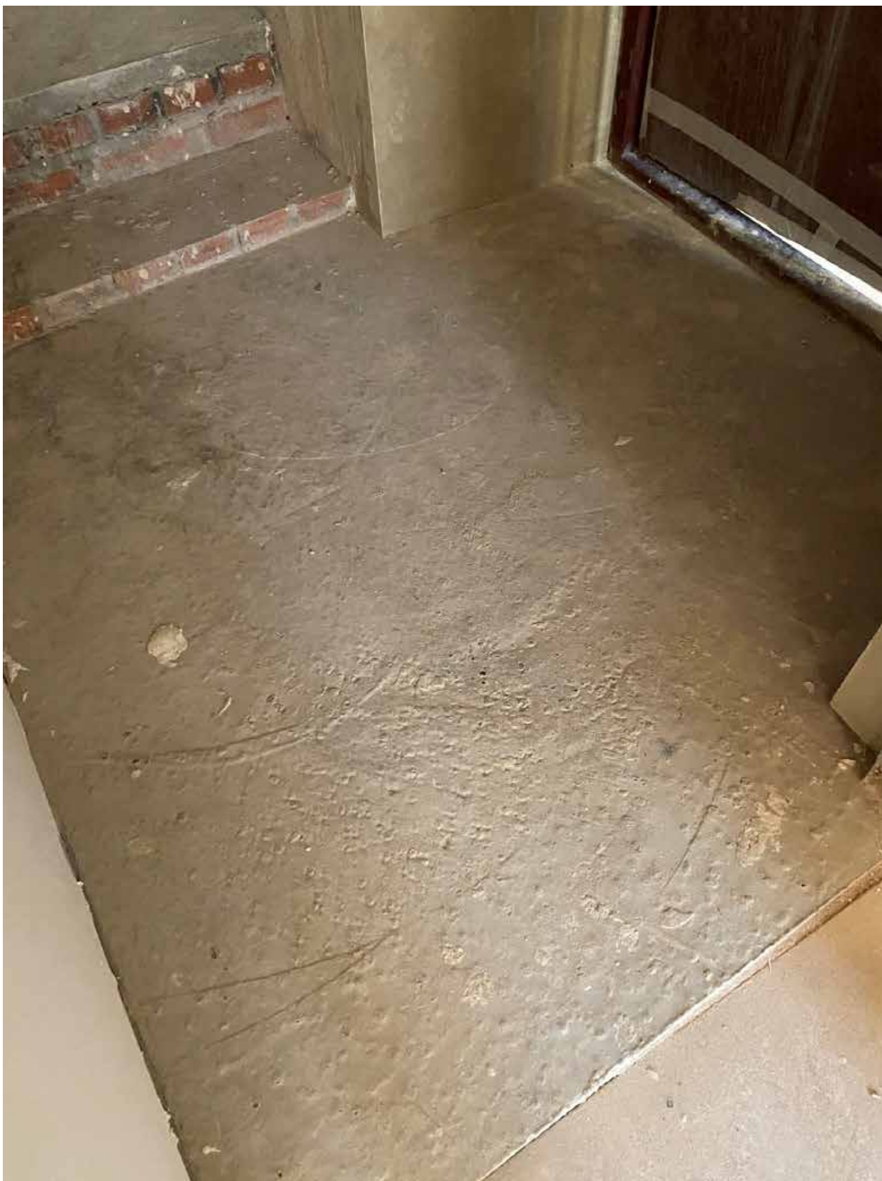
Фото 20. Вид на помещение квартиры № 5 объекта культурного наследия.
