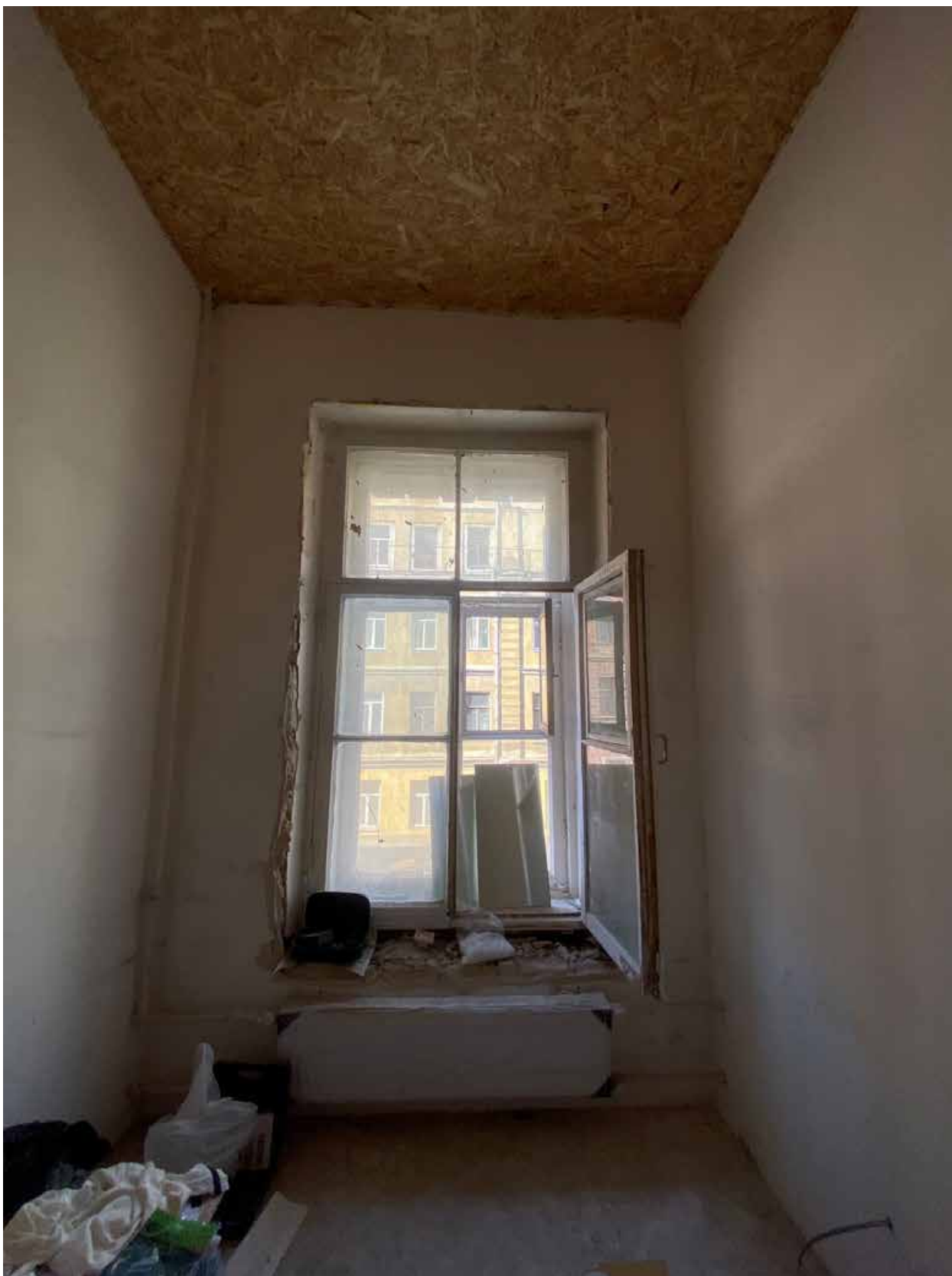
Фото 47. Вид на оконное заполнение в части квартиры № 5 объекта культурного наследия.
