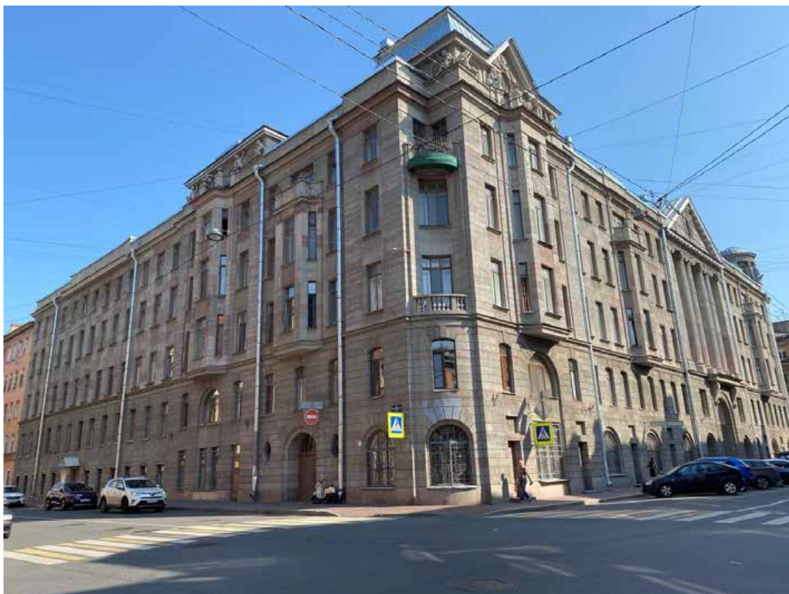
Фото 3. Общий вид объекта культурного наследия с перекрестка улиц Егорова и 5-й Красноармейской.
