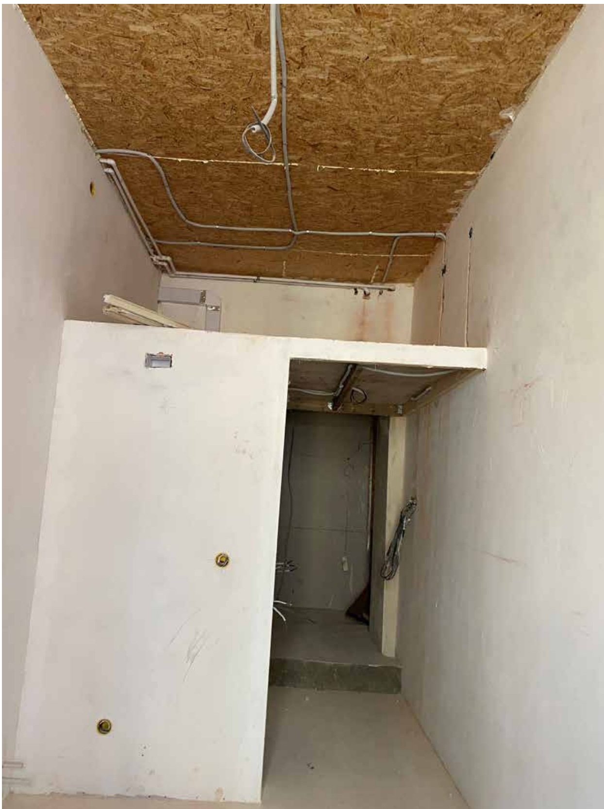
Фото 45. Вид на помещение квартиры № 5 объекта культурного наследия.
