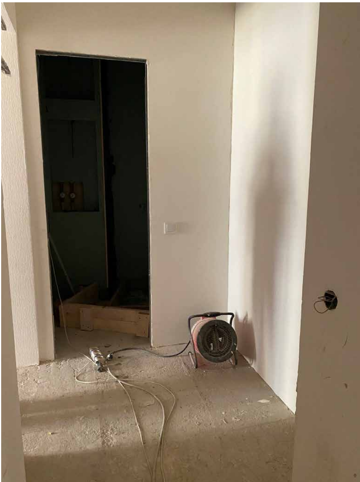
Фото 21. Вид на помещение квартиры № 5 объекта культурного наследия.
