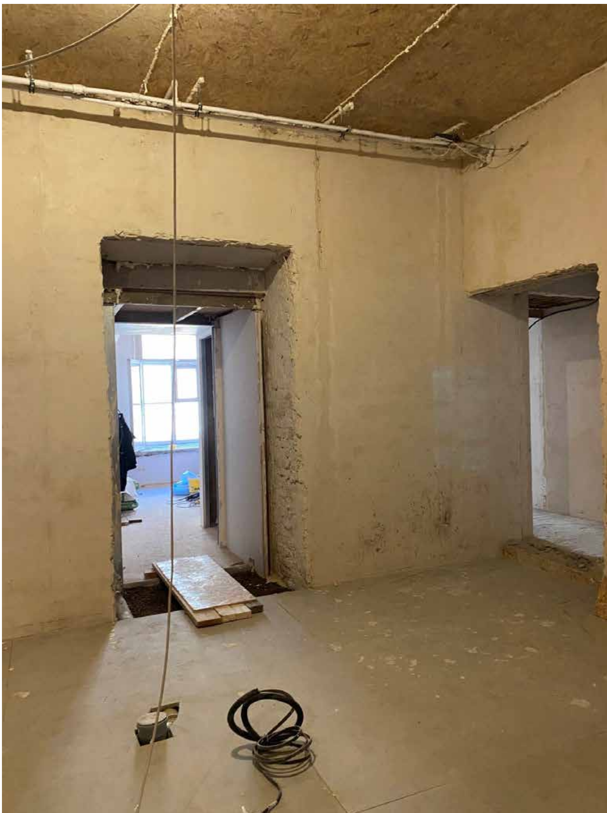
Фото 35. Вид на помещение квартиры № 5 объекта культурного наследия.
