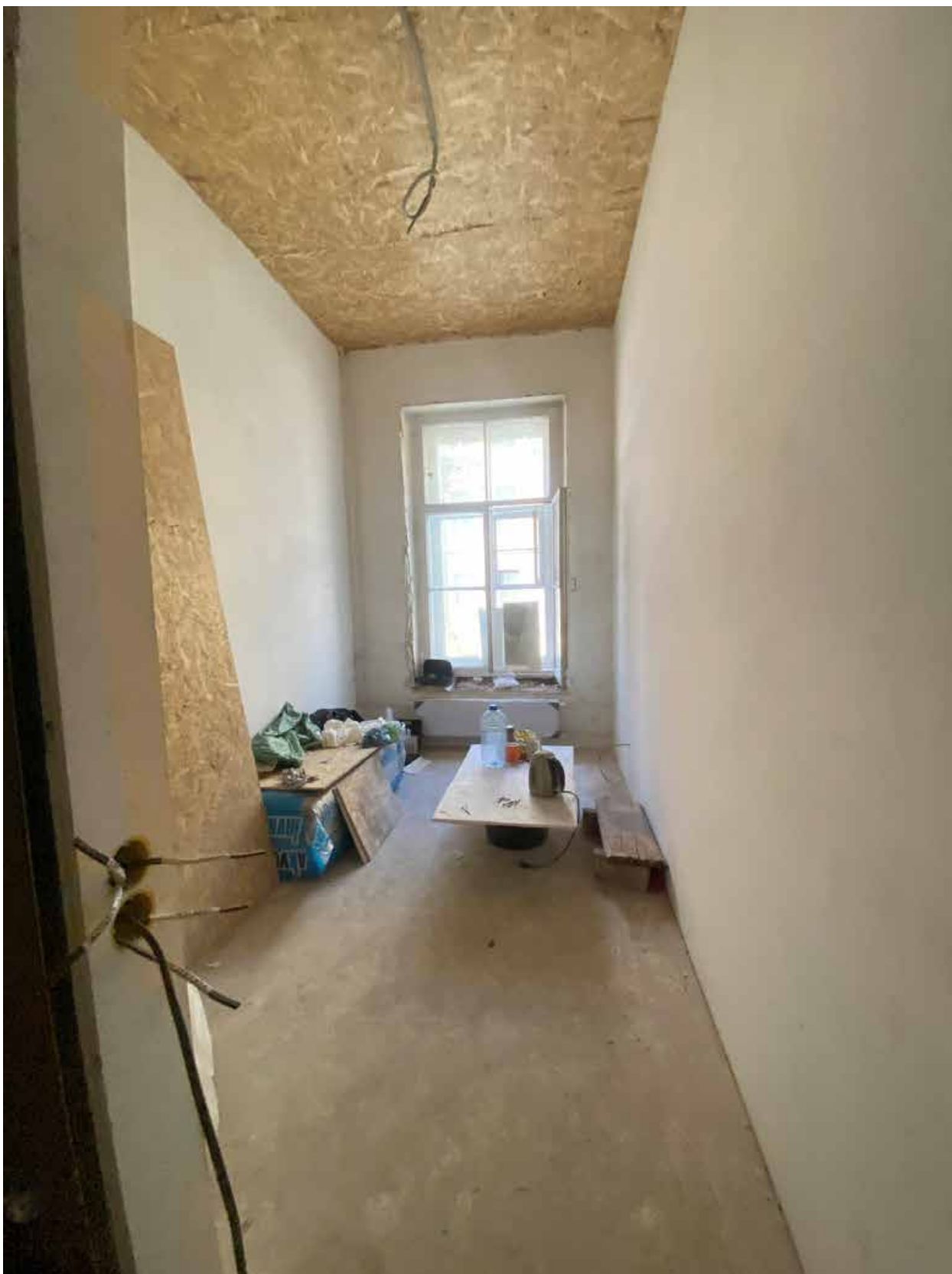
Фото 46. Вид на помещение квартиры № 5 объекта культурного наследия.
