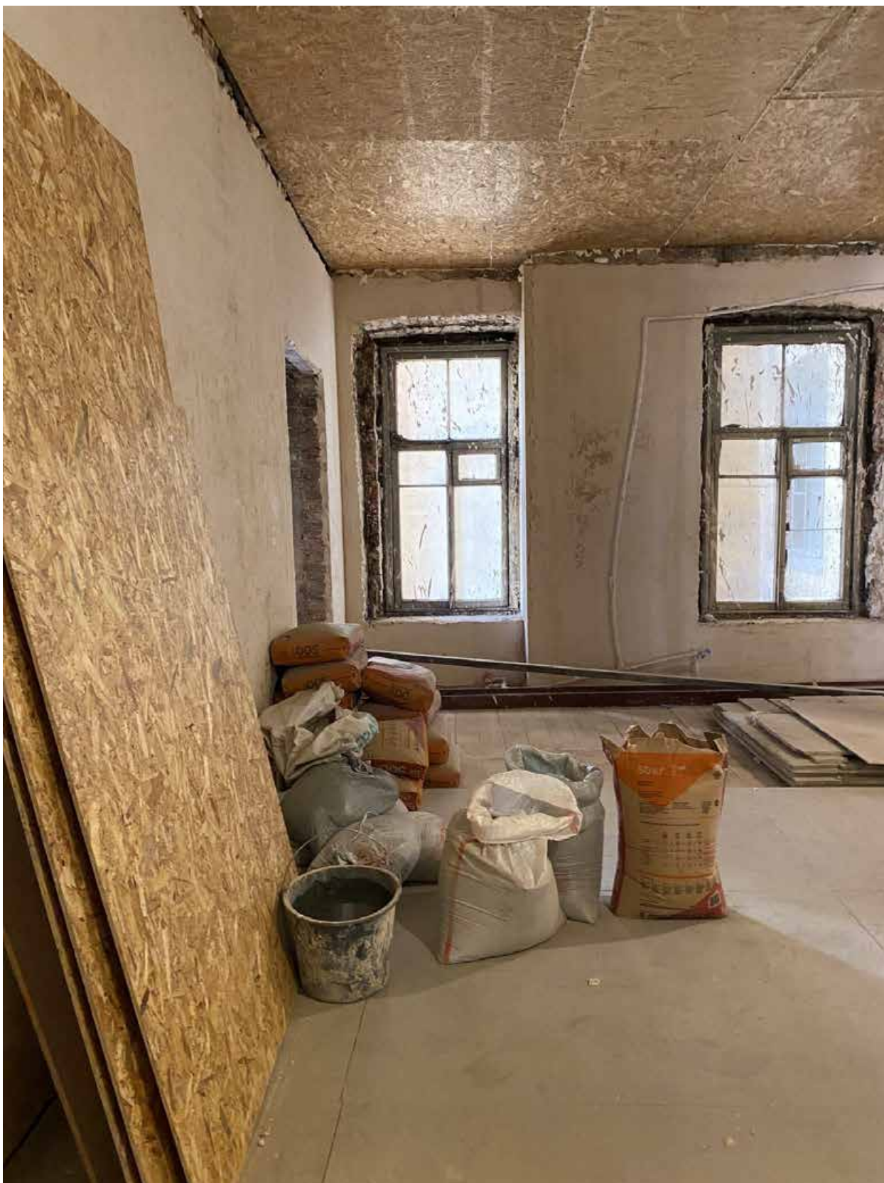
Фото 33. Вид на помещение квартиры № 5 объекта культурного наследия.
