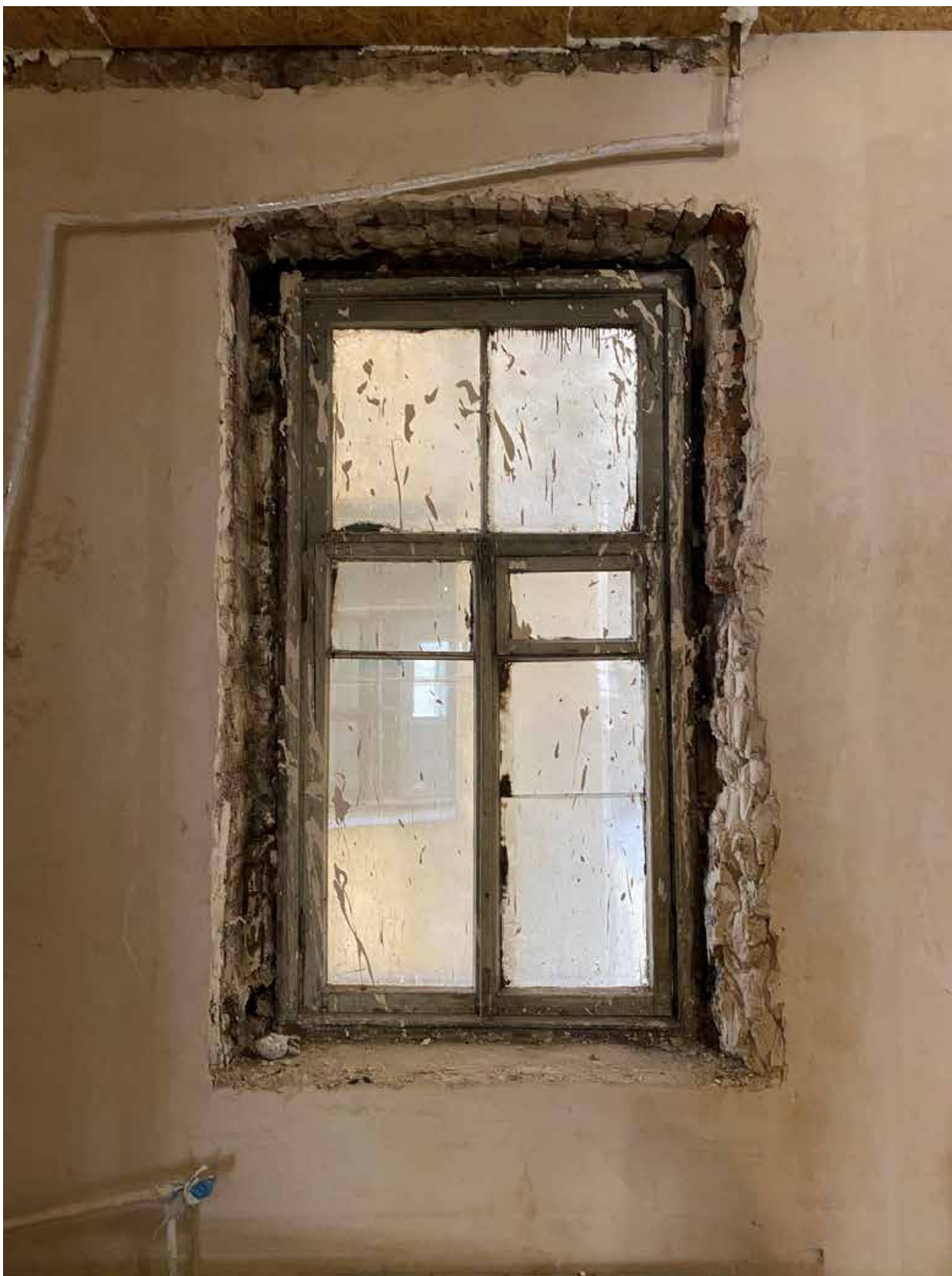
Фото 34. Вид на оконное заполнение в части квартиры № 5 объекта культурного наследия.
