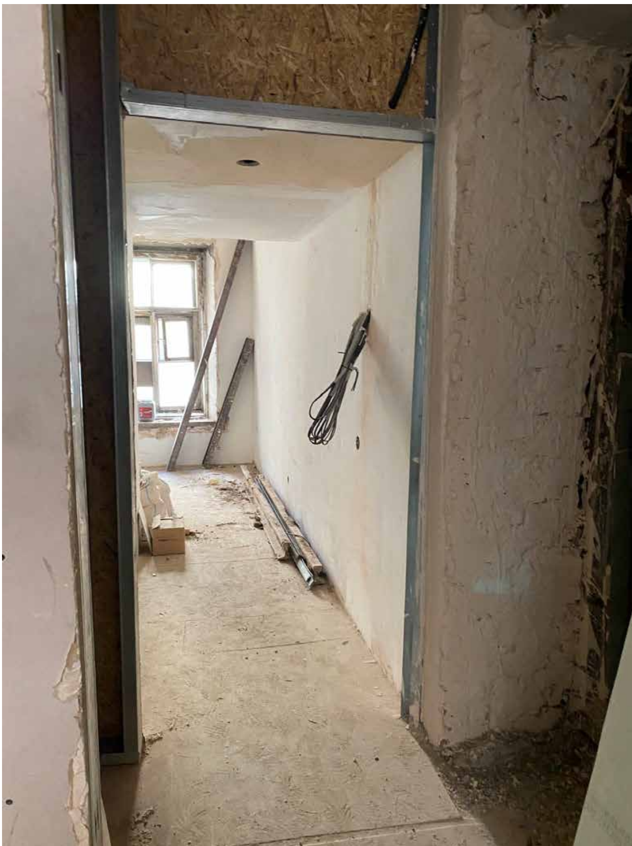
Фото 40. Вид на помещение квартиры № 5 объекта культурного наследия.
