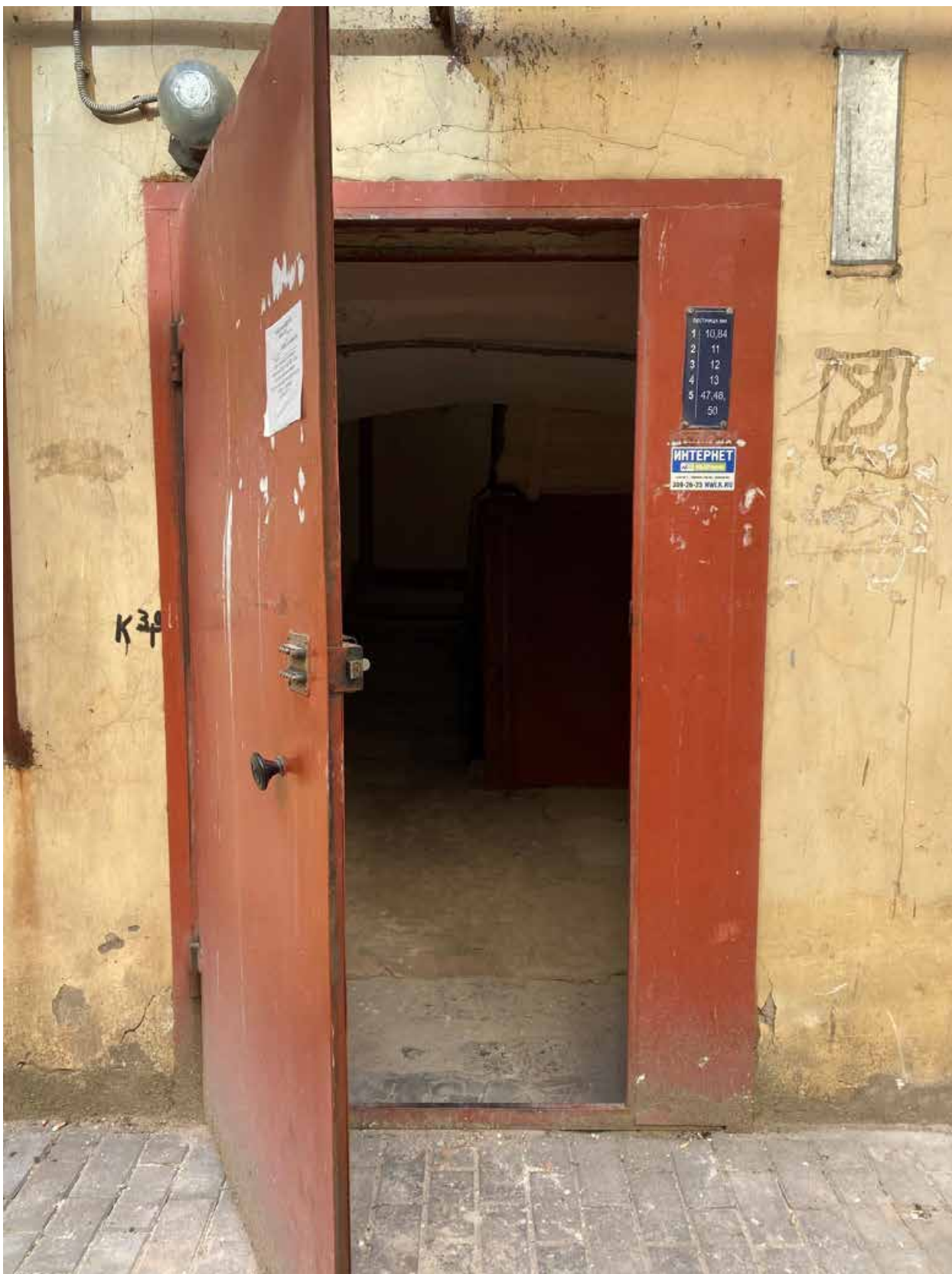
Фото 10. Вид на вход в парадную, ведущую к квартире № 5 (черная лестница), объекта культурного наследия.
