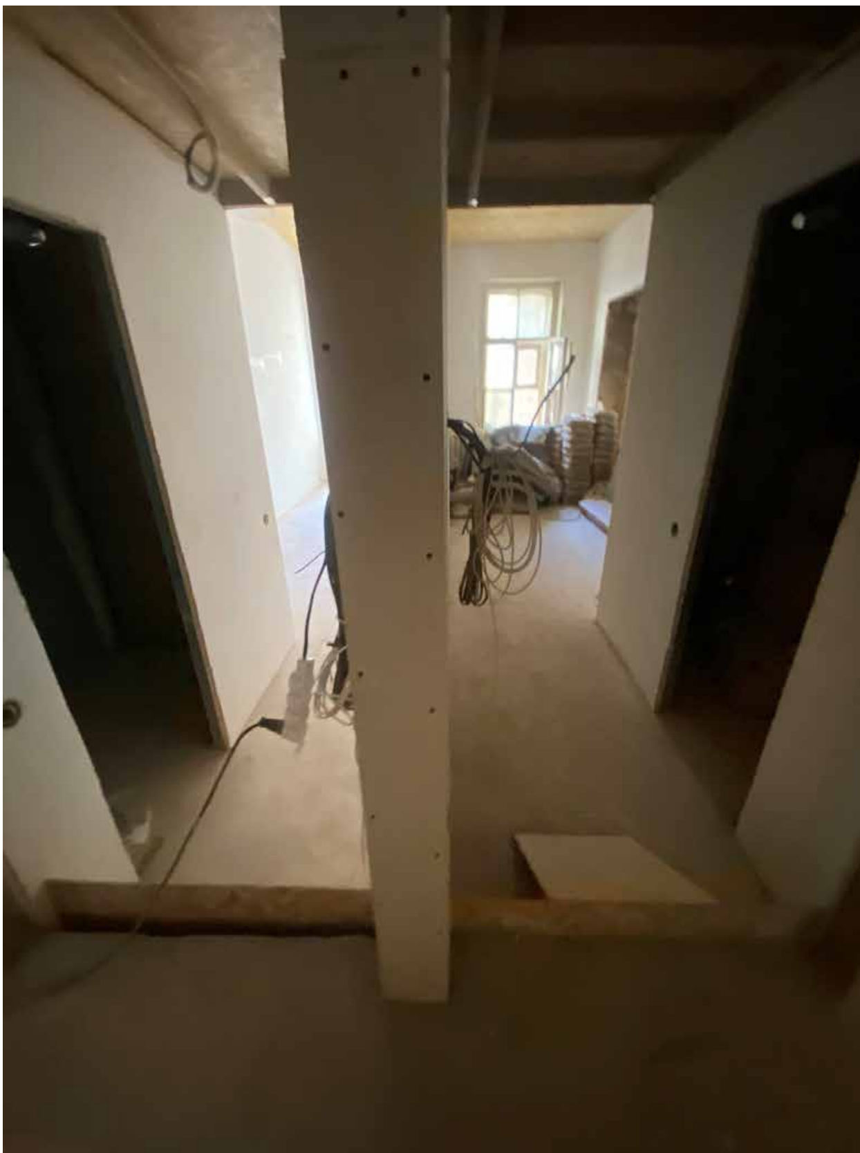
Фото 30. Вид на помещение квартиры № 5 объекта культурного наследия.
