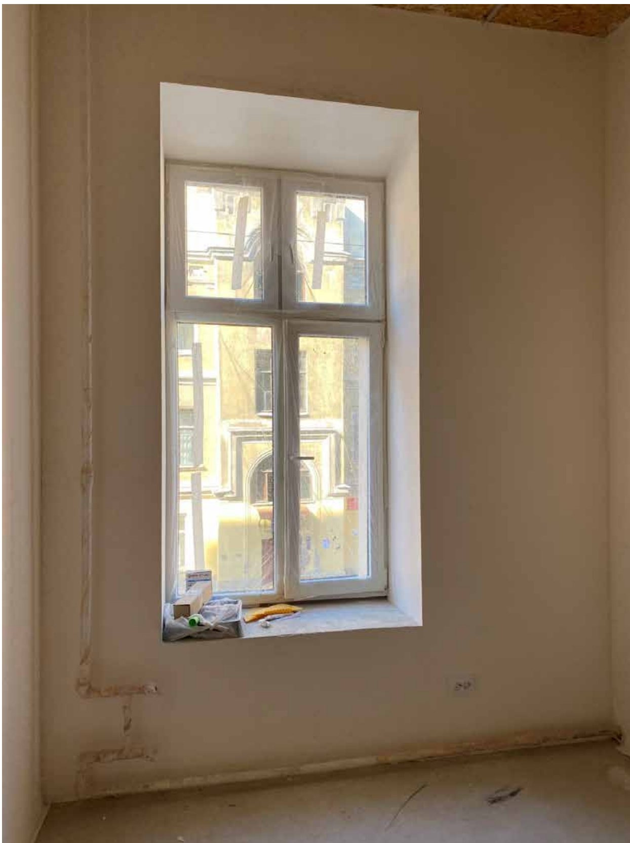
Фото 23. Вид на оконное заполнение в части квартиры № 5 объекта культурного наследия.
