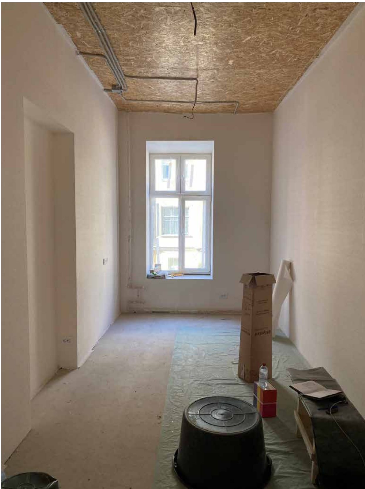
Фото 22. Вид на помещение квартиры № 5 объекта культурного наследия.
