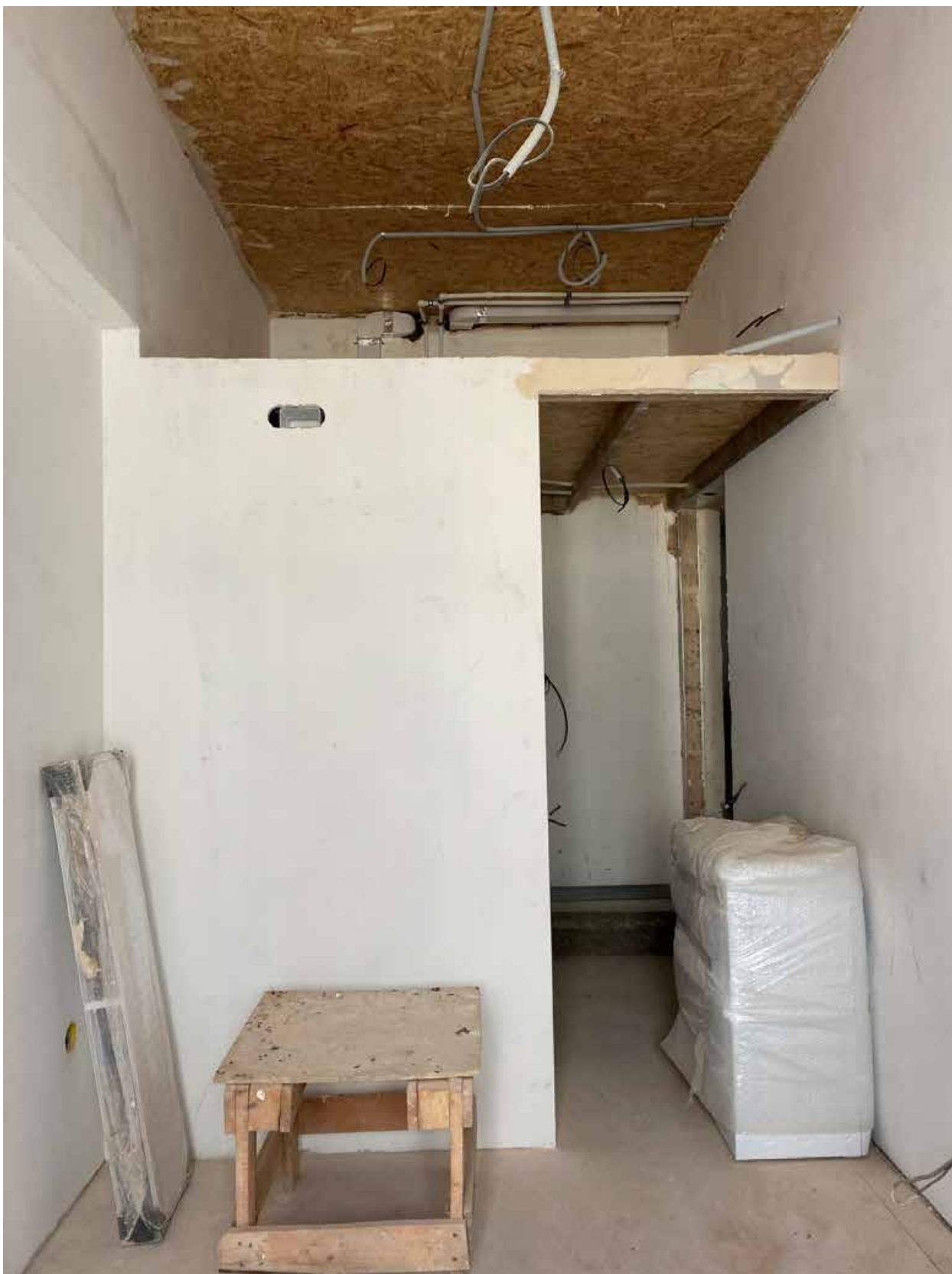
Фото 49. Вид на помещение квартиры № 5 объекта культурного наследия.
