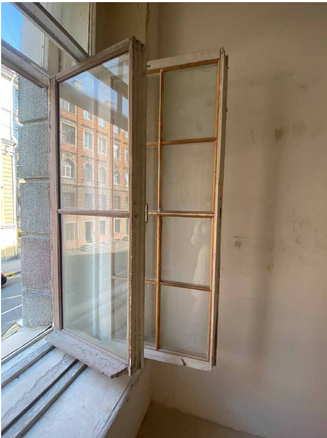
Фото 48. Вид на оконное заполнение в части квартиры № 5 объекта культурного наследия.
