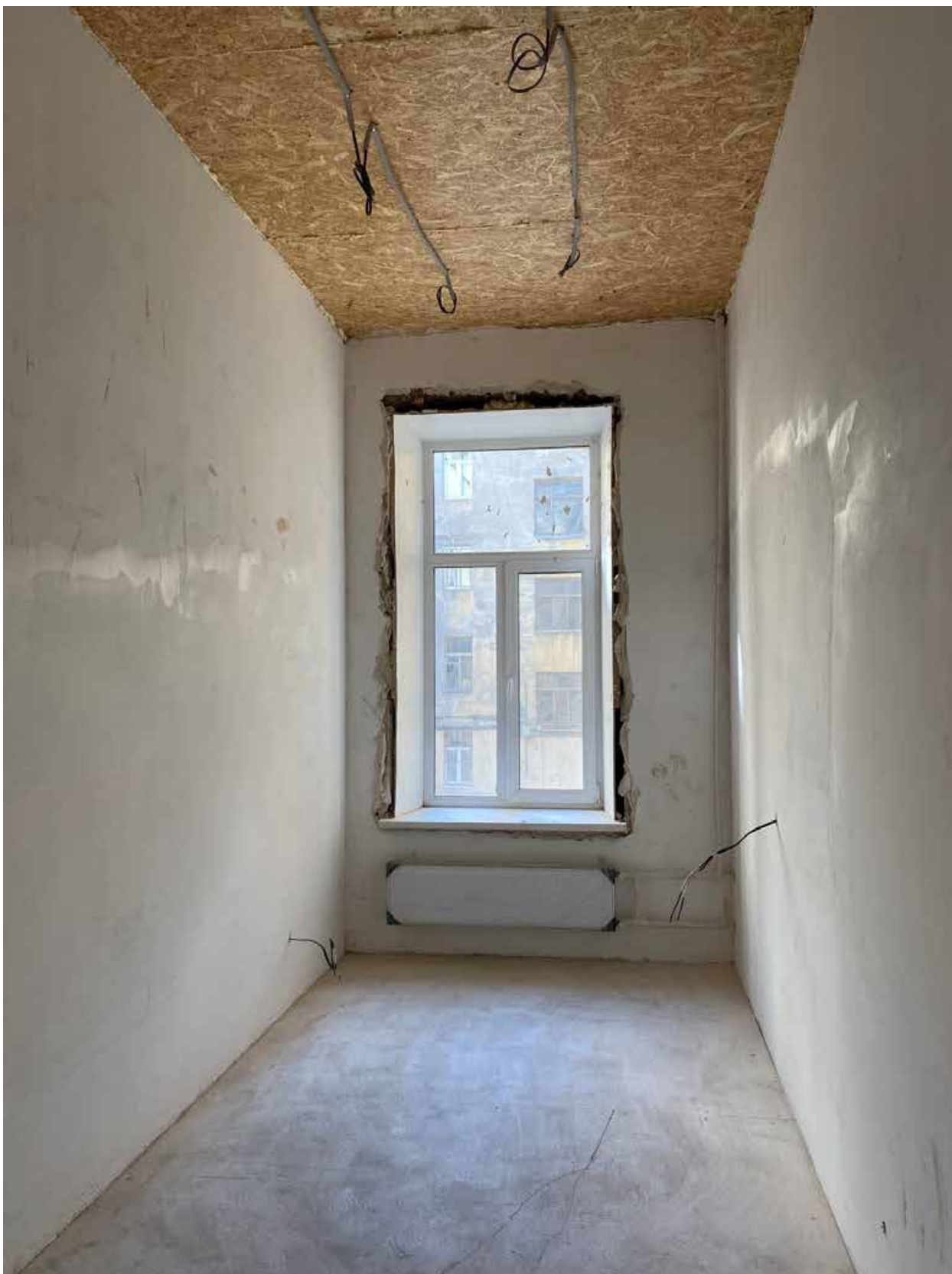
Фото 27. Вид на помещение квартиры № 5 объекта культурного наследия.
