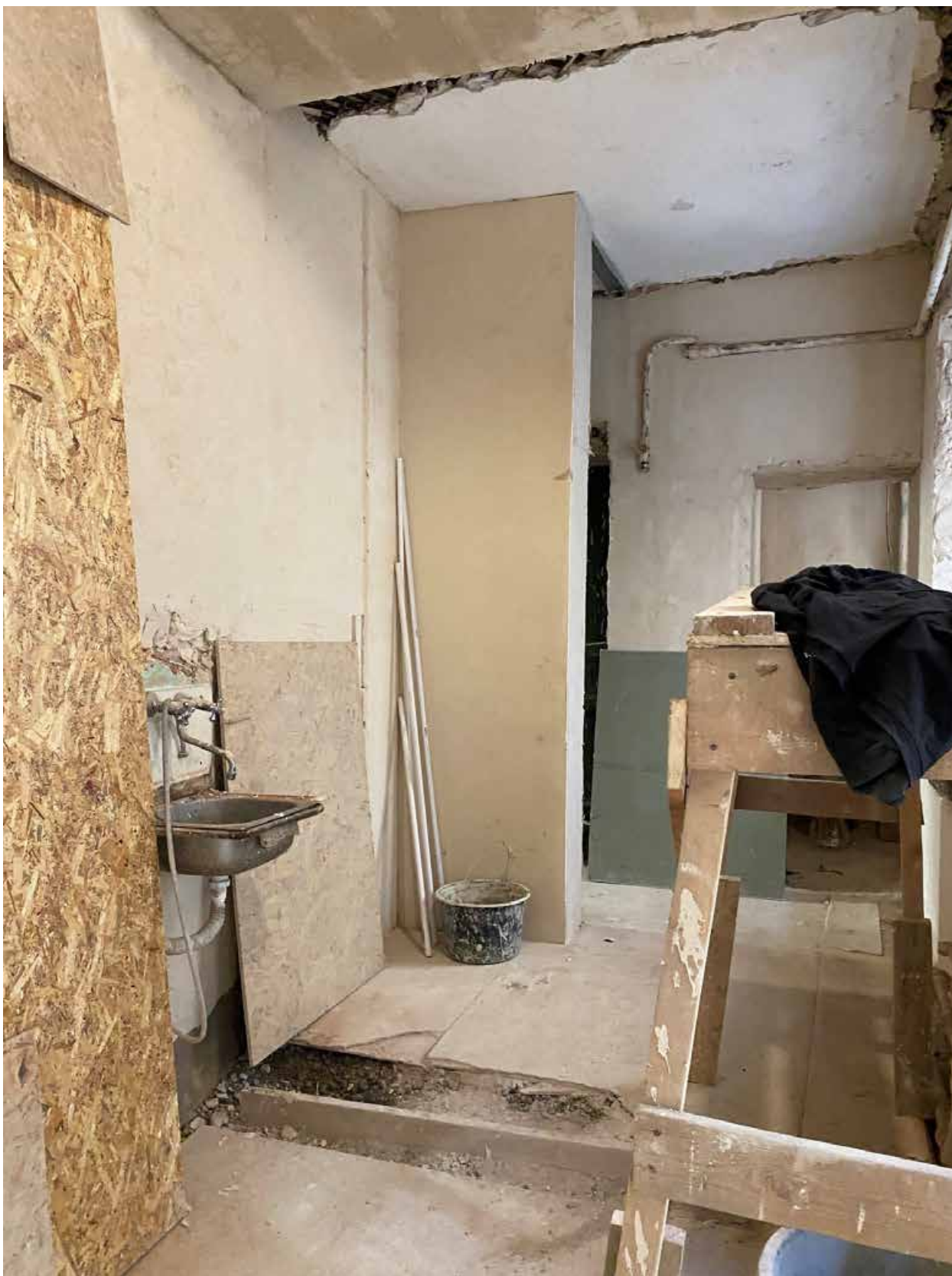
Фото 39. Вид на помещение квартиры № 5 объекта культурного наследия.
