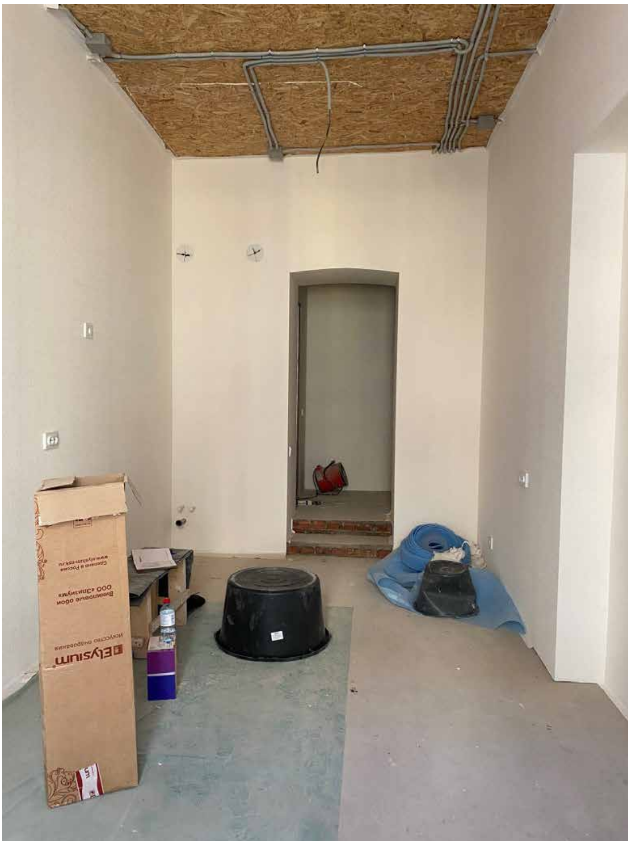
Фото 24. Вид на помещение квартиры № 5 объекта культурного наследия.
