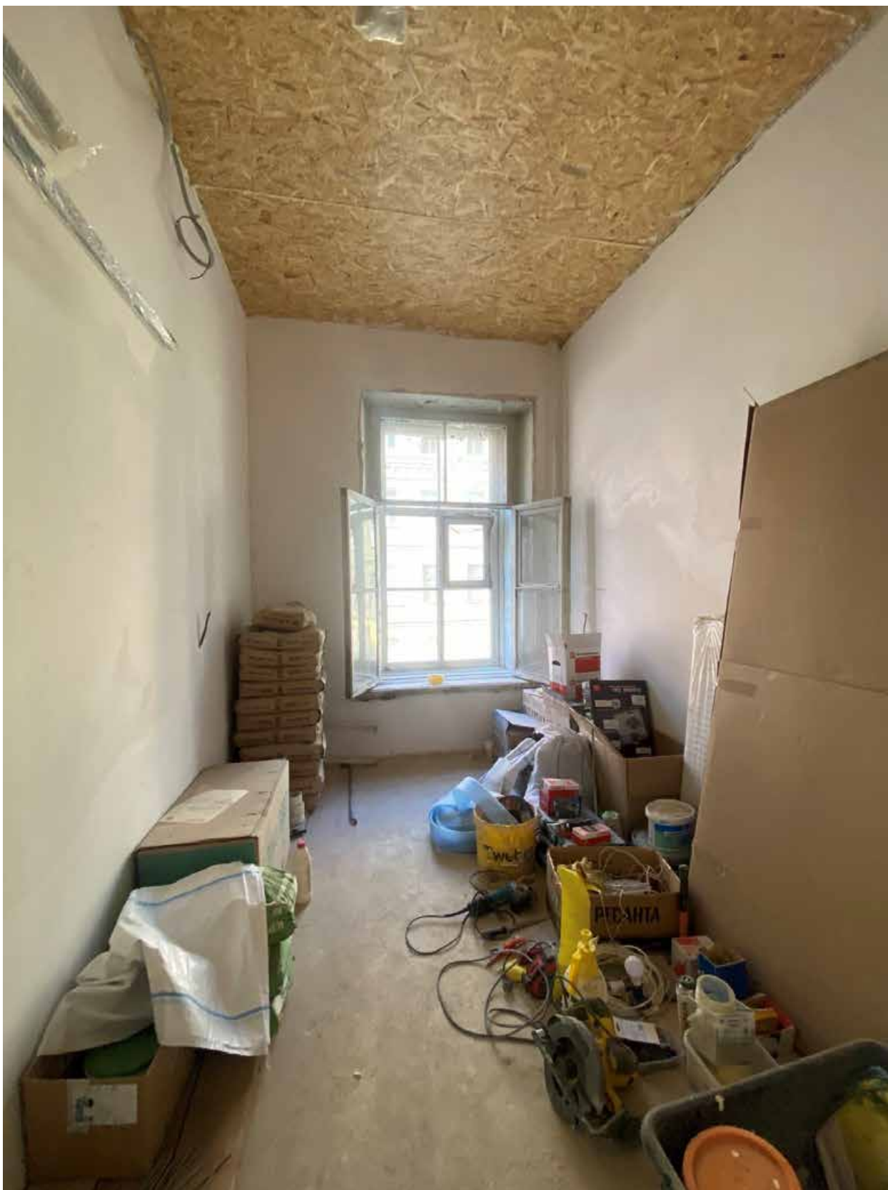
Фото 43. Вид на помещение квартиры № 5 объекта культурного наследия.
