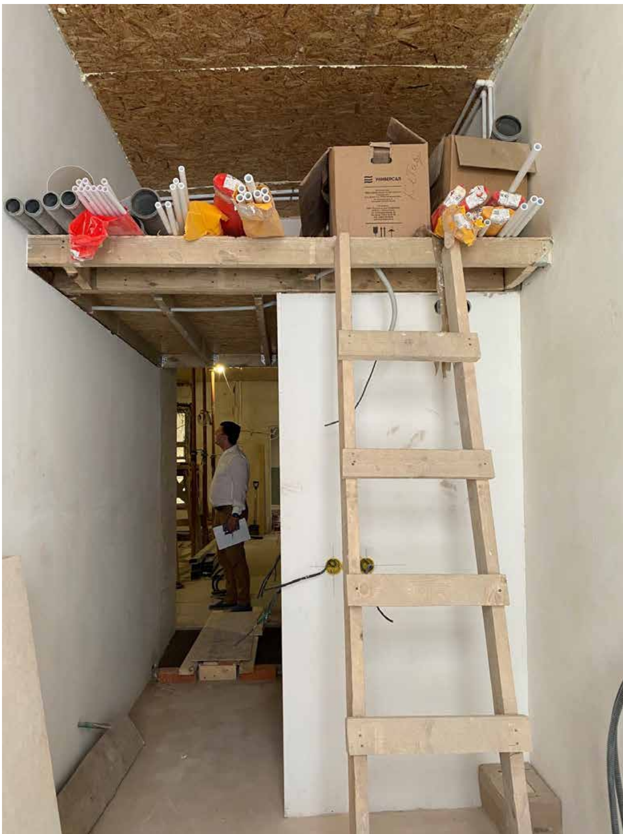
Фото 42. Вид на помещение квартиры № 5 объекта культурного наследия.
