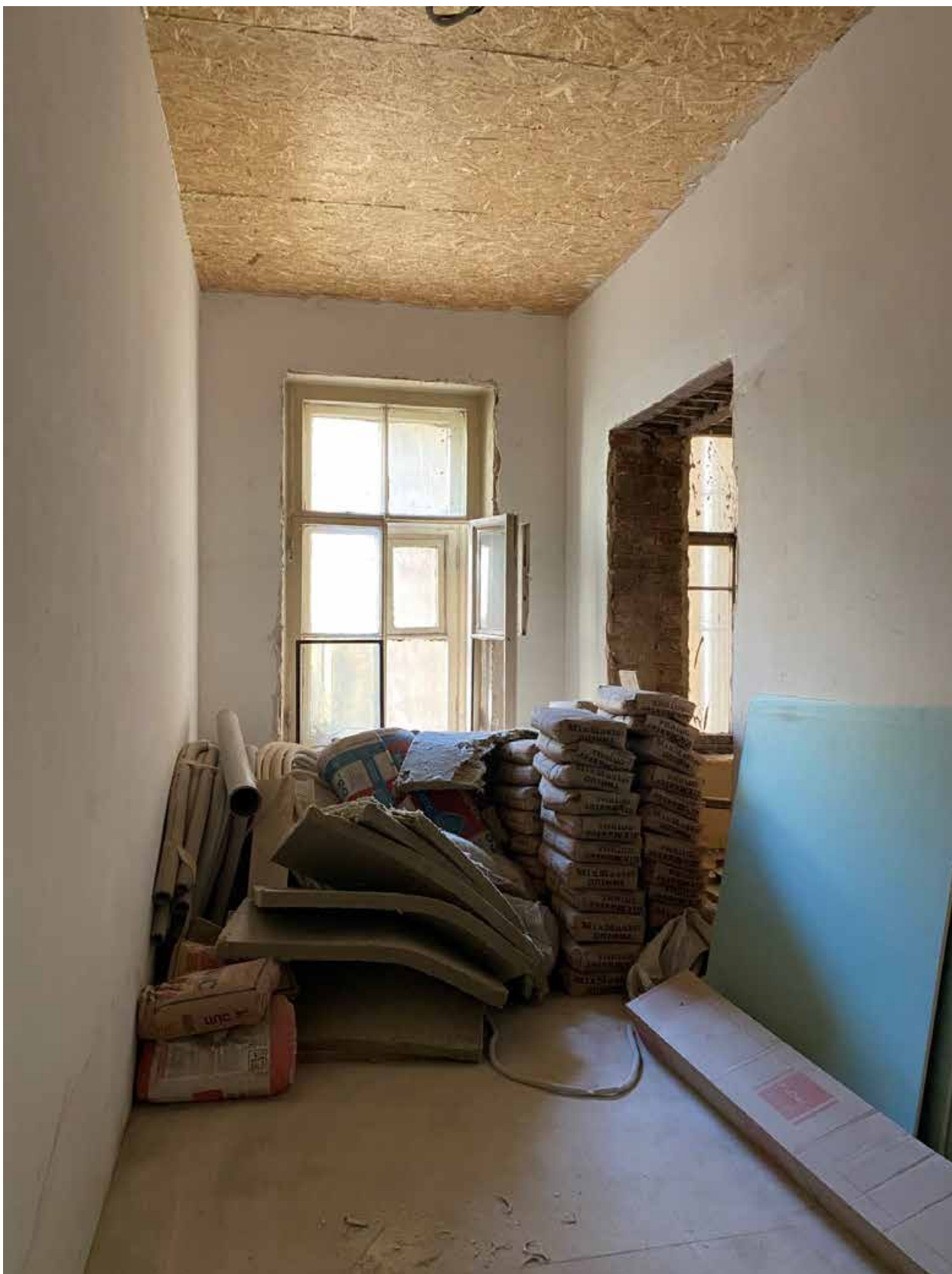
Фото 31. Вид на помещение квартиры № 5 объекта культурного наследия.
