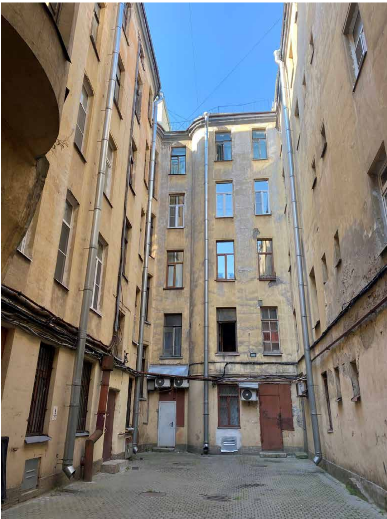
Фото 8. Вид на часть дворовых фасадов объекта культурного наследия.
