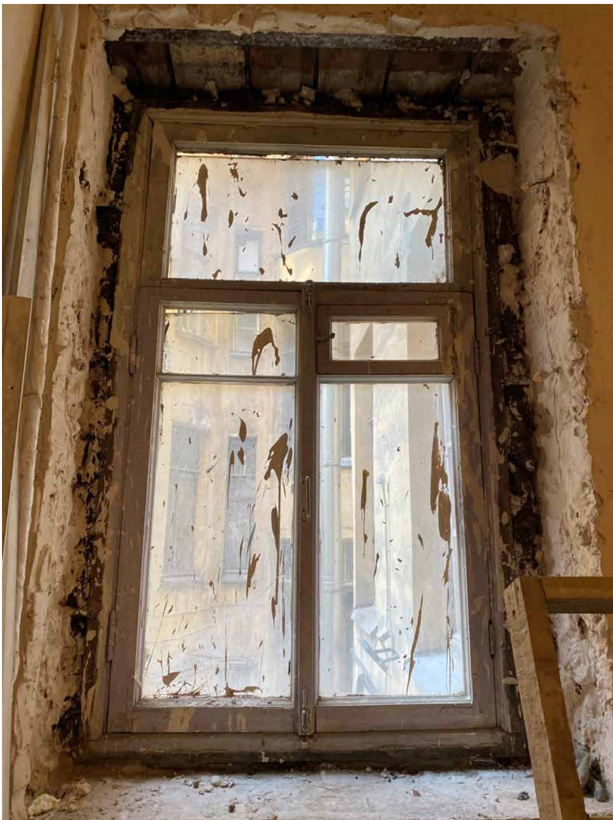
Фото 37. Вид на оконное заполнение в части квартиры № 5 объекта культурного наследия.
