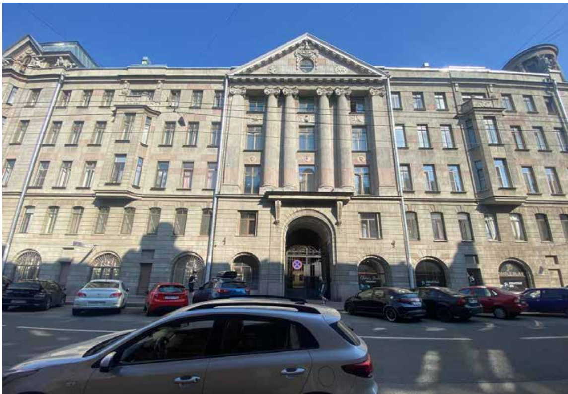
Фото 2. Вид на часть лицевого фасада объекта культурного наследия по улице Егорова.
