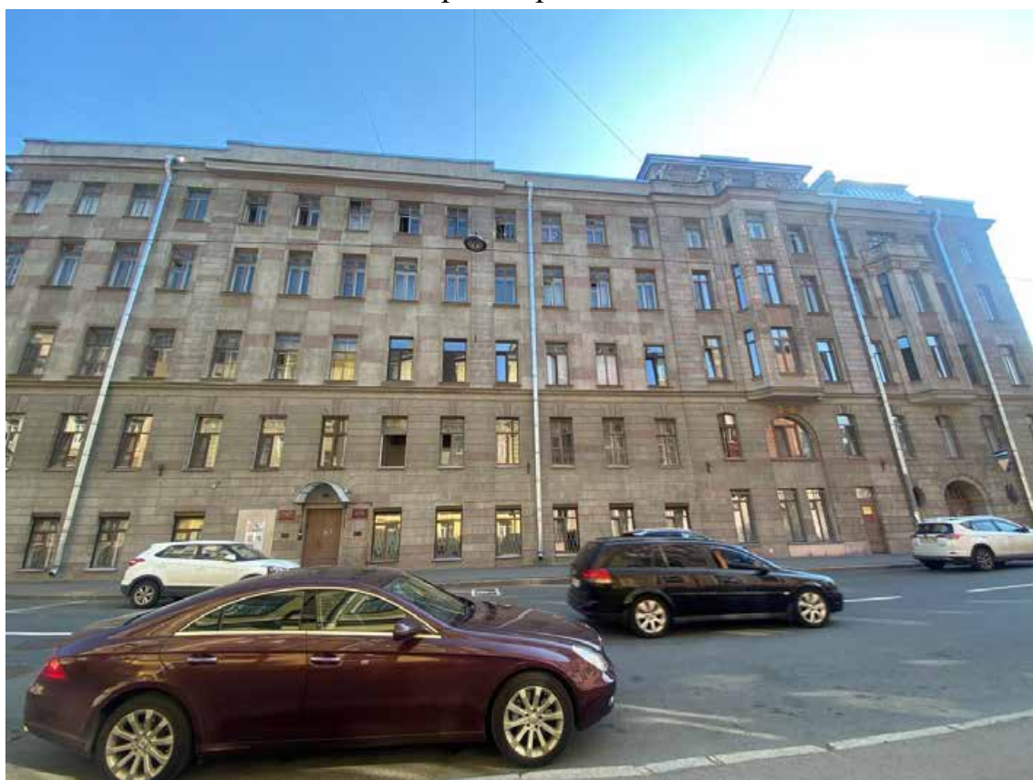
Фото 4. Вид на часть лицевого фасада объекта культурного наследия по 5-й Красноармейской улице.
