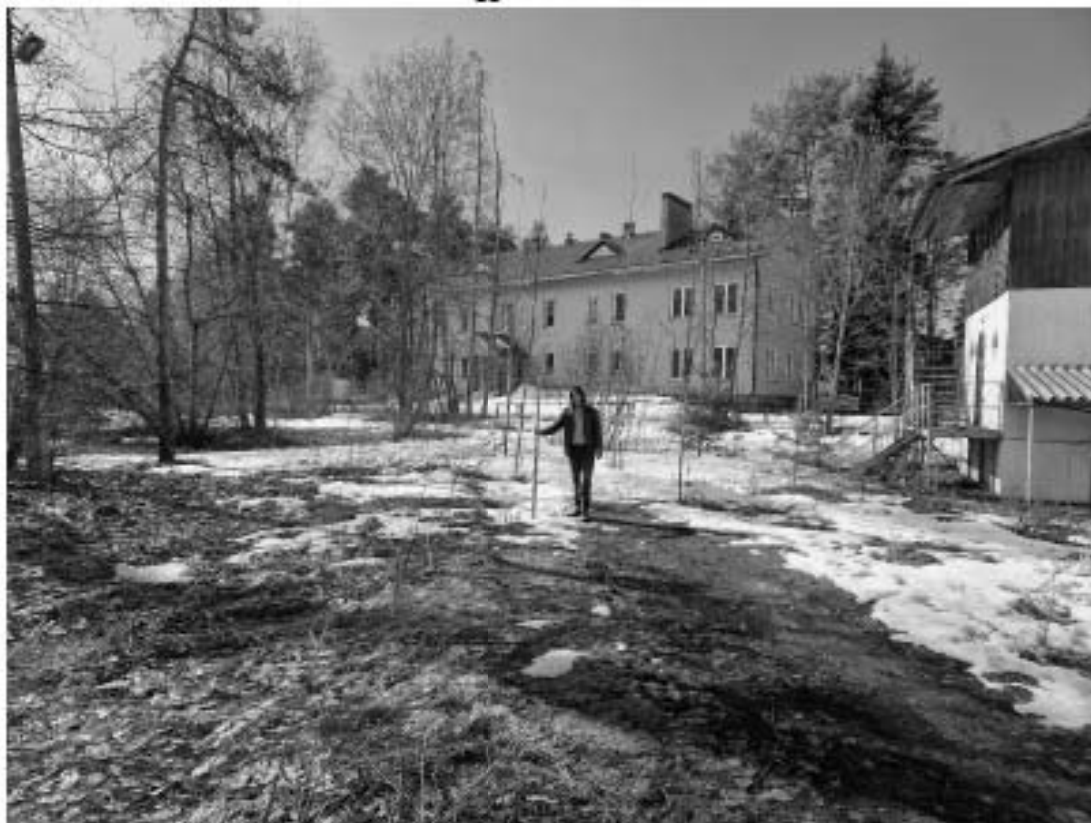
Рис. 13. СПБ-2023. Курортный район, пос. Солнечное. Общий вид участка обследования. Точка фотофиксации 5. Вид с севера
