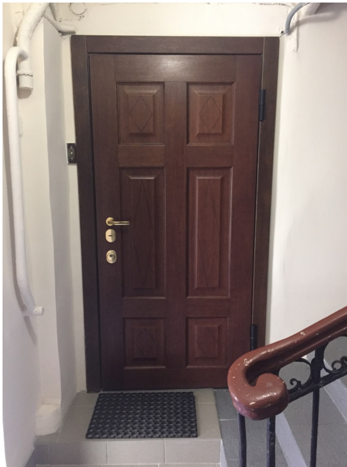
Фото 9. Вход квартиру № 18 (согласно технической документации) с лестничной клетки. Вид с юго-запада.
