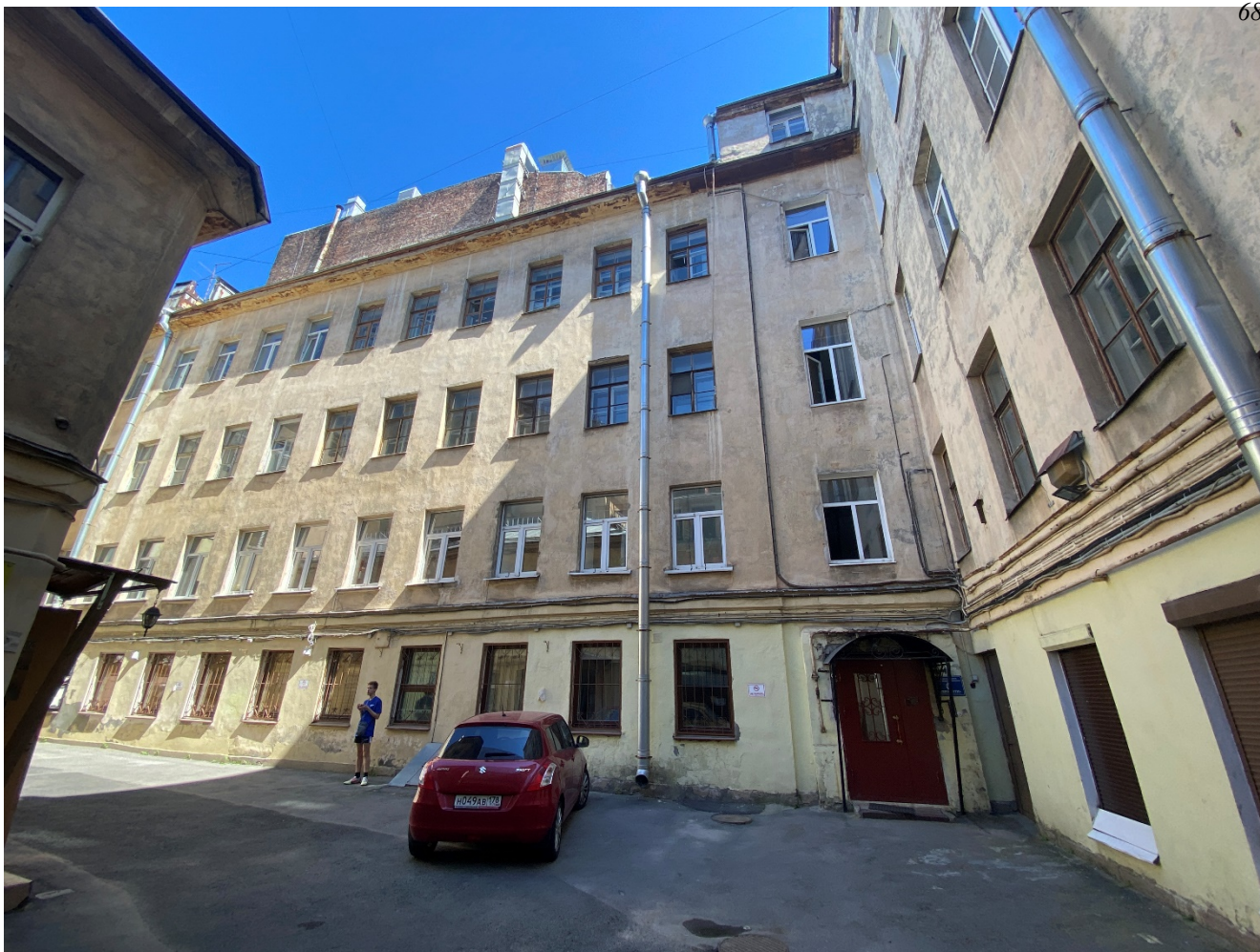
Фото 3. Юго-западный фасад дворового флигеля под лит. А 2 . Вид с юга.
