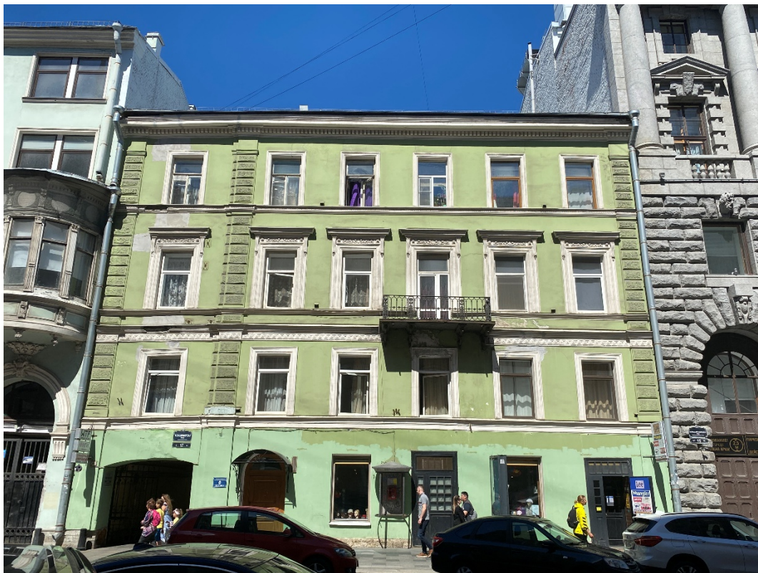
Фото 1. Лицевой фасад объекта культурного наследия «Дом французского общества страхования «Урбэн» по Большой Морской улице. Вид с юго-востока.
