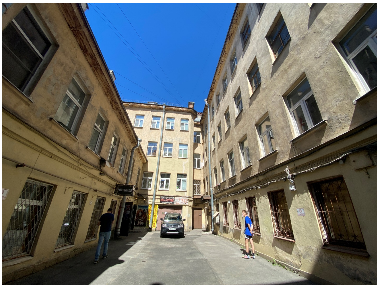
Фото 4. Юго-восточный фасад дворового флигеля под лит. А 3 . Вид с юго-востока.
