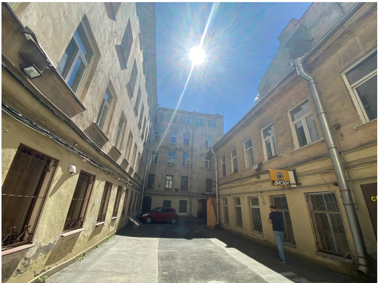
Фото 6. Северо-западный дворовой фасад лит. А 1 . Вид с северо-запада.
