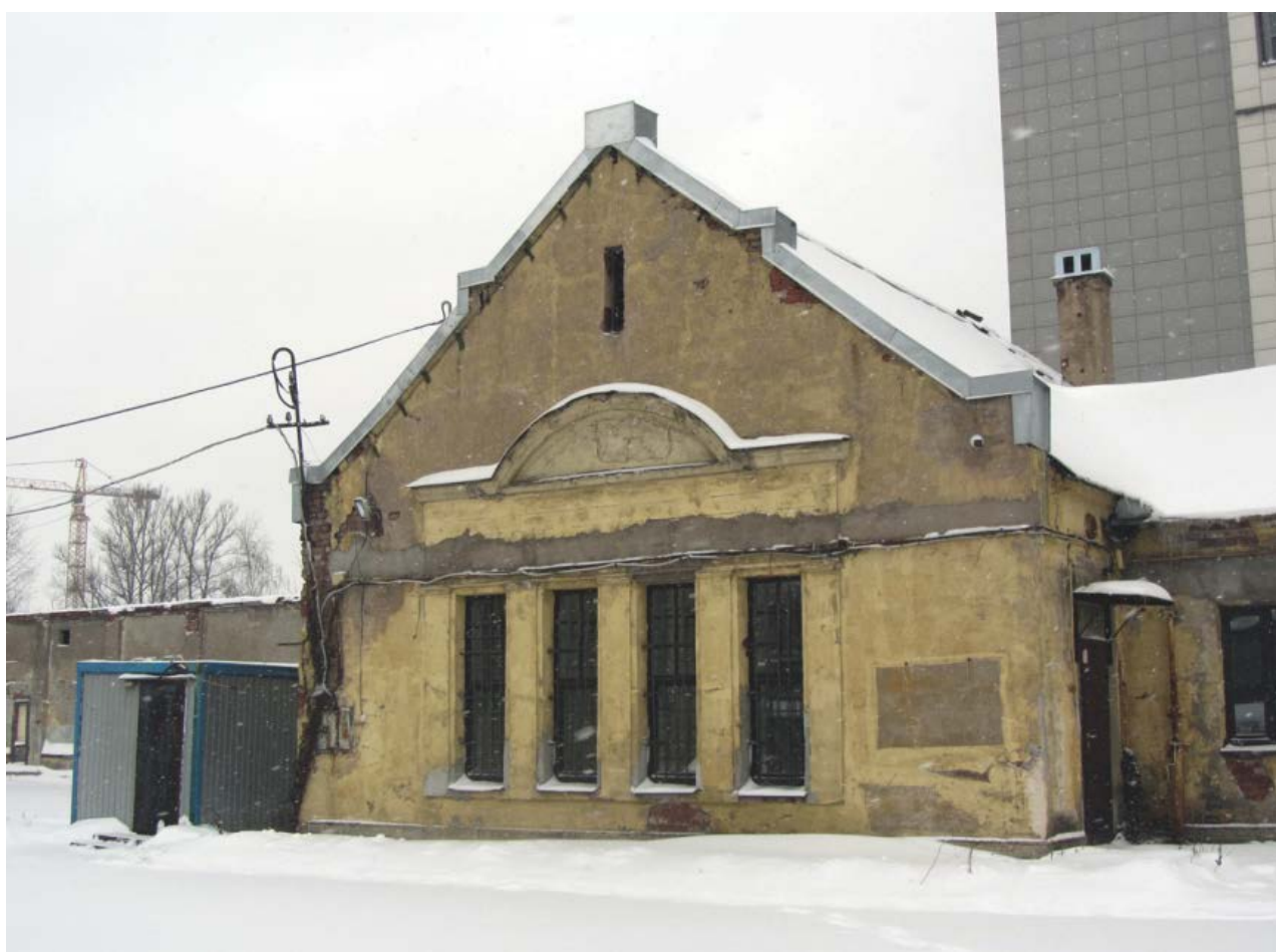
Фото. 4. «Корпус для подопытных животных» (Московский пр., д. 99 лит. О). Фрагмент южного фасада. 2021 г.
