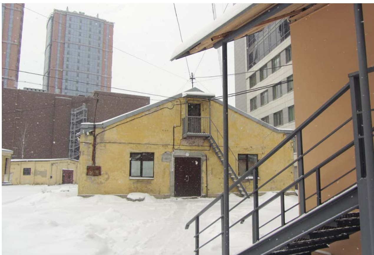
Фото. 2. «Корпус для подопытных животных» (Московский пр., д. 99 лит. О). Торцевой восточный фасад. 2021 г.
