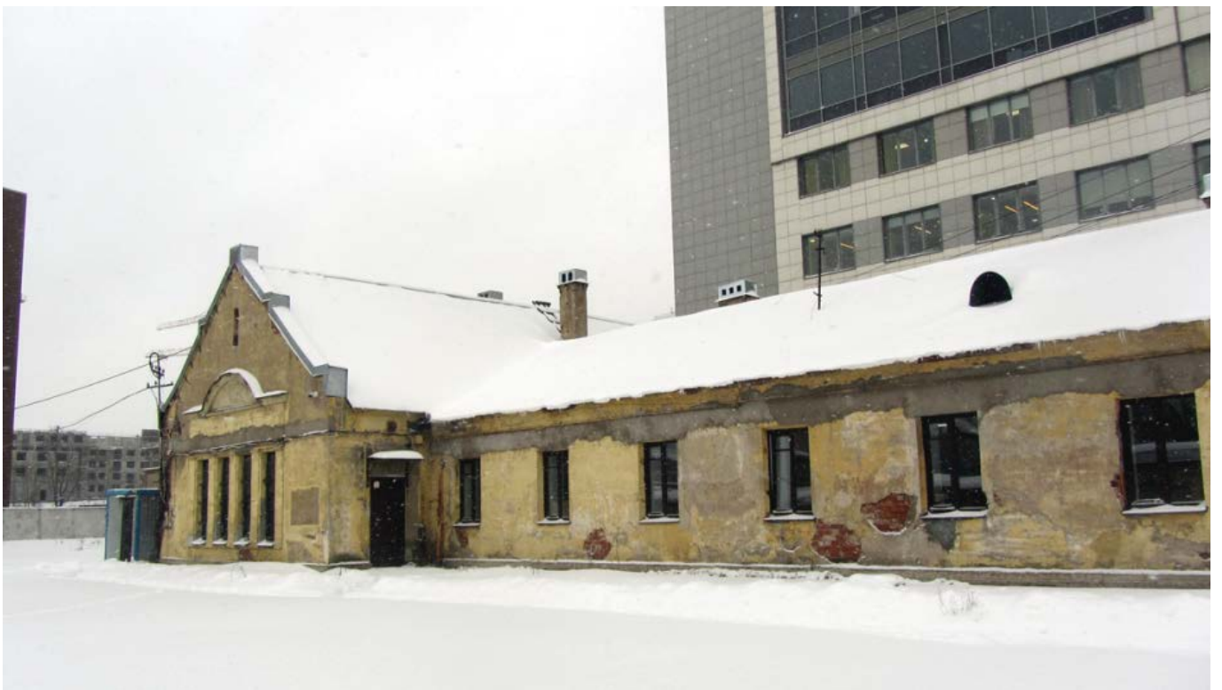
Фото. 3. «Корпус для подопытных животных» (Московский пр., д. 99 лит. О). Общий вид южного фасада. 2021 г.
