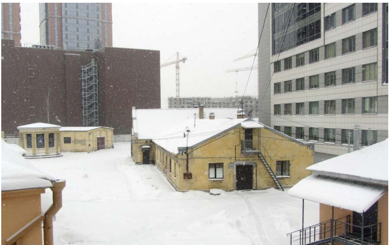
Фото. 1. «Корпус для подопытных животных» (Московский пр., д. 99 лит. О). Общий вид с востока. 2021 г.
