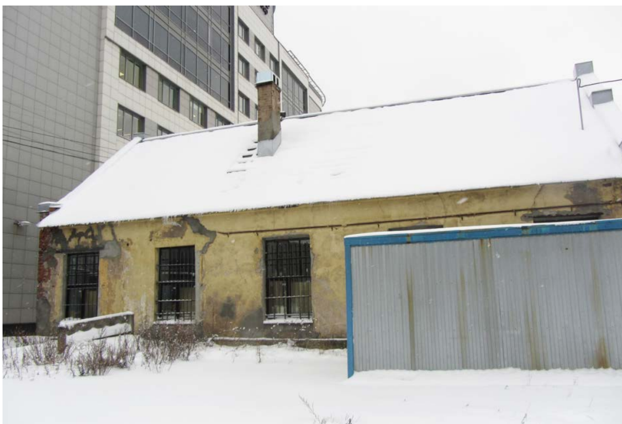
Фото. 7. «Корпус для подопытных животных» (Московский пр., д. 99 лит. О). Общий вид западного фасада. 2021 г.
