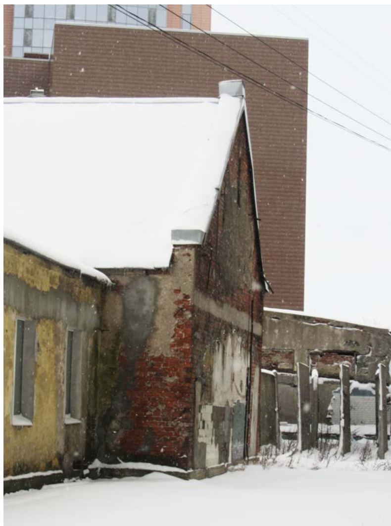
Фото. 6. «Корпус для подопытных животных» (Московский пр., д. 99 лит. О). Фрагмент северного фасада. 2021 г.
